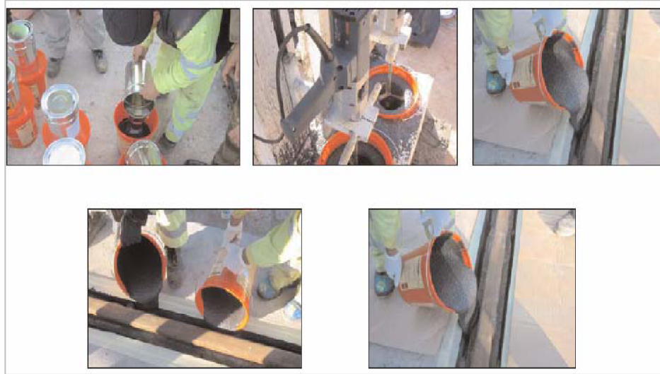
Figura 2.30. Preparación y vertido del Corkelast. Fuente: [31]
