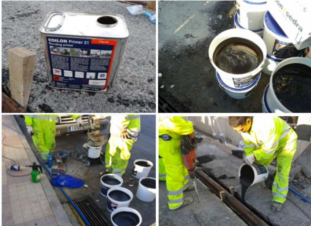
Figura I.22. Batido y vertido del elastómero líquido en los cajetines para embebido.
