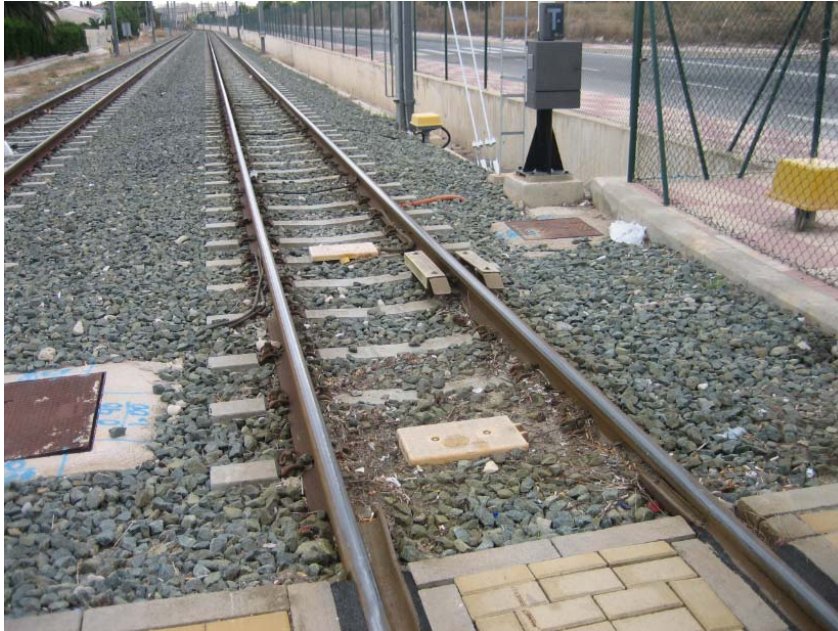
Figura I.1. Estado previo de los diversos sistemas existentes en el tramo de actuación y ejecución del tramo de pruebas. Fuente: Elaboración propia
