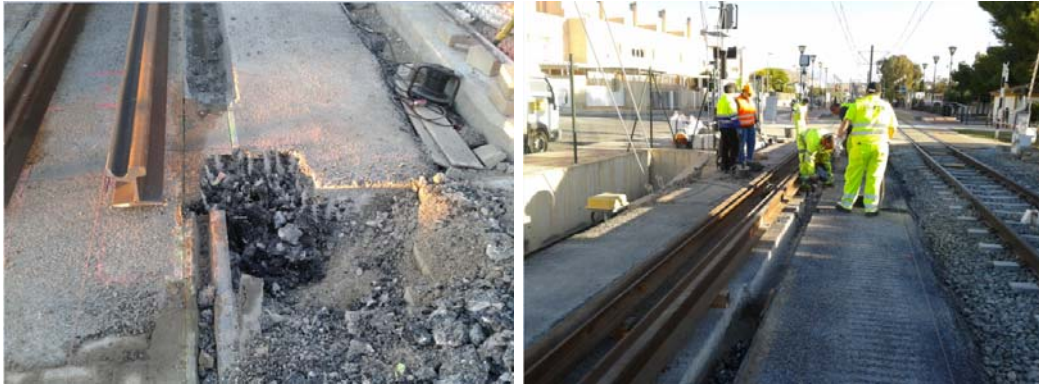
Figura I.16. Ejecución de las rozas para la instalación de circuitos de vía y balizas.
