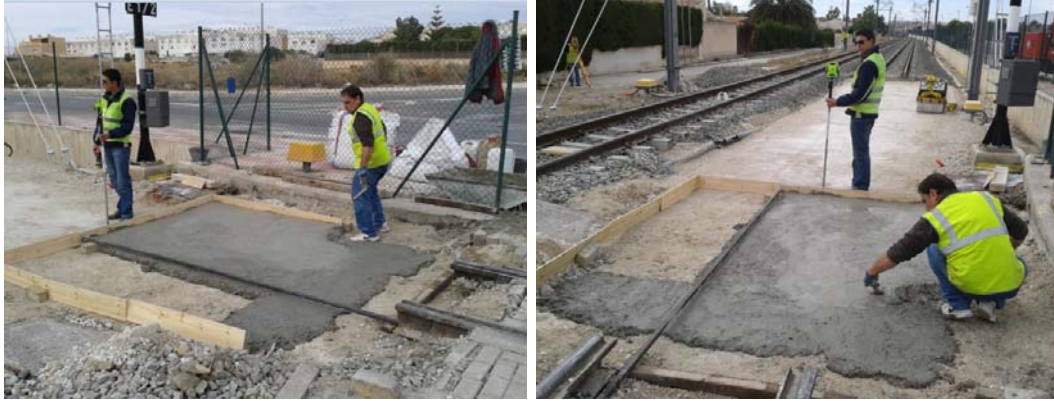
Figura I.11. Replanteo y ejecución de la losa de transición entre la vía en placa de hormigón y la vía de mezcla bituminosa. Fuente: Elaboración propia
