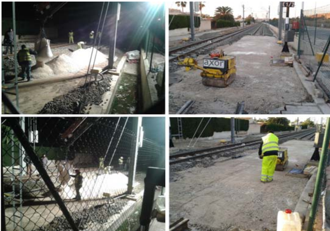
Figura I.9. Extensión, riego y compactación de la capa de zahorras artificiales.
