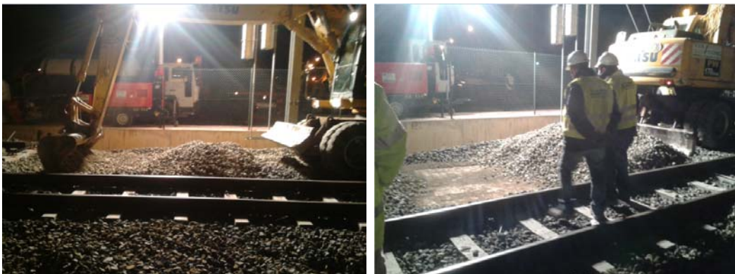
Figura I.8. Retirada de la banqueta de balasto existente hasta la plataforma.
