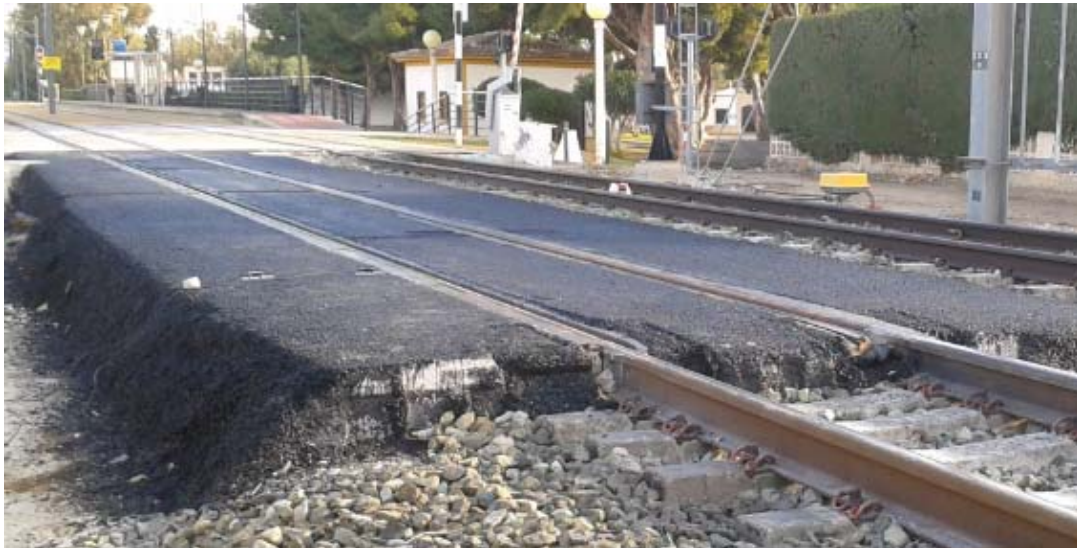
Figura 5.35. Transición vía en placa bituminosa-vía en balasto.
