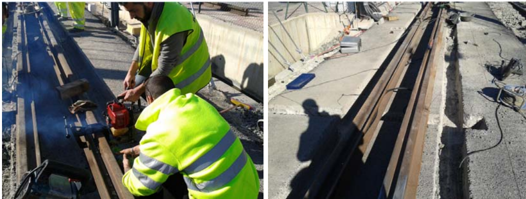
Figura I.17. Instalación de los circuitos de vía en el alma del carril.
