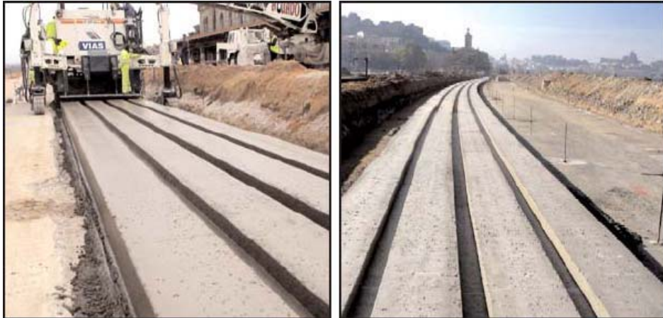
Figura 2.26. Detalle del proceso de hormigonado de la losa. Fuente: [33]
