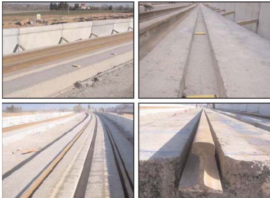
Figura 2.28. Detalle del proceso de colocación del carril. Fuente: [33]
