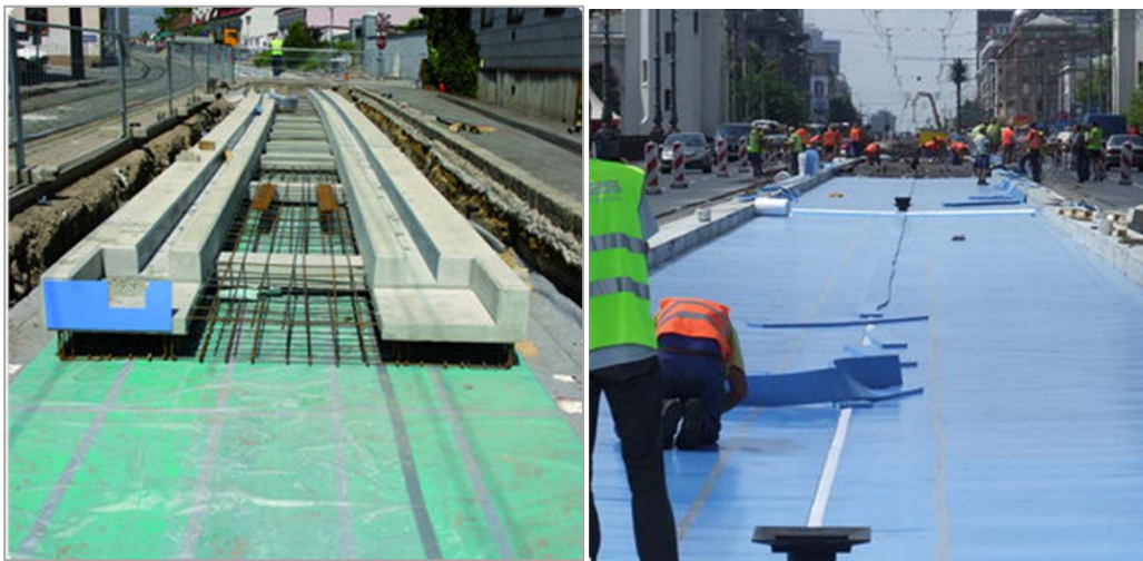
Figura 2.23. Extendido de mantas elásticas. Fuente: [31]
