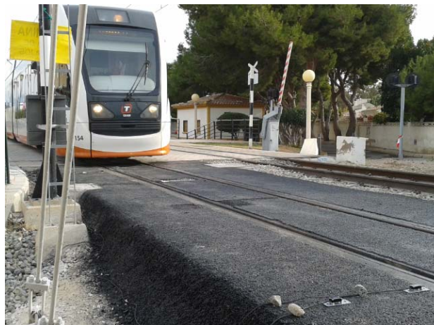
Figura 5.51. Circulaciones por el tramo de pruebas. Registro de aceleraciones.
