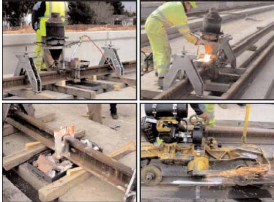
Figura 2.27. Detalle del proceso de soldadura del carril. Fuente: [33]
