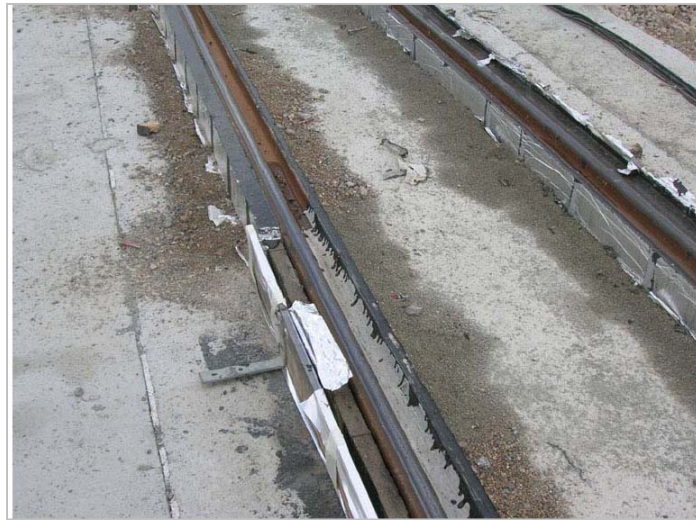
Figura 2.31. Imagen tras el vertido del Corkelast. Desencofrado. Fuente: [31]
