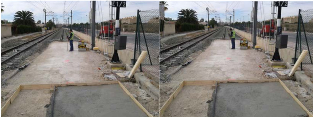
Figura I.12. Comprobación de cotas y marcaje de cotas para las mezclas bituminosas. Fuente: Elaboración propia
