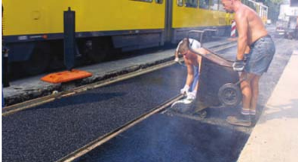
Figura 2.45. Asfaltado manual de la capa superior. Sistema "The Rheda City".
