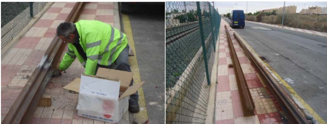
Figura I.15. Acopio de carriles Ph37N y soldadura intermedia exterior. Fuente: Elaboración propia
