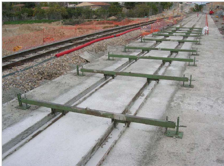
Figura 2.25. Encofrados para acanaladura en tranvía de Villajoyosa.
