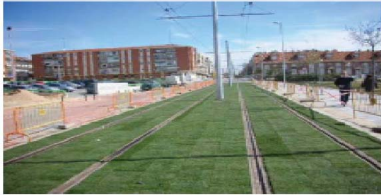
Figura 2.34. Acabado con césped. Fuente: [31]
