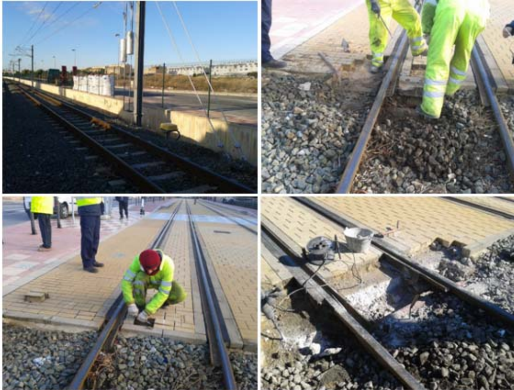
Figura I.6. Acopio de material granular y retirada de los adoquines de la vía en placa de hormigón. Fuente: Elaboración propia
