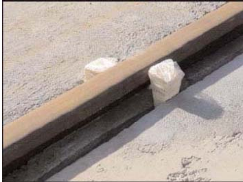
Figura 2.29. Detalle de la alineación mediante contracuñas. Fuente: [33]
