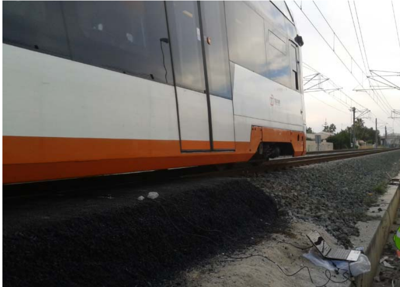
Figura 5.48. Circulación de los trenes por el tramo de pruebas. Registros de aceleraciones. Fuente: elaboración propia
