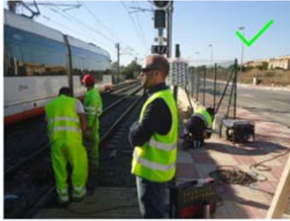
Figura I.2. Compatibilización de los trabajos ejecutados con la circulación ferroviaria mediante la figura de piloto de seguridad. Fuente: Elaboración propia
