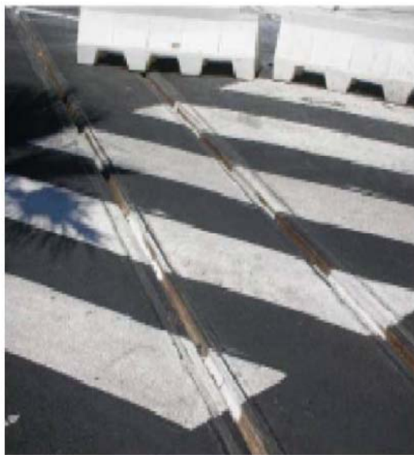
Figura 2.33. Acabado con asfalto. Fuente: [31]
