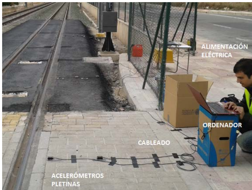
Figura 5.49. Disposición de los equipos. Fuente: elaboración propia
