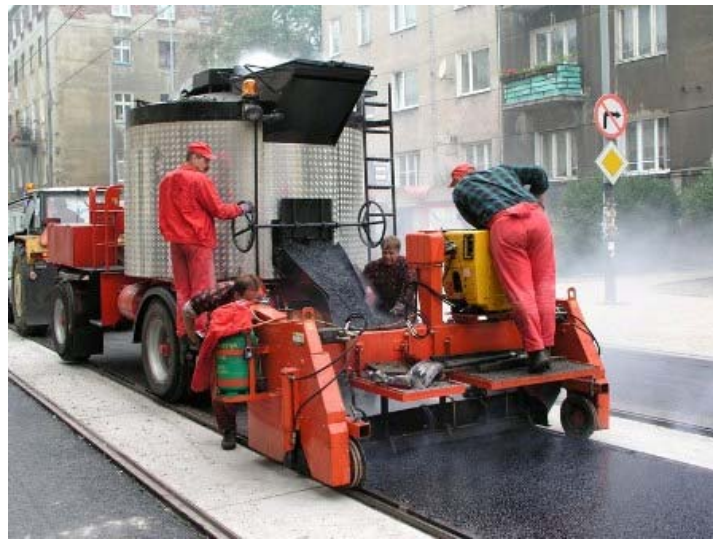
Figura 2.47. Asfaltado con maquinaria pequeña del hueco entre carriles. Fuente: [40]
