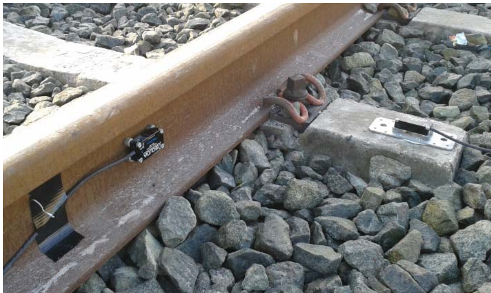
Figura 5.47. Colocación de los acelerómetros y cableado de los mismo a los portátiles.
