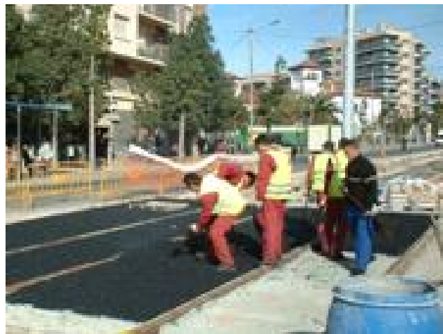
Figura 2.38. Asfaltado manual de un cruce vía-tranvía. Fuente: [35]
