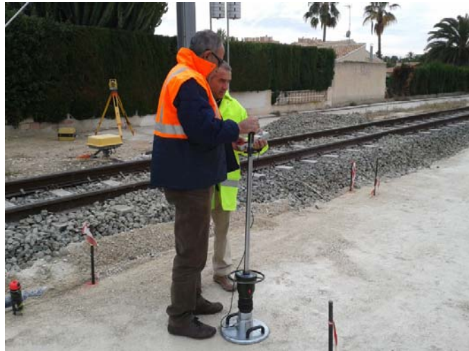
Figura I.10. Realización del ensayo de placa de carga dinámica sobre las zahorras artificiales. Fuente: Elaboración propia
