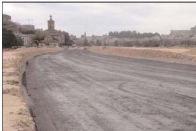
Figura 2.24. Vista panorámica del suelo cemento. Fuente: [33]
