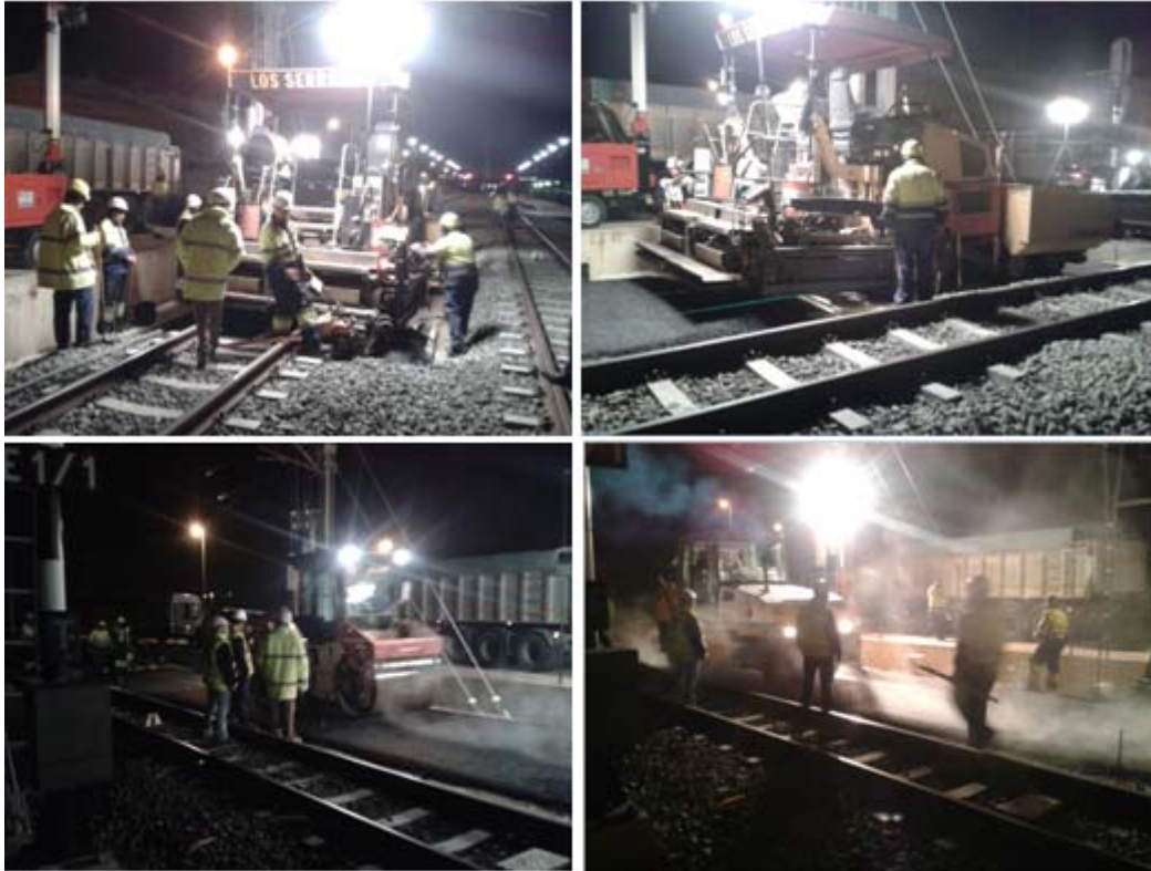
Figura I.13. Extensión, nivelación y compactación de las mezclas bituminosas SMA20.
