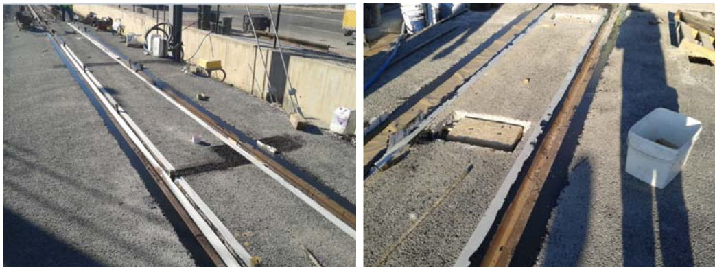
Figura I.23. Finalización del vertido del elastómero líquido en los cajetines.
