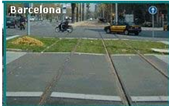
Figura 2.37. Imagen de un cruce vía-tranvía en funcionamiento. Fuente: [35]
