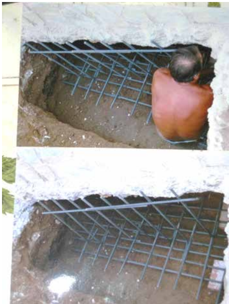
Fotografía 379. Colocación del armado de la zapata corrida.
