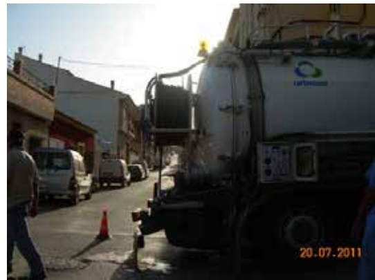
Fotografía 417. Inspección la red de Saneamiento mediante cámara de TV.
