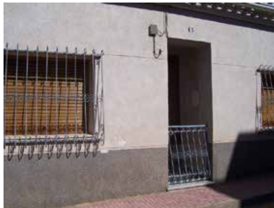
Fotografía 92. Fachada Calle Parricas.
