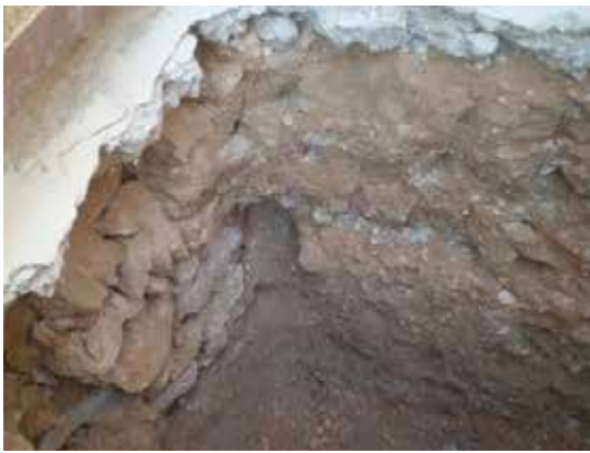
Fotografía 433. Detalle de la cimentación en la esquina de la vivienda.
