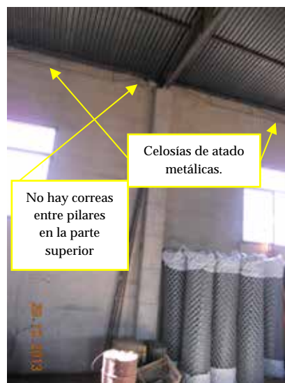
Fotografía 400.- Detalle de la parte superior de la estructura.
