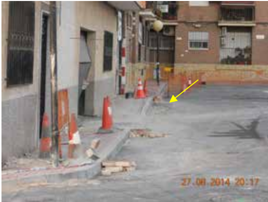
Fotografía 154. Zona de la avería detectada.
