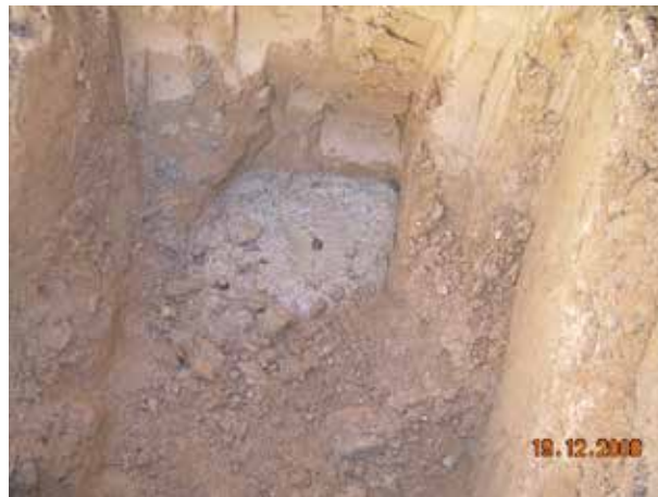
Fotografía 378. La red quedó sellada con mortero.
