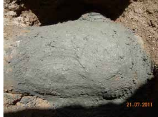
Fotografía 421. Reparación fisura con mortero SR.
