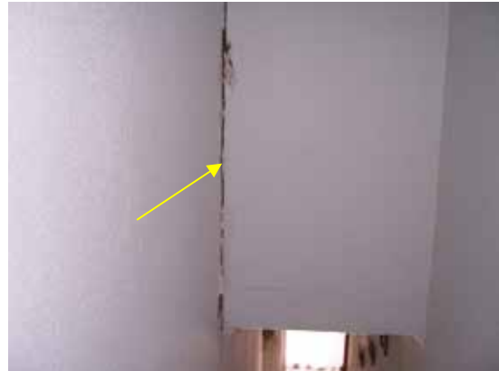
Fotografía 29. Caja de escaleras vista desde arriba.
