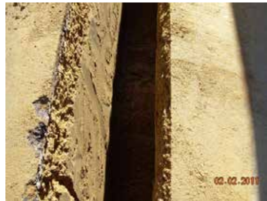
Fotografía 52. Se observa la zanja totalmente seca.
