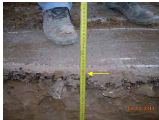
Fotografía 47. Comprobación de profundidad de la zanja (150cm)
