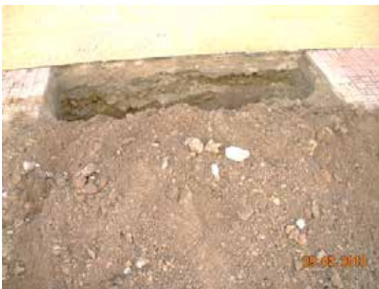
Fotografía 491. El material que se sacó de la excavación estaba totalmente seco.
