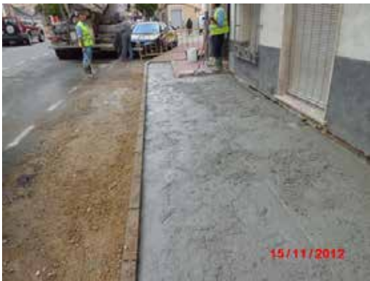
Fotografía 447. Acera una vez terminado de echar la última capa de HM-25.
