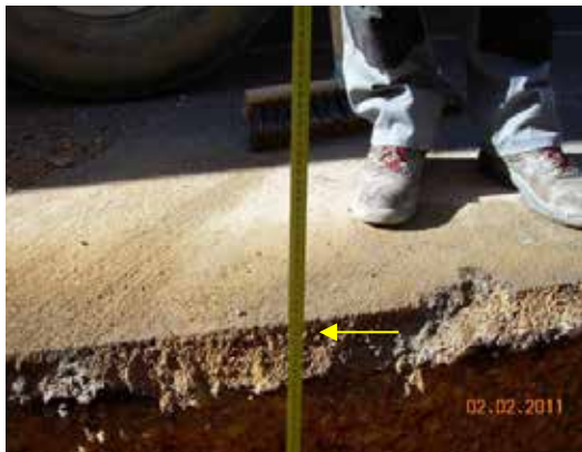
Fotografía 51. Altura de la zanja en Pedro Gambín (170cm).
