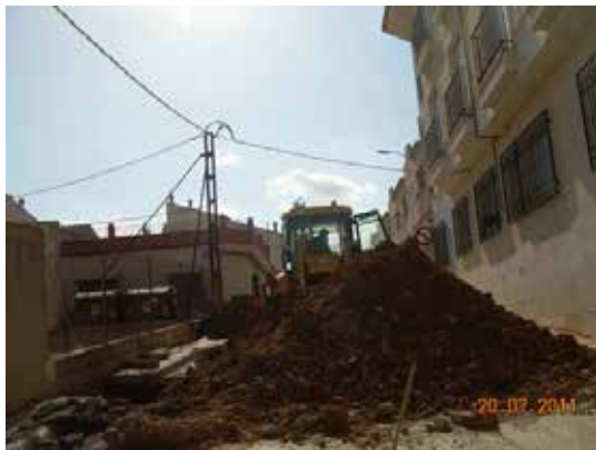
Fotografía 416. Apertura de zanja longitudinal C/ San Isidro.
