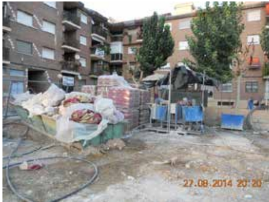
Fotografía 158. Maquinaria de inyección de cemento.
