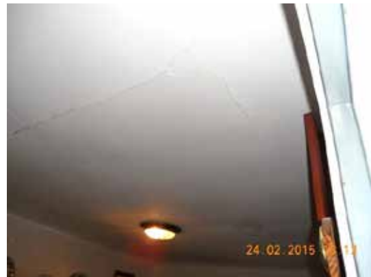
Fotografía 81. Detalle del falso techo de la cocina interior.
