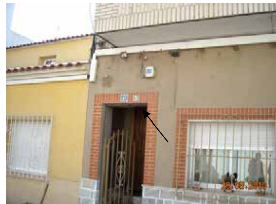
Fotografía 496. Vivienda frente a la que se produjo la avería.
