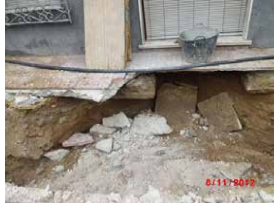
Fotografía 446. Detalle de la cimentación de una de las viviendas.
