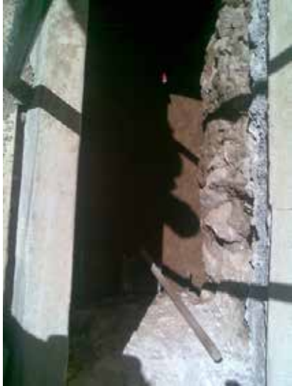
Fotografía 438. Se observan los cimientos de mampostería.
