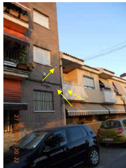
Fotografía 161. Marcas topográficas y testigos entre el bloque 5 y el dúplex colindante.
