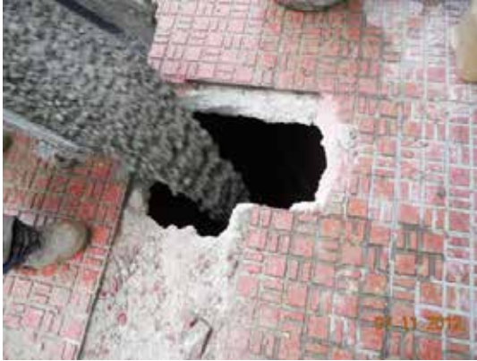
Fotografía 445. Vertido de hormigón.
