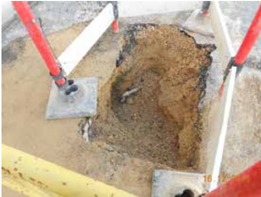
Fotografía 359. Se aprecia que la llave ha sido cambiada.
