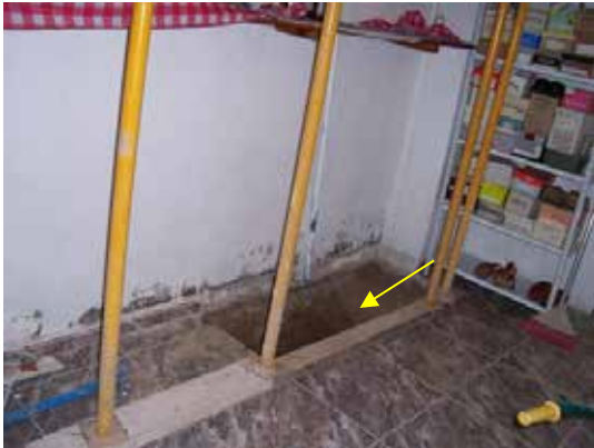
Fotografía 40. Cata junto a zapata del pilar afectado.
