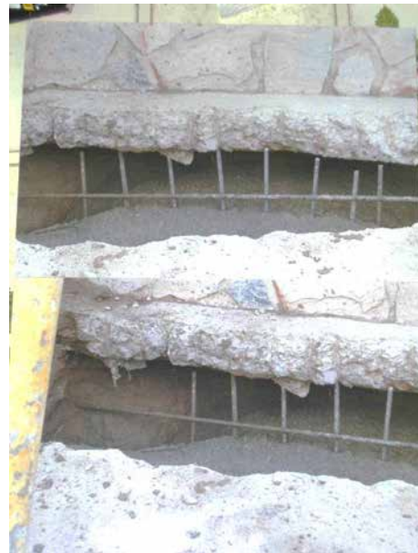
Fotografía 380. Detalle nueva cimentación con HA-25 fluido y redondos de 16mm.
