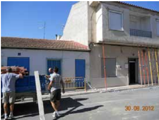
Fotografía 319. Apuntalamiento del voladizo de la primera planta.
