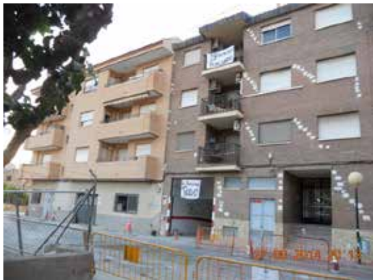
Fotografía 168. Vista general de los edificios Jofi II y Monte Azahar bloque 1.
