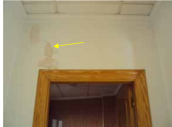
Fotografía 541. Grieta en la puerta del baño, tomada 25/04/2016.
