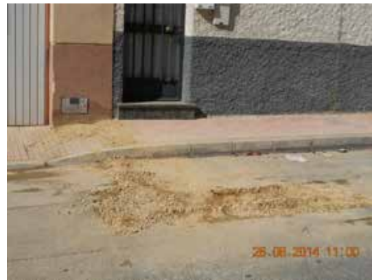
Fotografía 358. La avería completamente reparada.
