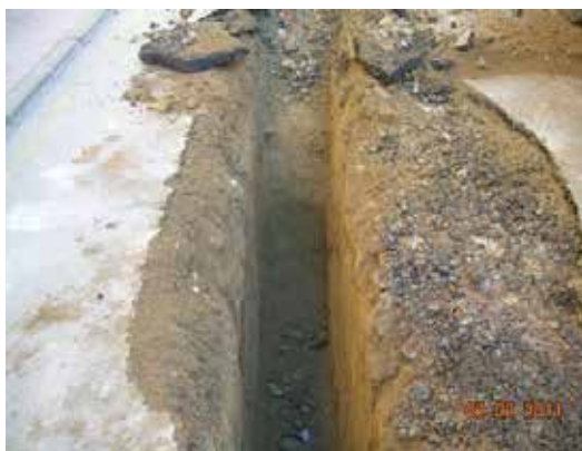
Fotografía 48. Zanja en Pedro Gambín.
