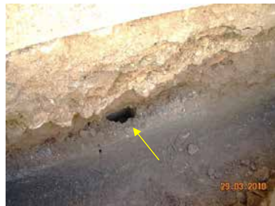
Fotografía 492. Detalle tomado de cerca del bloque de hormigón hueco.
