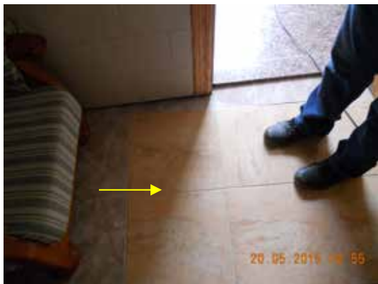
Fotografía 580. Zona con solado diferente.
