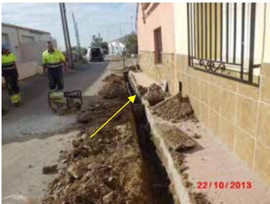
Fotografía 461. Se cambiaron las acometidas.
