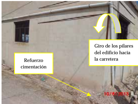
Fotografía 390. Extremo Suroeste donde se aprecia los refuerzos instalados.
