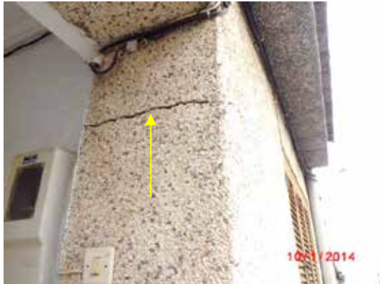
Fotografía 464. Pilar derecho del hueco de la puerta de acceso
