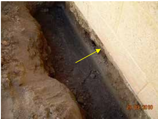
Fotografía 489. Inicio de la cata en acera se escarba y se aprecian los bloques de hormigón huecos.
