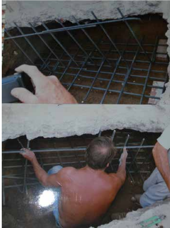
Fotografía 8. Vaciado del terreno quedando sin apoyo la estructura. Se excavó hasta terreno estable y se ha reparado ejecutando a pie de obra una zapata corrida con aceros de 16mm y un hormigón HA-30.
