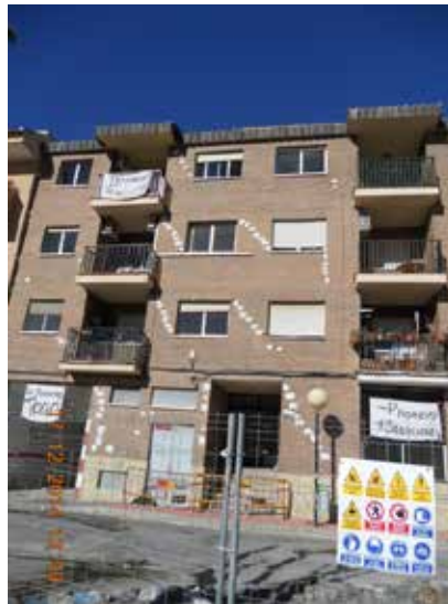
Fotografía 151. Fachada Calle Nieves Viudes Romero.
