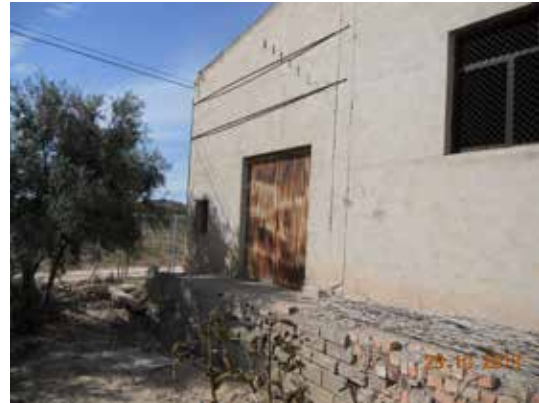
Fotografía 411.- Vista exterior de la esquina sur.
