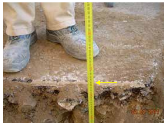
Fotografía 49. Altura de la zanja en otro punto (245cm).
