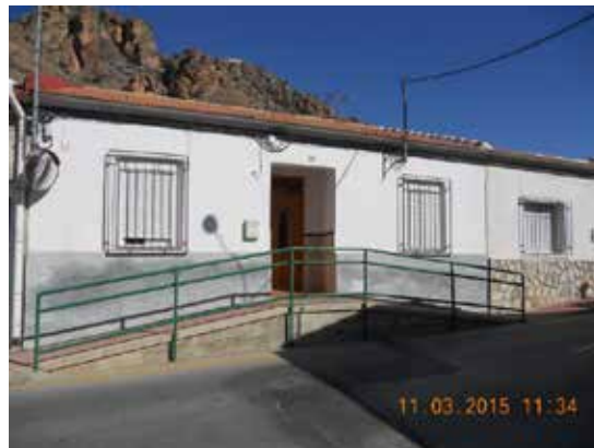
Fotografía 130. Fachada Calle Parricas 59.
