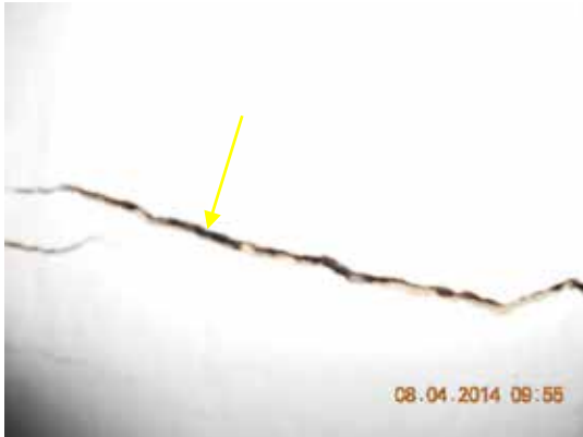
Fotografía 244. Grieta en el muro de carga cercano al lugar donde se detectó la primera avería en la acometida.
