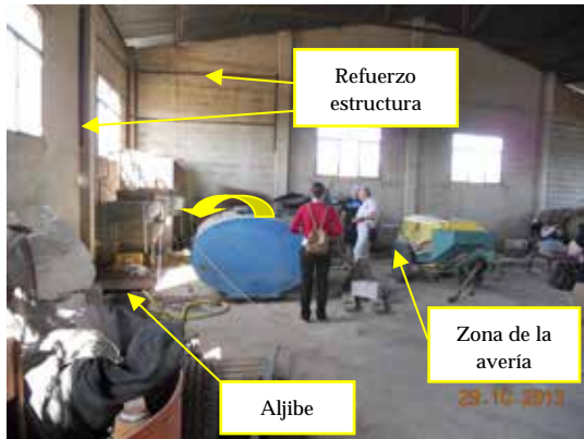
Fotografía 403. Vista general de la zona afectada
