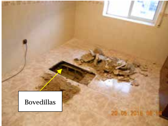
Fotografía 576. Calicata en la habitación más cercana a la fachada.
