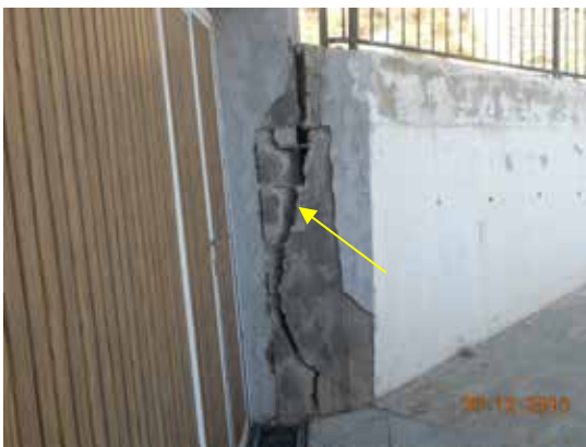
Fotografía 511. Muro de contención superior de la rampa de bajada al garaje.
