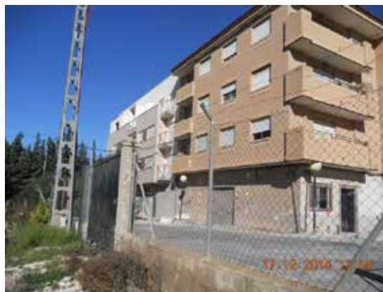
Fotografía 150. Fachada a la rambla del Garruchal.
