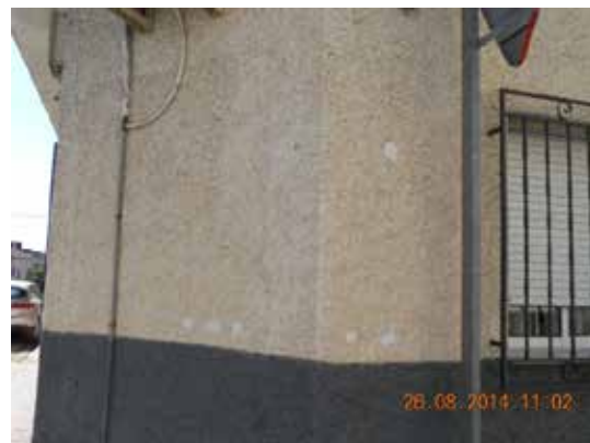
Fotografía 332. Esquina del edificio vista desde la calle Panay
