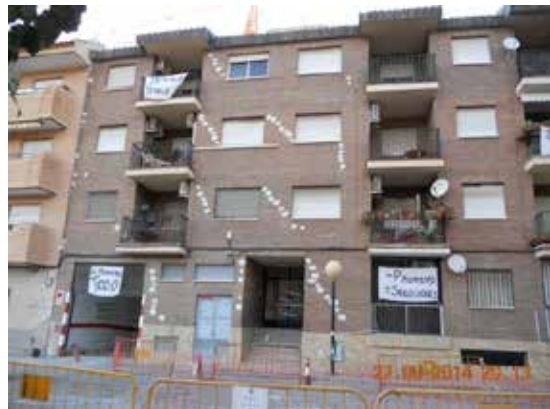
Fotografía 169. Bloque 1 de Monte Azahar al completo con sus testigos de yeso.
