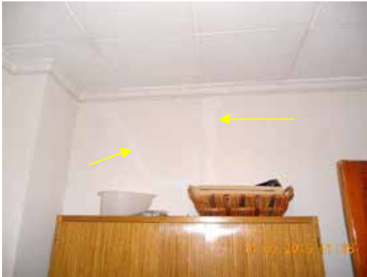
Fotografía 141. Fisuras reparadas en paramentos verticales.
