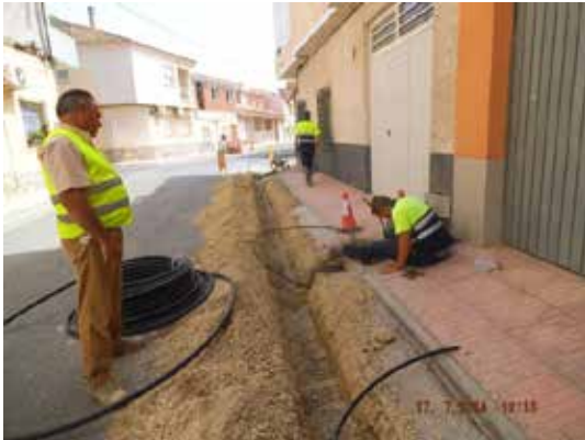
Fotografía 339. Reposición de acometida.
