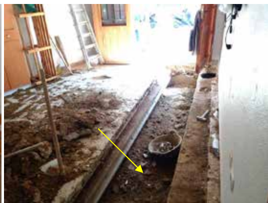
Fotografía 519. Zanja por donde instalaron la nueva red de saneamiento, se aprecia la ausencia de agua.
