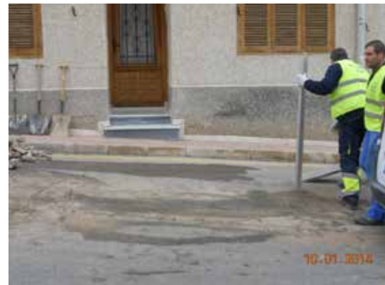
Fotografía 467. Momento de la reparación.
