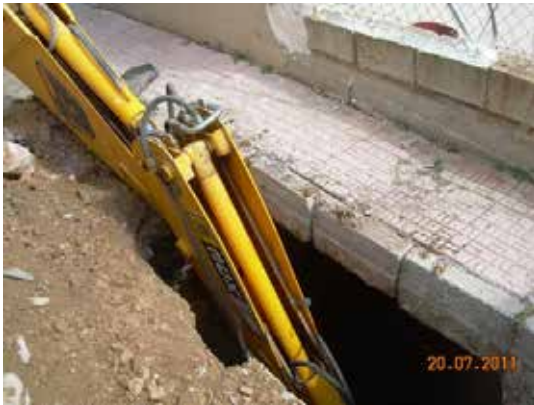
Fotografía 412. Inicio de las excavaciones en el vial junto a la acera.
