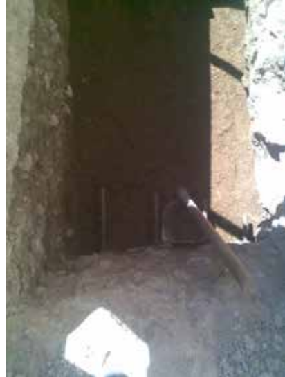
Fotografía 439. Se observan las armaduras de esperas de la zapata corrida ejecutada.
