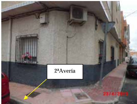
Fotografía 343. Vista general donde se aprecia donde se produjo la avería.
