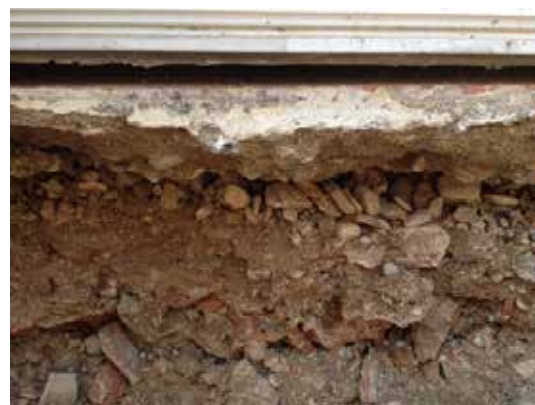
Fotografía 328. Estado de la cimentación a cota superior a la avería.
