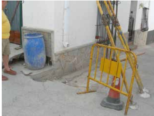
Fotografía 9. Edificio con la cimentación reparada y estabilizado.
