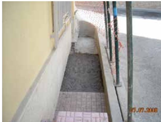
Fotografía 440. Refuerzo de la cimentación con la nueva zapata corrida de hormigón armado.
