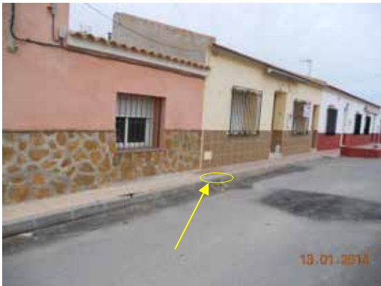
Fotografía 457. Lugar de la avería de la acometida.
