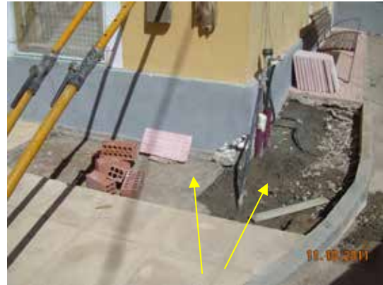
Fotografía 630. Zapata corrida en la esquina.
