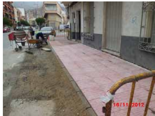
Fotografía 448. Aspecto de la obra de la acera finalizada.
