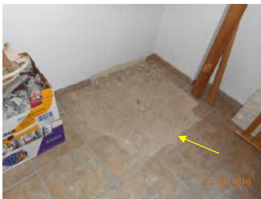
Fotografía 518. Calicata realizada en habitación junto muro de fachada.
