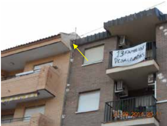
Fotografía 164. Cornisa superior del Monte Azahar donde se aprecia el desplazamiento que ha tenido el Jofi II.
