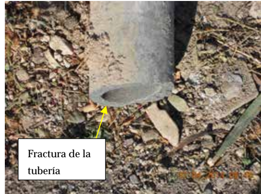
Fotografía 555. Detalle de la tubería.
