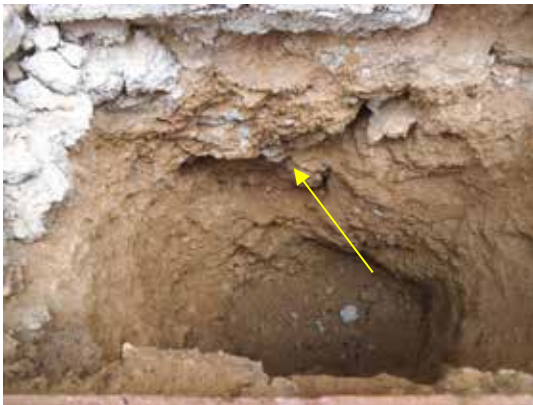
Fotografía 476. Detalle de la cimentación a base de clastos sedimentarios.
