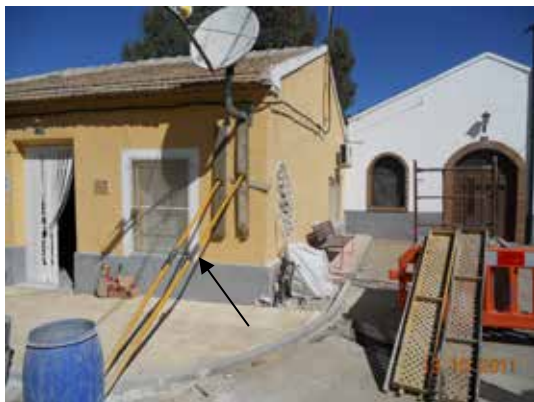
Fotografía 627. Fachada apuntalada para evitar mayores asentamientos.
