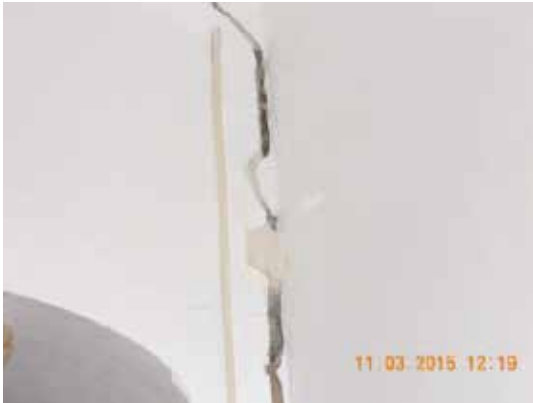
Fotografía 86. Testigo de la viga de la primera crujía no fisurado.
