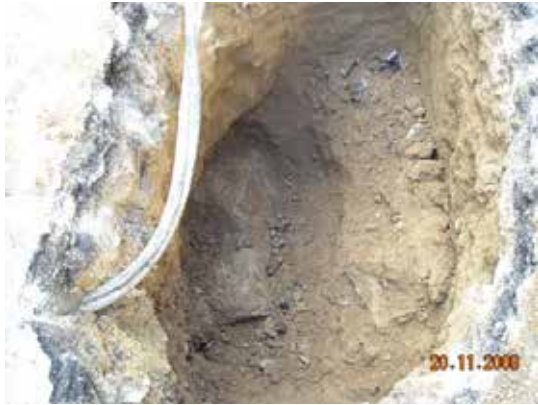
Fotografía 373. La cata se realizó donde estaban las acometidas de agua potable y la red de saneamiento.
