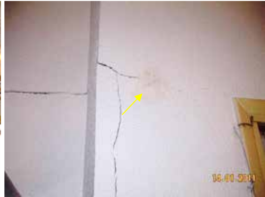
Fotografía 25. Detalle donde se aprecia la fecha en la fue colocado el testigo.
