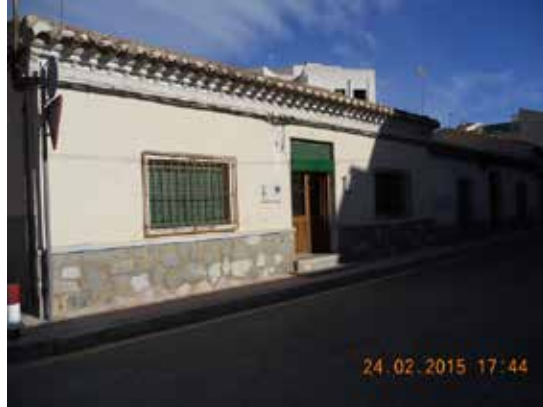
Fotografía 54. Fachada Calle Arapiles.
