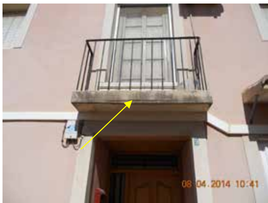
Fotografía 561. Detalle del voladizo de la balconera.
