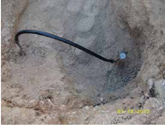
Fotografía 325. Reconexión provisional de la acometida.
