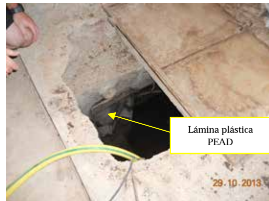
Fotografía 406.- Detalle del aljibe donde se aprecia la lámina plástica instalada.
