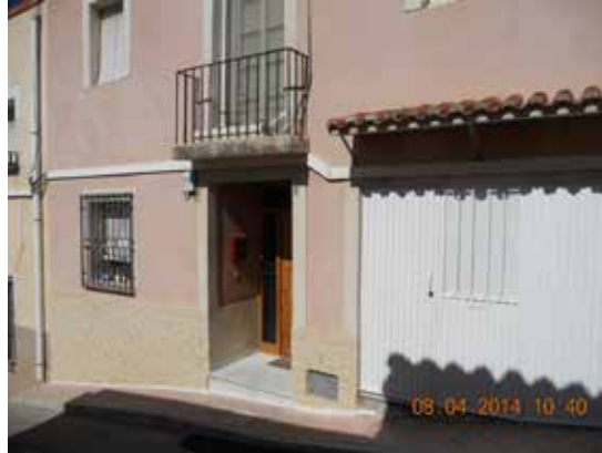
Fotografía 560. Fachada del inmueble.
