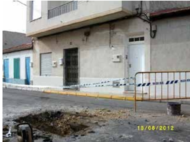
Fotografía 310. Fachada principal del inmueble con la cata en la red general.
