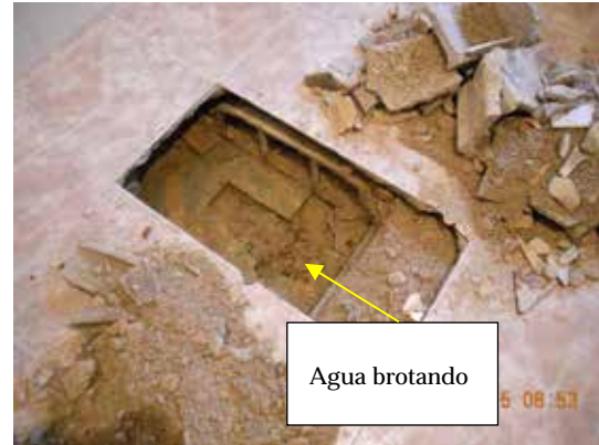
Fotografía 577. Detalle de la calicata.
