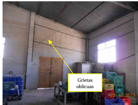
Fotografía 399.- Esquina sur de la edificación.
