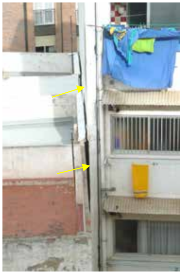
Fotografía 192. Separación con el edificio colindante.
