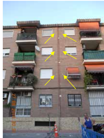
Fotografía 159. Marcas topográficas y testigos entre el bloque 3 y 4 de Monte Azahar.
