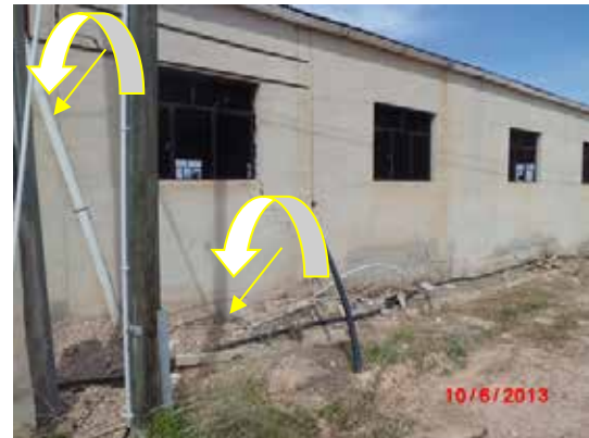
Fotografía 391. Detalle de la esquina suroeste.
