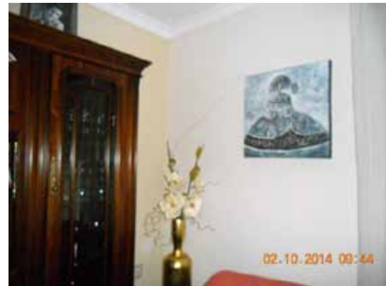
Fotografía 348. Grieta dentro del comedor en la zona más afectada.
