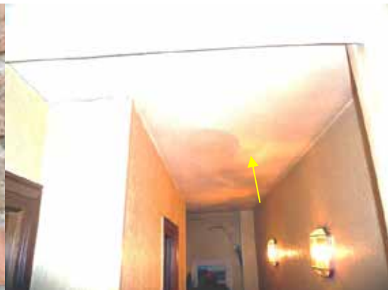
Fotografía 213. Grieta sobre un techo con el recubrimiento de yeso desprendido
