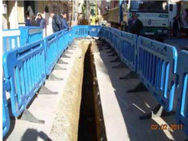
Fotografía 50. Zanja Pedro Gambín
