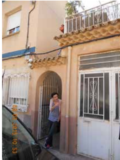
Fotografía 498. Fachada de la vivienda.
