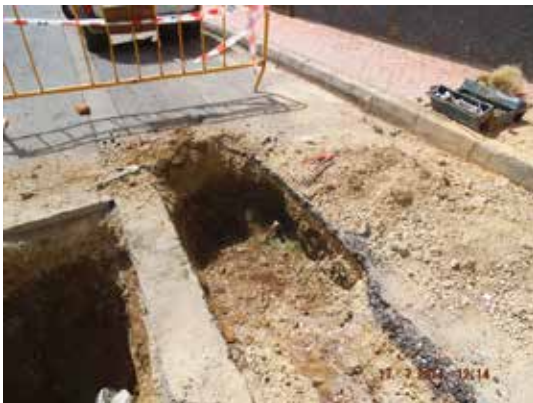
Fotografía 341. Excavación junto a la red municipal. No se aprecian lavados de finos.
