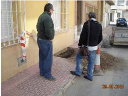
Fotografía 493. Inspección de la calicata.
