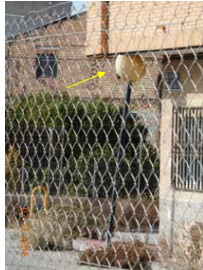
Fotografía 183. Farola tomada 07/12/2015, no parece que haya variado su posición.
