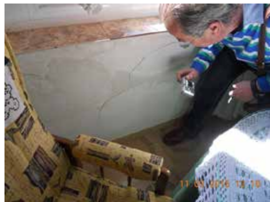
Fotografía 148. Se observa que la pared se ha enlucido con yeso recientemente.
