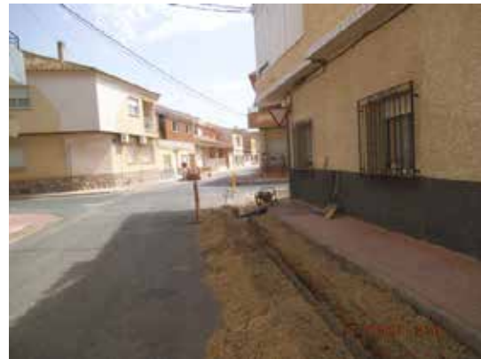
Fotografía 344. Zanja abierta en calle Panay por donde se repuso la acometida.
