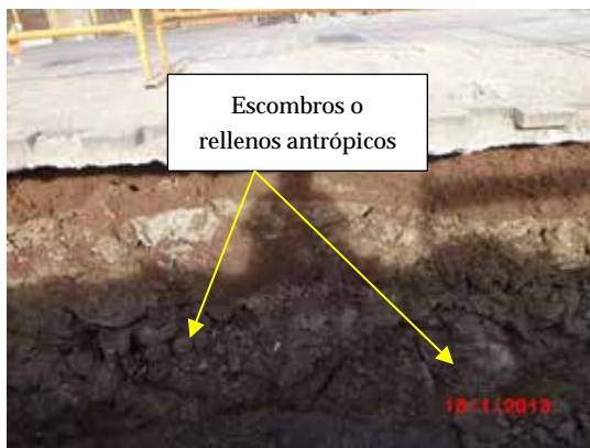
Fotografía 552. Debido a la calidad del terreno hubo dificultades a la hora de sacar el agua.
