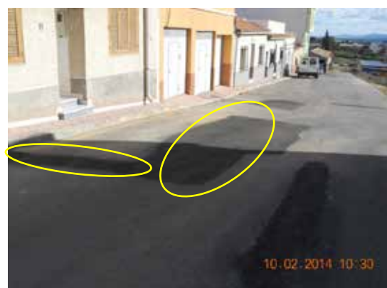
Fotografía 469. Zanjas usadas para la realización de la nueva acometida.
