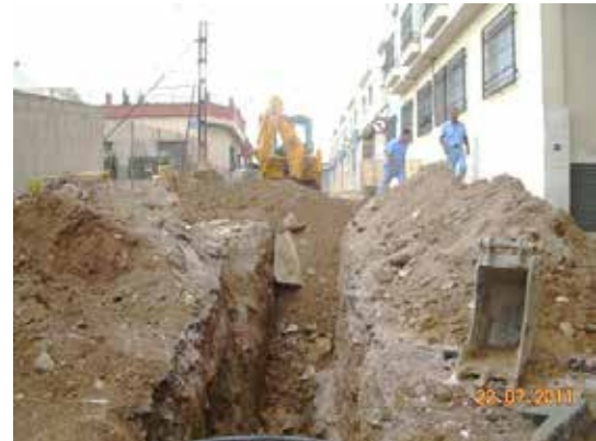
Fotografía 423. Se aprecia una excavación de más de 3 m.
