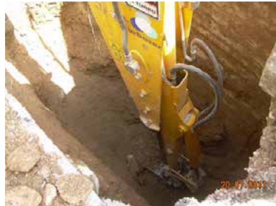
Fotografía 413. Excavación junto al muro de contención.
