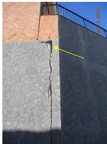
Fotografía 512. Muro de contención inferior de la rampa de bajada al garaje.
