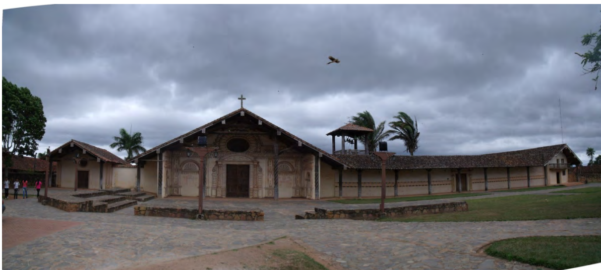
Fig. 1.- Iglesia y conjunto de edificaciones religiosas de la misión de San Javier. Fachada a la plaza. Se destacan los atrios porticados y galerías. (Fuente: autor)
