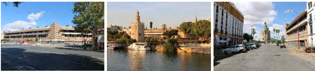
Figura 11,12 y 13. De izquierda a derecha. Vista general sur-oeste de fachada por acceso principal, vista norte desde el puente de San Telmo con Torre del Oro y Previsión Española, y vista este desde la Calle Almirante Lobo (Sevilla). Autor: Raúl Torres Rubio. Arquitecto. Fecha 14-09-2014
