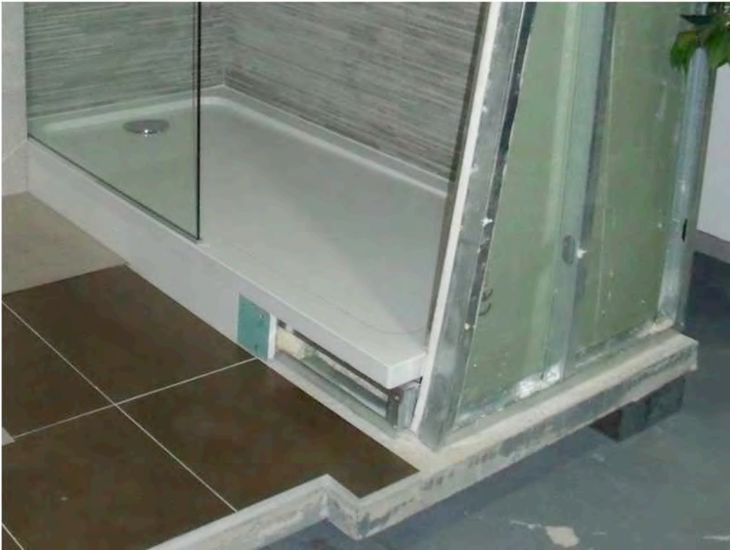
Figura 2.12.- Aislamiento bajo el pie de ducha. Conspace, año 2015
