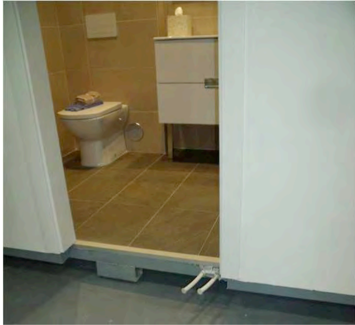
Figura 2.9.- Sifón en paramento vertical. Conspace, año 2015
