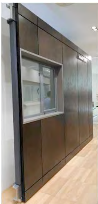
Figura 3.2.- Sistema modular de fachada. Feria de la cerámica, Butech, Porcelanosa Grupo, año 2016
