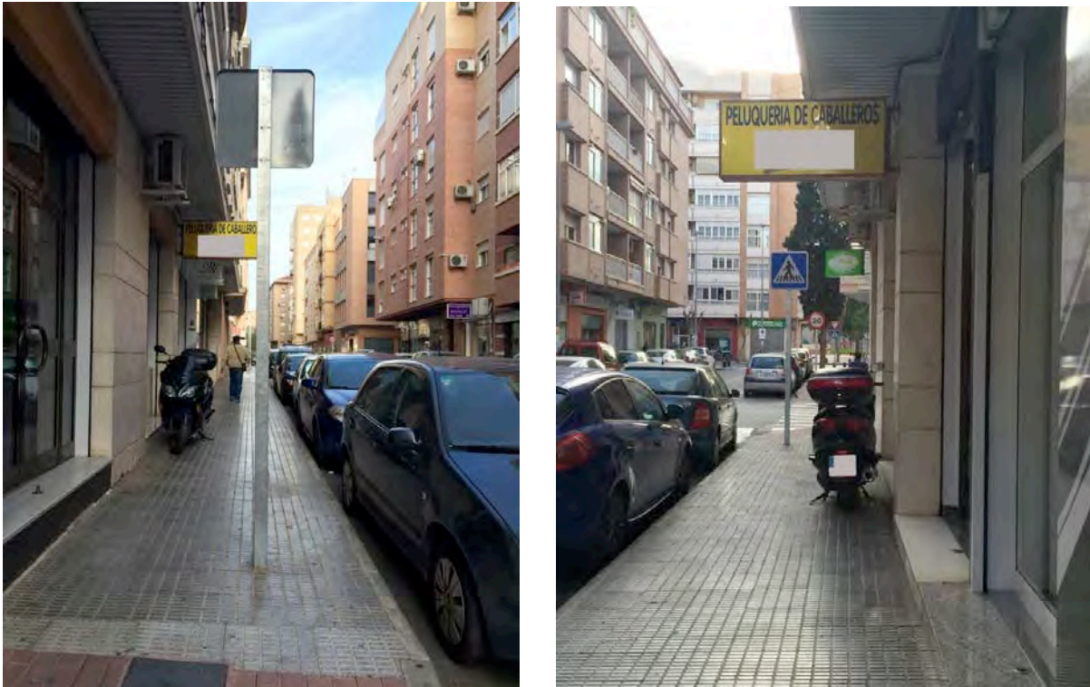
FIGURA 4.1 Y 4.2: Obstáculos fijos y móviles, en aceras de una calle de la Ciudad de Murcia.
