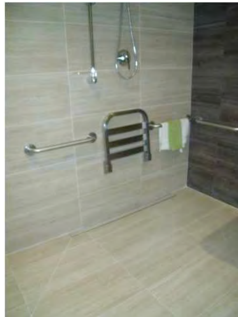
Figura 2.16.- Ducha realizada in situ con acabado cerámico. Conspace, año 2015
