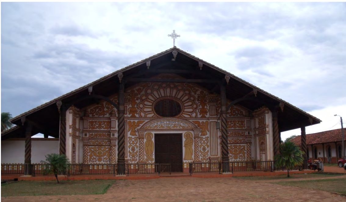
Fig. 7.- Fachada Iglesia de Concepción. (Fuente: autor)
