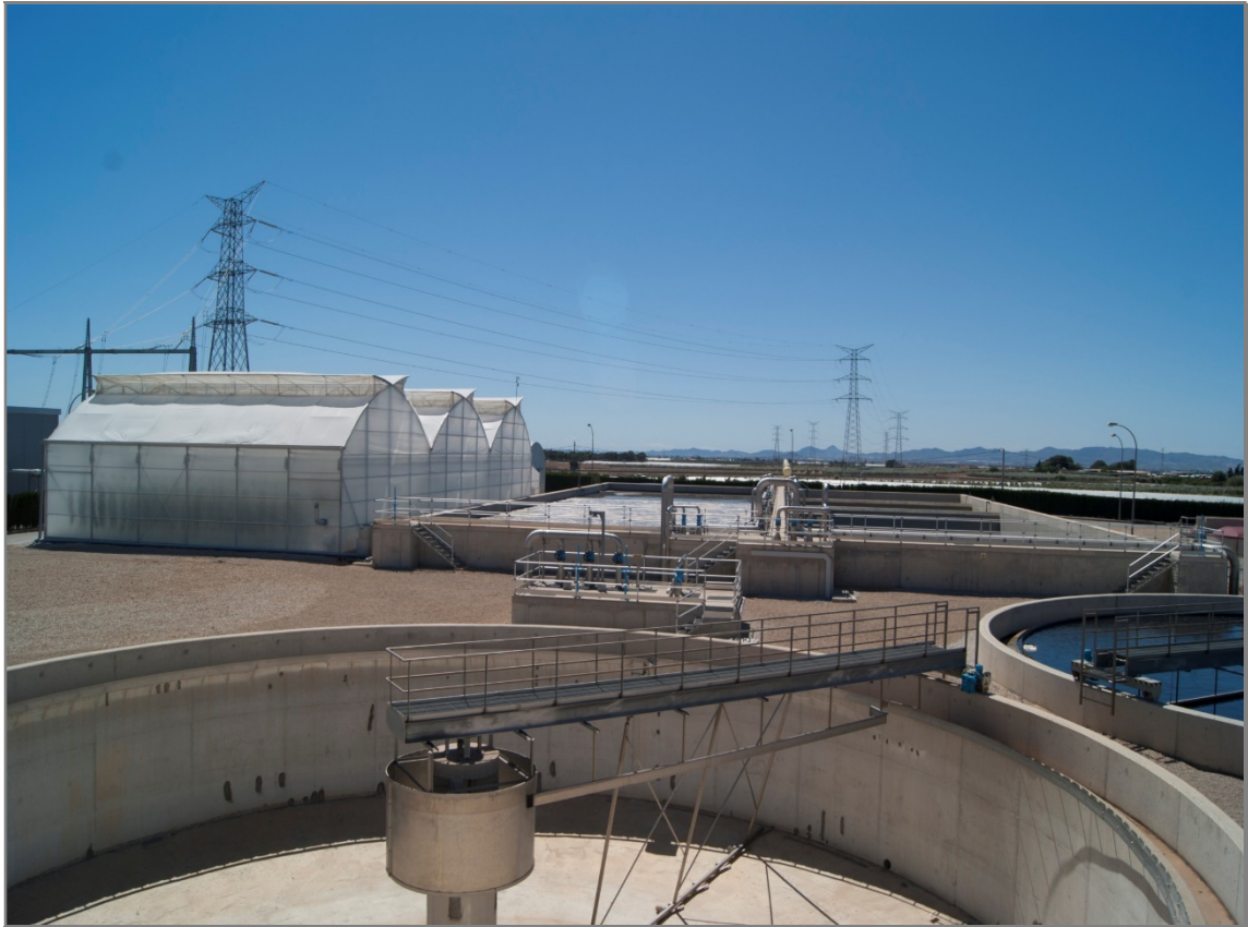
Figura 9. Vista exterior de la EDAR de Roldán-Balsicas y de los invernaderos. Fuente: CEBAS-CSIC
