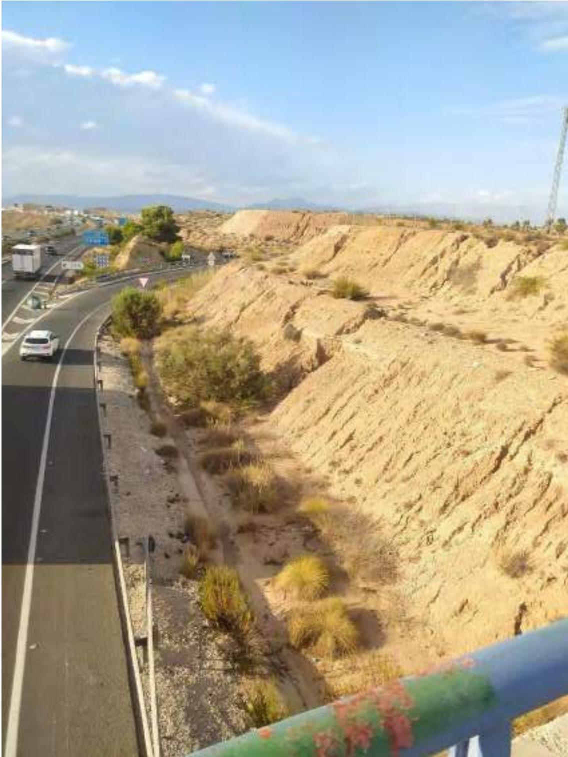
Figura 7.-Fotografía del ramal actual de la autovía A-30 (El Chorrico)
