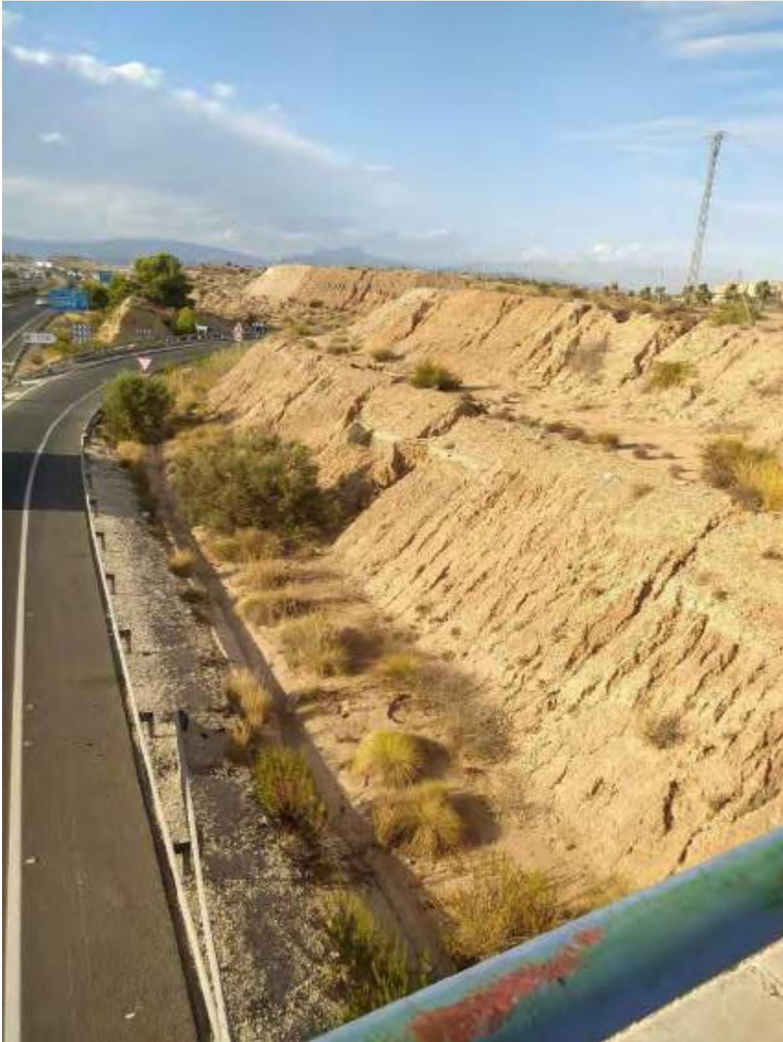
Figura 8.-Fotografía del ramal actual de la autovía A-30 (El Chorrico)
