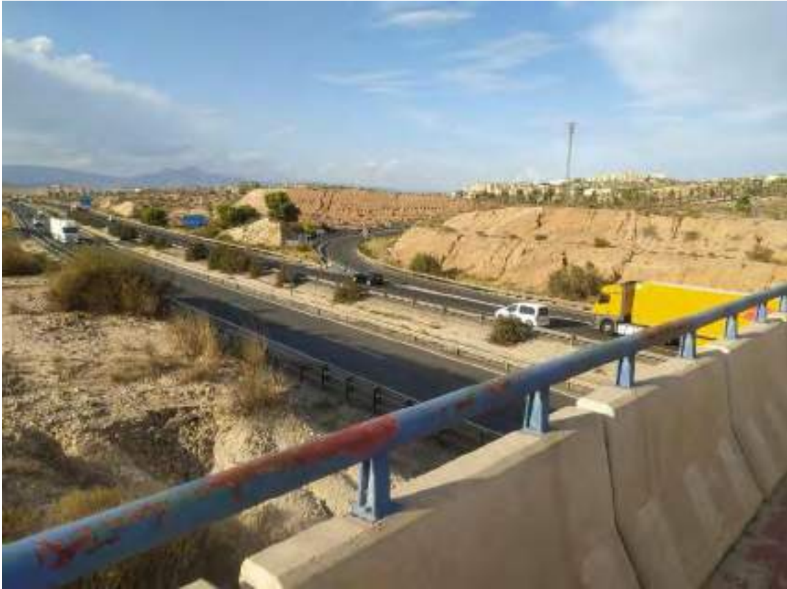
Figura 9.-Fotografía del ramal actual de la autovía A-30 (El Chorrico)
