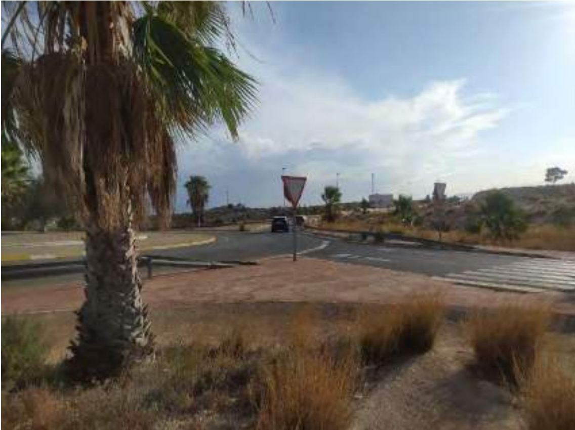
Figura 1.-Fotografía de la rotonda actual de la carretera avenida castaños (El Chorrico)
