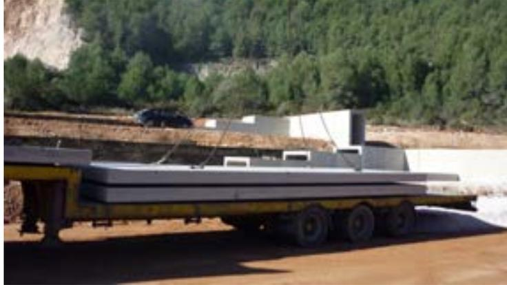
Figura 5.1.13 Descarga de las losas prefabricadas en el banco de pruebas. Fuente: elaboración propia.
