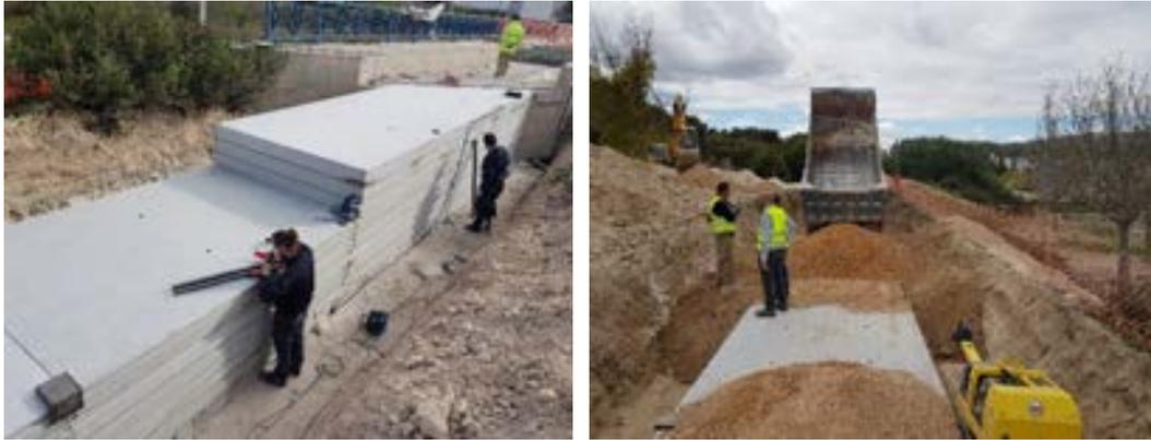
Figura 6.3.1 Instalación de las cuñas granular y prefabricada en línea ferroviaria L9 Alicante-Denia. Fuente: elaboración propia.
