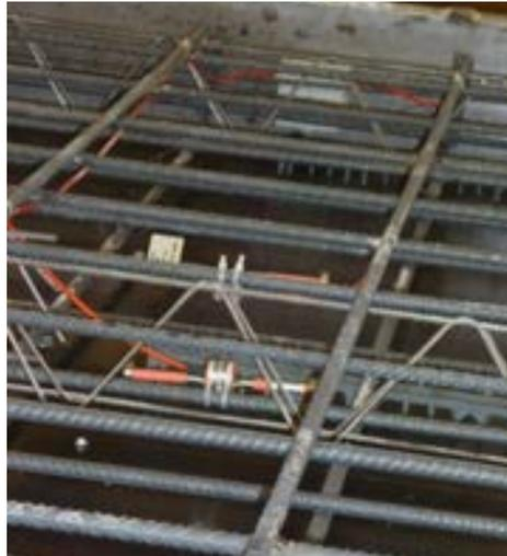
Figura 5.1.1 Imagen colocación instrumentación de losas. Extensómetros. Fuente: Elaboración propia.
