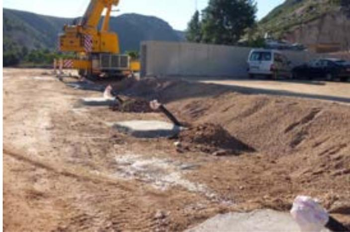
Figura 5.1.12 Detalle de la colocación de líneas de asiento en el cimientó del banco de pruebas. Fuente: elaboración propia.
