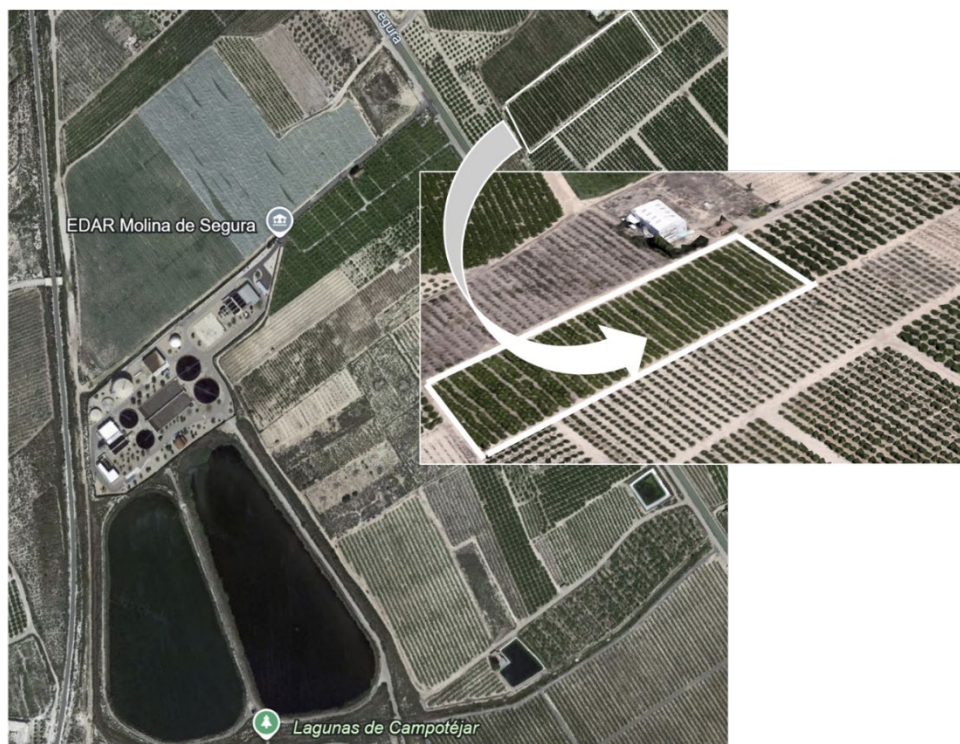
Figura 14. Vista panorámica de la parcela experimental de mandarino, el Canal del trasvase Tajo-Segura y la Estación Depuradora de Aguas Residuales (EDAR) de Molina de Segura Norte
