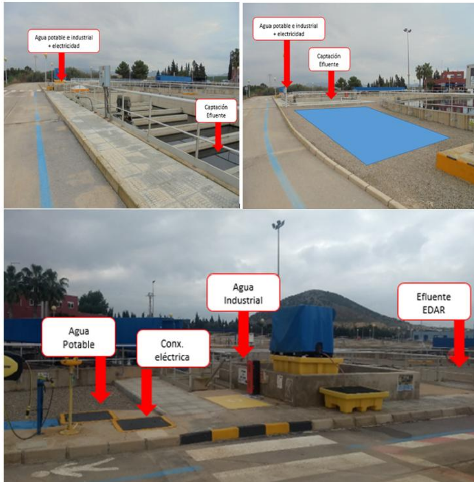
Figura V.40 Imágenes de la ubicación de los suministros necesarios para la instalación del prototipo en la EDAR de Cabezo Beaza.
