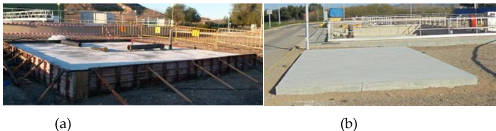
Figura V.39 Imágenes de la construcción de losa de hormigón (a) y losa terminada (b).
