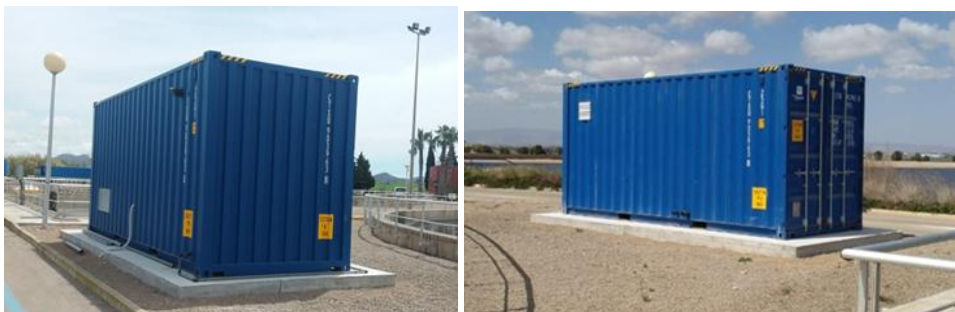
Figura V.41 Imágenes de la colocación del contenedor sobre la losa de hormigón en la EDAR de Cabezo Beaza.
