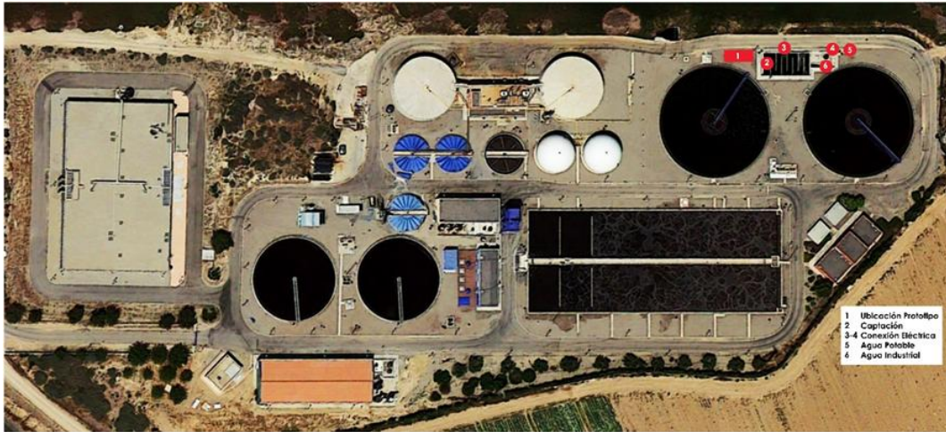
Figura V.38 Vista aérea de la ubicación de la planta piloto en la EDAR de Cabezo Beaza.
