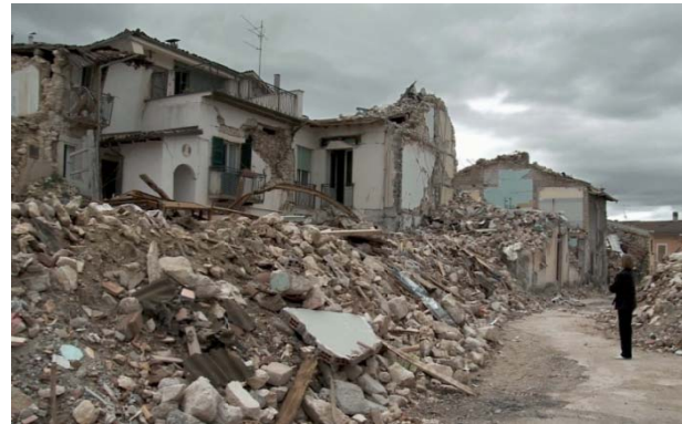
Figura 2. L'Aquila: Efectos del sismo. Fuente: cataniavera.it
