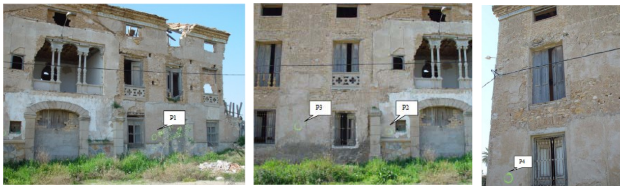
Figura 5. Ensayos esclerométricos en fachada este.
