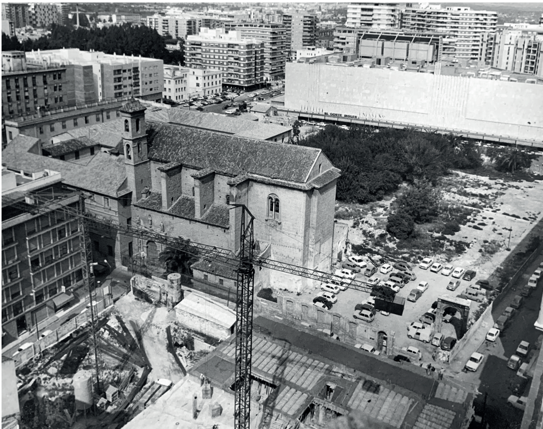
El inmueble tras la demolición del manicomio y previo a la demolición de anexos (1982)
