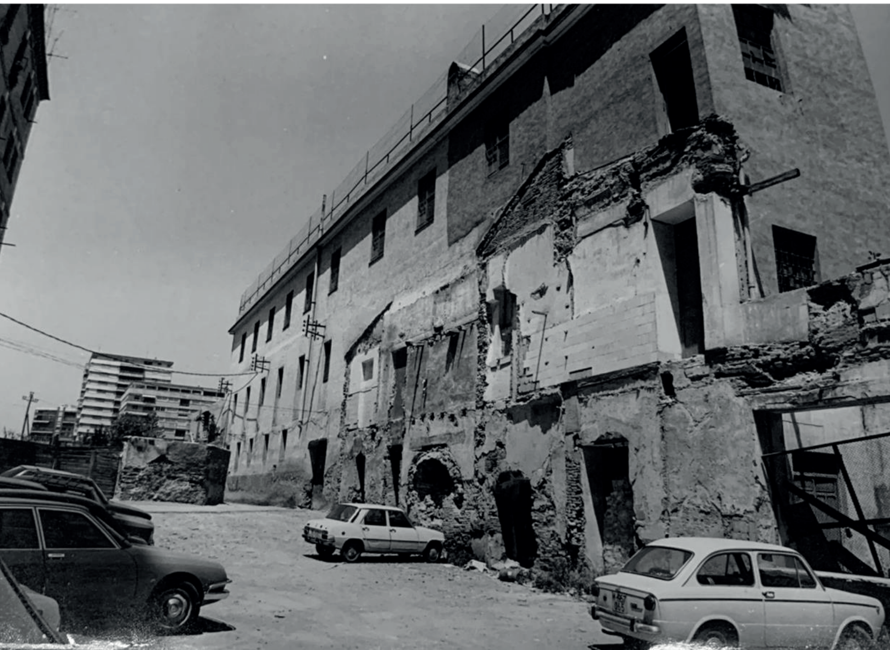
Colegio tras la eliminación de edificaciones anexas previo a rehabilitación años 80
