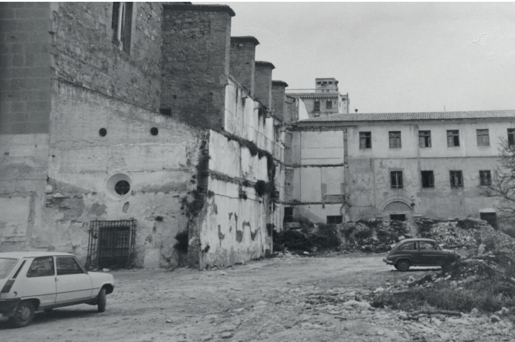
Colegio tras la eliminación de edificaciones anexas previo a rehabilitación años 80
