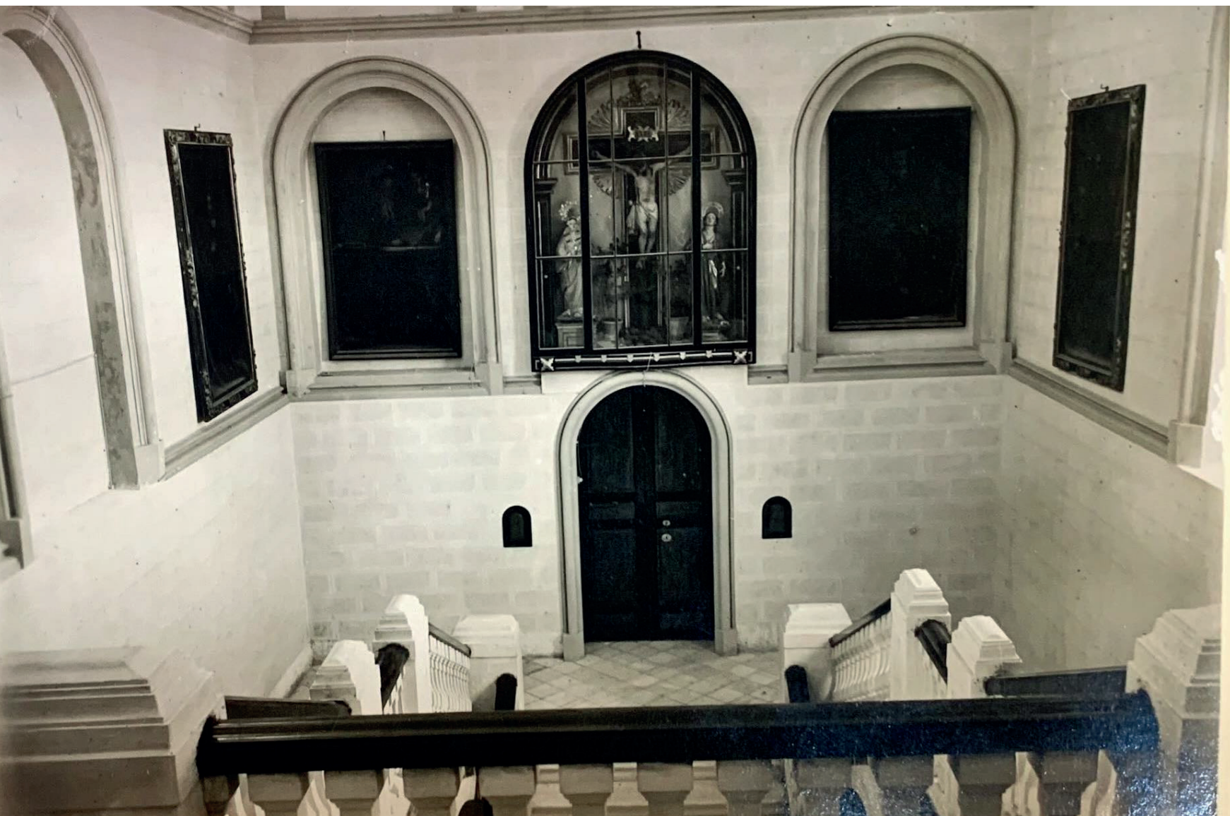
Escalera previa a la reforma años 80
