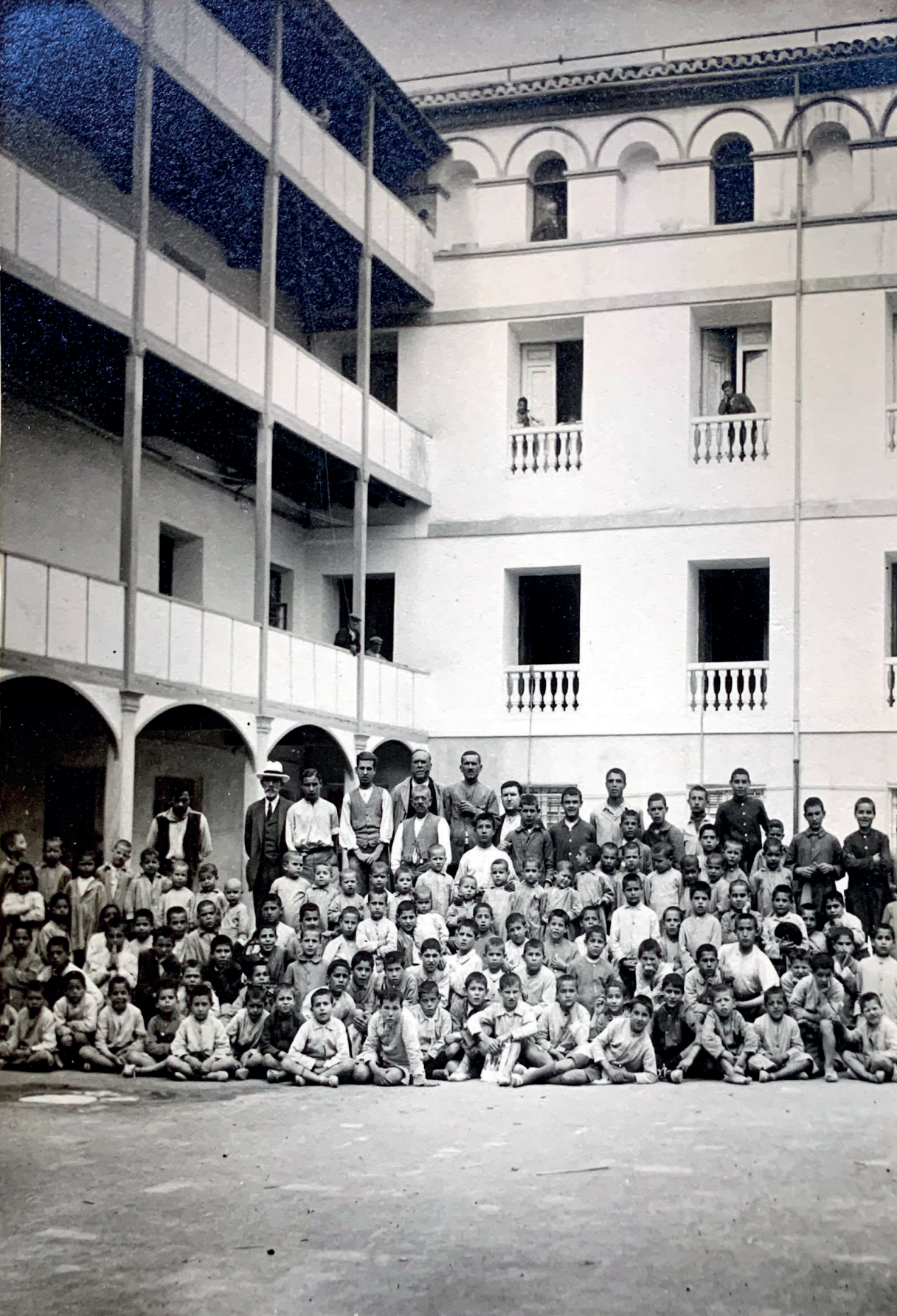
Casa de la Misericordia (ampliación) Patio de los Niños
