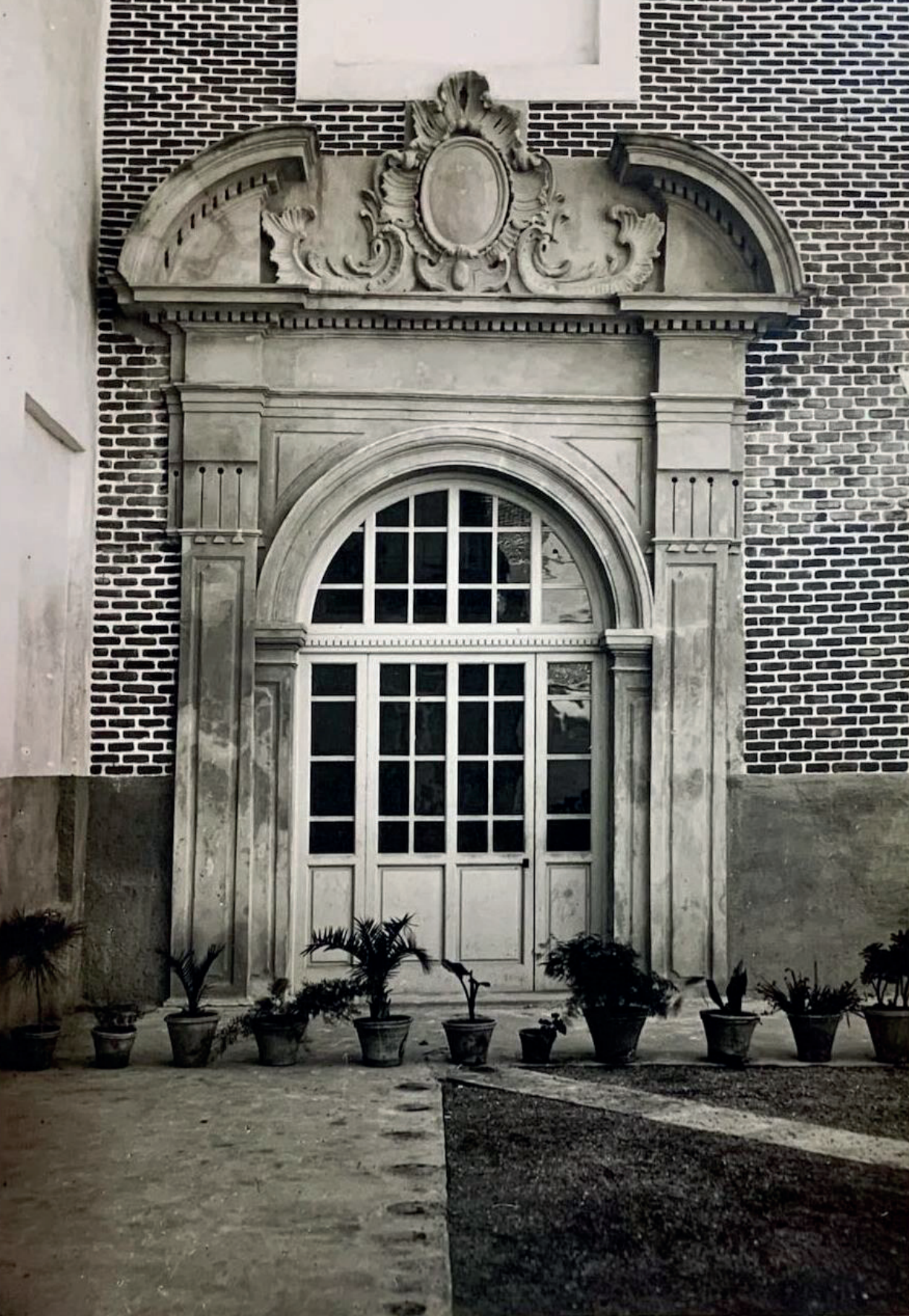
Portada acceso desde Patio Recogimiento previa a la reforma
