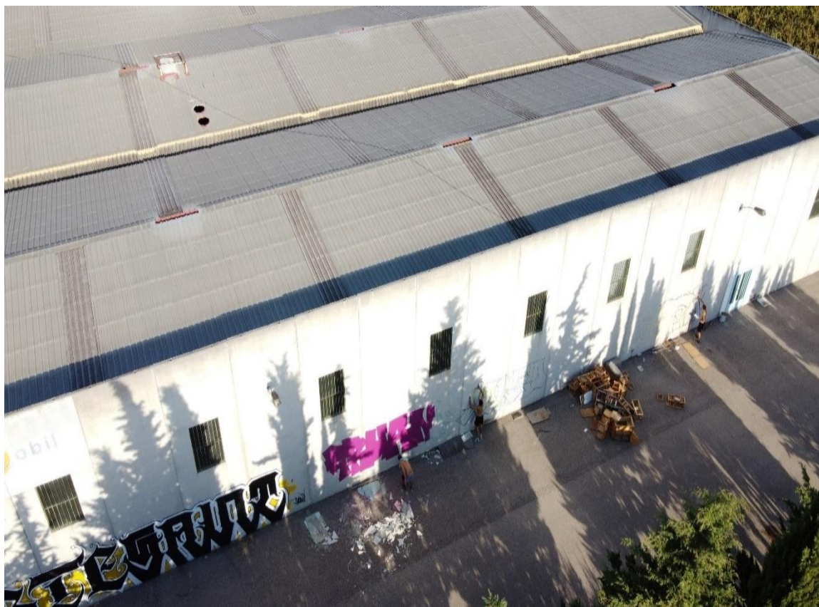
Figura 30. Fotografía aérea de los supuestos autores de los daños en la nave.
