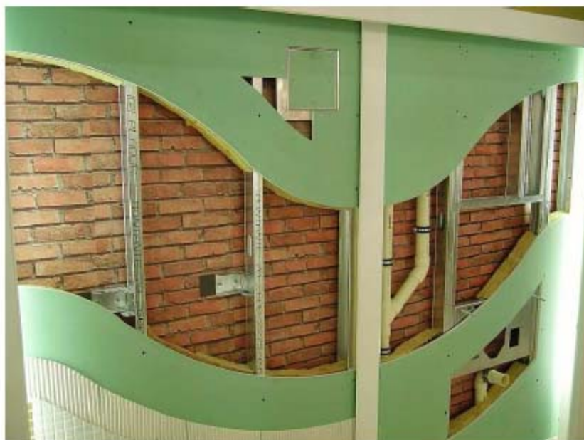
Figura 2.3. Sistema mixto cerámica y placas de yeso con paso de instalaciones.
