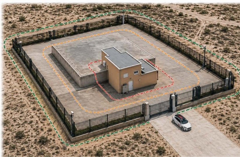
Figura 7-1 Anillos de protección del depósito de agua
