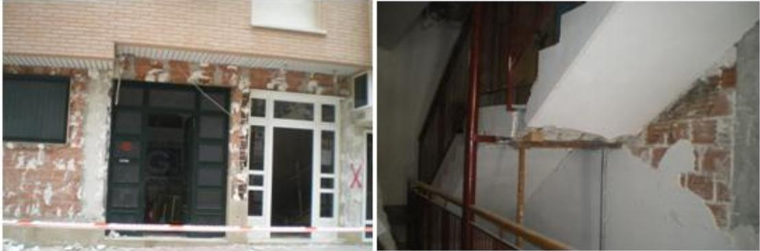
**Figura 4: Daño localizado en fachada con desprendimiento del revestimiento (Izquierda). Daño producido en escalera (Derecha). (Fuente: Los autores).**
