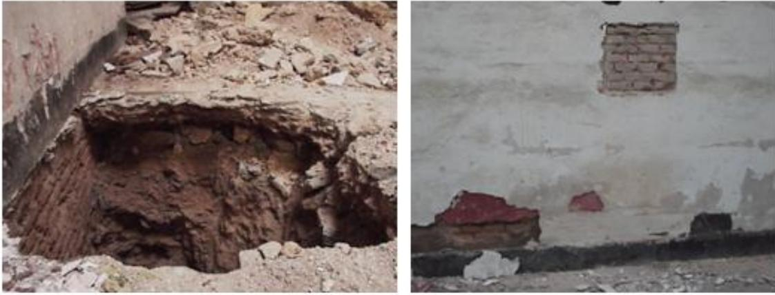
**Figura 5: Catas de inspección, para la toma de muestras. Inspección de la cimentación de los muros (izquierda). Comprobación del revestimiento (derecha). (Fuente: los autores).**
