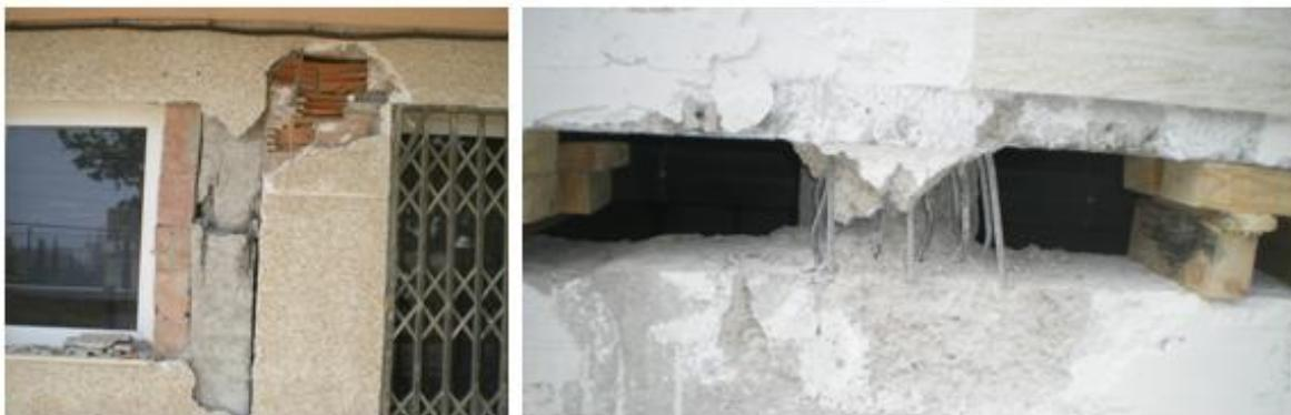
**Figura 3: Daños localizados en pilares. (Fuente: Los autores).**
