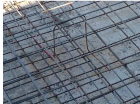
Pies de pato para apoyo de la armadura de la cara superior.
