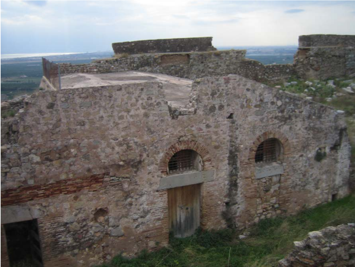
Mampostería mixta de piedra y ladrillo.
