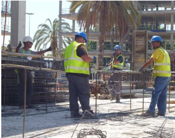
Montaje de la ferralla a pie de obra.
