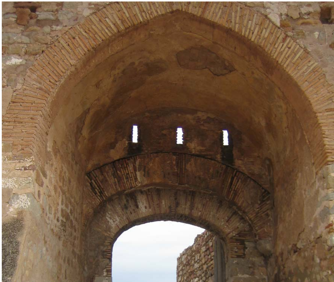
Dinteles de fábrica de ladrillo formando arcos rebajados o apuntados.
