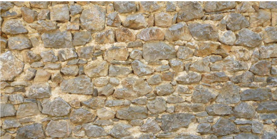
Muro de mampostería ordinaria, con mampuestos sin labrar tomados con mortero.
