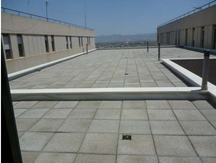
Cubierta invertida con losa filtrante. Ampliación del hospital de Lorca.
