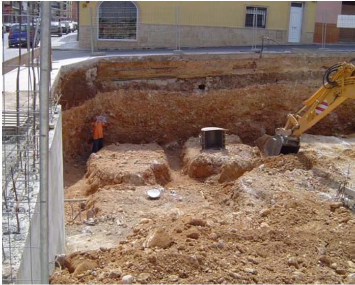
Excavación de las zanjas de zapatas y vigas. Vertido del hormigón de limpieza en el fondo de la excavación, proporcionando la base adecuada para los cimientos.
