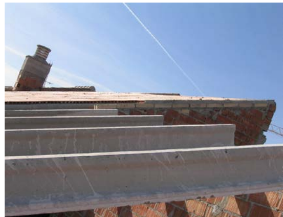
Cubierta inclinada sobre viguetas de hormigón pretensado.
