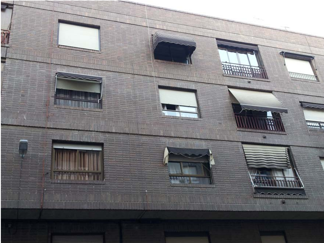
Fachadas de ladrillo caravista con aparejo de sardineles en dinteles de ventana y frentes de forjado.
