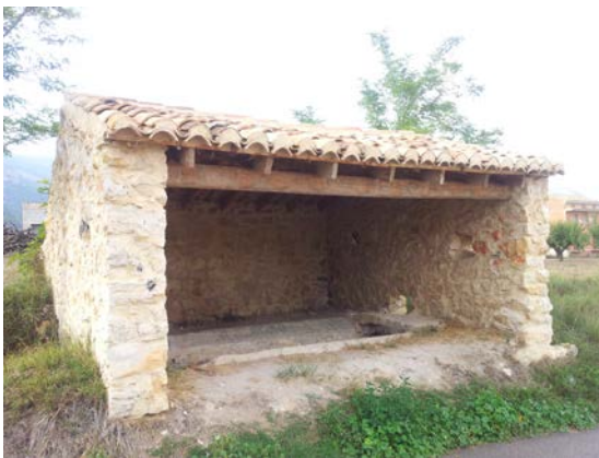
Cubierta inclinada sobre pares de madera.
