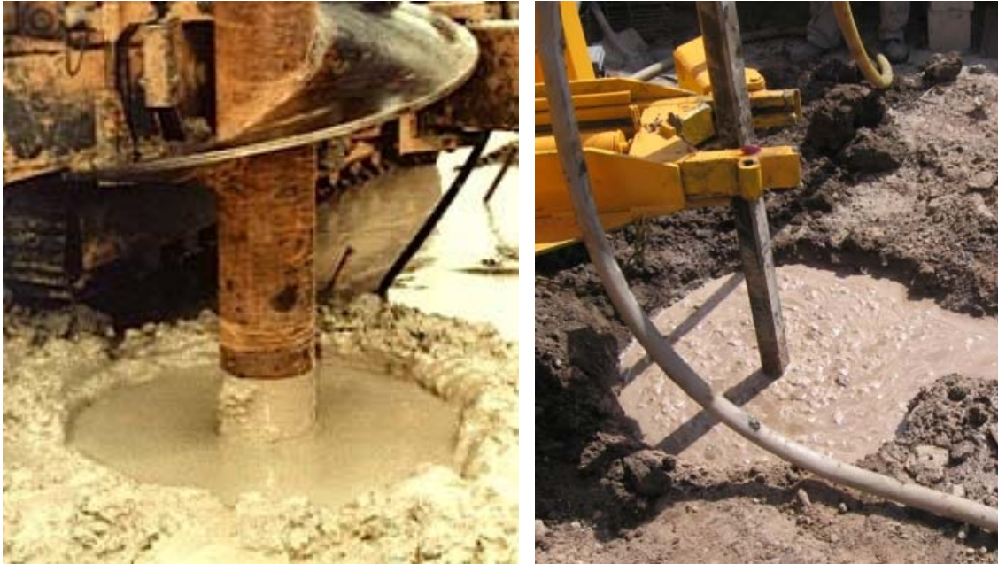
Ejecución de pitole de extracción con lodos bentoníticos. Fuente: <www.canalconstruccion.com> y <www.ingenierosaivel.com> [Consulta: 1 de marzo de 2015].
