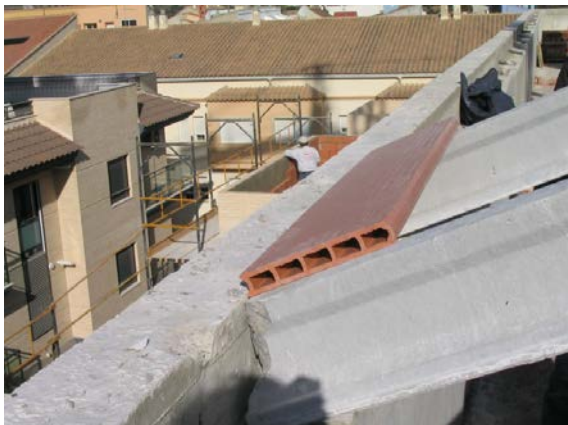
Cubierta inclinada sobre viguetas de hormigón pretensado.
