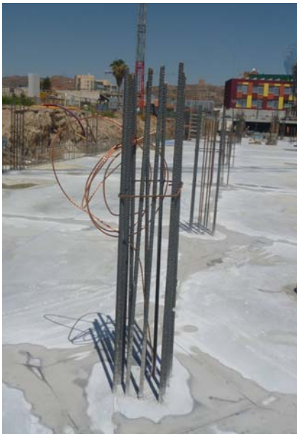
Armaduras en espera y replanteo del pilar.
