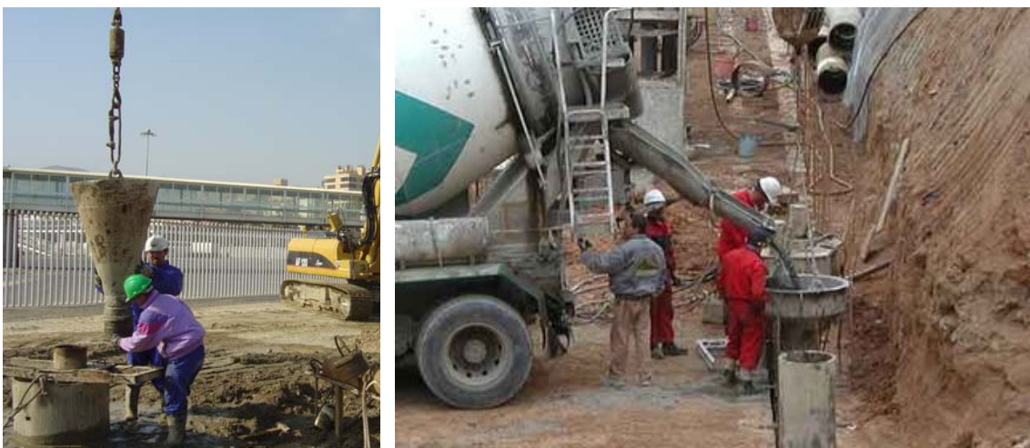
Hormigonado de pilotes. Fuente: < www.tecnoiberica.es > y < www.construmatica.com > [Consulta: 1 de marzo de 2015].
