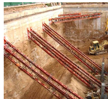
Apuntalamiento contra el fondo de la excavación. Dibujos basados en el CTE DB SE-C-75. Fuente: <www.hotfrog.es> [Consulta: 4 de febrero de 2014].
