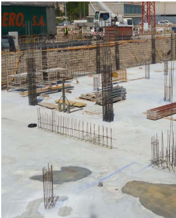
Disposición de armaduras de pilares y muros previo al hormigonado.
