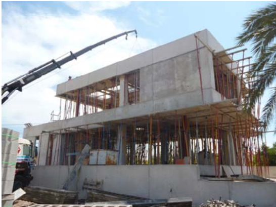
Hoja exterior del cerramiento de hormigón visto ejecutado in situ.
