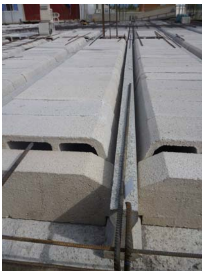
Disposición de los nervios, armaduras longitudinales de negativos y armadura de reparto.
