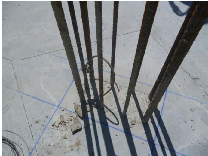
Armaduras en espera y replanteo del pilar.
