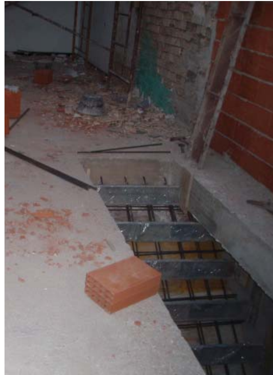
Disposición de las armaduras del tablero y los peldaños de la escalera de hormigón armado.
