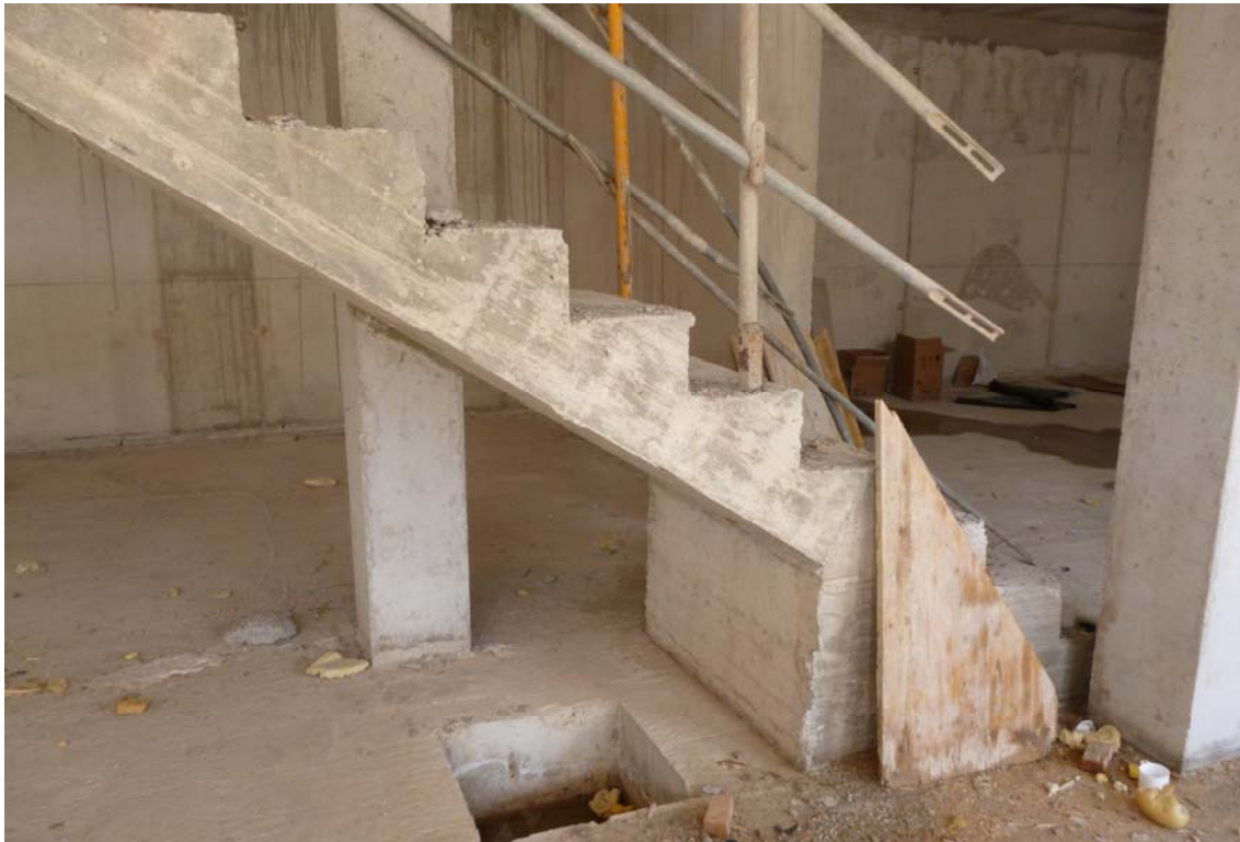
Arranque de escalera con recrecio de hormigón armado.
