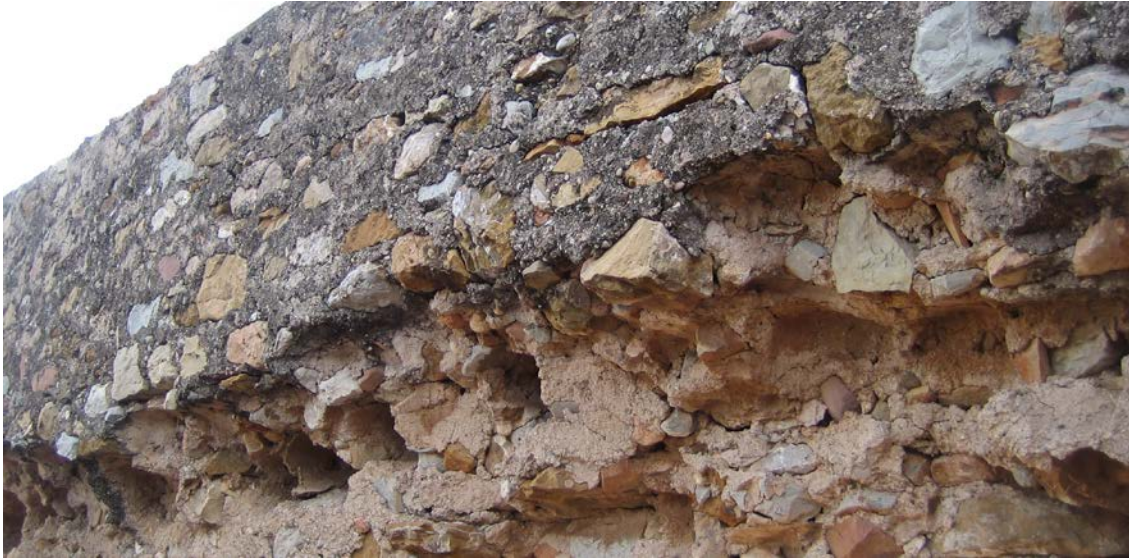
Muro de mampostería sin apenas ninguna labra, tomadas con morteros.
