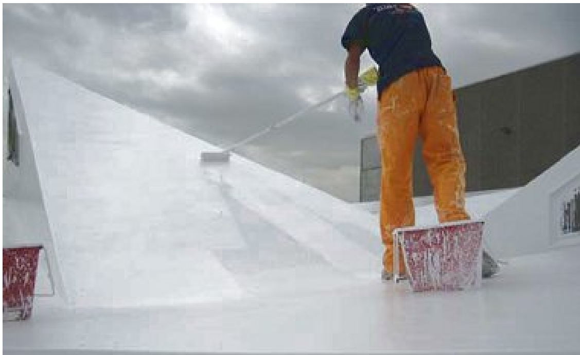
Impermeabilización de cubierta inclinada con poliuretano líquido. Fuente: < www.generadordeprecios.info > [Consulta: 20 de mayo de 2018].
