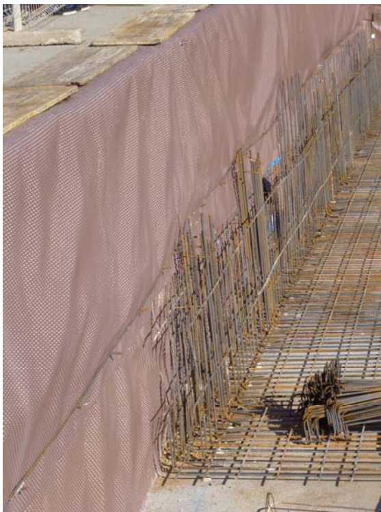
Drenaje de muro con lámina nodular. < www.generadordeprecios.info > [Consulta: 18 de febrero de 2012]. Remate superior con perfil metálico < www.archiexpo.es > [Consulta: 18 de febrero de 2014].
