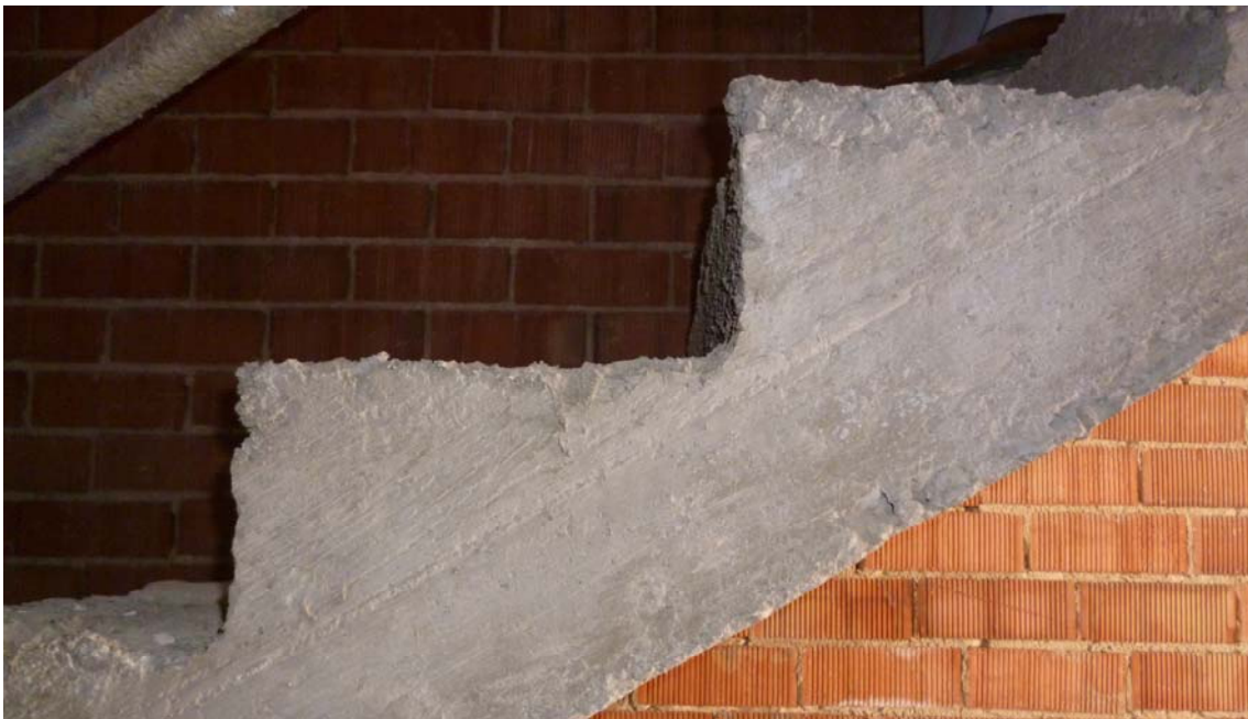
Peldaños de escalera de hormigón armado, hormigonados de forma simultanea al tablero.
