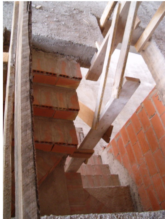
Escaleras de peldaños de hormigón o peldaños tradicionales de ladrillo cerámico hueco.
