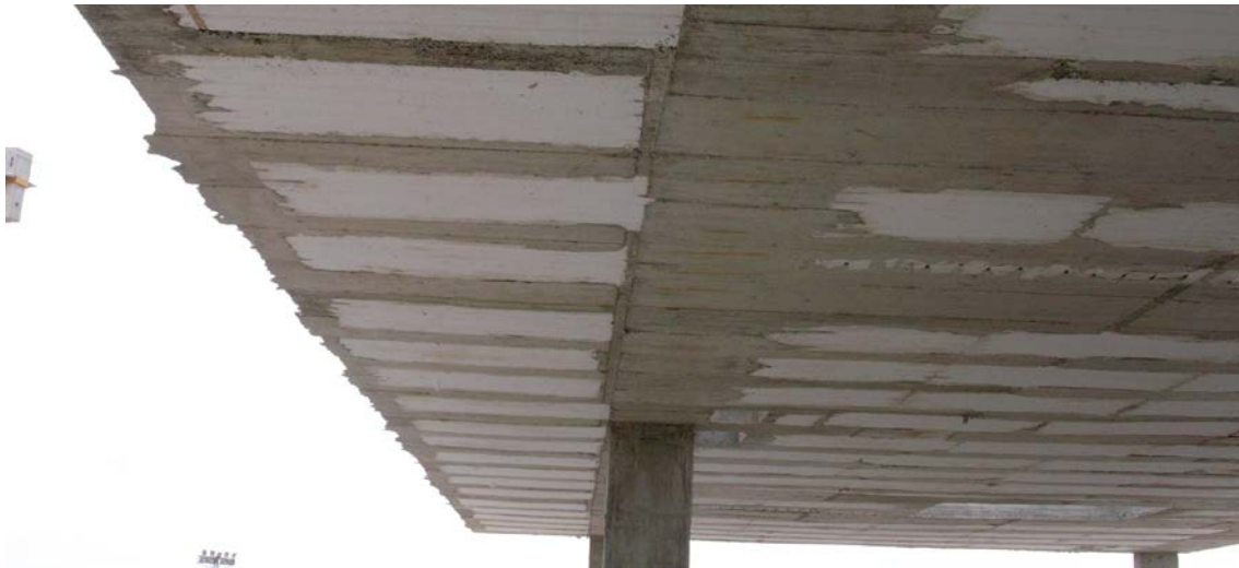
Forjado de cubierta resuelto con bovedillas de poliestireno.
