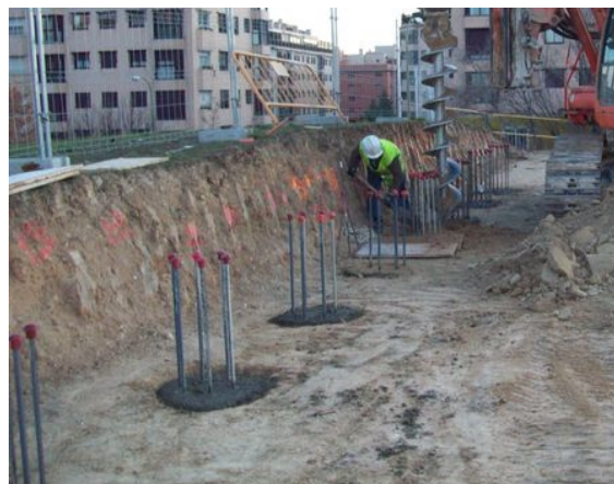
Armaduras de los pilotes. Fuente: < www.kiev.all.biz > y < www.mypfundaciones.com > [Consulta: 1 de marzo de 2015].
