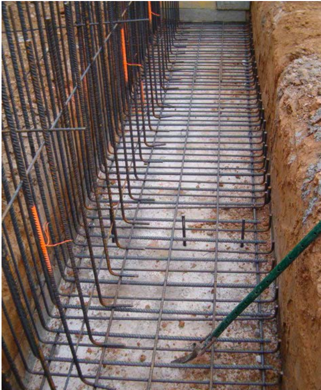
Pies de pato para apoyo de la armadura de la cara superior.
