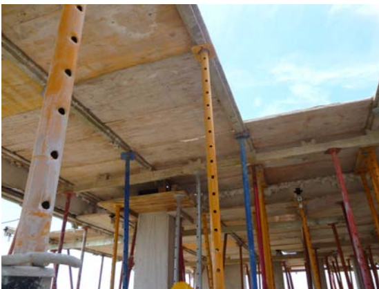
Encofrado de un forjado con nervios ejecutados in situ.
