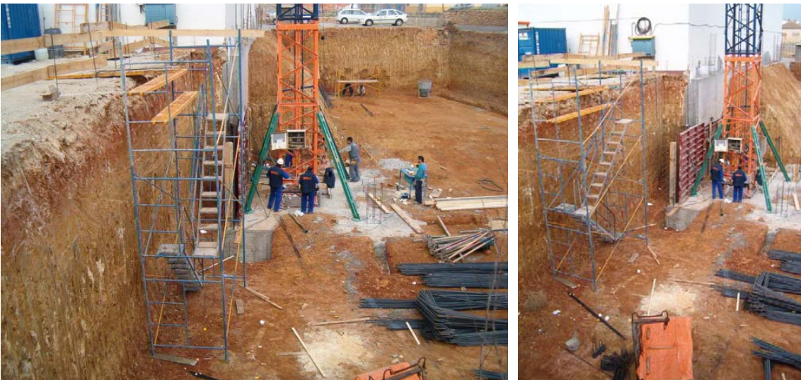
Hormigonado de la cimentación.
