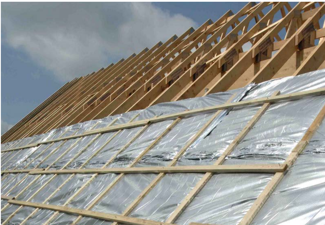
Aislamiento cubierta inclinada con aislamiento reflexivo. Fuente: <Arelux> [Consulta: 20 de mayo de 2018].
