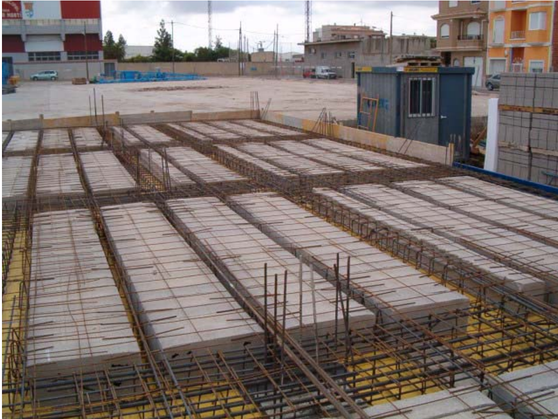
Armaduras en espera del pilar atravesando un forjado intermedio.
