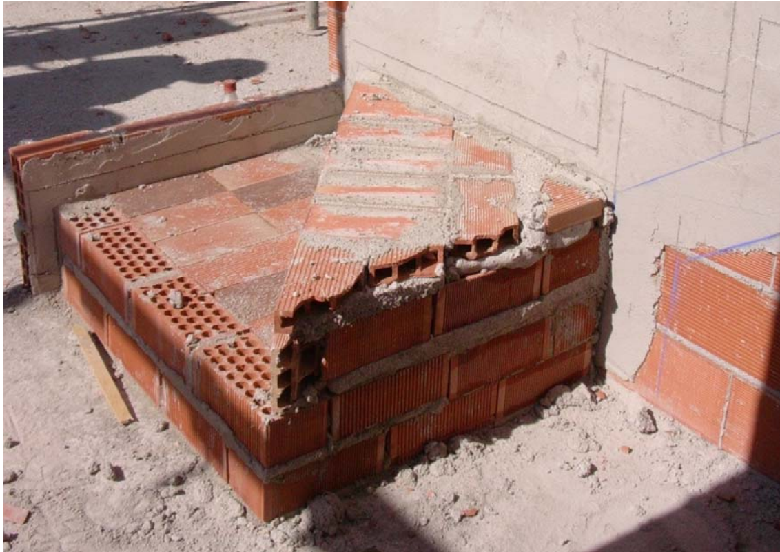
Peñaños de arranque de escalera ejecutado con recrecio de ladrillo perforado y rasillas cerámicas.
