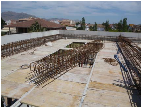
Disposición de las armaduras de las vigas, zunchos y brochales.
