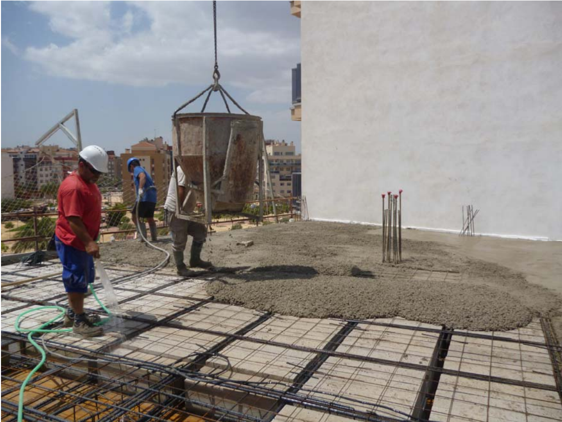
Hormigonado del forjado con tobera.
