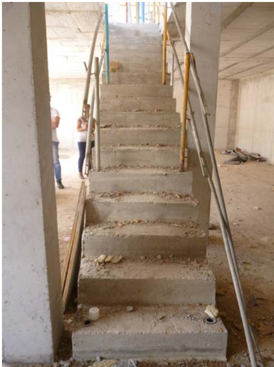
Escaleras de peldaños de hormigón o peldaños tradicionales de ladrillo cerámico hueco.
