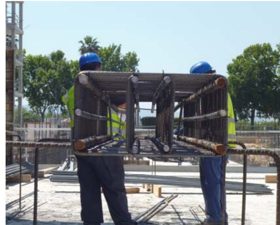
Montaje de la ferralla a pie de obra.
