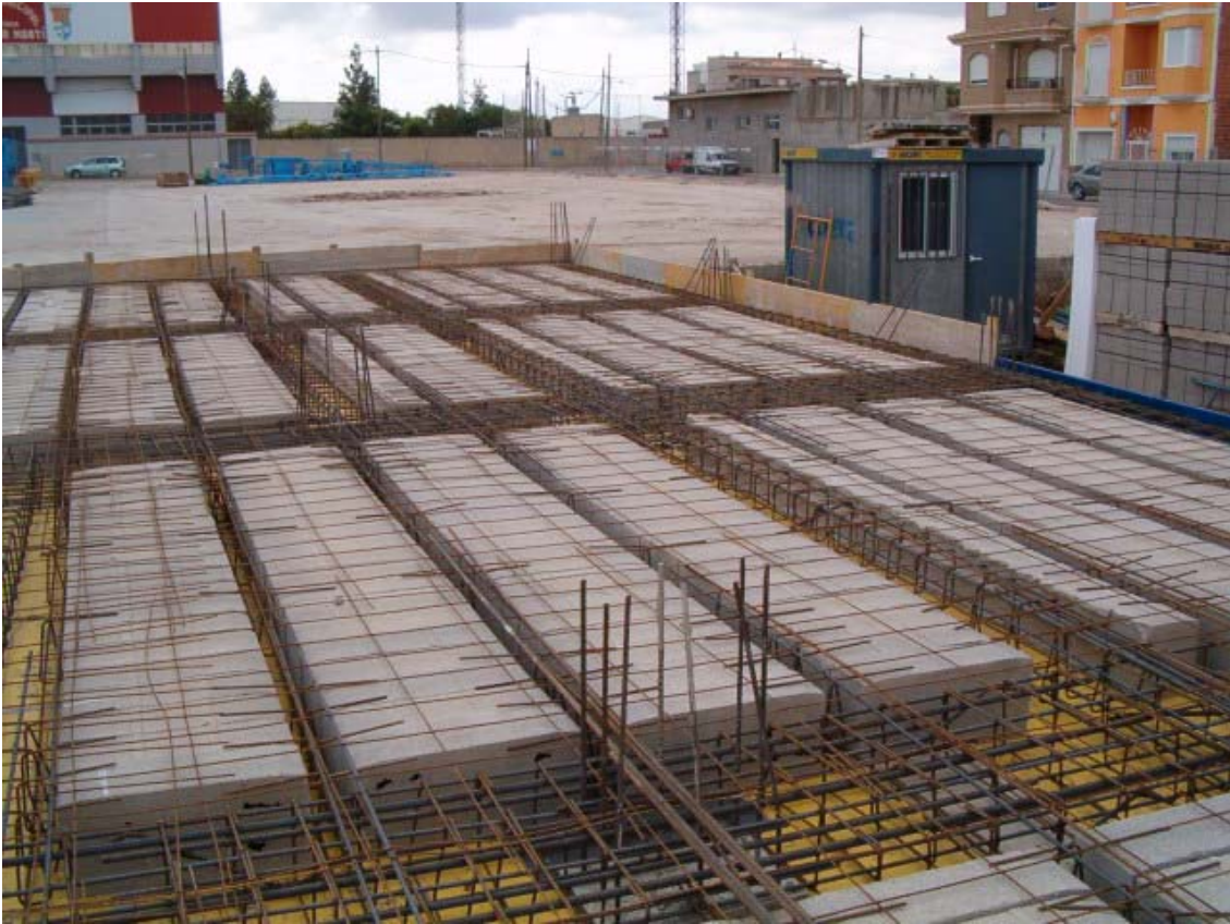
Armado de forjado unidireccional con nervios in situ. Disposición de zunchos en borde y en apoyo de fábrica pesada.
