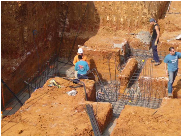
Armado de zapatas y vigas centradoras y de atado.
