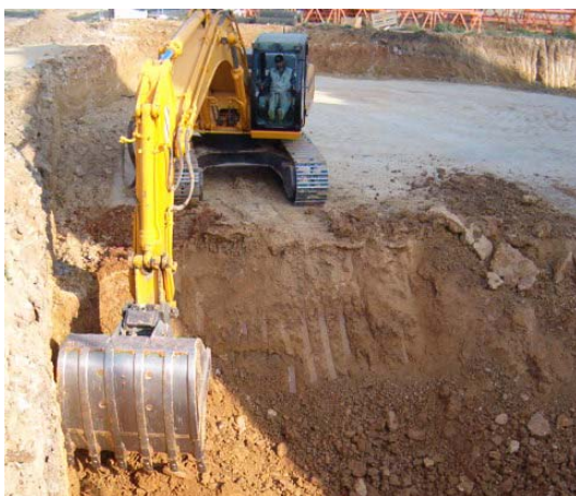
Vaciado de gran profundidad por franjas horizontales. Habilitación de rampas de acceso al tajo.
