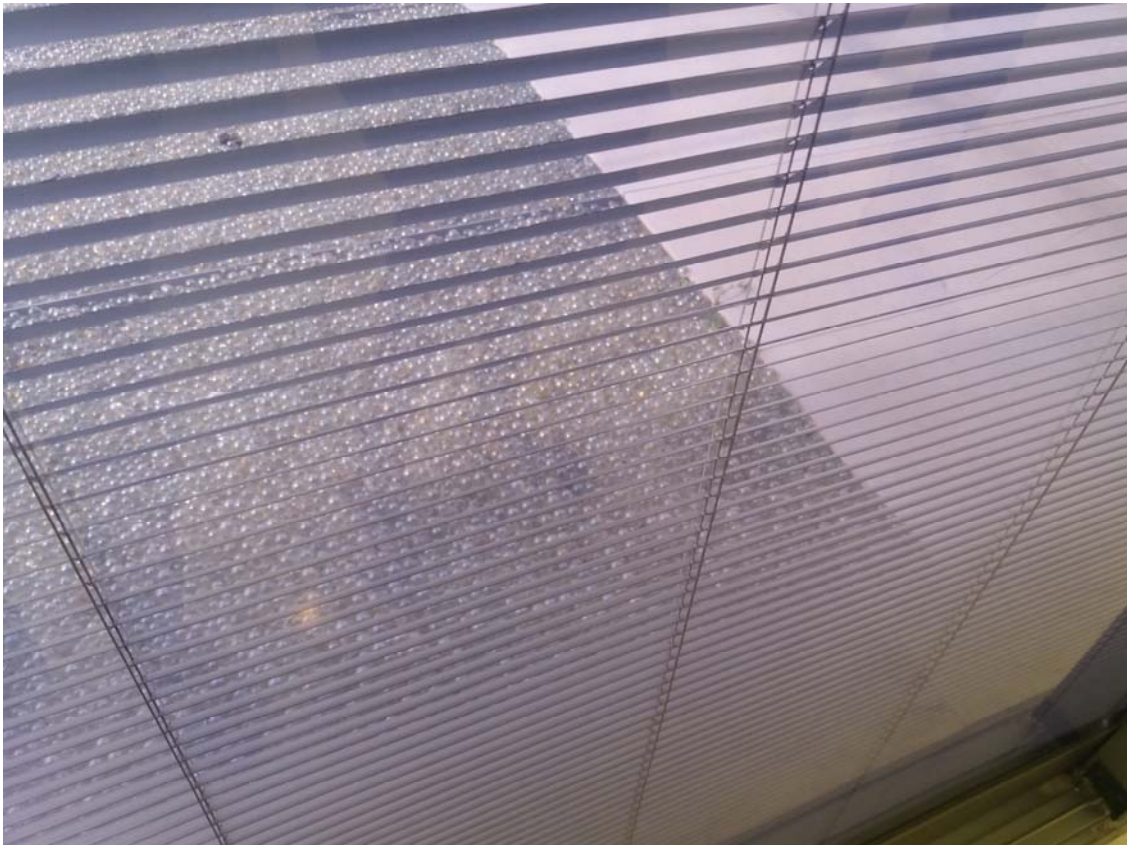
Cubierta plana no transitable con acabado de esferas de vidrio, MACA, Alicante.
