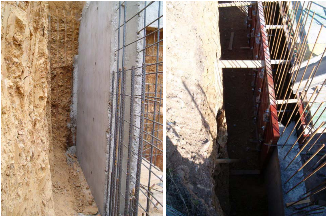
Disposición y atado de las armaduras del alzado del muro, encofrado y hormigonado.
