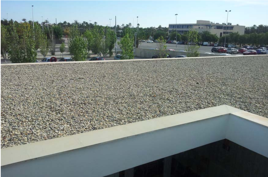
Acabado de cubierta plana no transitable con grava. Escuela Oficial de Idiomas de Elche.
