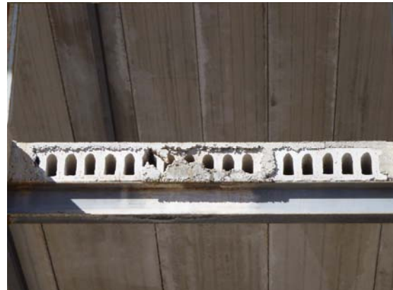
Forjado unidireccional de losas alveolares con apoyo en estructura metálica.
