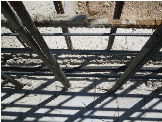
Disposición de cordón de bentonita de sodio en el encuentro del muro con la zapata.
