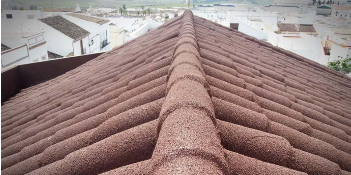
Aislamiento cubierta inclinada con corcho proyectado. Fuente: < www.decoprojecandalucia.com > [Consulta: 20 de mayo de 2018].
