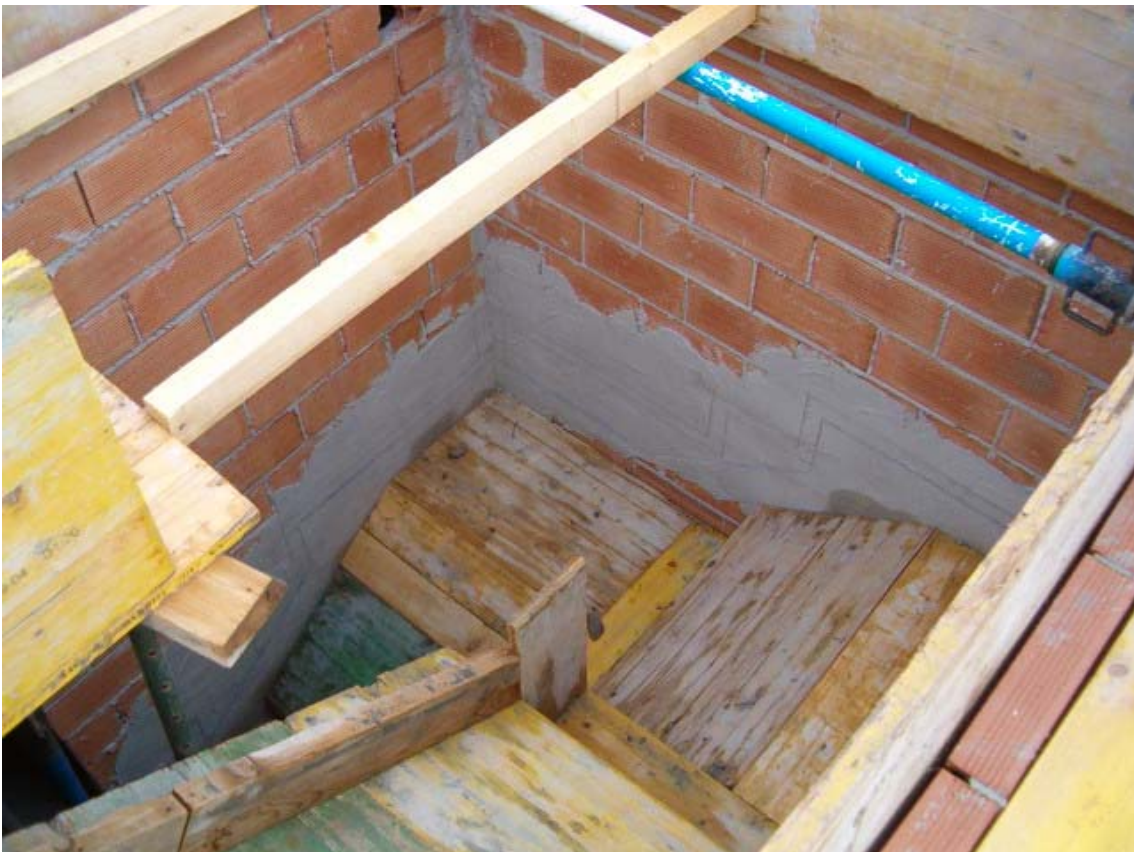
Encofrado de la escalera, disposición de costeros y puntales.
