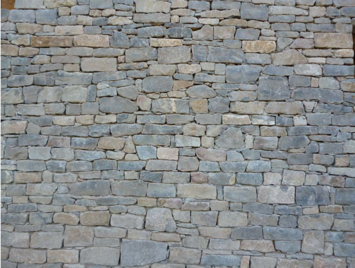
Muro de mampostería a hueso, con los mampuestos más o menos labrados.
