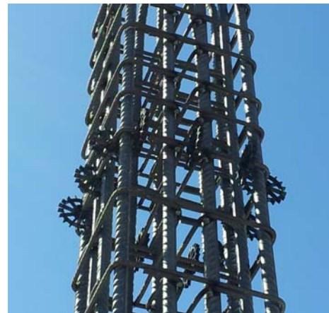
Separadores de disco en las armaduras verticales de los pilares.
