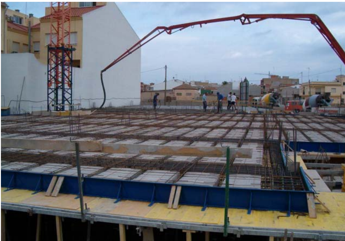
Hormigonado del forjado con hormigón bombeado.
