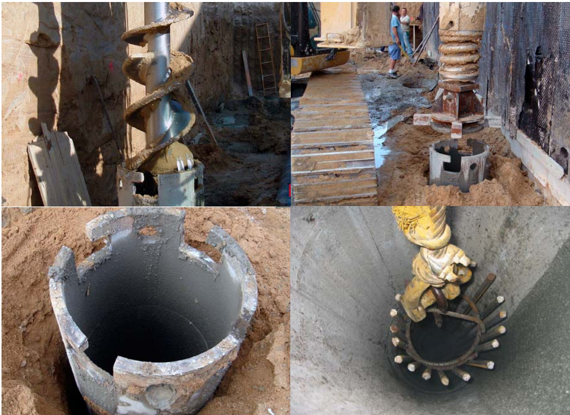
Proceso de extracción e introducción de la camisa y las armaduras. Fuente: < www.micros.es > [Consulta: 1 de marzo de 2015].
