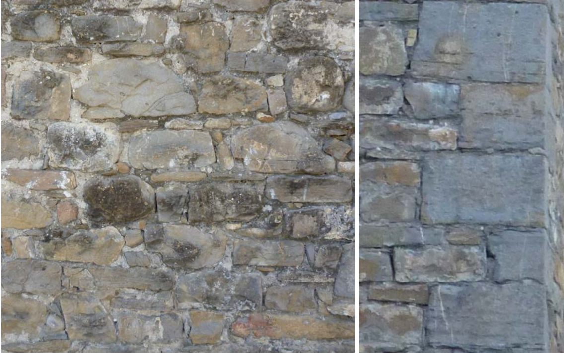
Mampostería enripiada por hiladas. Disposición de grandes sillares en los encuentros en esquina.
