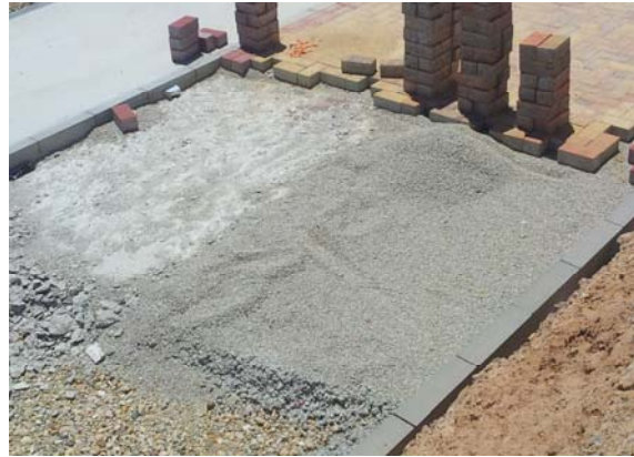
(Izda.) Solera en sótano interior con acabado visto. (Dcha.) Solera base de un pavimento exterior.
