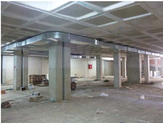
Forjado reticular ejecutado con casetones recuperables.
