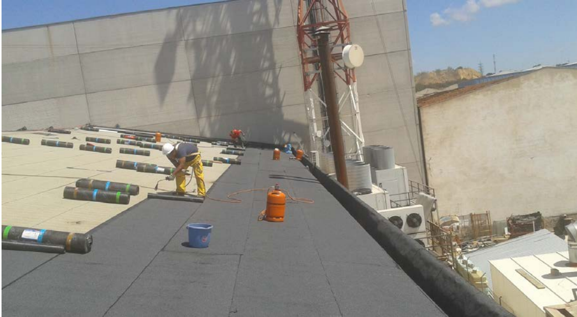
Impermeabilización de cubierta inclinada con lámina autoprotegida. Fuente: < http://impertec.es > [Consulta: 20 de mayo de 2018].
