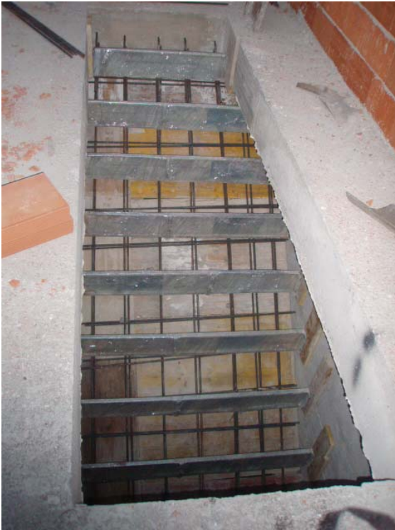
Disposición de las armaduras del tablero y los peldaños de la escalera de hormigón armado.
