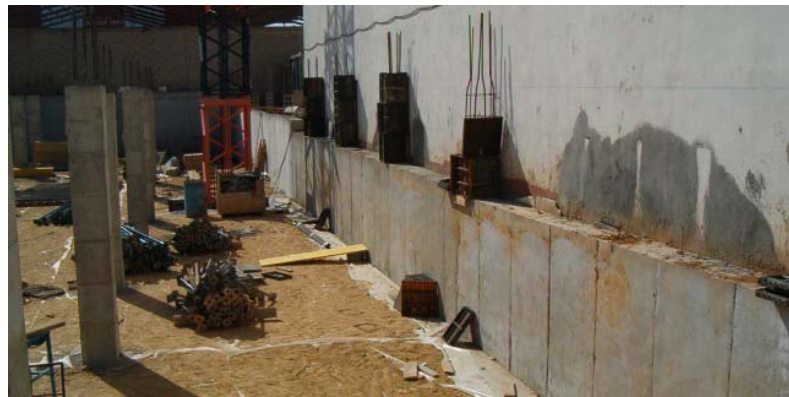
Encofrados metálicos modulares para pilares.
