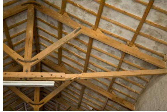
Cubierta inclinada sobre correas apoyadas sobre cerchas.
