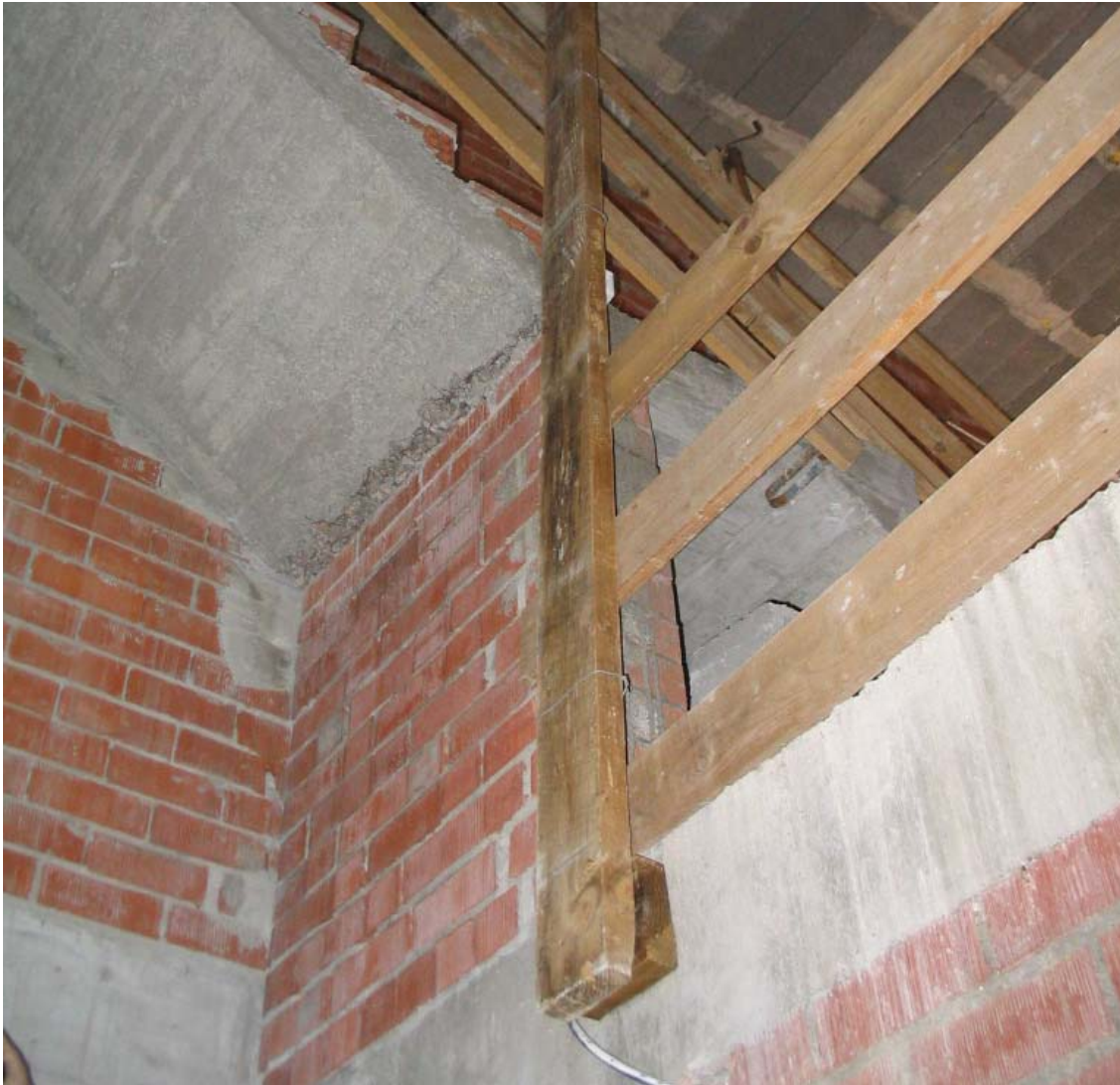
Escalera de hormigón armado con descansillo colgado del forjado superior.
