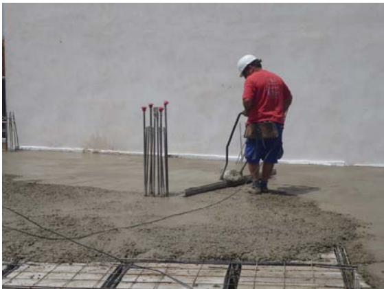
Forjado reticular ejecutado con casetones perdidos.
