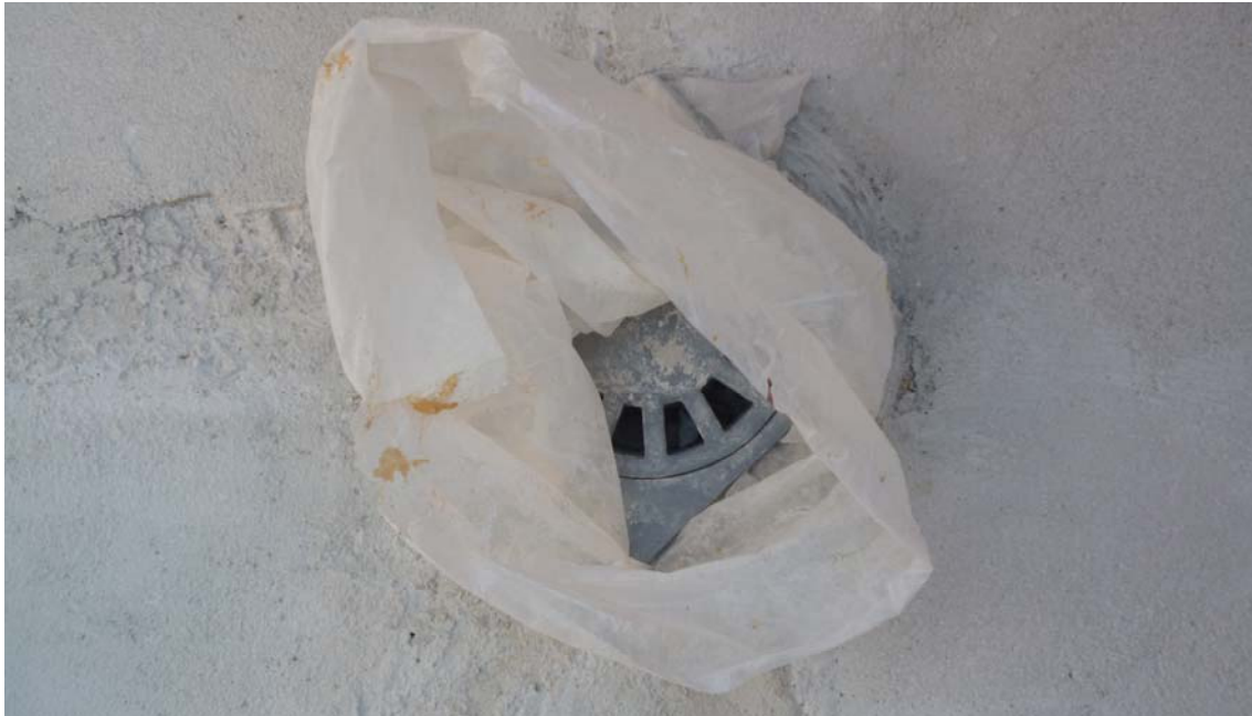
Rejilla practicable de protección de sumidero en cubierta plana transitable.
