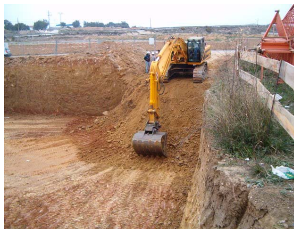
Vaciado de gran profundidad por franjas horizontales. Habilitación de rampas de acceso al tajo.
