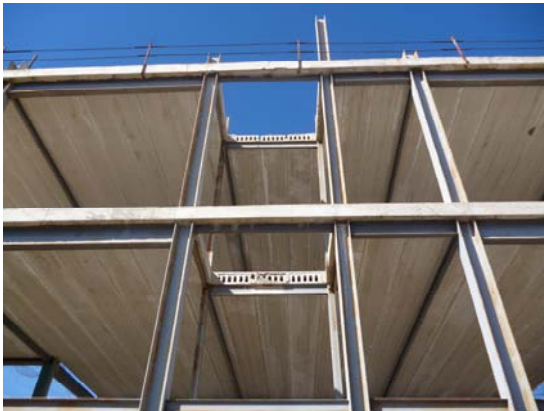
Forjado unidireccional de losas alveolares con apoyo en estructura metálica.
