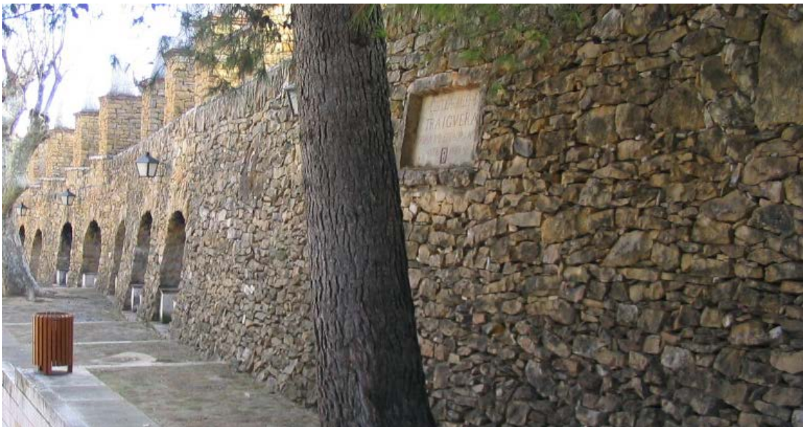
Muro de contención de mampostería en seco. Perfil ataluzado.
