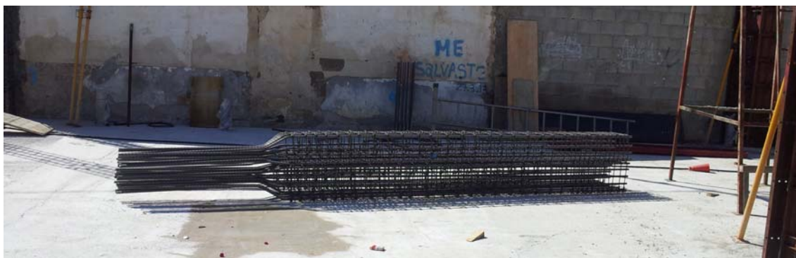
Jaulas de armaduras montadas en fábrica.
