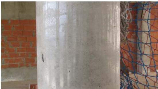
Encofrados TBT para pilares circulares de hormigón visto. Protegen el pilar tras su ejecución de golpes y proporciona un acabado liso y satinado.
