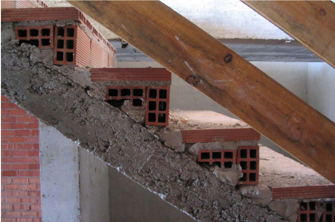
Peldaños de escalera de hormigón armado ejecutados al modo tradicional, in situ, con ladrillo hueco cerámico.
