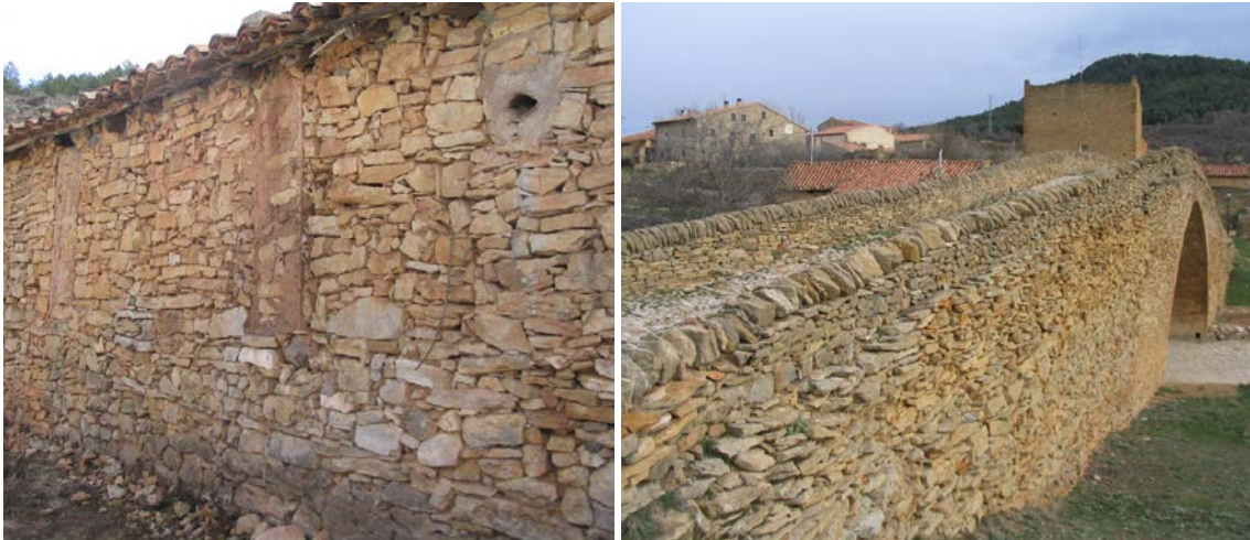
Muro de mampostería en seco en cerramiento de fachada y en un puente medieval.
