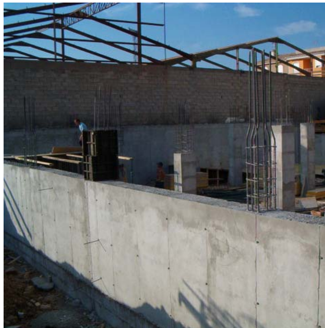
Armaduras en espera del pilar sobresaliendo de la coronación del muro de sótano: disposición enrasada.
