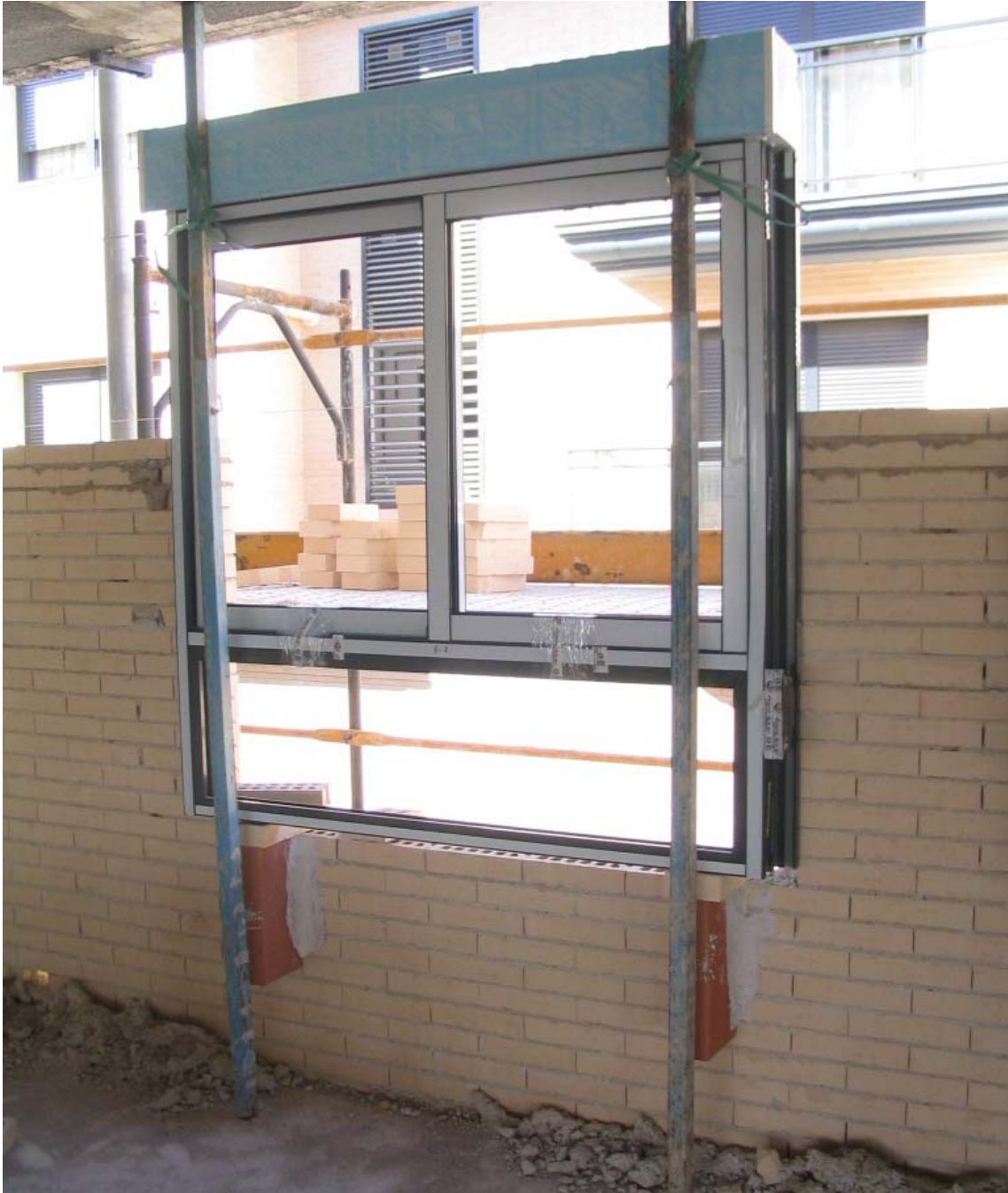
Colocación de la carpintería en una fachada caravista.
