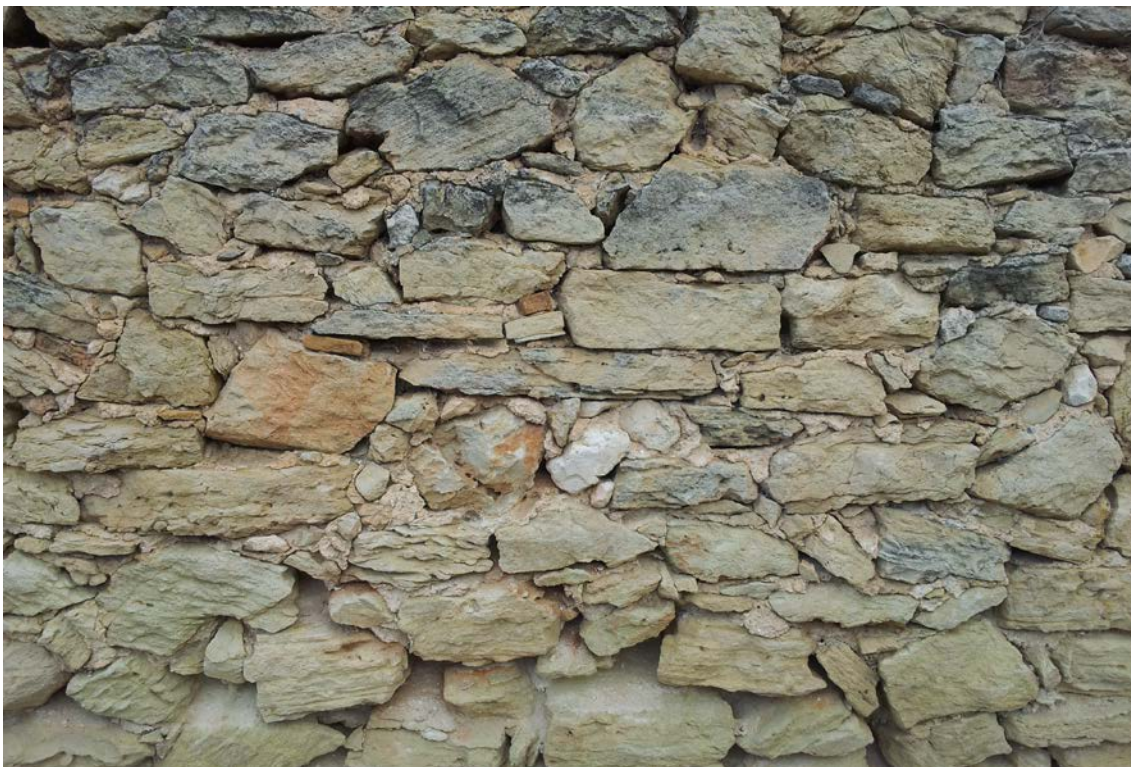
Muro de mampostería tomada con mortero, con ripios relleno de las juntas.
