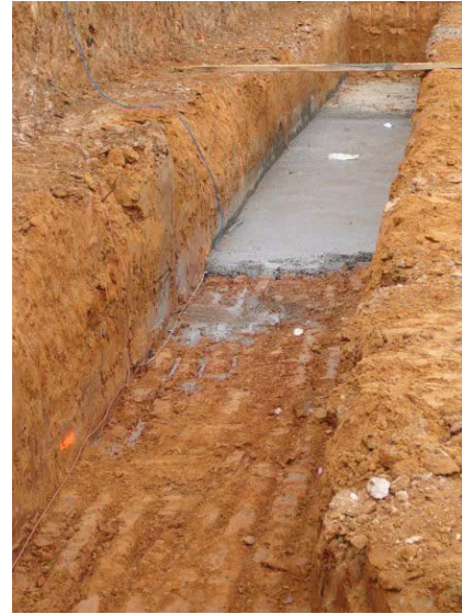
Excavación de las zanjas de zapatas y vigas. Vertido del hormigón de limpieza en el fondo de la excavación, proporcionando la base adecuada para los cimientos.
