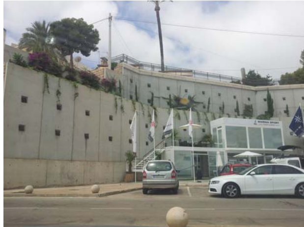
Muros de contención por bataches.
