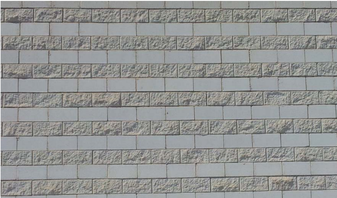
Fábrica de bloque de hormigón vibrado con distintos acabados de las hiladas.
