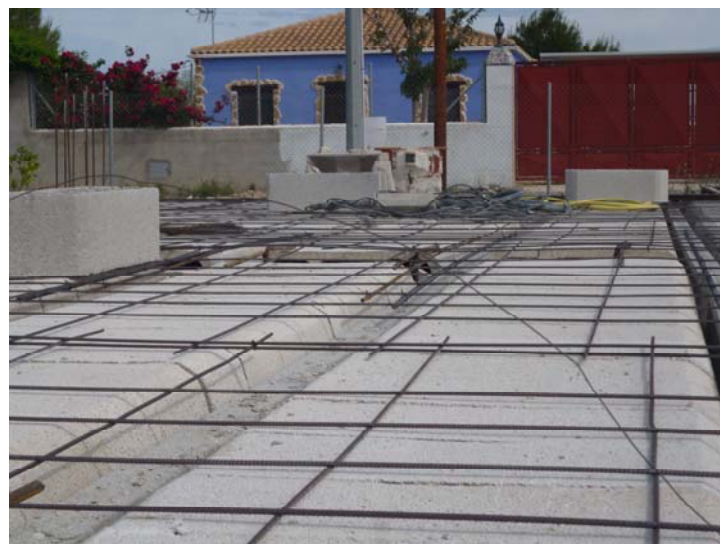
Disposición de los nervios, armaduras longitudinales de negativos y armadura de reparto.
