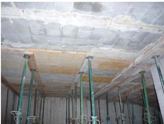
Desencofrado mediante la retirada progresiva de cimbras y puntales.
