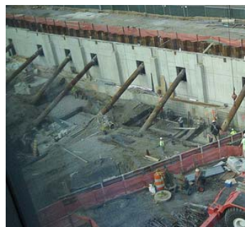
Apuntalamiento contra el fondo de la excavación. Dibujos basados en el CTE DB SE-C-75. Fuente: <www.hotfrog.es> [Consulta: 4 de febrero de 2014].
