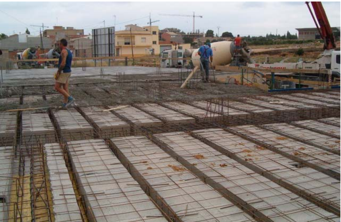
Vibrado del hormigón con vibrador interno.
