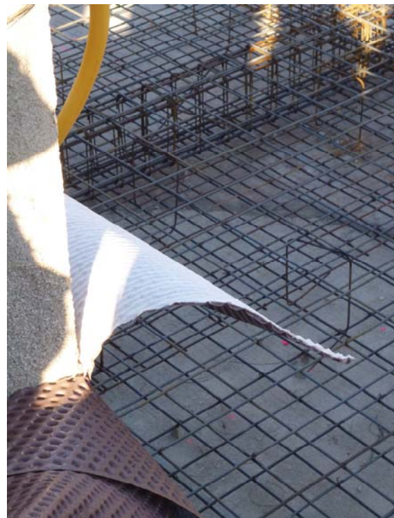
Drenaje de muro con lámina nodular. < www.generadordeprecios.info > [Consulta: 18 de febrero de 2012]. Remate superior con perfil metálico < www.archiexpo.es > [Consulta: 18 de febrero de 2014].
