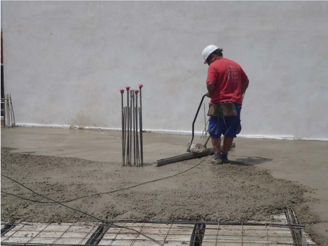
Vibrado del hormigón con vibrador de superficie.
