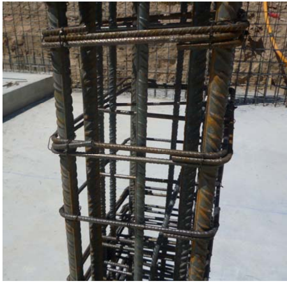
Izda.: unión estribo-armadura con puntos de soldadura en taller. Drcha.: unión estribo-armadura con alambre.
