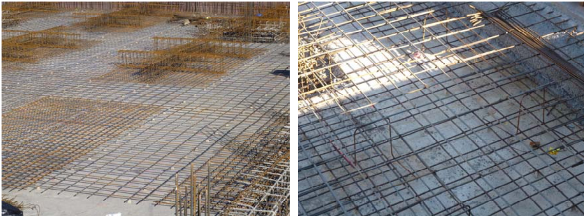
Armado de losa de cimentación. Armadura en cara inferior y superior con doble malla y crucetas de refuerzo en los puntos de apoyo de los pilares.
