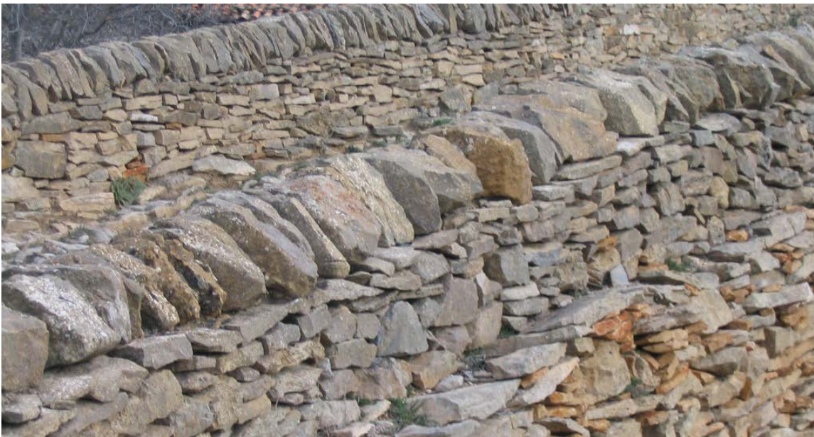
Mampostería de rajuela.
