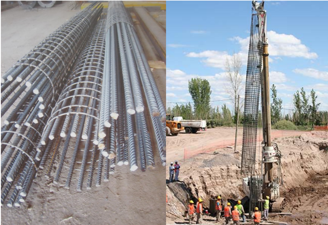
Armaduras de los pilotes. Fuente: < www.kiev.all.biz > y < www.mypfundaciones.com > [Consulta: 1 de marzo de 2015].
