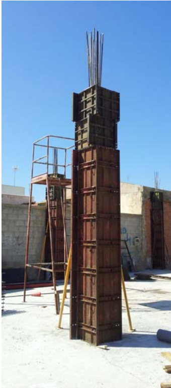
Encofrados metálicos modulares para pilares.
