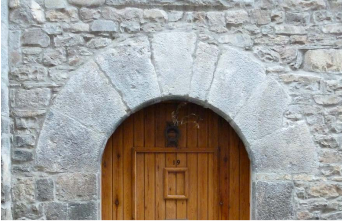
Arco de medio punto de dovelas de piedra.
