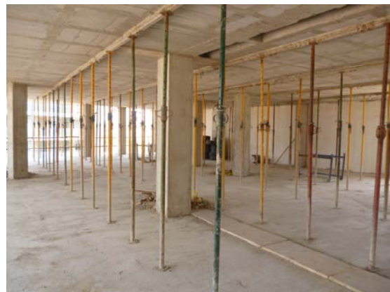
Desencofrado mediante la retirada progresiva de cimbras y puntales.
