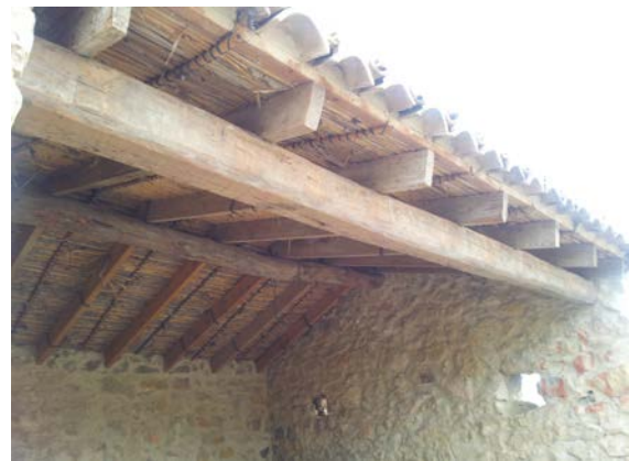
Cubierta inclinada sobre pares de madera.
