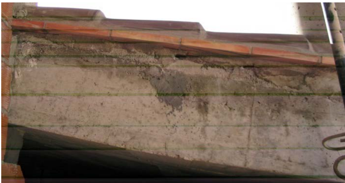
Cubierta inclinada sobre forjado inclinado.
