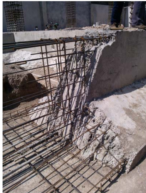
Concepto de rigidez estructural de las zapatas aisladas. Esquemas basados en el CTE DB SE-C Cimientos, pg. SE-C-20. Imagen de una zapata rígida corrida.
