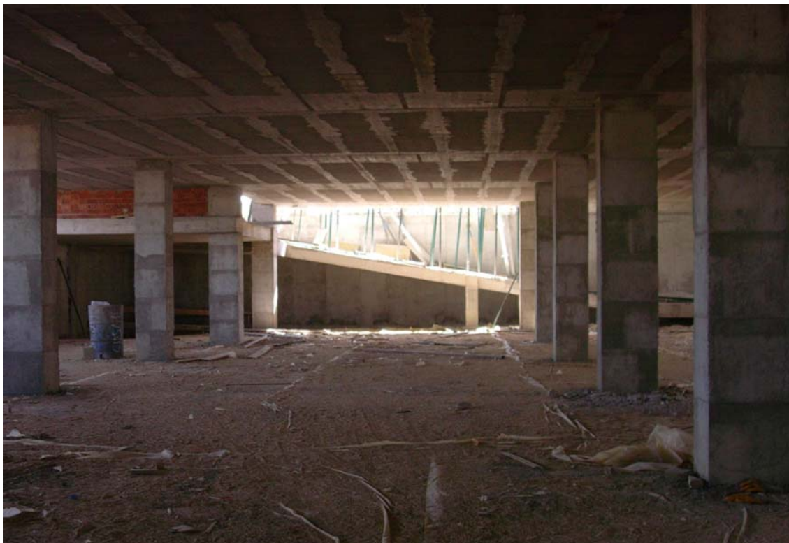
Forjado unidireccional de nervios hormigonados in situ.
