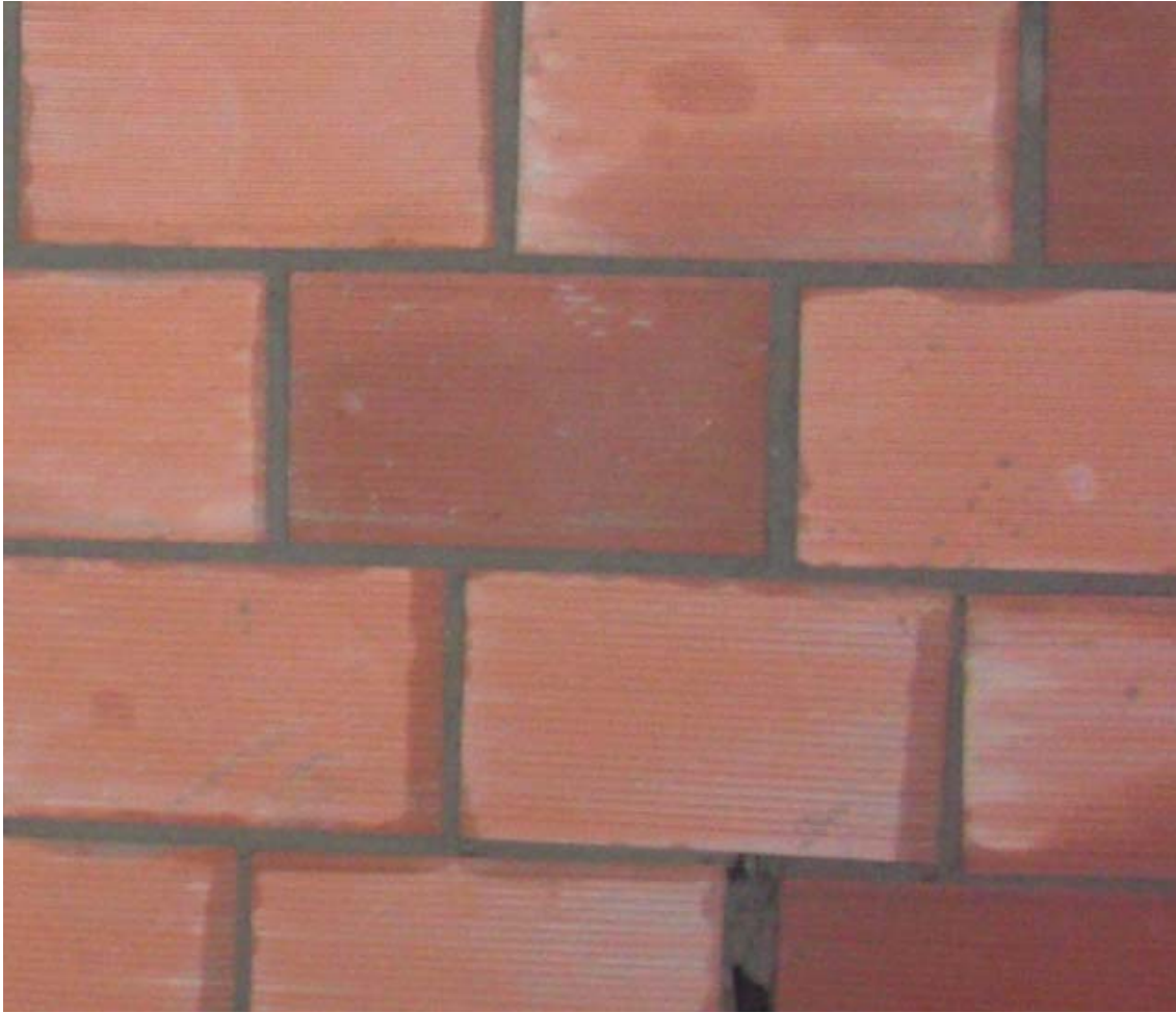
Llagas y tendeles de una fábrica cerámica a revestir.
