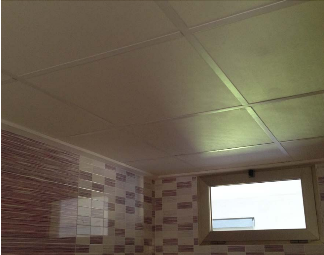
Placas hidrófugas para cuartos húmedos.
