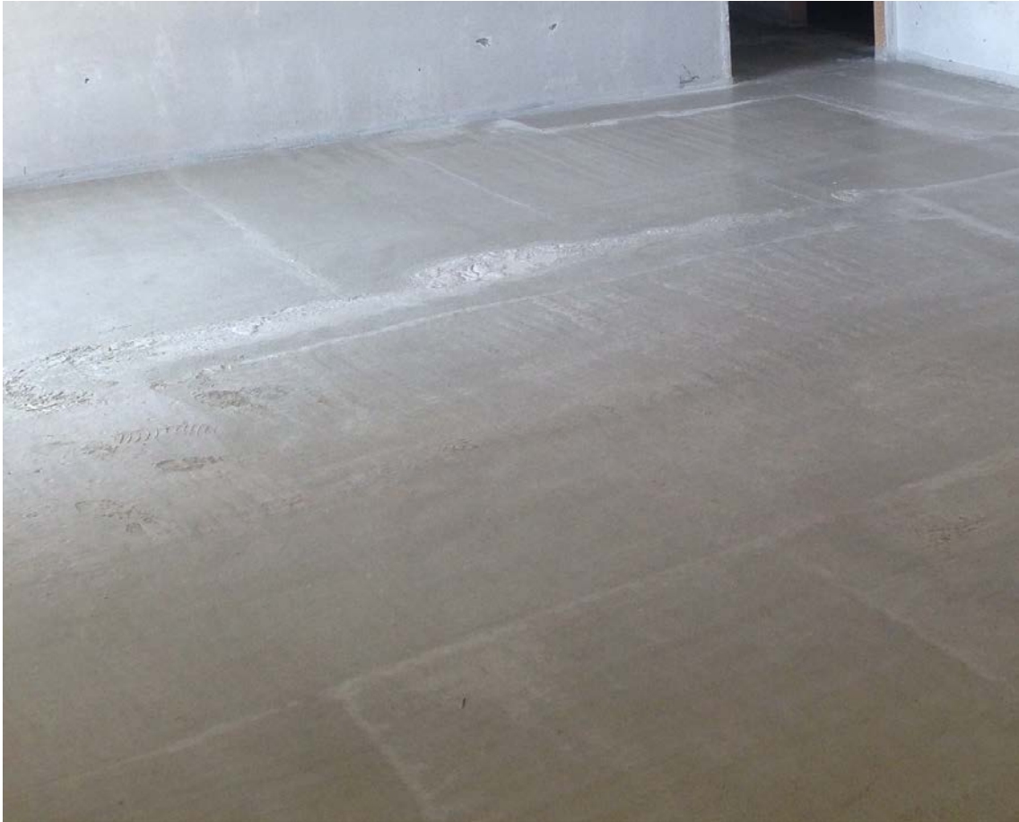
Acabado superficial de solera de hormigón maestreada.
