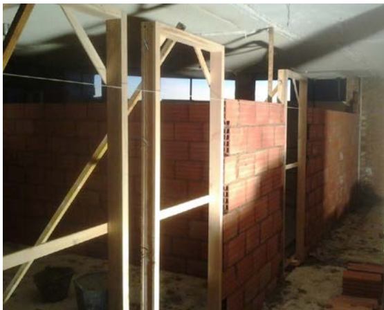
Premarcos aplomados y sujetos mediante puntales.
