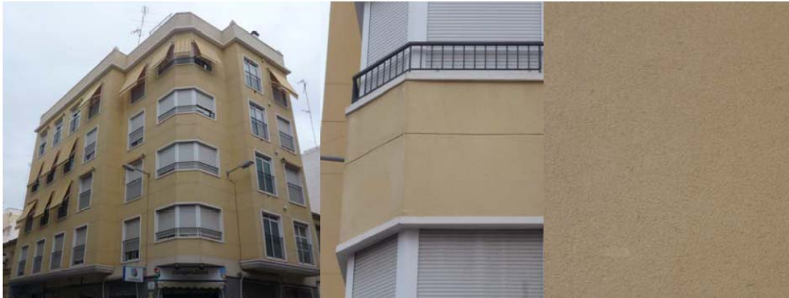
Ejemplo del mococapa coloreado en amarillo y con acabado raspado de una fachada.
