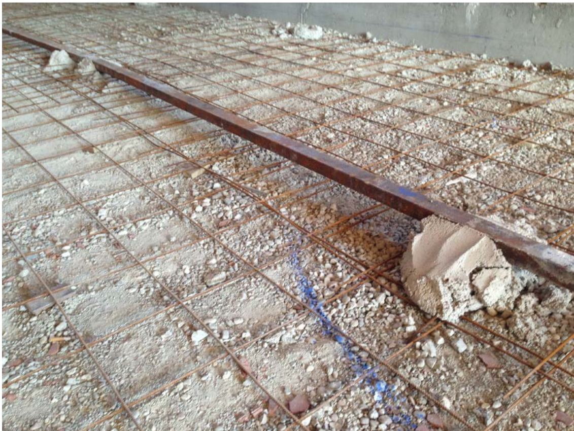
Armadura embebida en el grueso de la solera.
