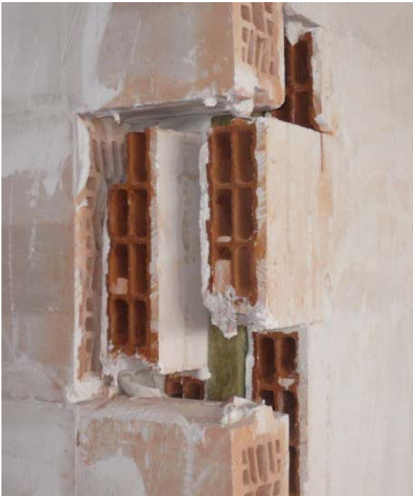
Arriostramiento y trabado de la tabiquería: tabiques en L o en T.
