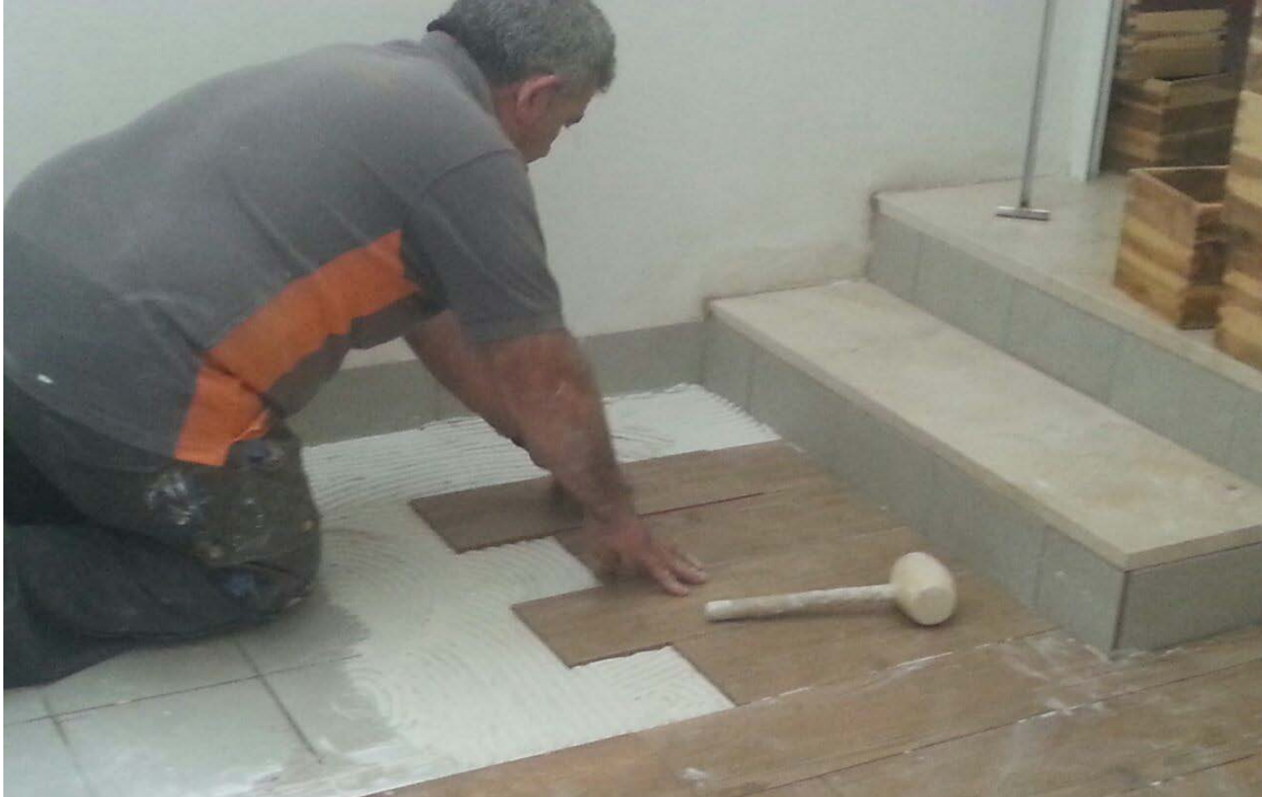
Colocación de las plaquetas cerámicas.
