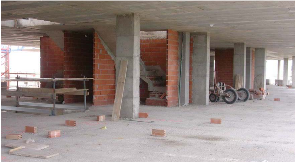
Tabicones materializando el cerramiento de la caja de escalera del edificio.
