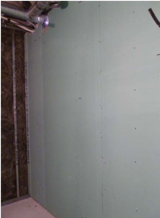
Cierre del sistema con el atornillado de los tableros de la segunda cara.
