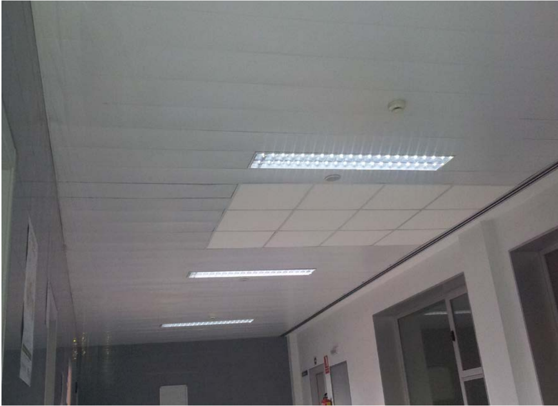
Falsos techos desmontable metálico.
