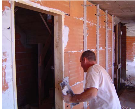
Clavos de agarre y relleno de los huecos para embeberlos al tabique con pasta.
