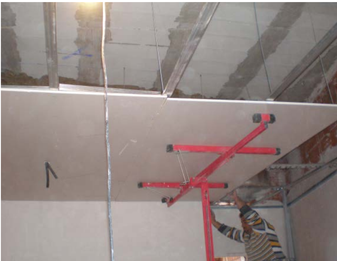
Atornillado de los tableros en un techo simple.
