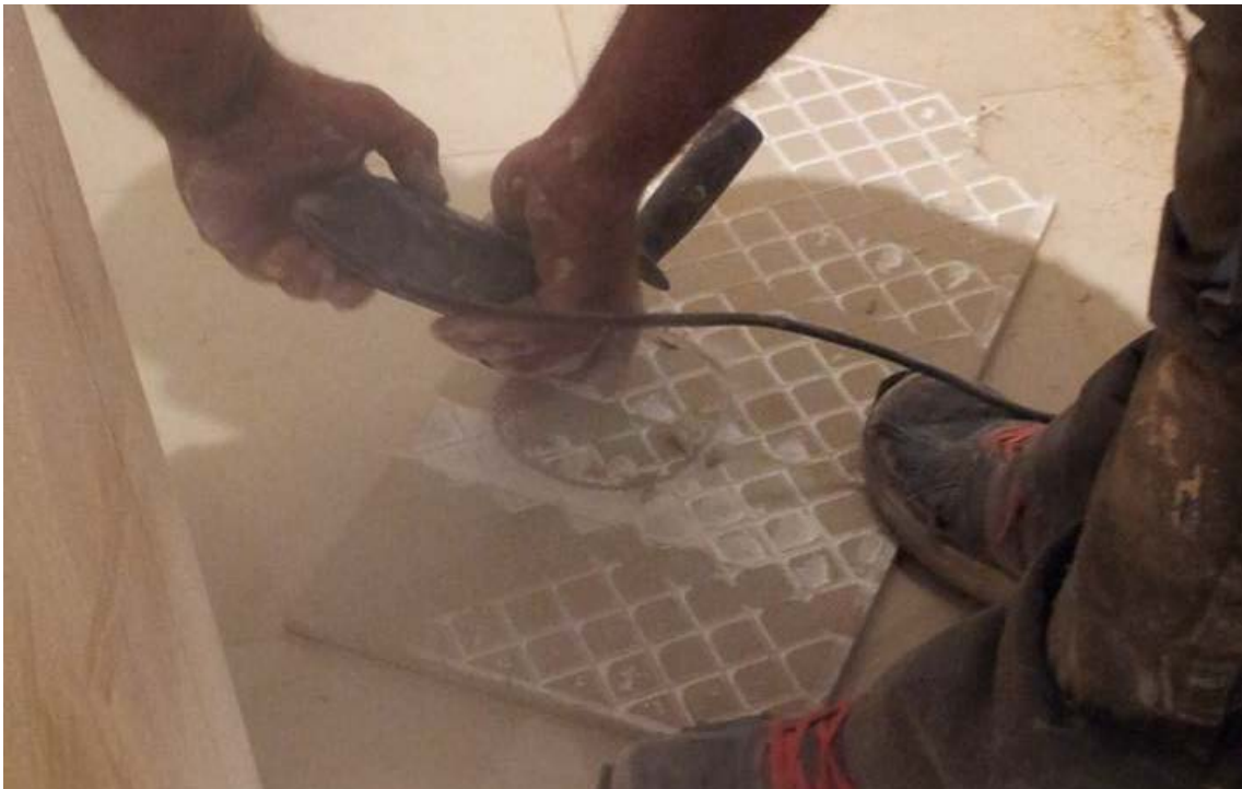
Ajuste de piezas con radial y abertura de hueco para paso de instalaciones.
