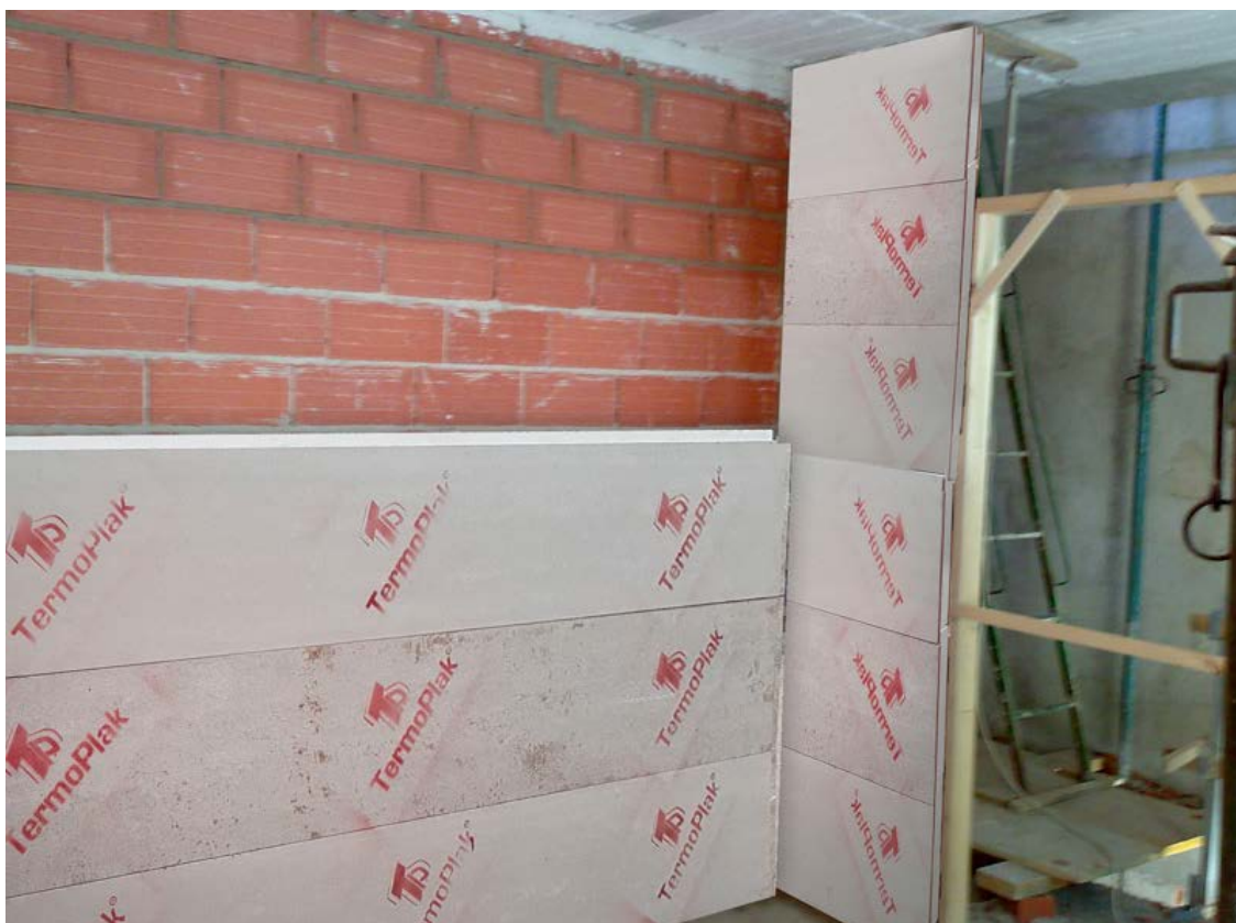
Proceso constructivo de un tabique y un trasdosado. Fuente: < www.craluminios.com > [Consulta: 24 de enero de 2019].
