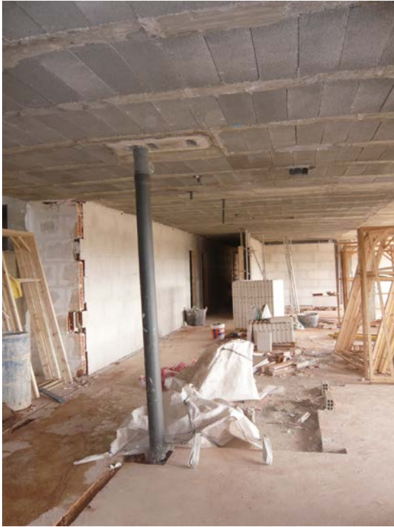
Premarcos de madera almacenados en planta previamente a su colocación.
