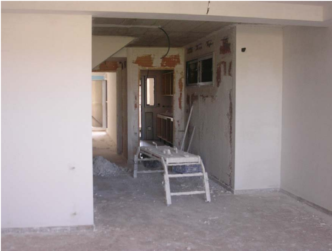
Revestimiento de paredes interiores con tendidos de yeso sobre sáfrica cerámica de gran formato.
