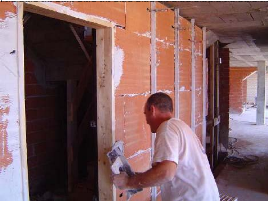
Relleno de huecos que albergan las patillas del premarco en el tabique con pasta.
