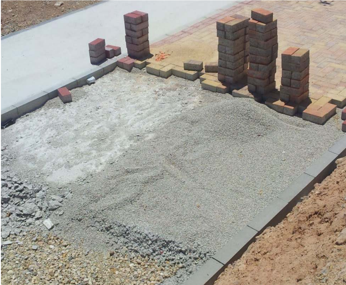
Ejecución de un pavimento adoquinado sobre cama de arena.
