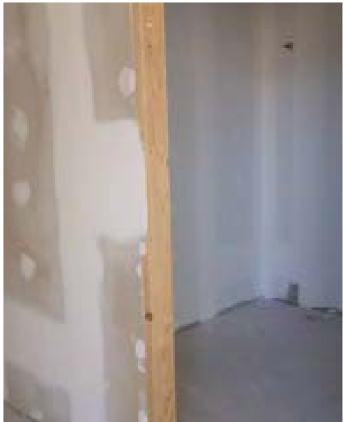
Disposición de placas estándar en la cara seca e impermeables en el perímetro del núcleo húmedo.
