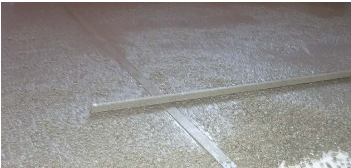
Mortero de regulación maestreado.
