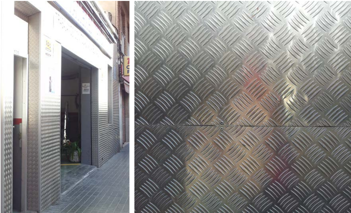
Chapa de acero inoxidable como acabado de fachada exterior.
