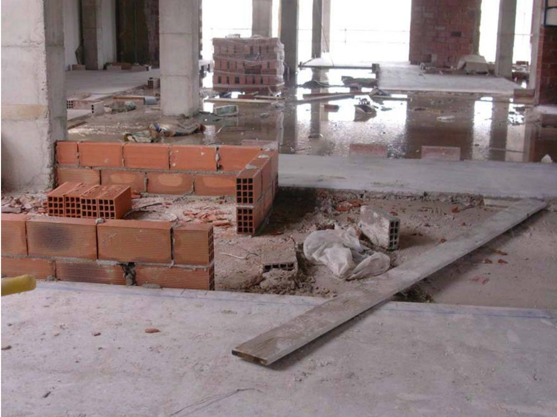
Cítara resolviendo el perímetro de los núcleos húmedos de una vivienda.
