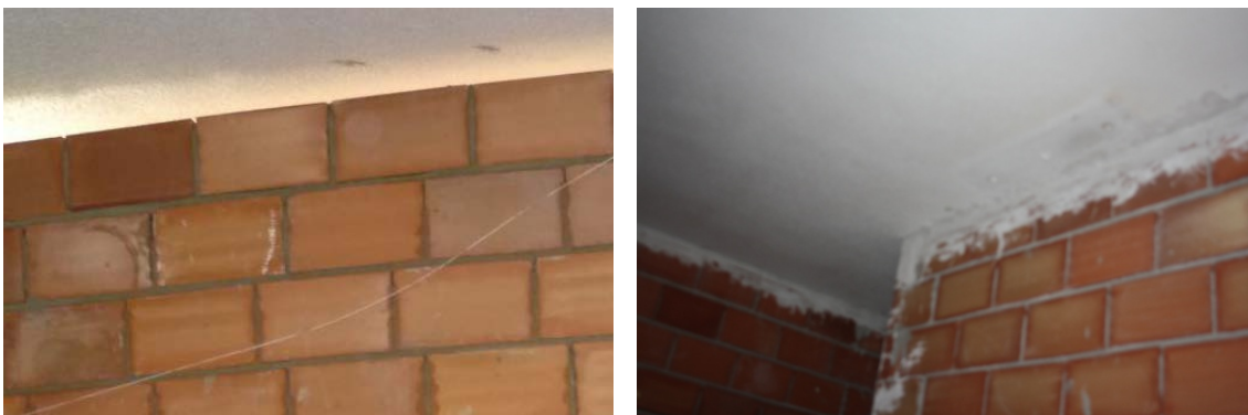
Holgura creada en encuentro superior del tabique con el forjado y posterior relleno con pasta de yeso blanco para formación de junta elástica.
