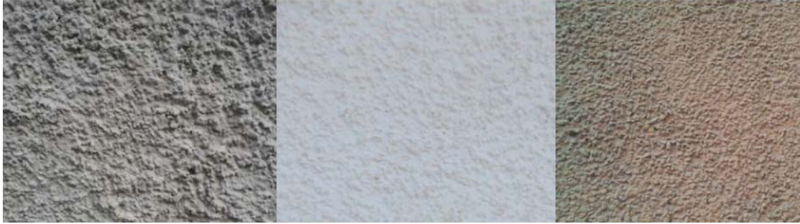
Ejemplos de revoco a la Tirolesa con diferentes tamaños de grava y texturas de acabado.
