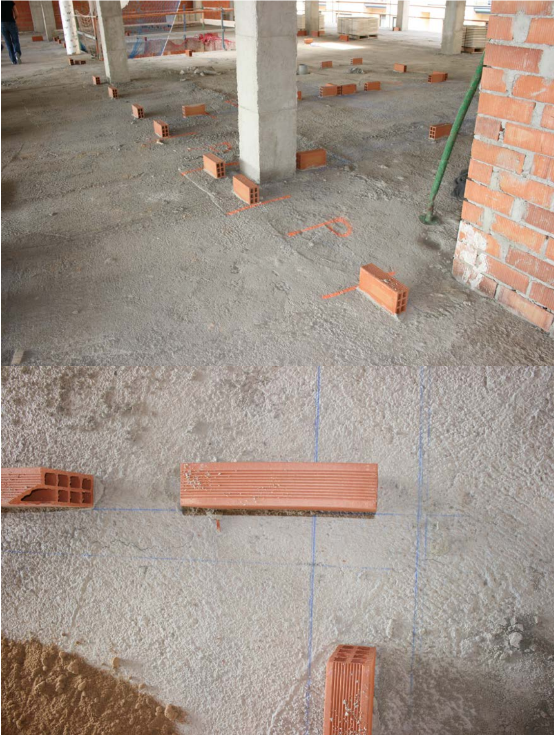
Replanteo de la tabiquería en una planta de viviendas. Disposición de ladrillos guía.
