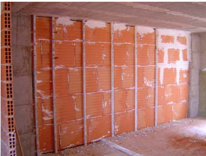
Trasdosado de una medianera entre edificios con tabique a panderete, realizado con piezas cerámicas de gran formato (rasillones).
