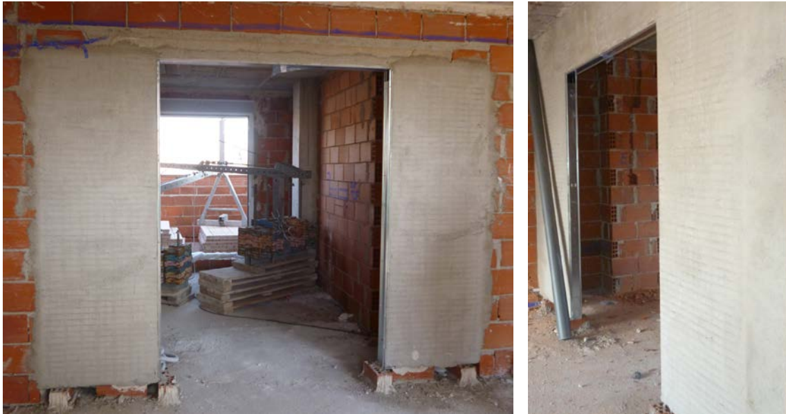
Enfoscado de mortero de cemento enrasado con premarco de puerta corredera.
