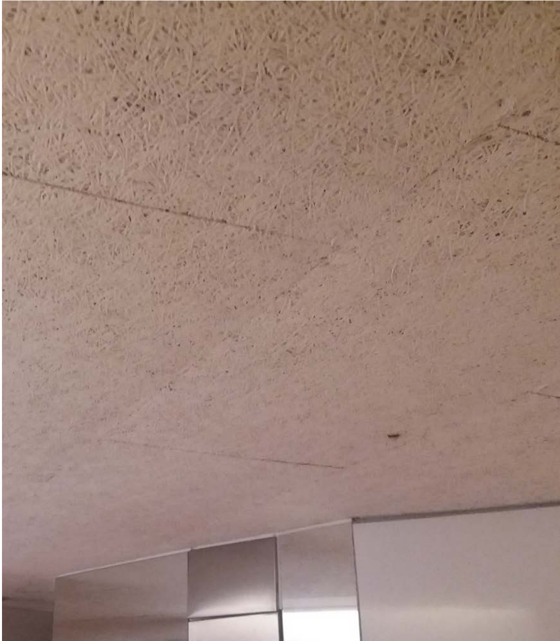
Falsos techos desmontable de fibras minerales.
