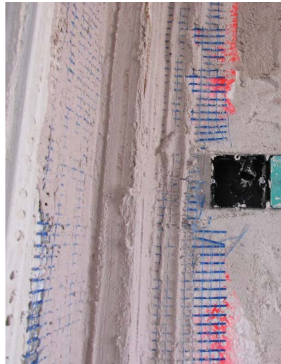
Mallas de fibra de vidrio embebidas en el conglomerado durante su ejecución en las zonas de encuentro entre distintos materiales.
