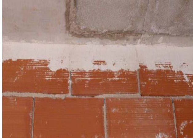
Ejecución de la tabiquería en sentido descendente. Junta elástica tabique-forjado.
