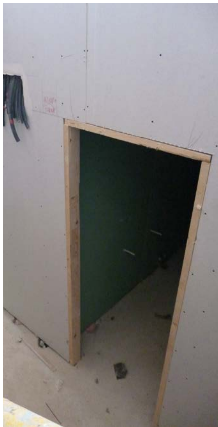
Disposición de placas estándar en la cara seca e impermeables en el perímetro del núcleo húmedo.
