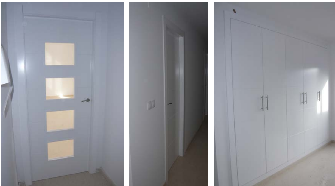
Puertas interiores con acabado lacado en blanco.
