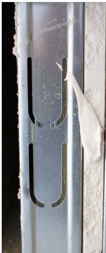
Troqueles y huecos ovalados en el alma de los montantes para el paso de instalaciones.
