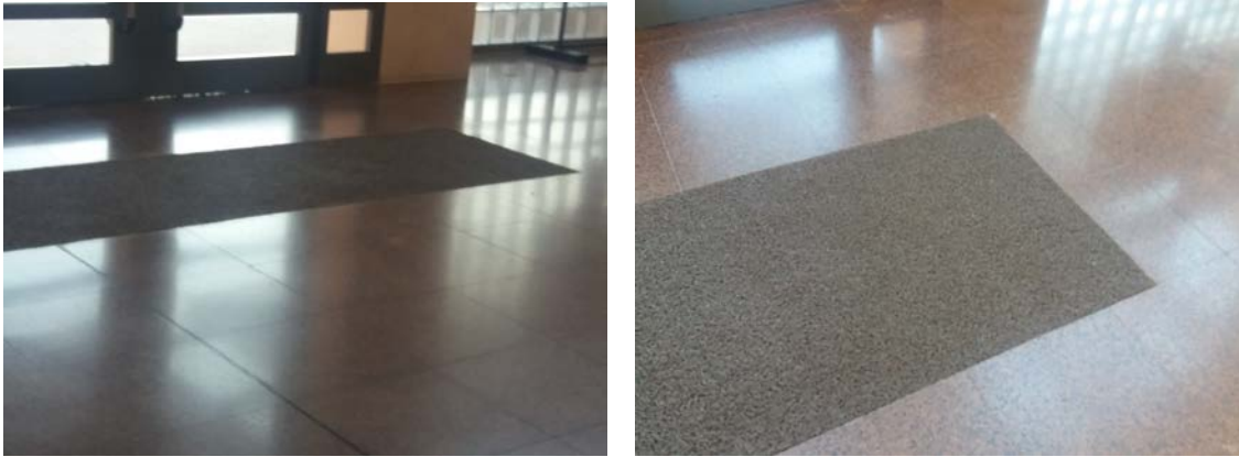
Pavimento de moqueta en acceso a edificio público desde exterior.
