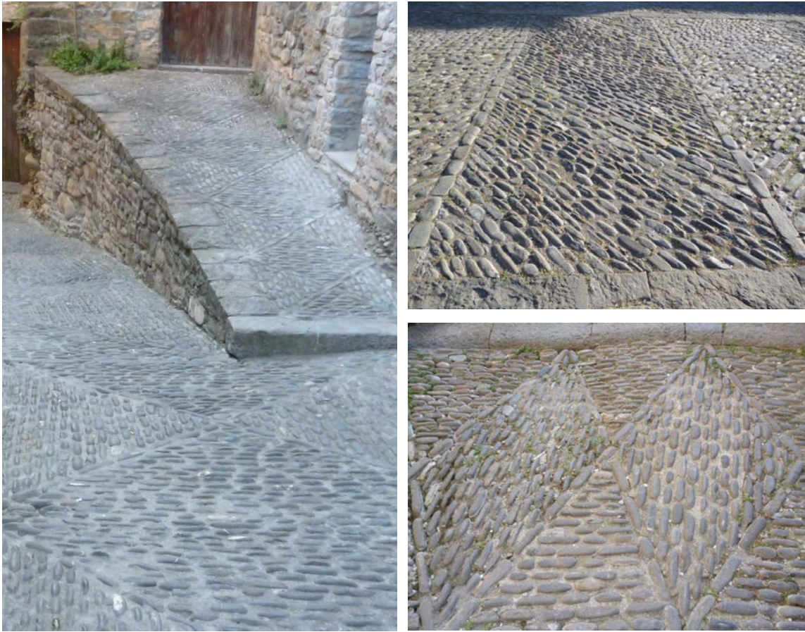
Pavimentos empedrados con distintas geometrías decorativas en las calzadas de Ainsa.
