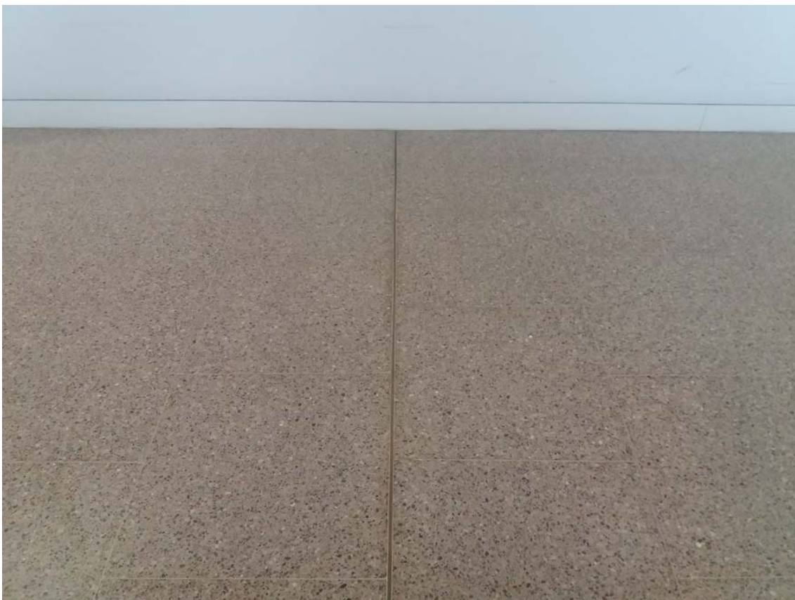
Junta entre pavimento de terrazo rellada con perfil rígido.
