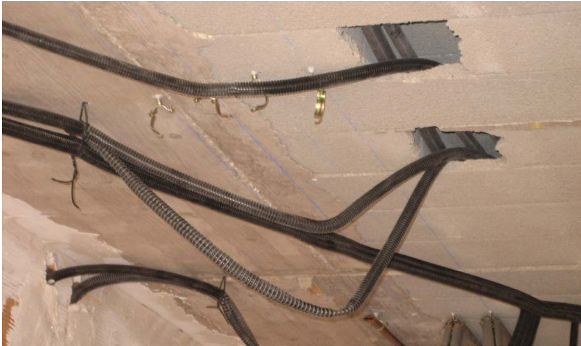
Empotramiento de las instalaciones en el forjado.
