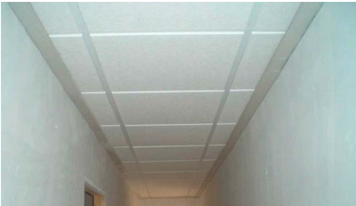
Falso techo registrable de placas de escayola con perfil semioculto.
