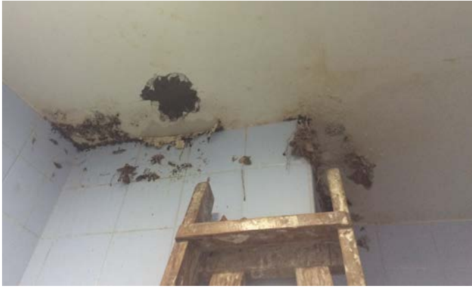
Aparición de hongos en superficies verticales y horizontales por exceso de humedad.
