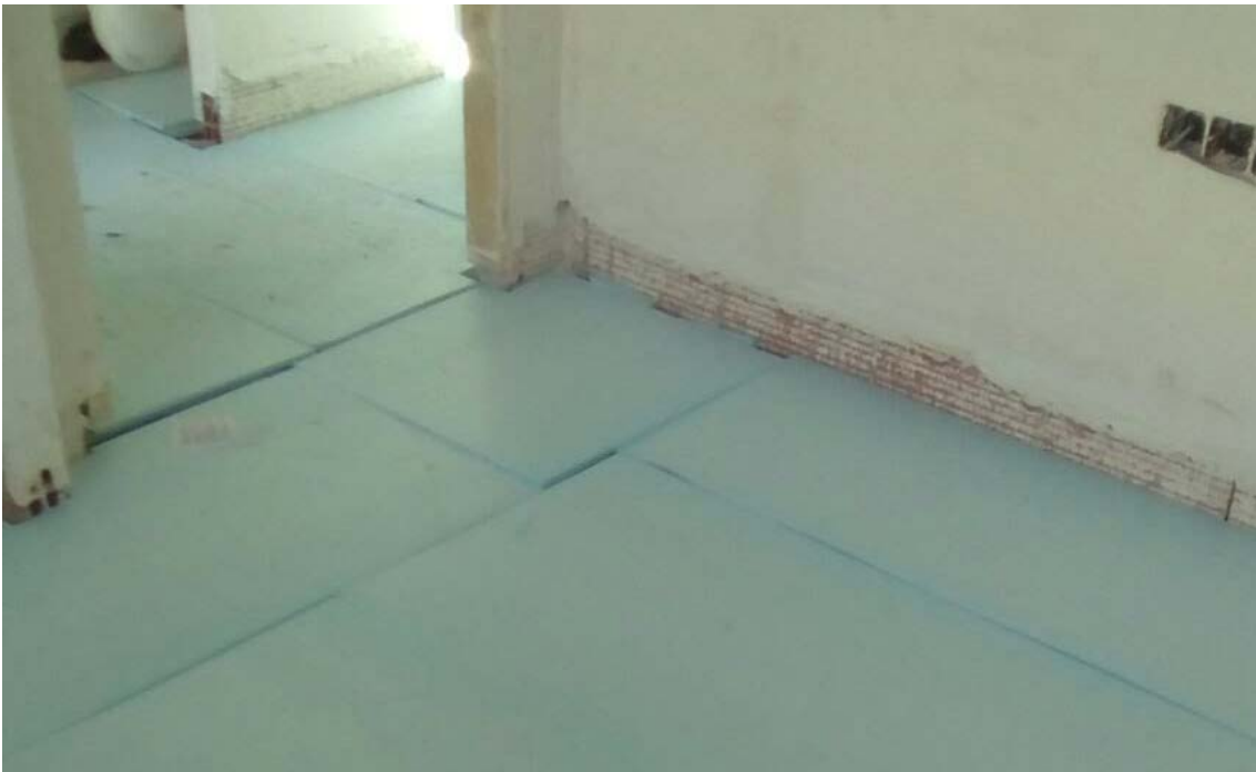
Planchas de poliestireno extruido cubriendo toda la superficie bajo el solado.
