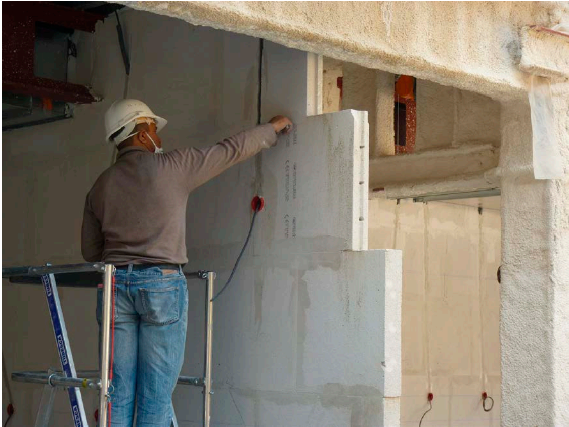
Tabiques de placas de hormigón celular. Imagen comercial. Fuente: < www.archiexpo.es > [Consulta: 24 de enero de 2019].
