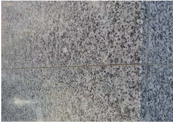
Ejemplos de aplacados con canto a tope visto en uno de los planos.
