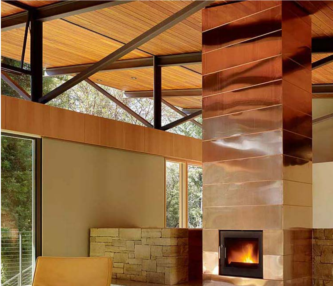
Revestimiento de chimenea con planchas de cobre. Fuente: < www.cubiertadezinc.es > [Consulta: 10 de septiembre de 2019].
