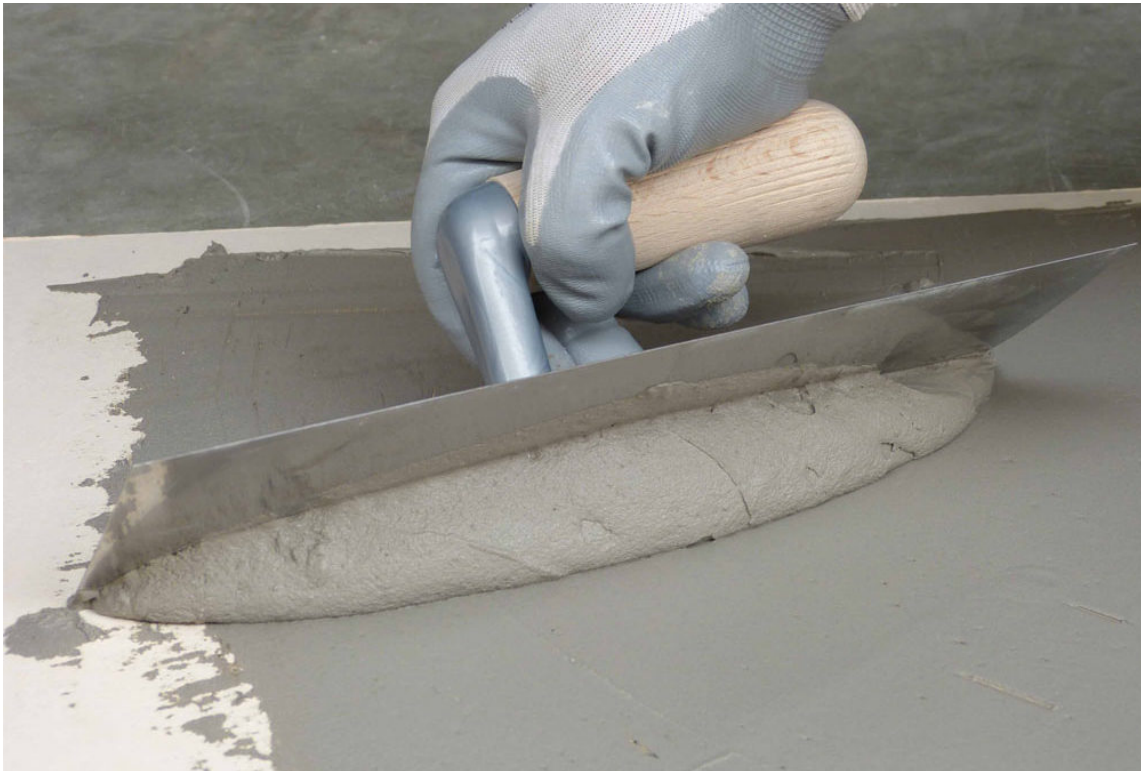
Aplicación del microcemento en un pavimento. Fuente: < https://www.ingremic.com/2015/01/microcemento-aplicacion.html > [Consulta: 2 de marzo de 2019].
