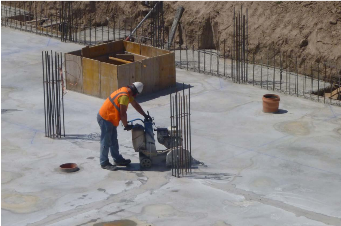
Corte con radial de la solera para disponer las juntas de retracción.
