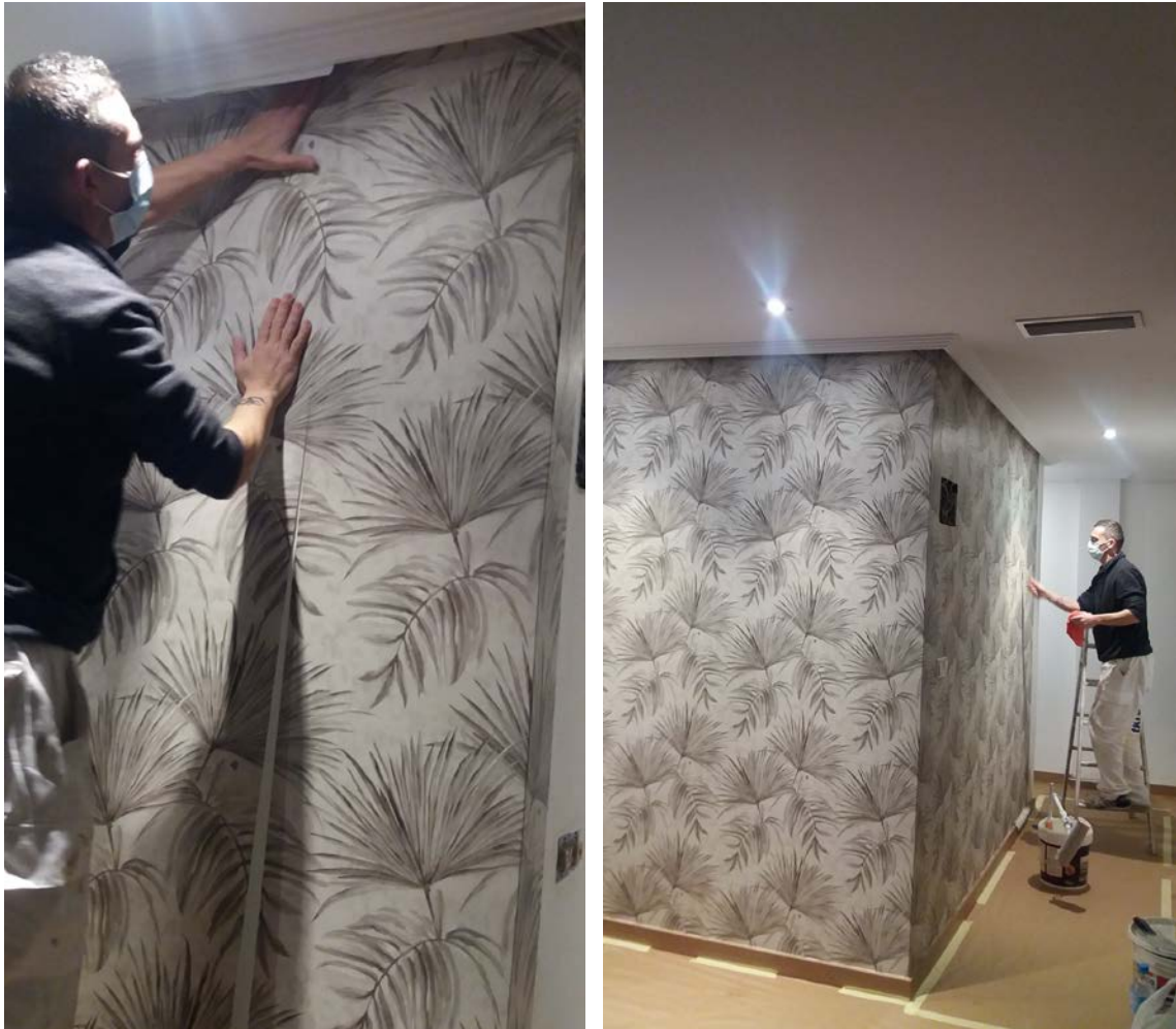
Colocación de rollos consecutivos haciendo coincidir la geometría del dibujo.
