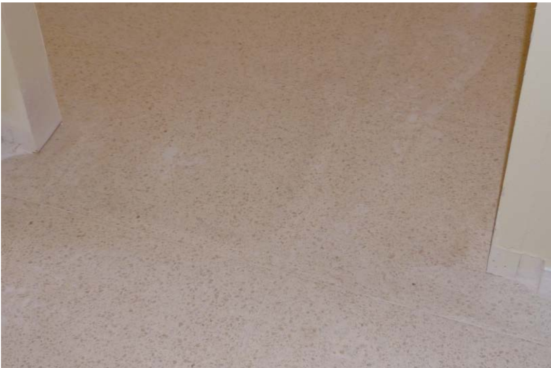
Pavimento de terrazo.
