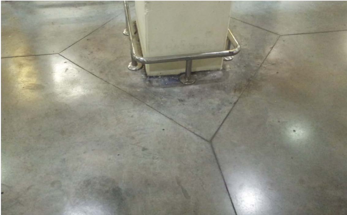
Solera con un acabado de hormigón pulido.
