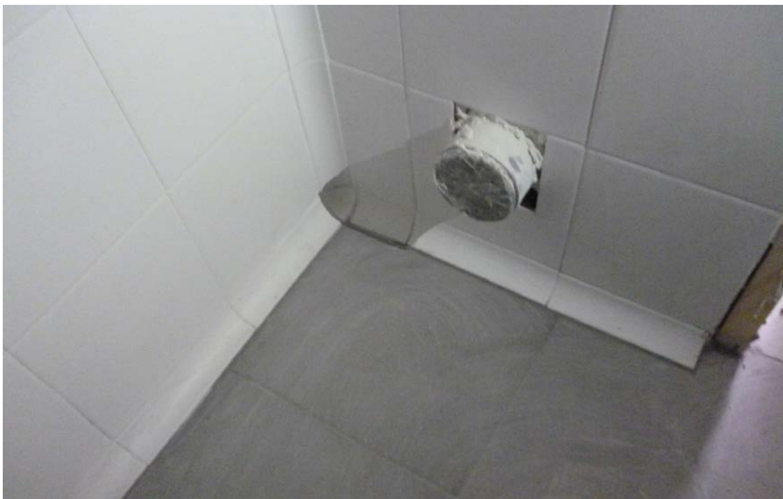
Piezas curvas especiales para resolver el encuentro de alicatados en esquina entrante. Es la mejor solución para eliminar aristas donde se acumula la suciedad.
