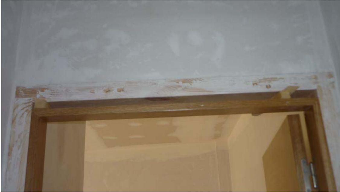
Disposición de cuñas para salvar las diferencias dimensionales.
