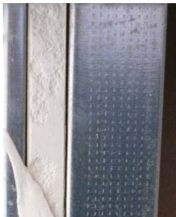
Troqueles y huecos ovalados en el alma de los montantes para el paso de instalaciones.
