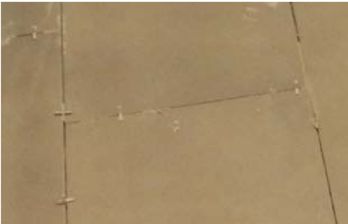
Crucetas para mantener el espesor de junta..
