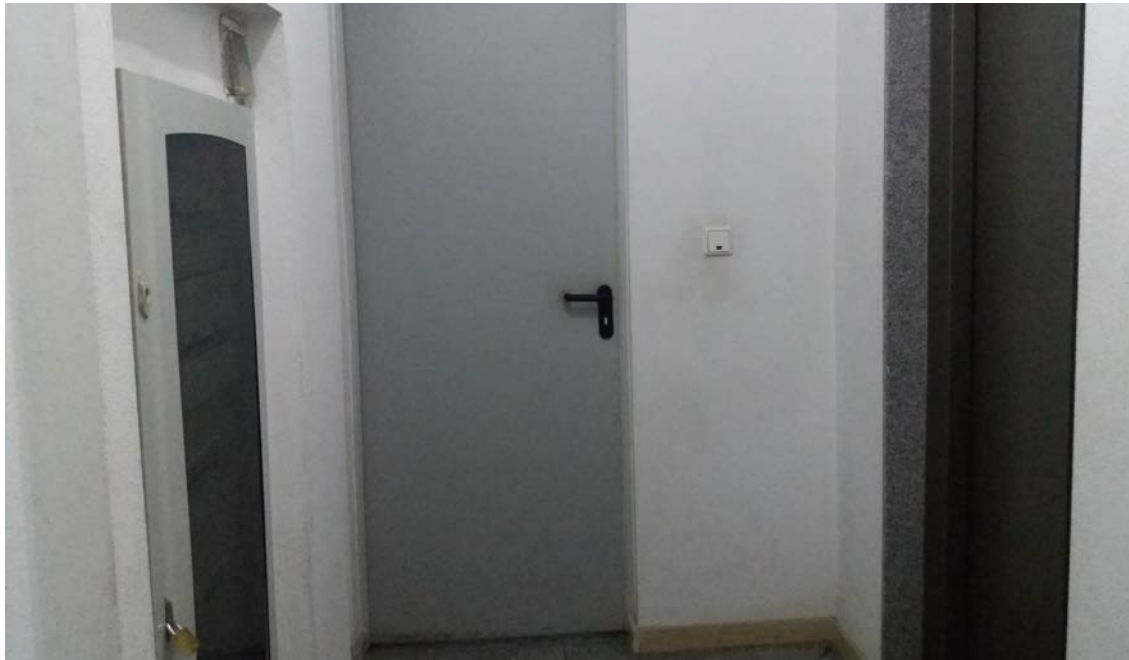
Armario de contadores de luz situado en vestíbulo de independencia
