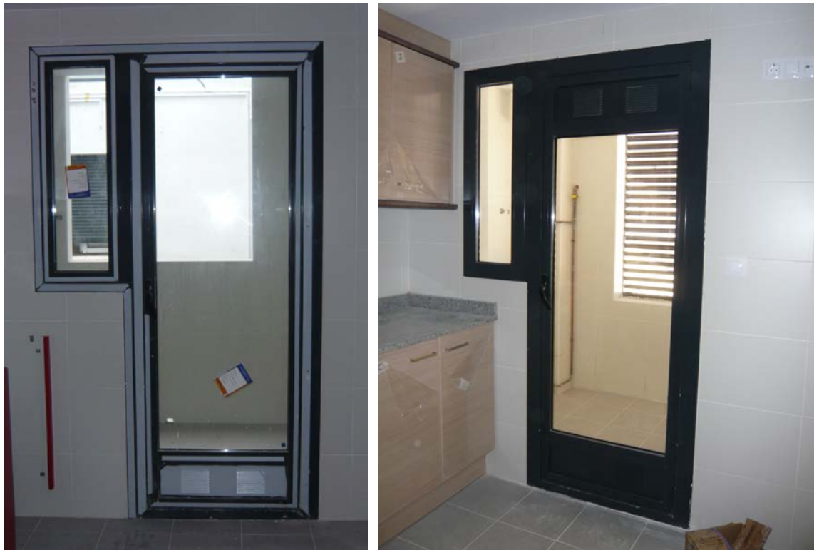
Aberturas integradas en las carpinterías metálicas.
