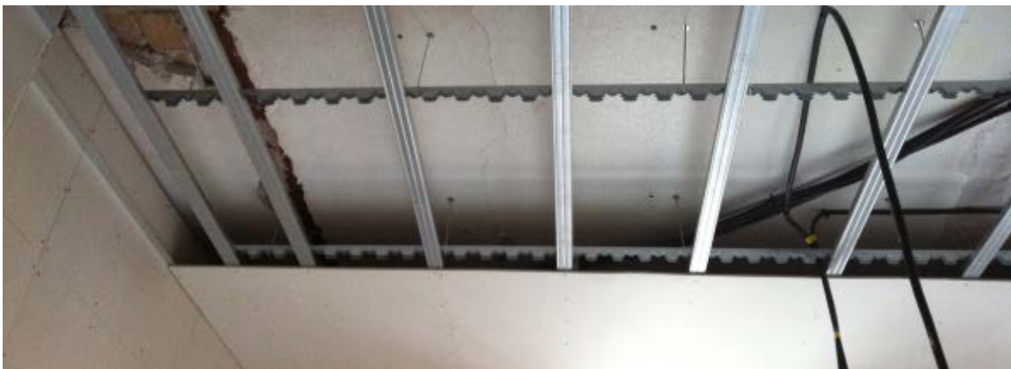
Atornillado de los tableros en un techo compuesto.
