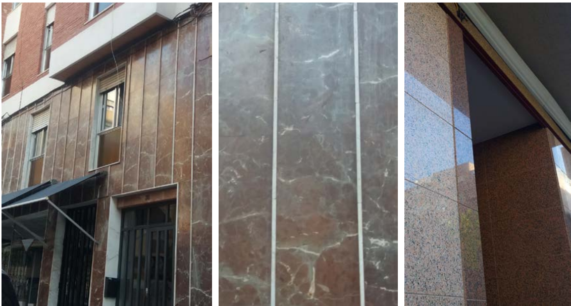
Aplacados con junta saliente marcando la verticalidad y el perímetro del acceso al zaguán del edificio.
