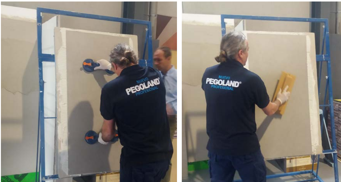
Colocación de lámina cerámica y palmeado de la superficie.
