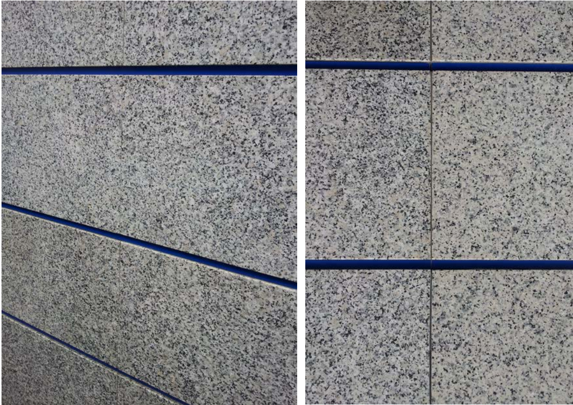
Aplacados con juntas verticales a tope y horizontales entrantes de distinto material.
