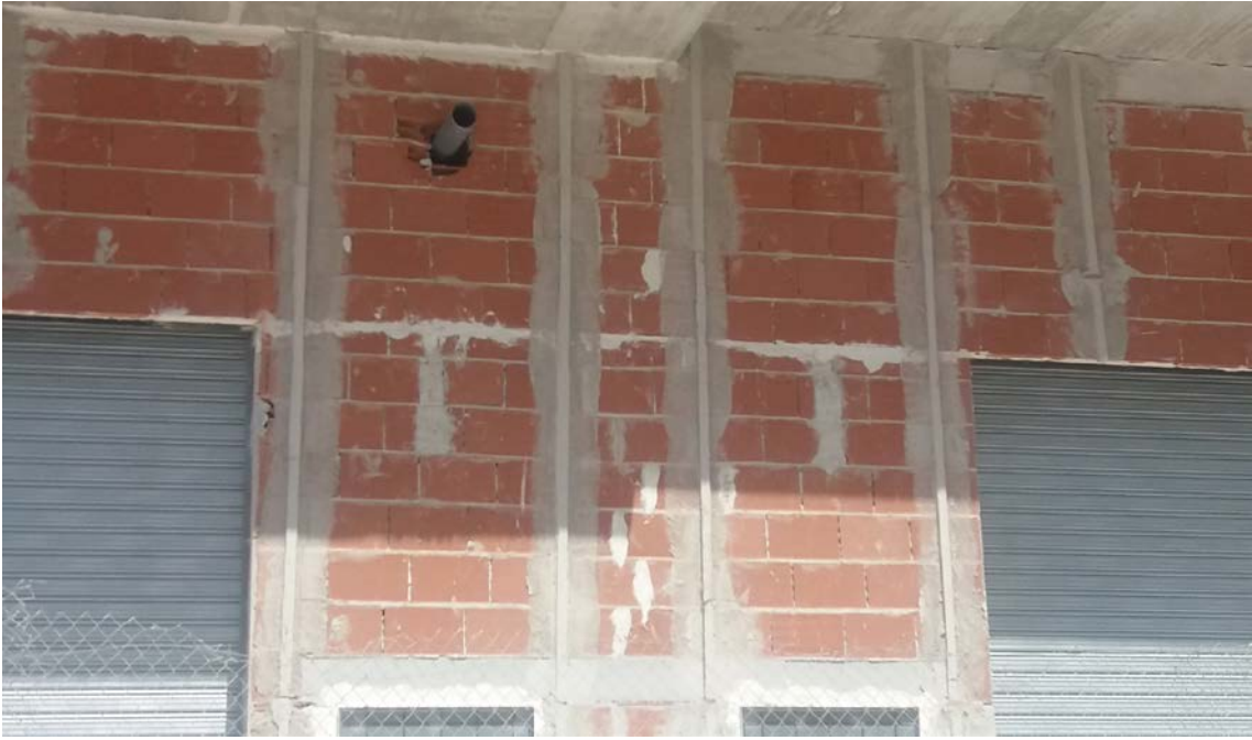
Ejecución de maestras en un conglomerado hidráulico en fachada exterior.
