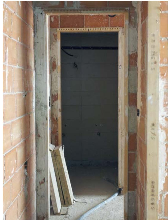
Orificios integrados en el premarco de las carpinterías de madera para garantizar la circulación del aire entre las distintas estancias dentro de una misma unidad de uso.
