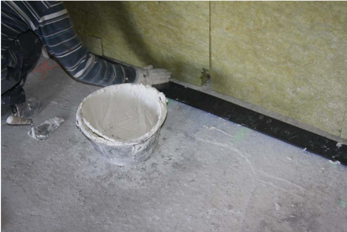
Pegado de banda acústica de espuma de polietileno previa ejecución del tabique.
