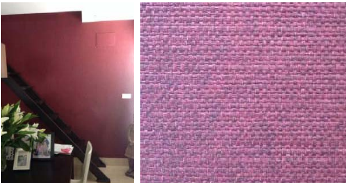
Revestimiento de pared con moqueta.
