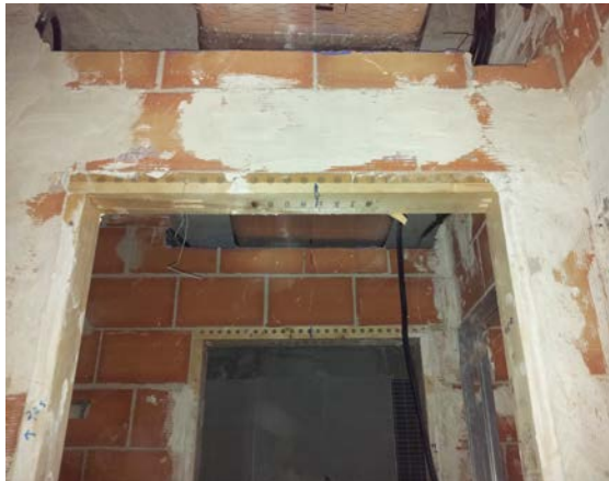
Orificios integrados en el premarco de las carpinterías de madera para garantizar la circulación del aire entre las distintas estancias dentro de una misma unidad de uso.
