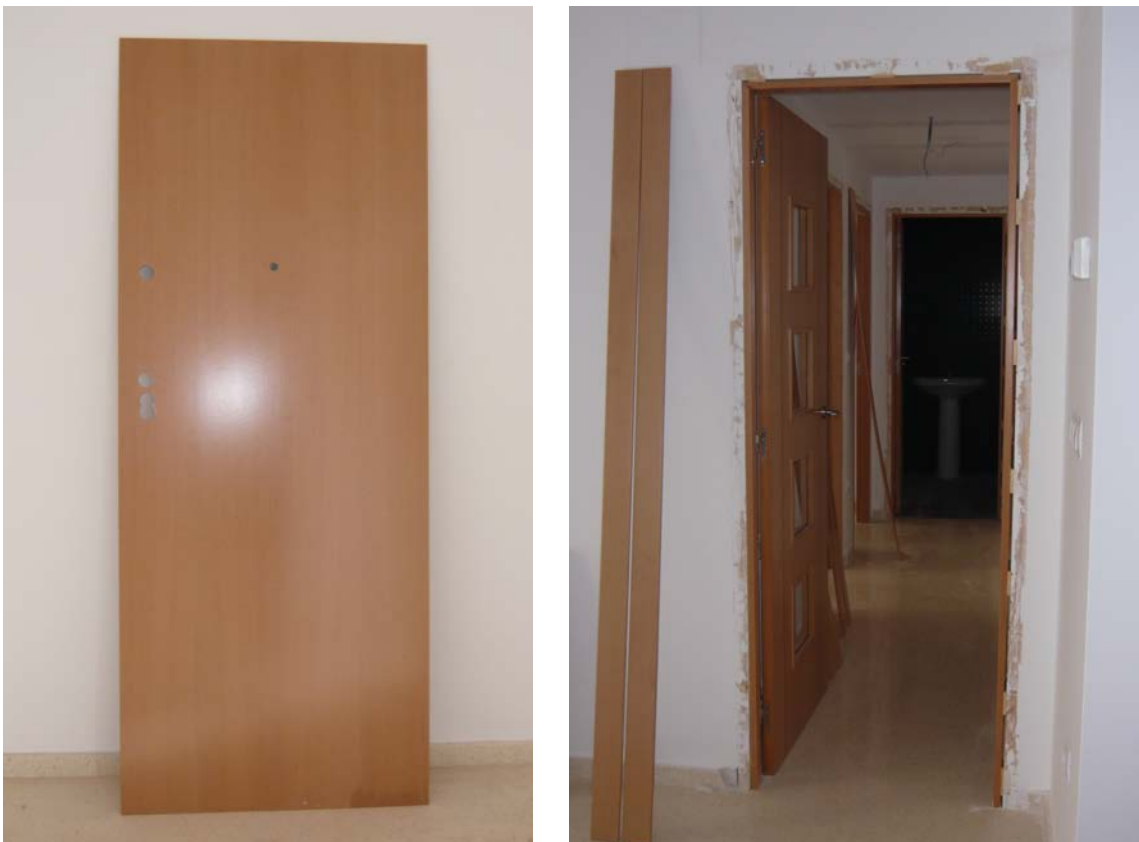
Hoja de puerta de acceso a vivienda en espera. Hoja interior colgada. Tapajuntas en espera.
