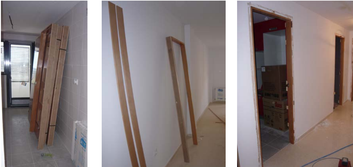
Almacenamiento de marcos y hojas, suministrados en pack de fábrica. Marcos y tapajuntas en espera. Colocación del marco en obra.
