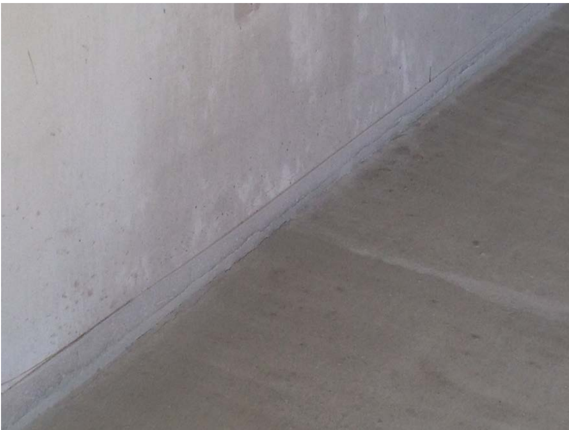
Junta de dilatación de la solera en el encuentro con el muro perimetral.
