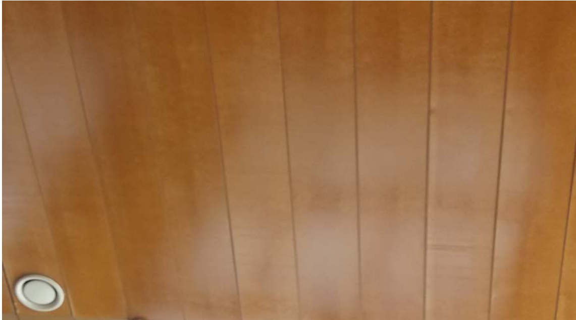
Falsos techos desmontable de madera.
