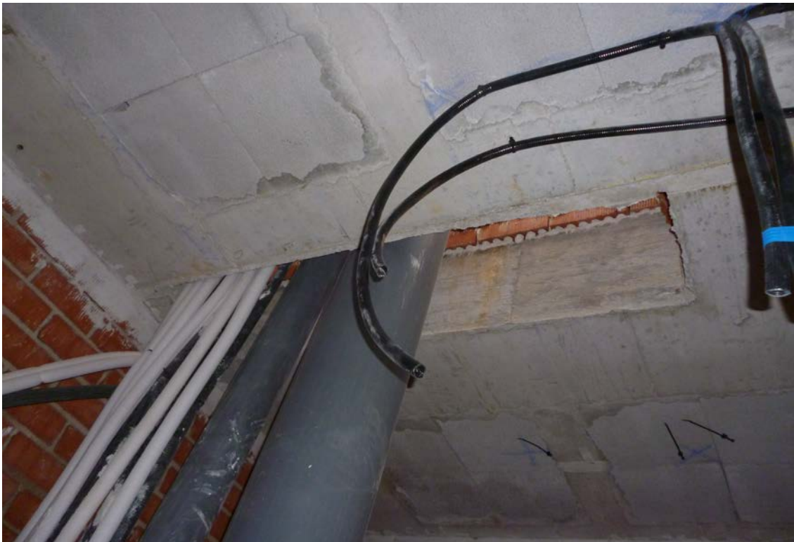
Huecos en el forjado para el paso de las instalaciones.
