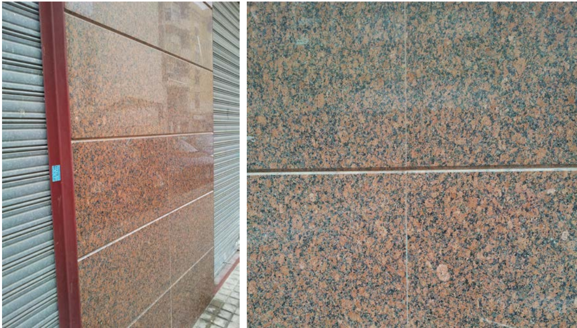
Aplacados con juntas verticales a tope y horizontales a bisel.
