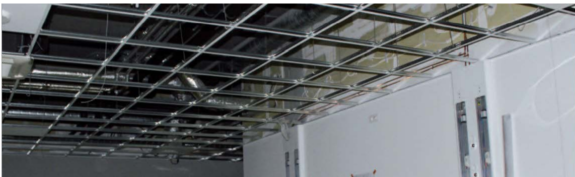
Estructura secundaria de falso techo registrable de placas de escayola.
