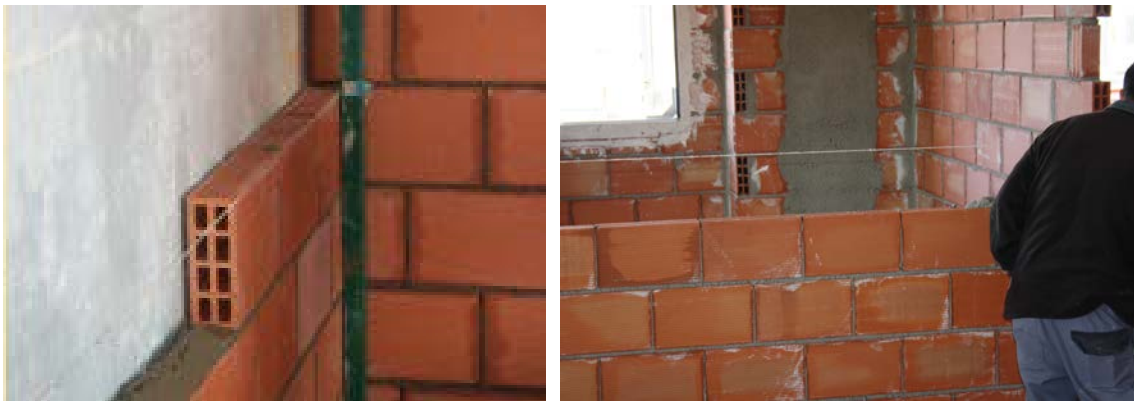
Nivelado de cuerdas marcado la altura de cada hilada de ladrillos.
