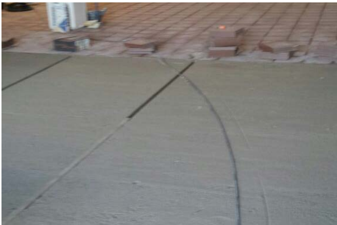
Colocación de pavimento de acabado sobre mortero de regulación maestreado.
