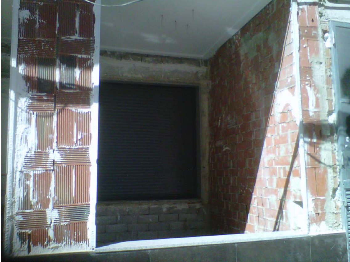
Colocación de guardavivos en las aristas, embebidos en un conglomerado hidráulico, acabado exterior de una fachada.
