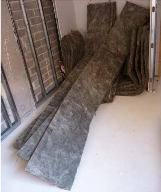
Relleno de las cámaras con mantas de lana de roca.
