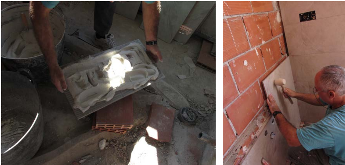
Colocación de la placa de piedra natural.
