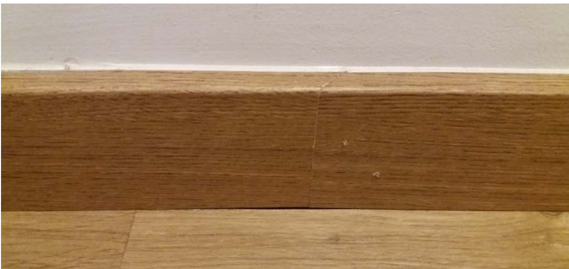
Colocación de rodapié para ocultar la junta de dilatación en el encuentro con el tabique.
