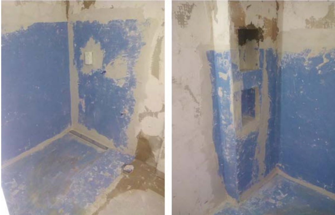
Impermeabilización del ámbito de una ducha de obra con lámina impermeable de polietileno.
