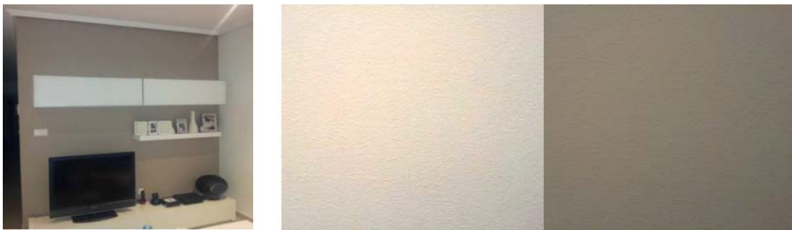
Ejemplo de tendido compuesto por: guarnecido + enlucido + pintura lisa en dos colores.
