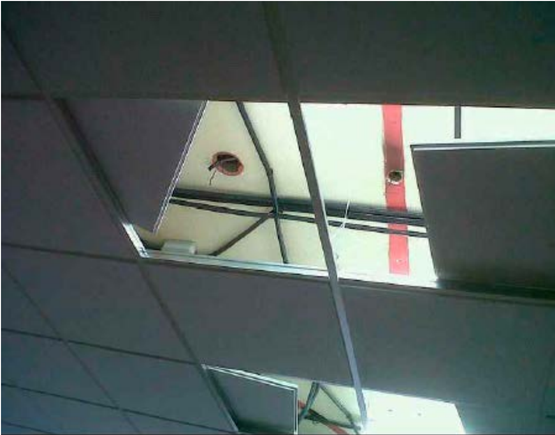
Placas de escayola apoyadas en la estructura portante.
