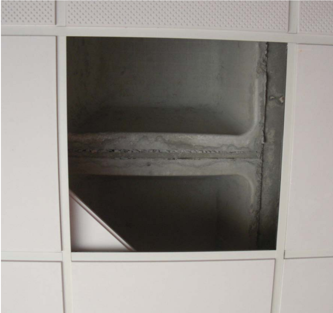
Falso techo registrable de placas de escayola.
