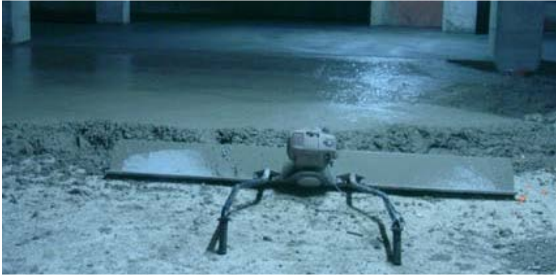
Vibrado superficial de la solera para proporcionar una superficie de acabado nivelada y lisa.
