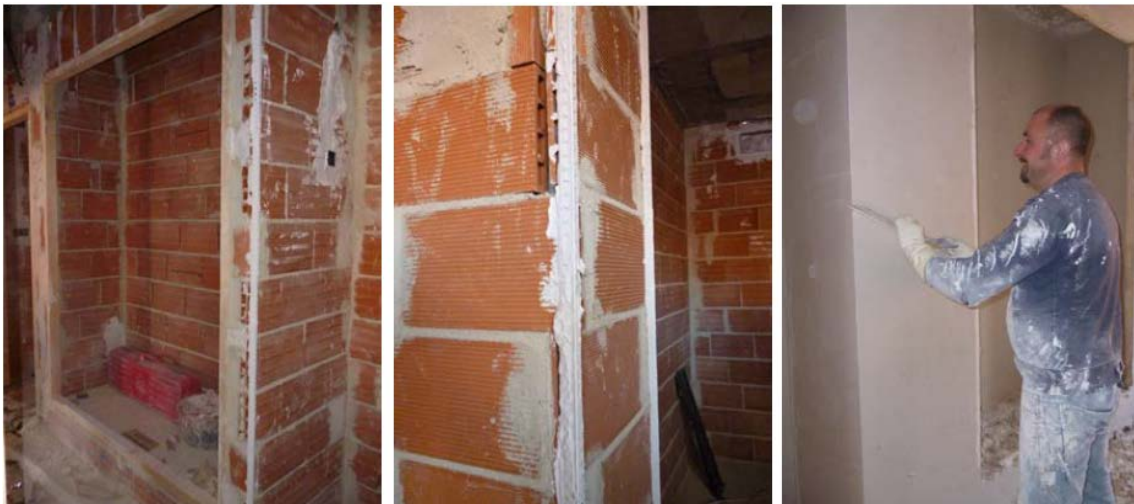
Colocación de guardavivos en las aristas, embebidos en un conglomerado no hidráulico, un enlucido.
