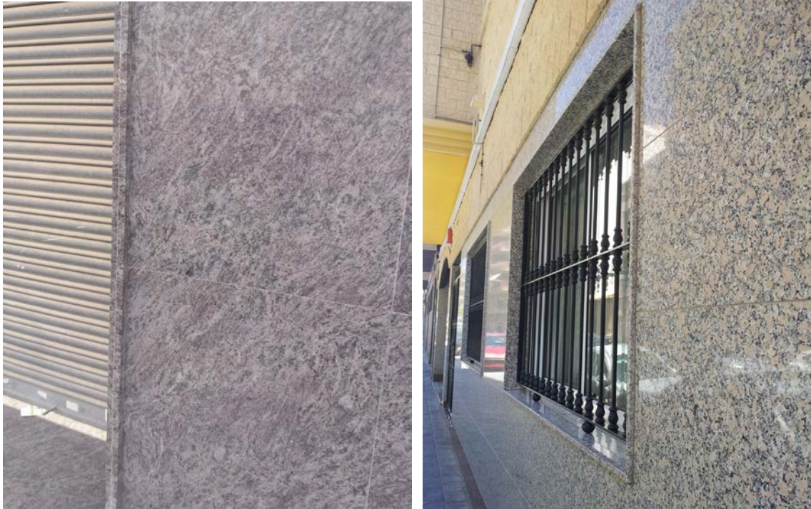
Ejemplo de placas con canto a tope saliente.
