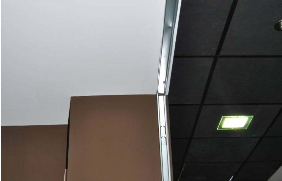
Montante de arranque y canal superior atornillados a la obra gruesa.
