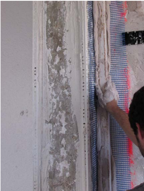
Mallas de fibra de vidrio embebidas en el conglomerado durante su ejecución en las zonas de encuentro entre distintos materiales.
