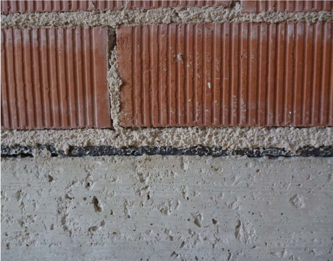
Bandas acústicas convenientemente fijadas al forjado antes de la ejecución de la fábrica.
