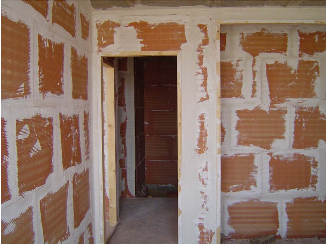
Retirada de escuadras de premarcos.
