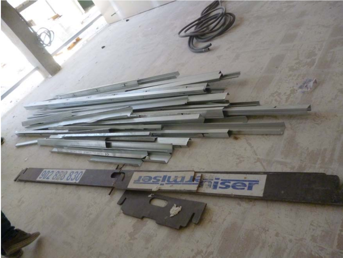
Perfiles de acero galvanizado de la estructura autoportante para la ejecución de los tabiques, almacenados en obra.
