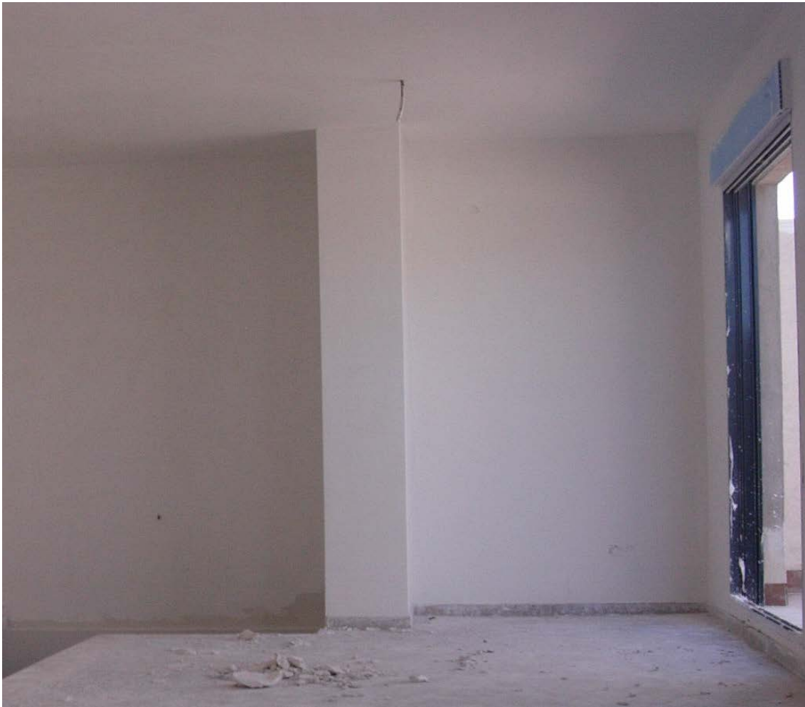
Planicidad de paramentos y rectitud de las aristas.
