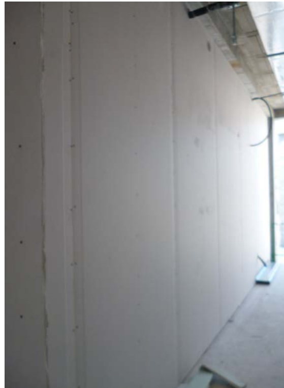
Cierre del sistema con el atornillado de los tableros de la segunda cara.
