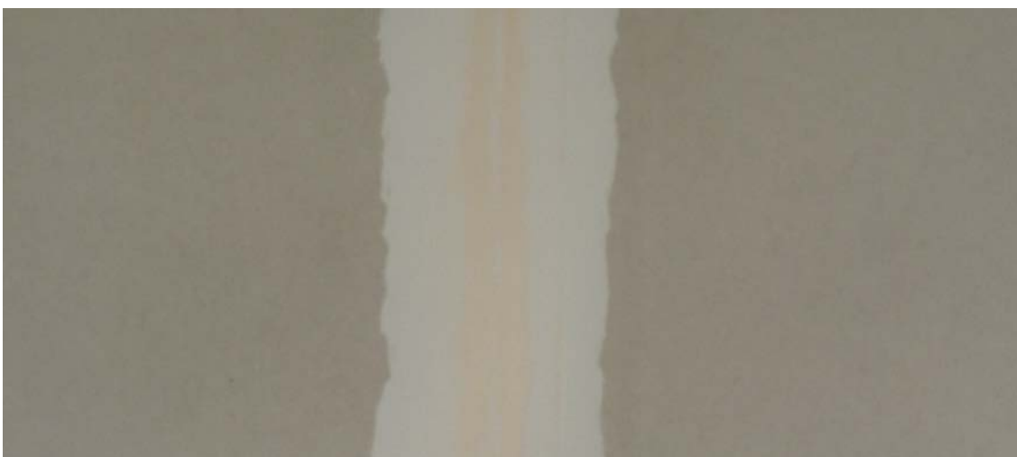
Colocación de la cinta de junta sobre la primera capa de pasta de junta.
