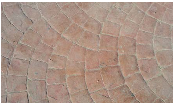
Soleras con acabado de hormigón impreso.
