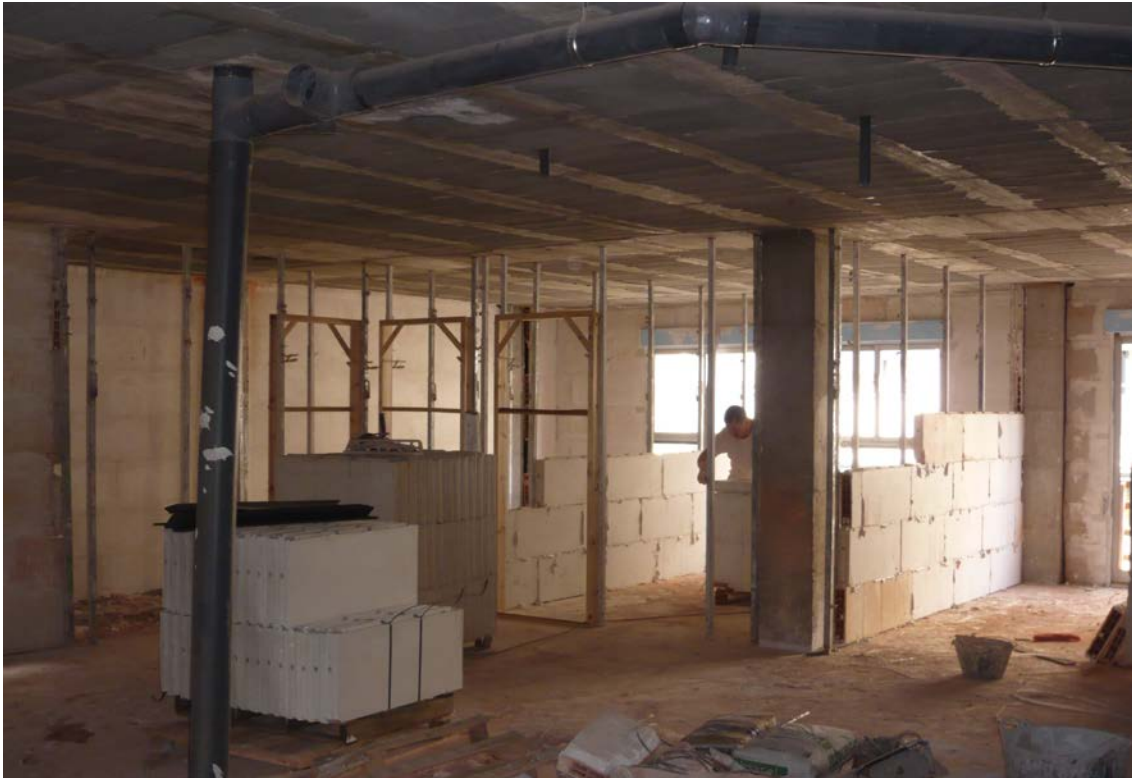
Disposición de miras y precercos para la ejecución de un tabicón de ladrilyeso.
