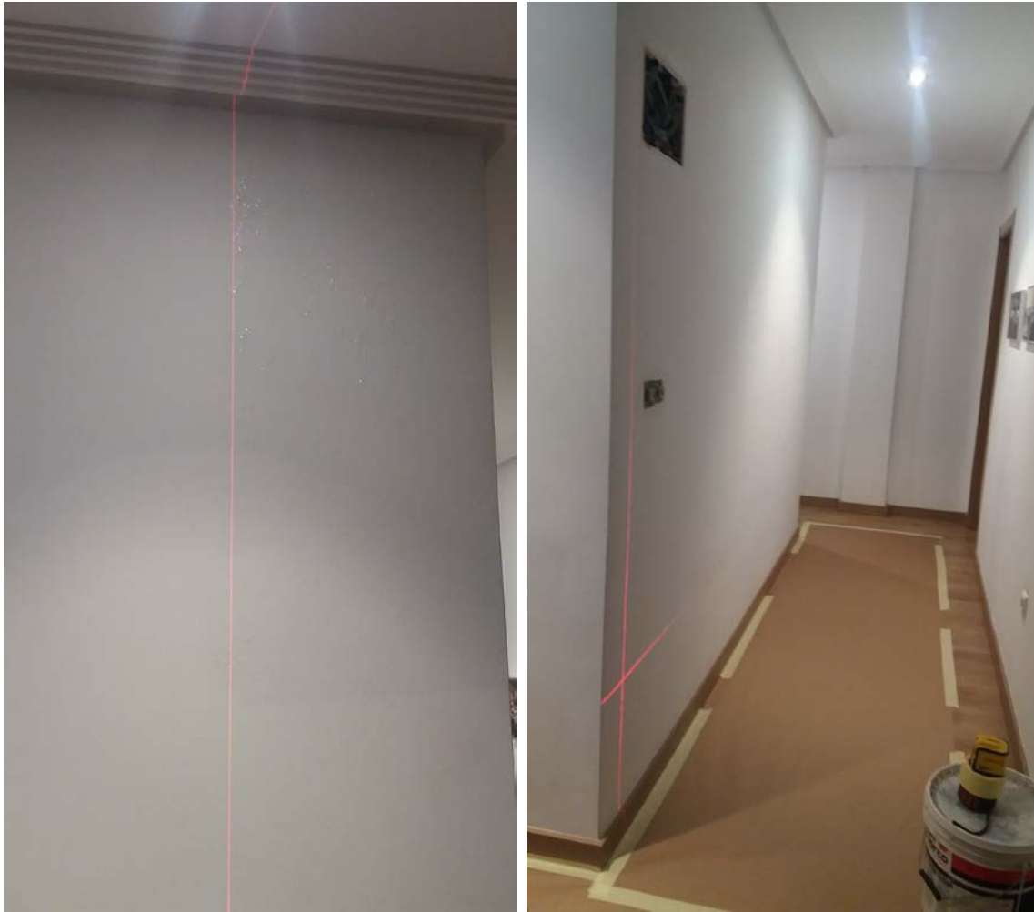
Nivelado de la vertical con láser.
