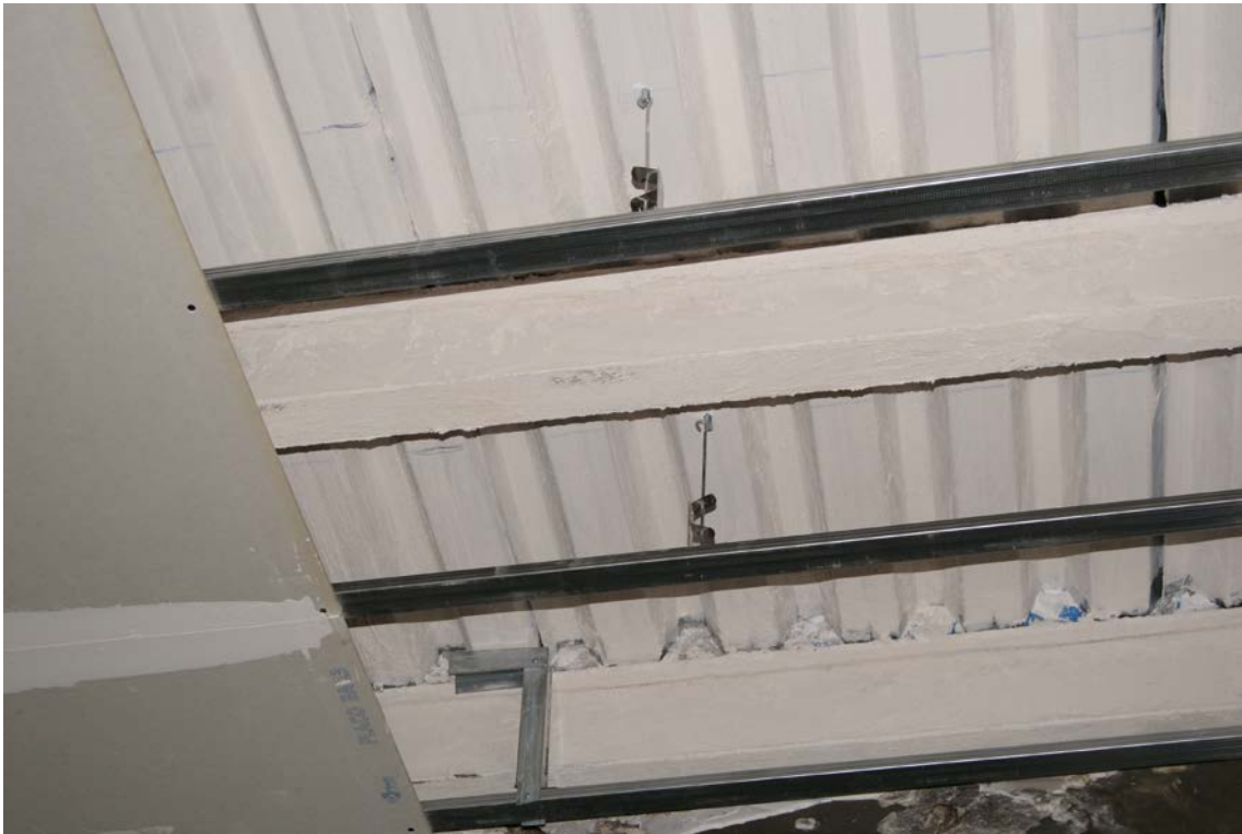
Techo simple con suspensión de varillas roscadas.
