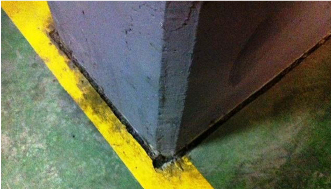
Junta de dilatación sellada con masilla asfáltica.
