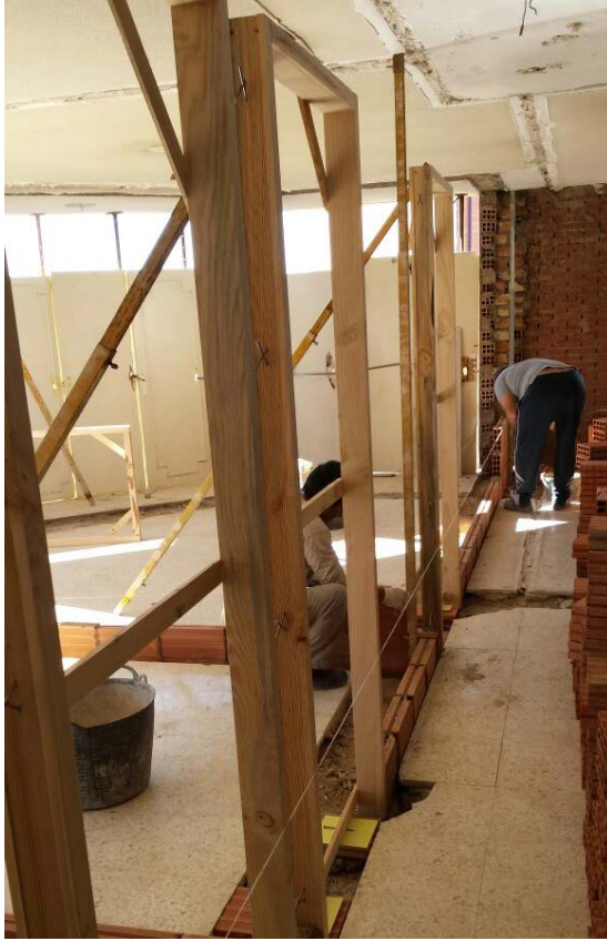
Premarcos aplomados y sujetos mediante puntales.
