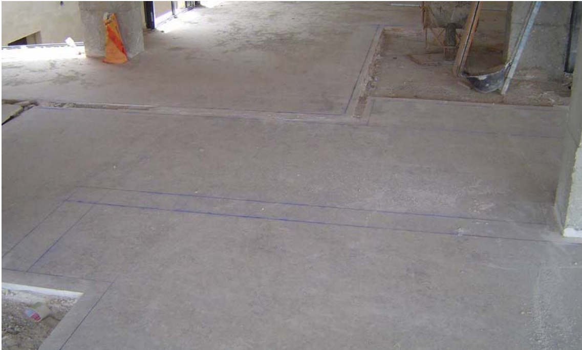
Replanteo de la tabiquería de una misma unidad de uso sobre suelo flotante.
