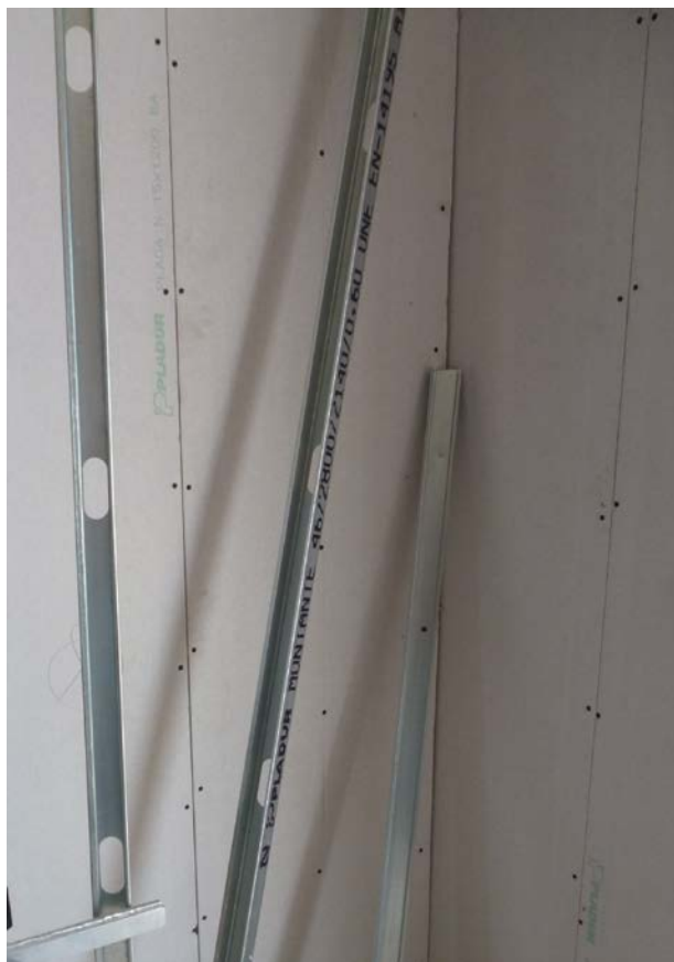
Troqueles y huecos ovalados en el alma de los montantes para el paso de instalaciones.
