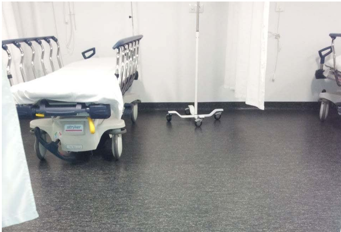
Pavimento de linóleo en un hospital.
