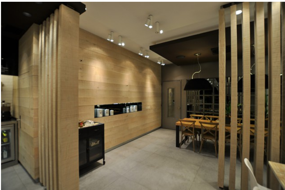
Revestimiento de pared con listones horizontales de madera. Fuente: < www.dumaplast.com > [Consulta: 10 de septiembre de 2019]
