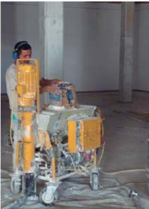
Máquina para proyección del yeso y pistola de proyección.
