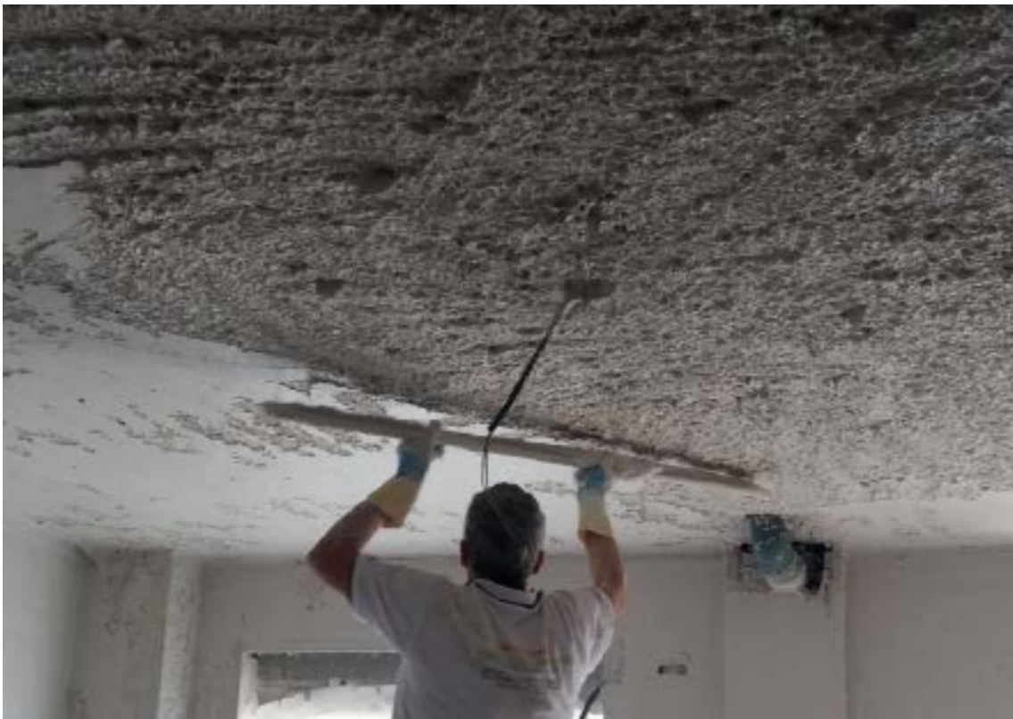
Extendido del yeso proyectado a buena vista.
