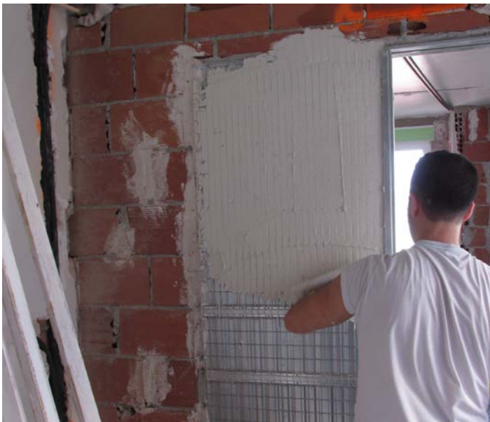
Rellenado del cajón con pasta de yeso reforzando con malla de fibra de vidrio el encuentro entre materiales.
