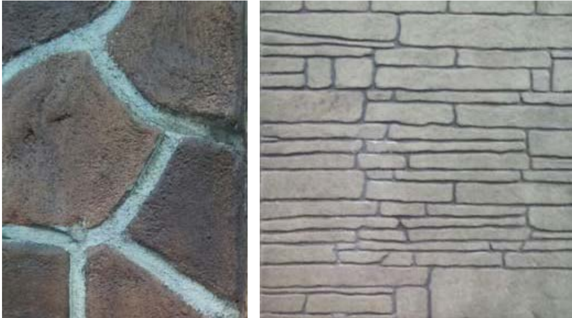
Ejemplos de revocos pétreos en fachadas imitando fábricas de piedra natural.
