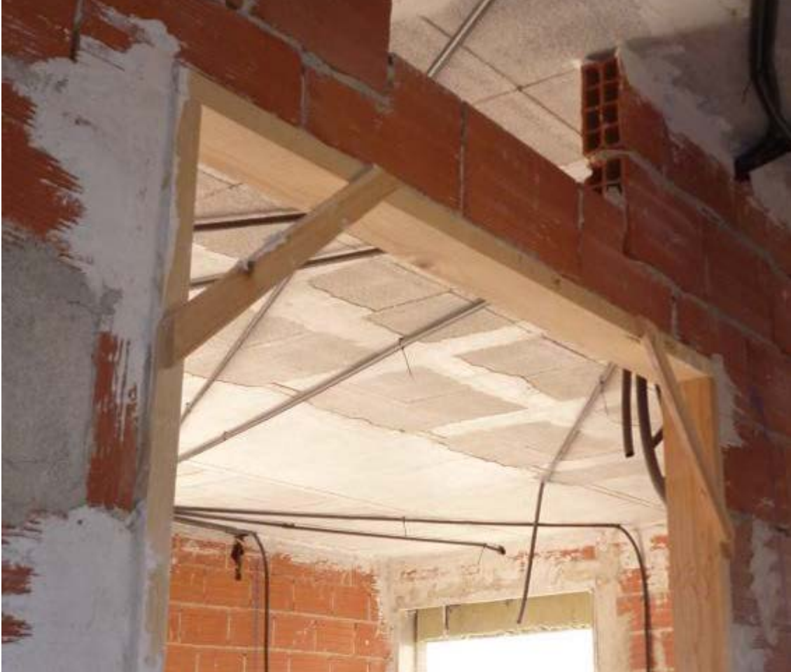
Refuerzo de la tabiquería en las esquinas de los cercos.
