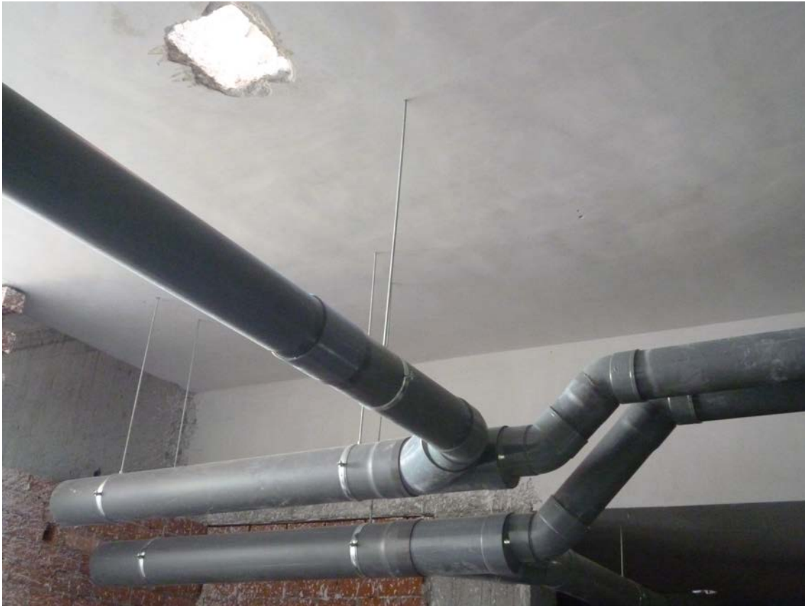
Rebozado aplicado a la cara inferior del forjado en la planta sótano de uso aparcamiento.
