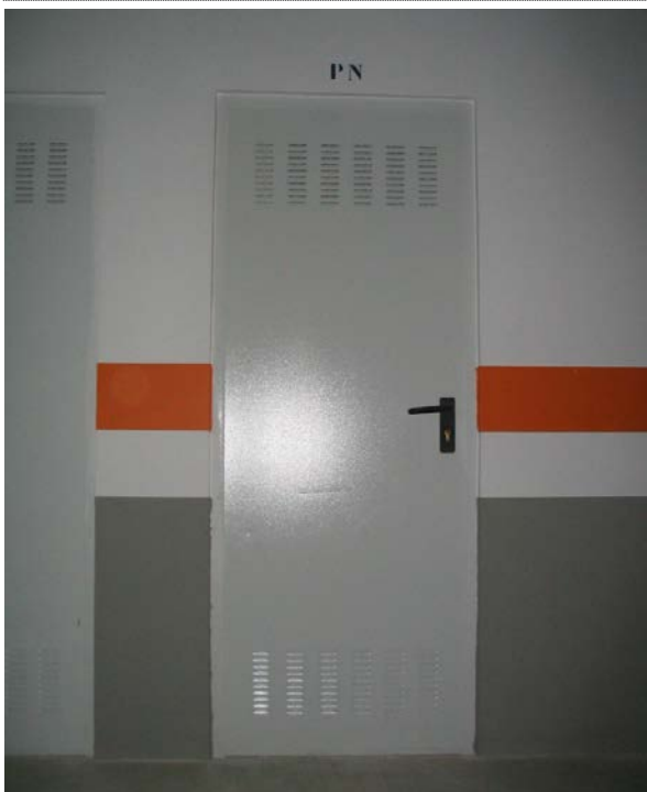
Carpinterías metálicas de los trasteros con rejillas de ventilación.
