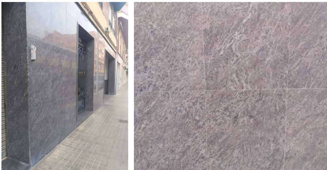
Aplacados con juntas verticales y horizontales a tope.
