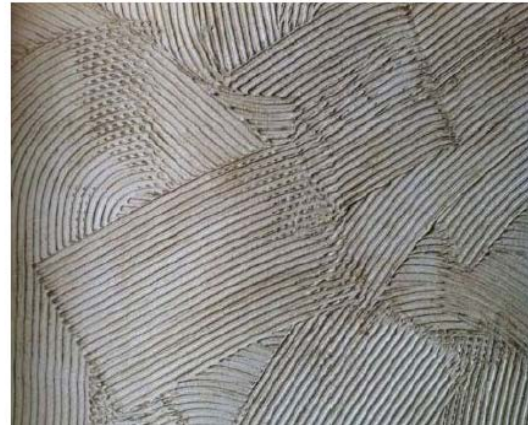
Ejemplo de estuco no hidráulico con acabado rústico sobre guarnecido.
