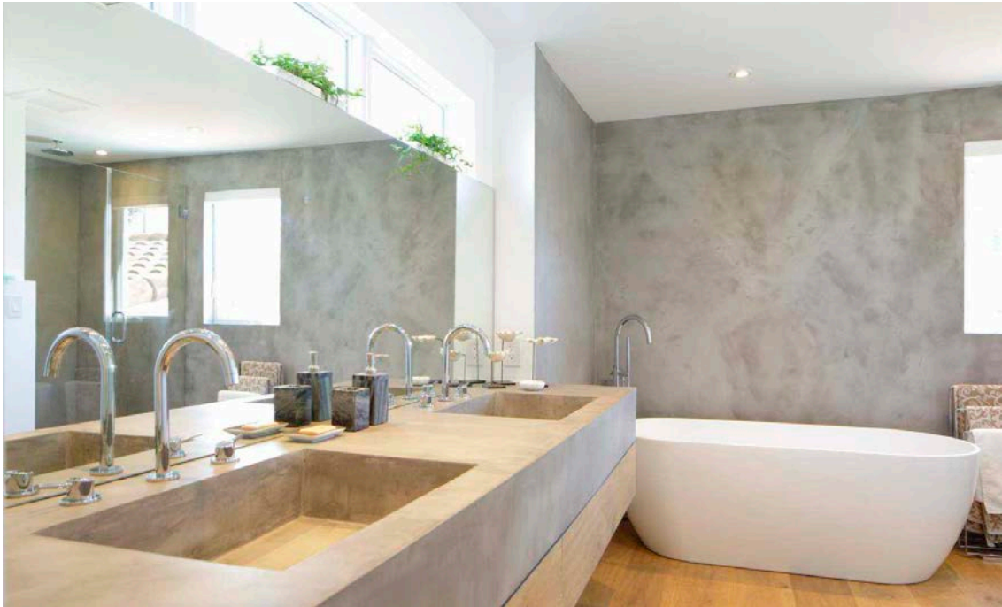
Microcemento como revestimiento de paredes y muebles en baño. Fuente: < www.topciment.com > [Consulta: 14 de junio de 2021].
