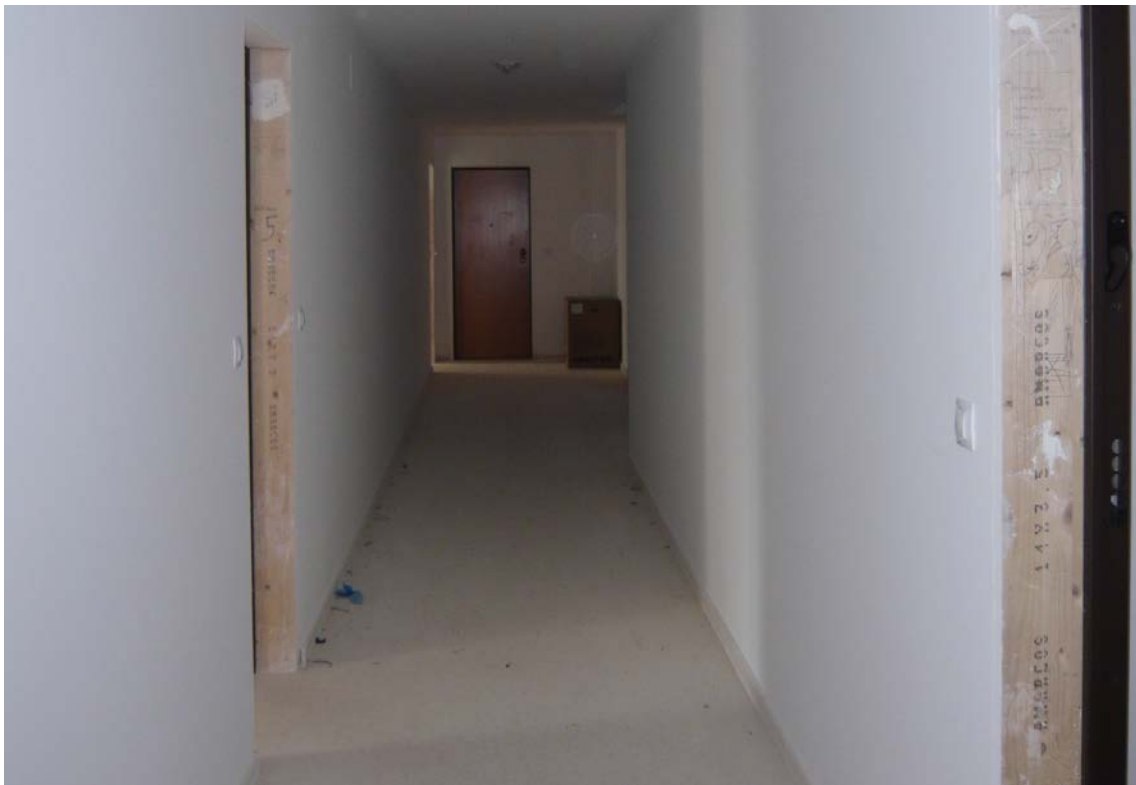
Enlucido de yeso enrasado con premarco de puerta abatible.
