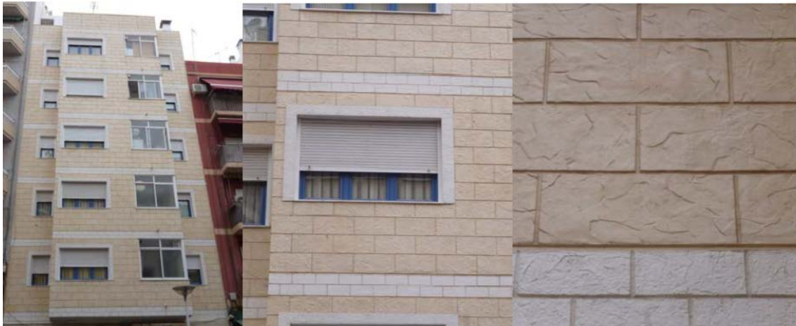
Ejemplo de revoco pétreo en una fachada imitando el despiece de un bloque de hormigón.
