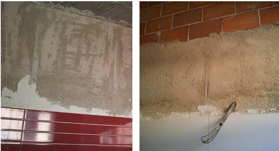
Izquierda: enfoscado ejecutado correctamente. Derecha: enfoscado ejecutado incorrectamente por la interrupción a la altura del falso techo.
