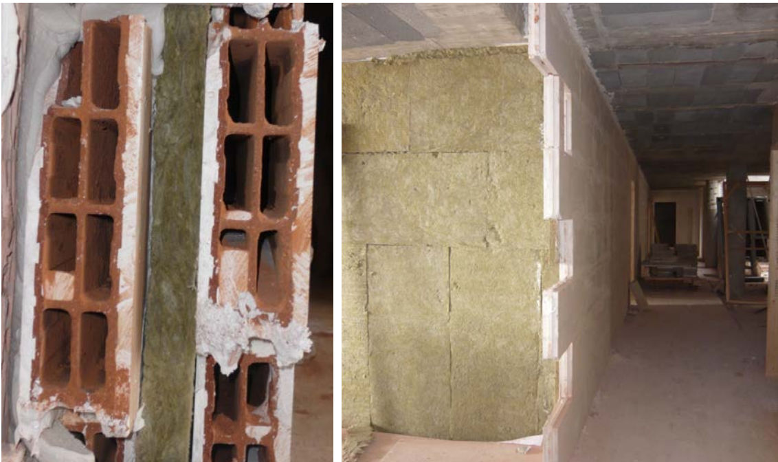
Mantas de lana de roca rellenando la cámara de separación de las dos hojas que constituyen los elementos de separación vertical entre viviendas en toda su superficie y espesor.
