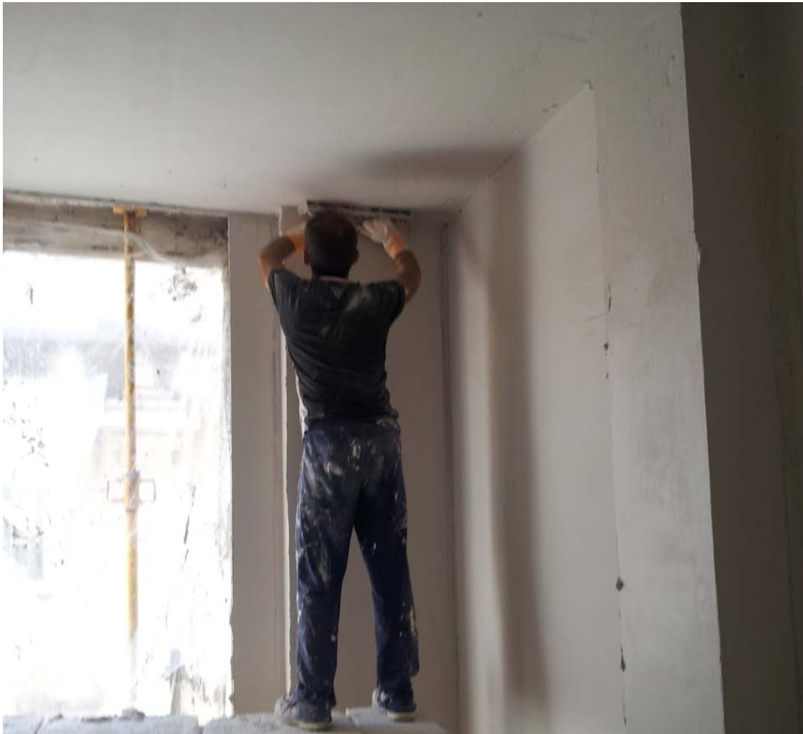
Extendido del yeso de forma manual
