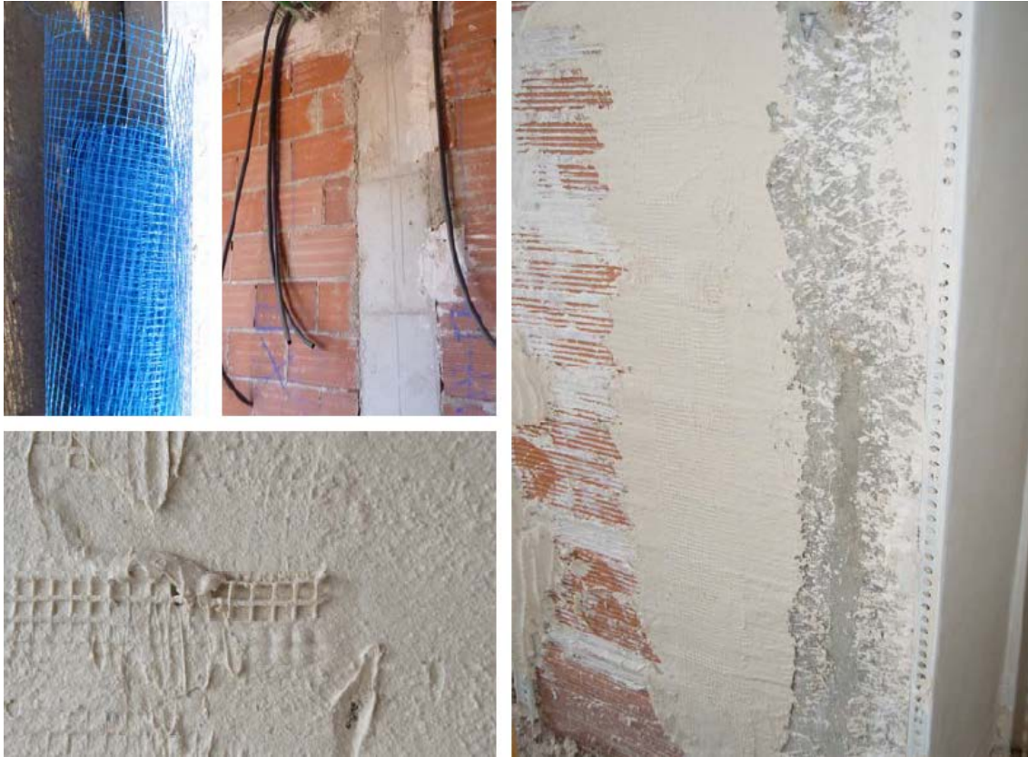
Colocación de malla de fibra de vidrio en el encuentro de un pilar con el tabique de compartimentación, quedando embebida en el grueso del guarnecido.
