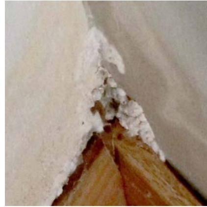
Aparición de hongos en superficies verticales y horizontales por exceso de humedad.
