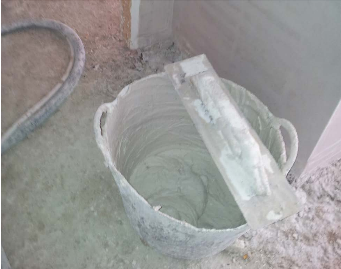
Preparado de la pasta para extendido manual.
