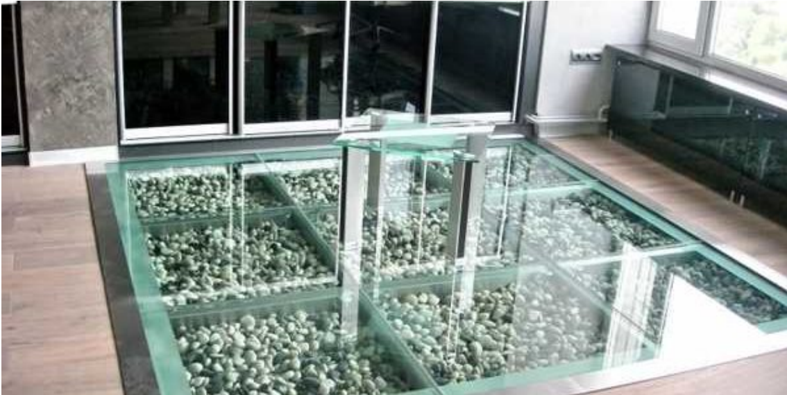
Suelo de baldosas de vidrio con relleno de canto rodado. Fuente: < https://www.vidriopanel.es/blog/poner-suelos-cristal/ > [Consulta: 28 de septiembre de 2019].
