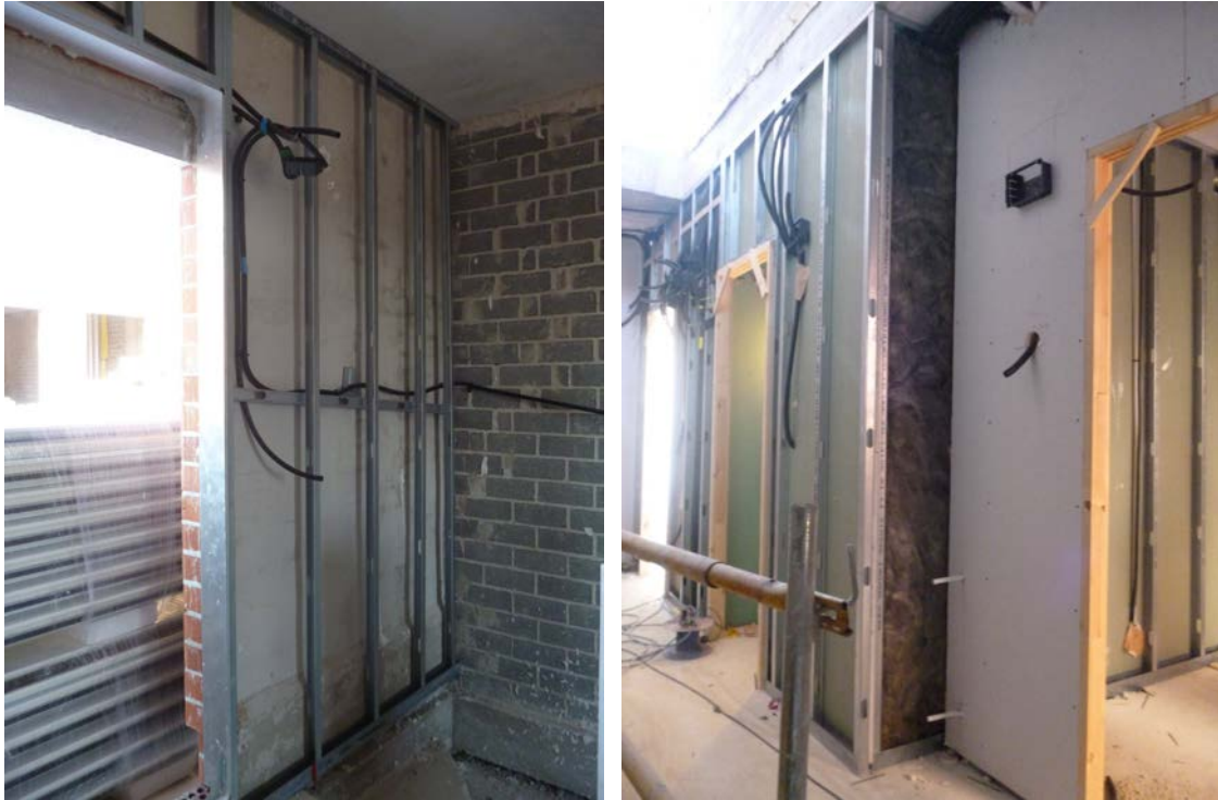
Huecos de paso materializados con la estructura metálica y la posterior colocación de los premarcos de madera.
