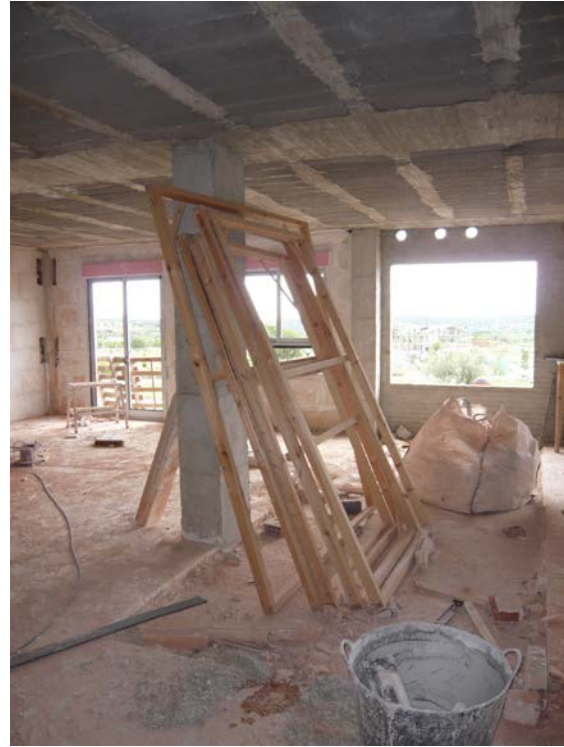
Premarcos de madera almacenados en planta previamente a su colocación.
