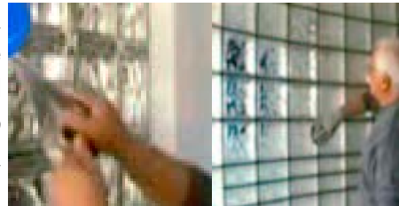
Rejuntado y limpieza de la superficie. Fuente: < www.vitroland.com > [Consulta: 9 de septiembre de 2019].
