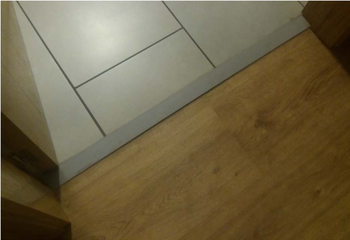
Junta entre pavimentos cubierta con perfil de aluminio.
