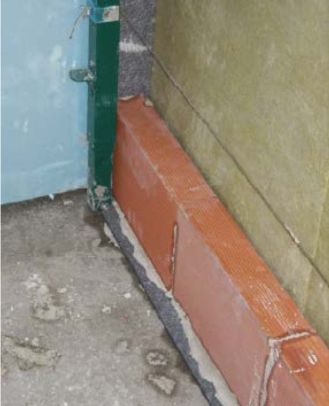
Disposición de banda acústica perimetral de poliestireno de grafito en una hoja de un tabique divisorio entre distintas unidades de uso.
