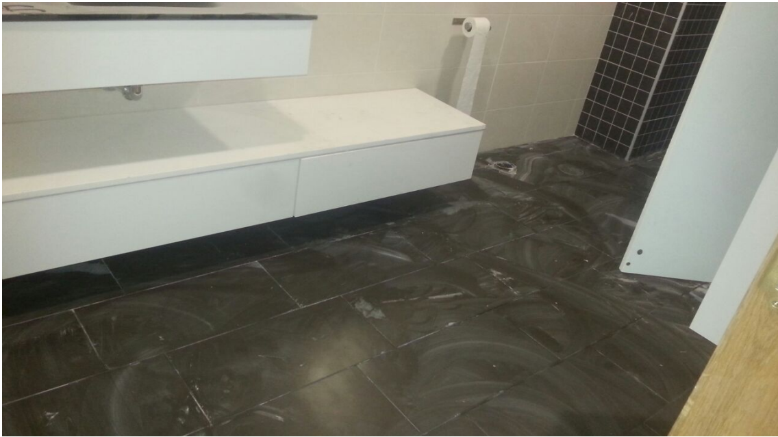
Pavimento de un núcleo húmedo interior.
