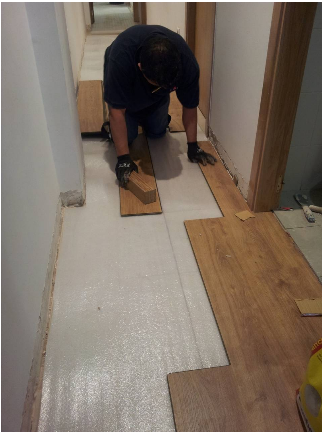
Colocación de las tablas en obra.
