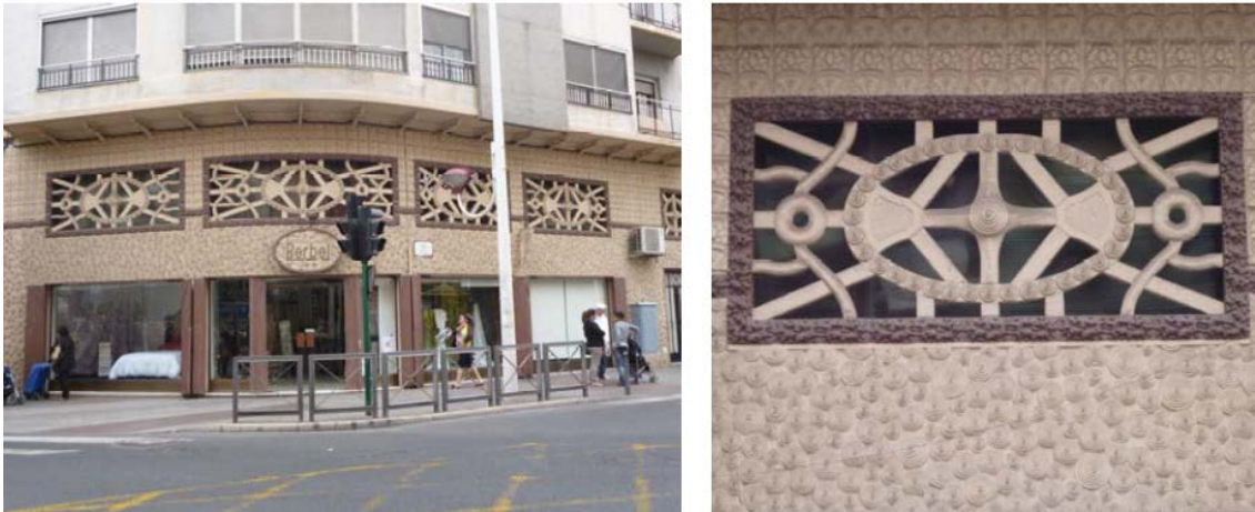
Ejemplos de estucos de relieve en la planta baja de una fachada.
