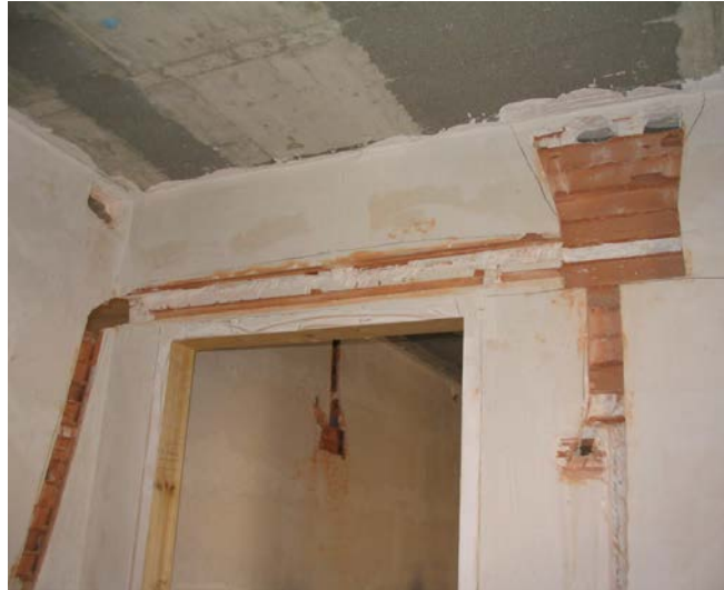
Debilitamiento de los tabiques por la apertura de rozas, principalmente las de trazado horizontal.
