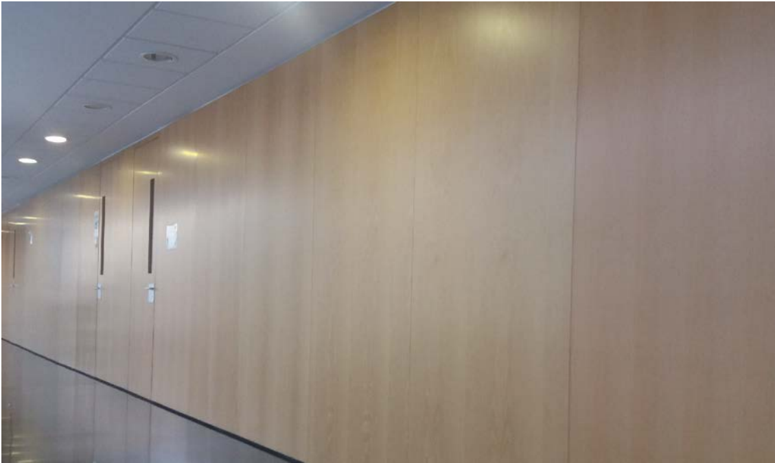
Tabique de tableros de madera con acabado visto.
