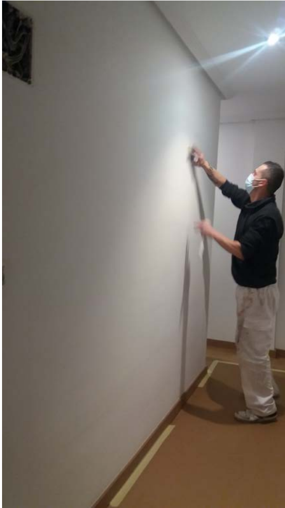
Lijado de la superficie y aplicación de la cola con brocha.
