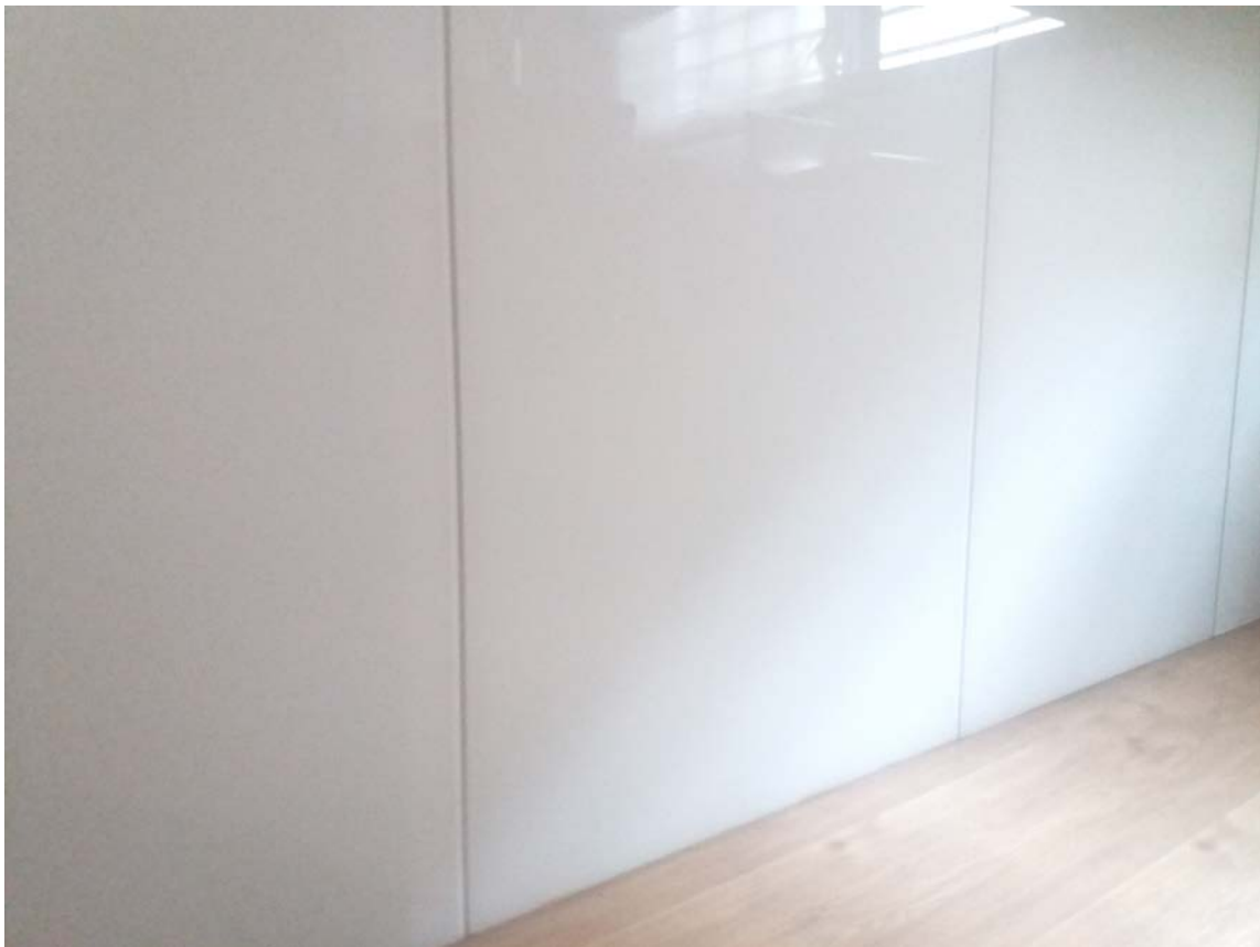
Rvestimiento de pared con planchas de vidrio blanco.
