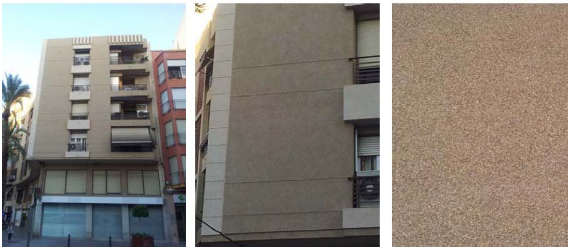
Ejemplo de fachada revestida con un monocapa con acabado de árido proyectado. Detalle del despiece y de la textura del acabado.
