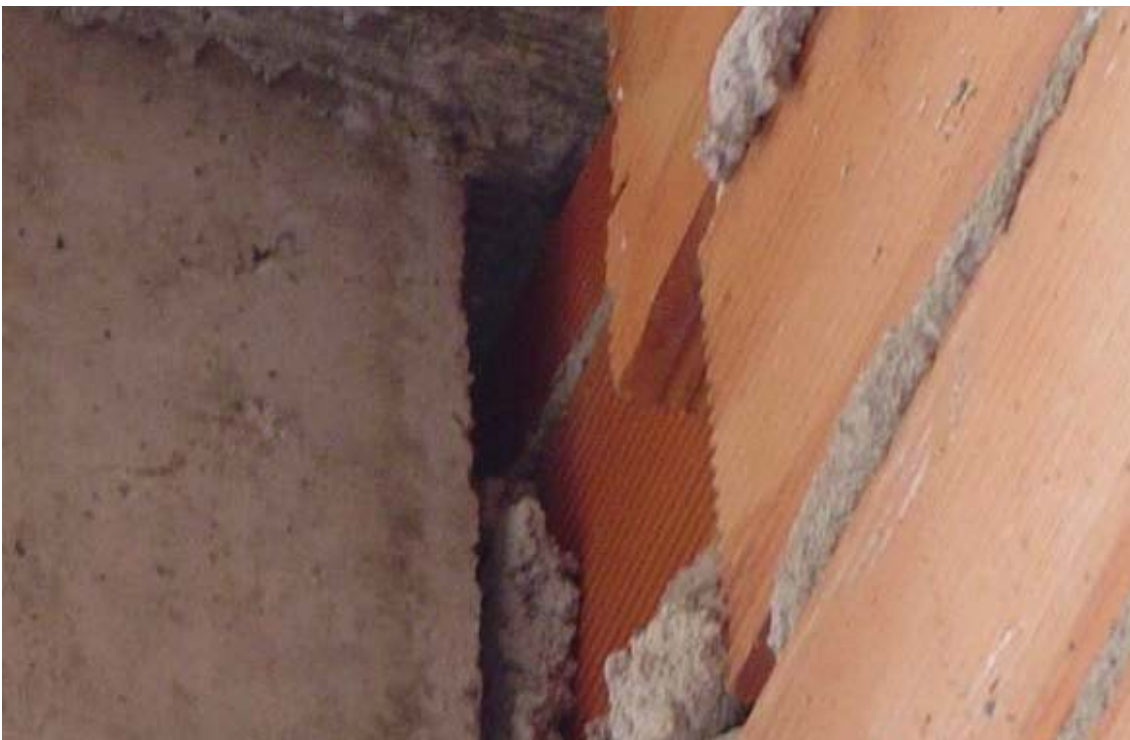
Junta deslizante tabique-pilar.
