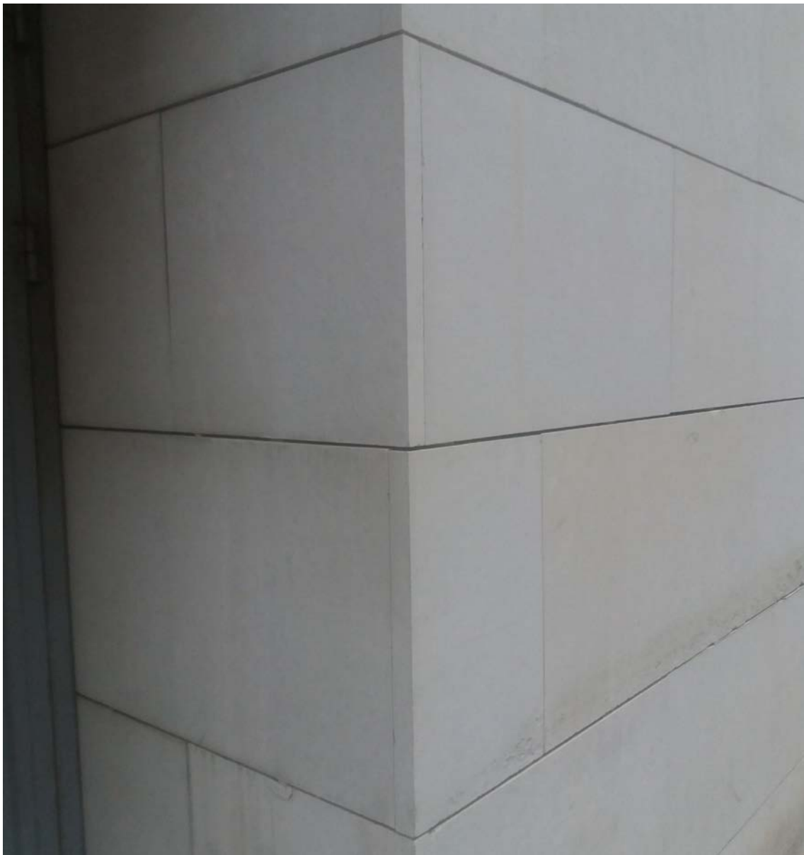
Ejemplos de aplacados con canto a tope visto en los dos planos de forma alterna.
