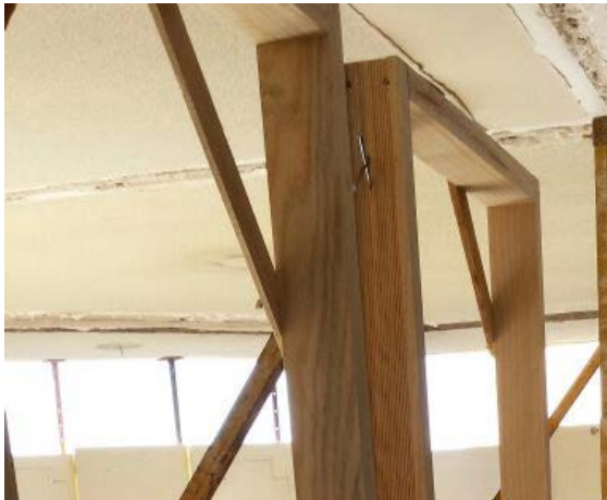
Clavos de agarre y relleno de los huecos para embeberlos al tabique con pasta.
