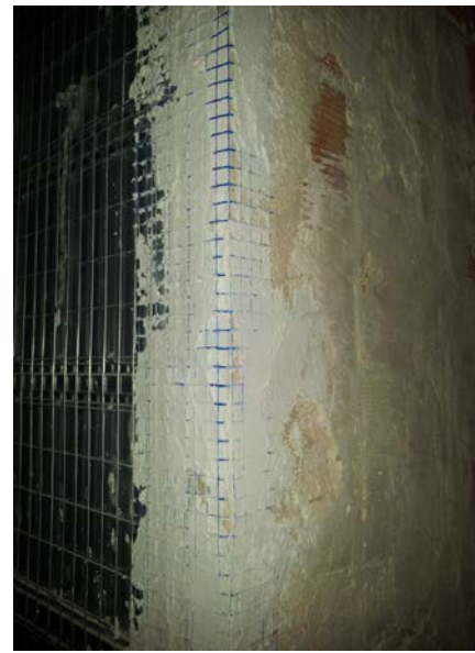
Rellenado del cajón con pasta de yeso reforzando con malla de fibra de vidrio el encuentro entre materiales.
