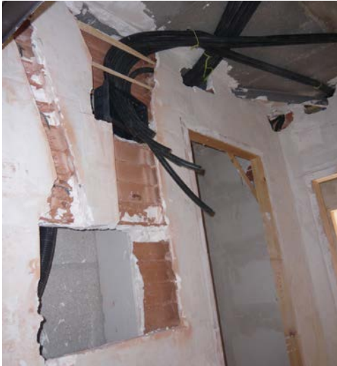
Debilitamiento de los tabiques por la apertura de rozas, principalmente las de trazado horizontal.
