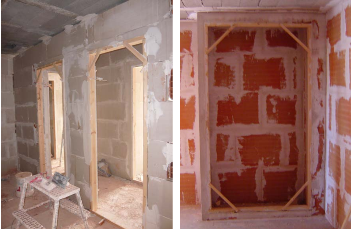
Premarcos de madera colocados en obra.
