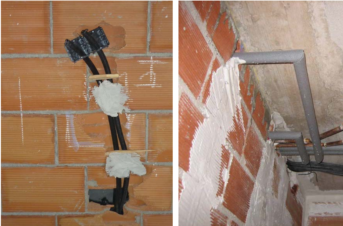
Rozas para instalaciones no pasantes y posterior rellenado con pasta.
