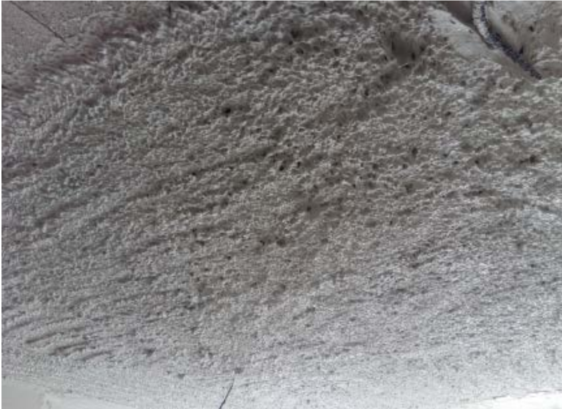
Yeso proyectado sobre la cara inferior del forjado.
