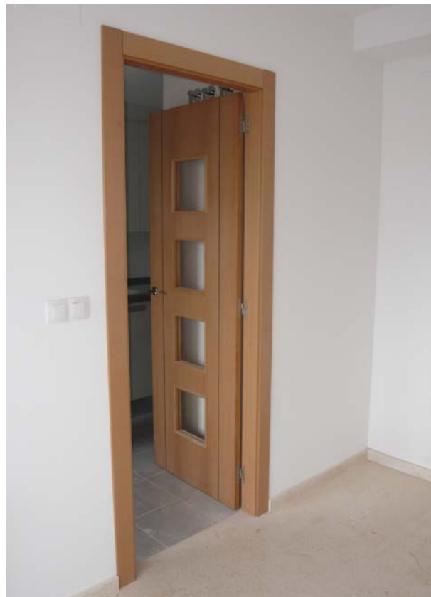
Disposición de bisagras y demás herrajes de la hoja.
