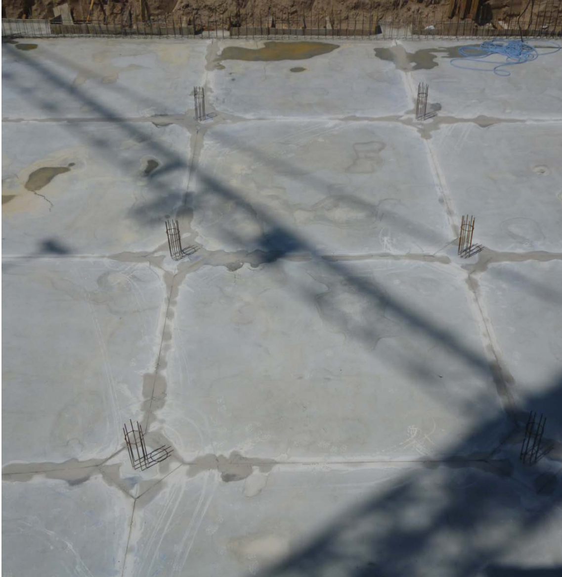
Retícula creada con las juntas de retracción de la solera.
