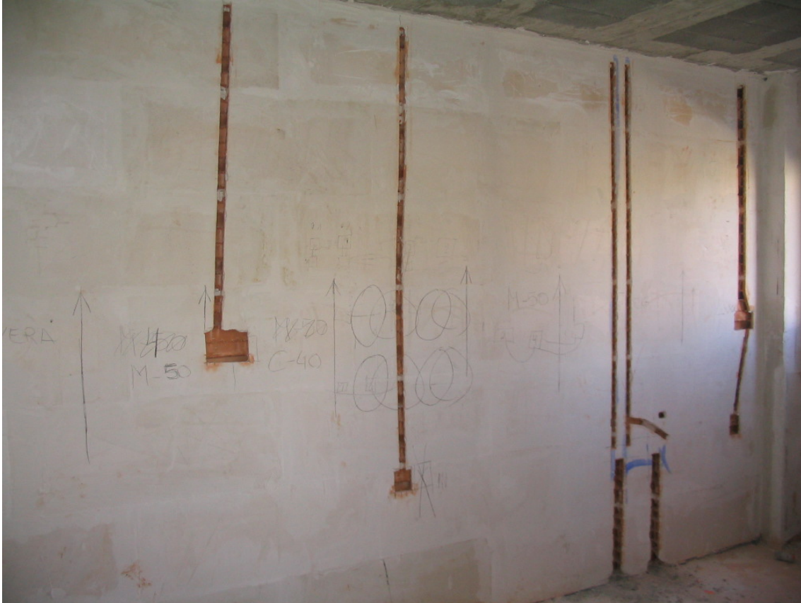
Rozas practicadas en tabique de fábrica de ladrillo hueco doble.
