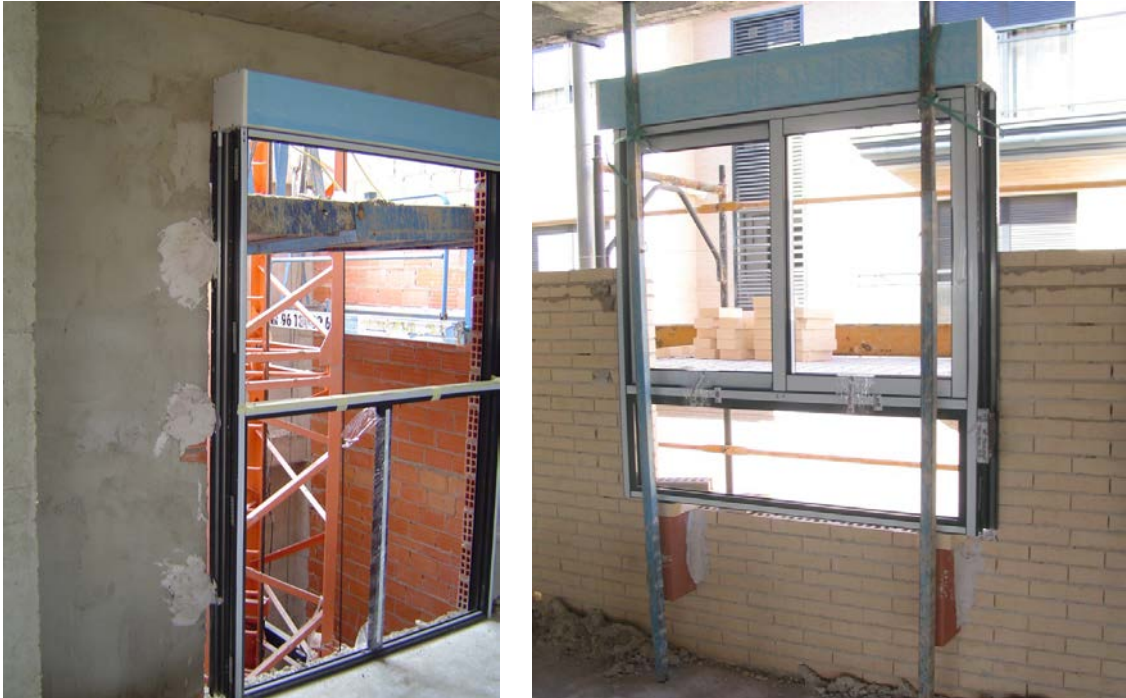
Colocación de carpintería en obra.
