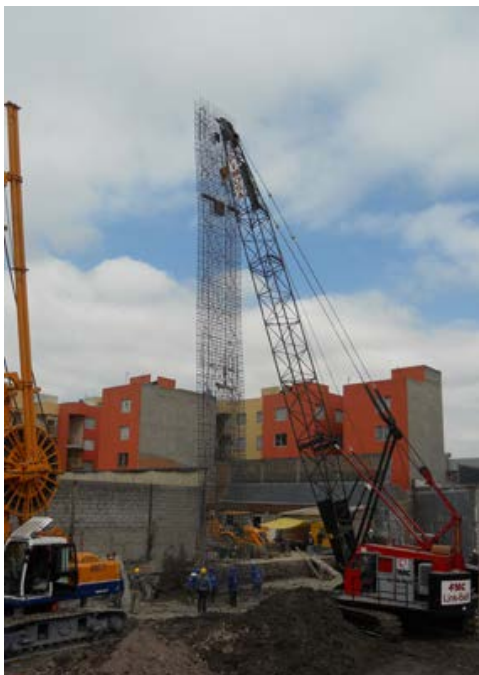
Colocación de las jaulas de armaduras. Fuente: <www.pimosa.com> [Consulta: 4 de febrero de 2014].
