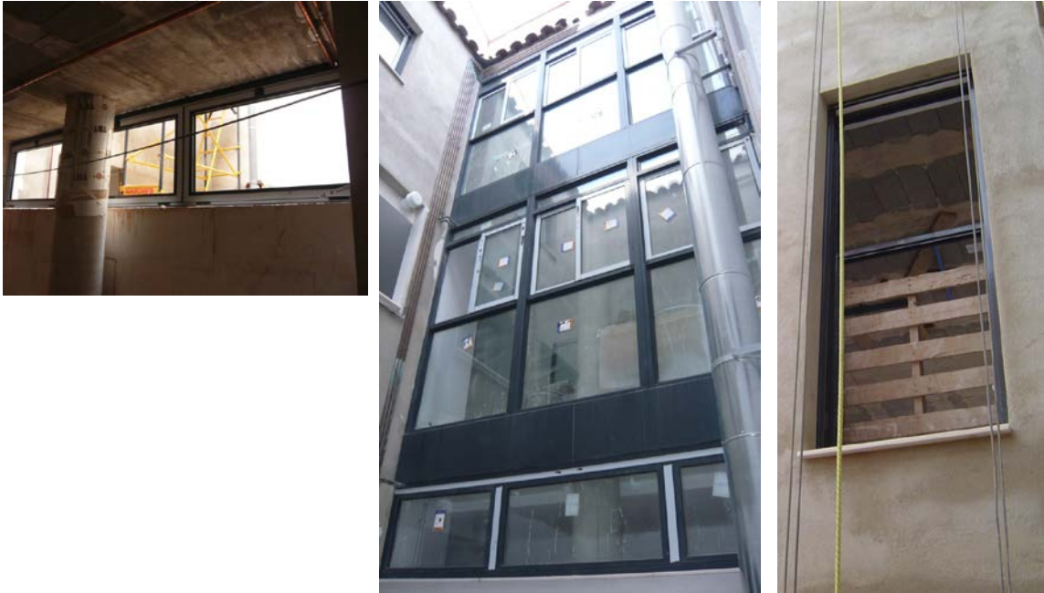
Ventanas con distintos sistemas de abertura.
