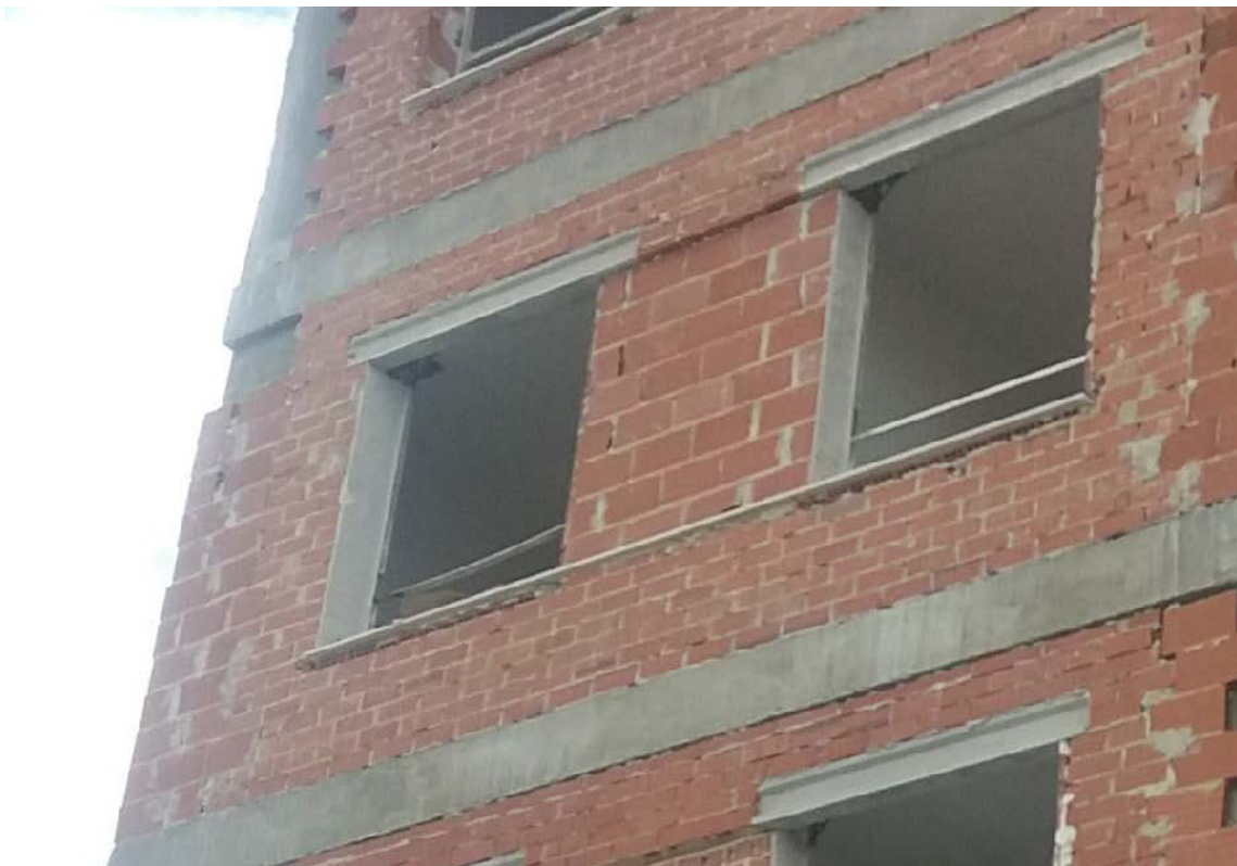
Fachada de ladrillo a revestir con viguetas ejerciendo de cargaderos.
