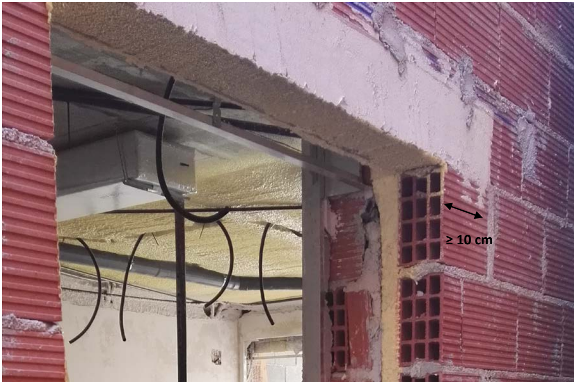
Apoyo de cargadero de hormigón en los paños de fábrica de ladrillo contiguos.
