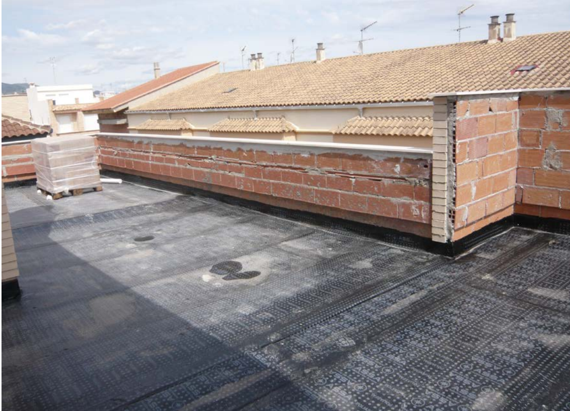
Disposición de lámina impermeable bituminosa adherida, con doblado en el encuentro con los paramentos verticales embebido en el rebaje practicado en el peto.
