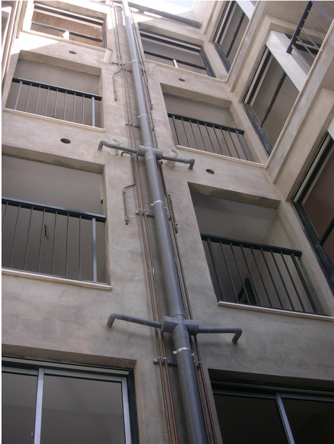
Instalación de gas canalizado y de saneamiento en fachada a patio interior.
