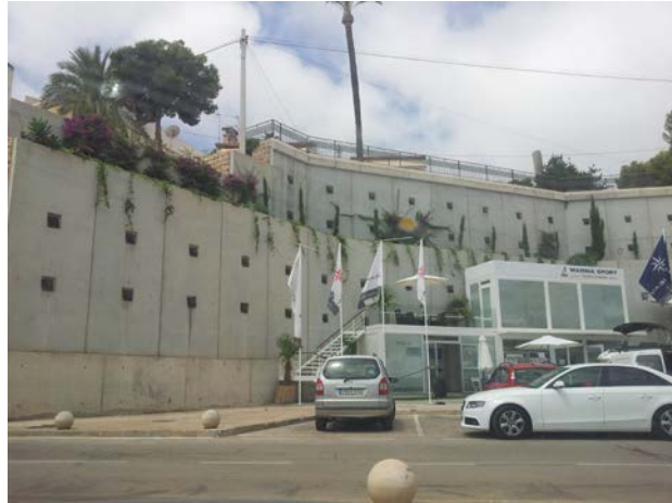
Muros de contención por bataches.
