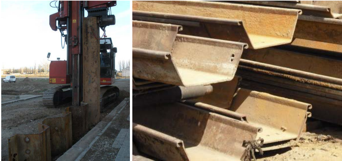
Ejecución de las pantallas y perfiles de las tablestacas. Fuente: <www.emgrisa.es> y <www.azendra.com> [Consulta: 3 de febrero de 2012].
