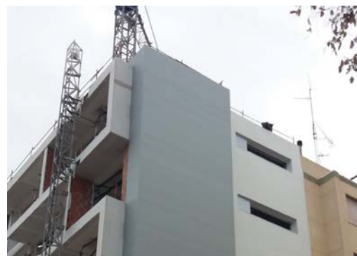
Fachada ventilada con acabado de plancha de aluminio.
