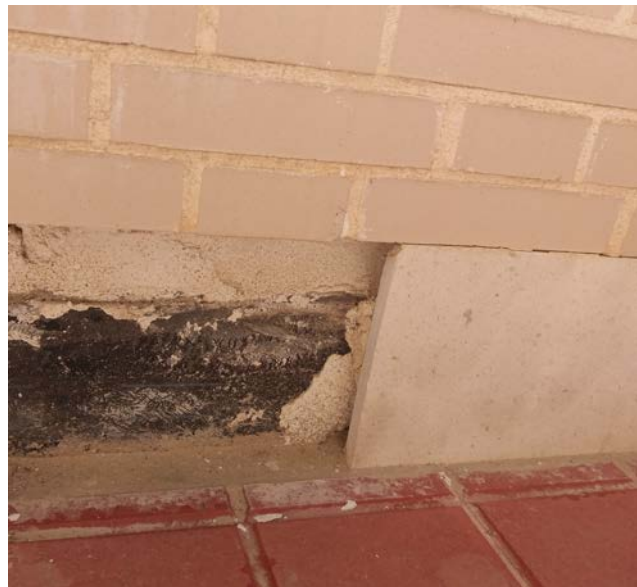
Prolongación de lámina impermeable 15 cm sobre rasante y protección con zócalo aproximadamente una altura igual o superior a 30 cm.
