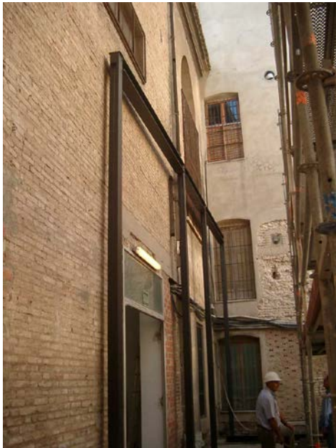
Estructura auxiliar para independizar la impostación del patio del palacio del Embajador Vich en el Museo de Bellas Artes San Pío V de Valencia del propio edificio.
