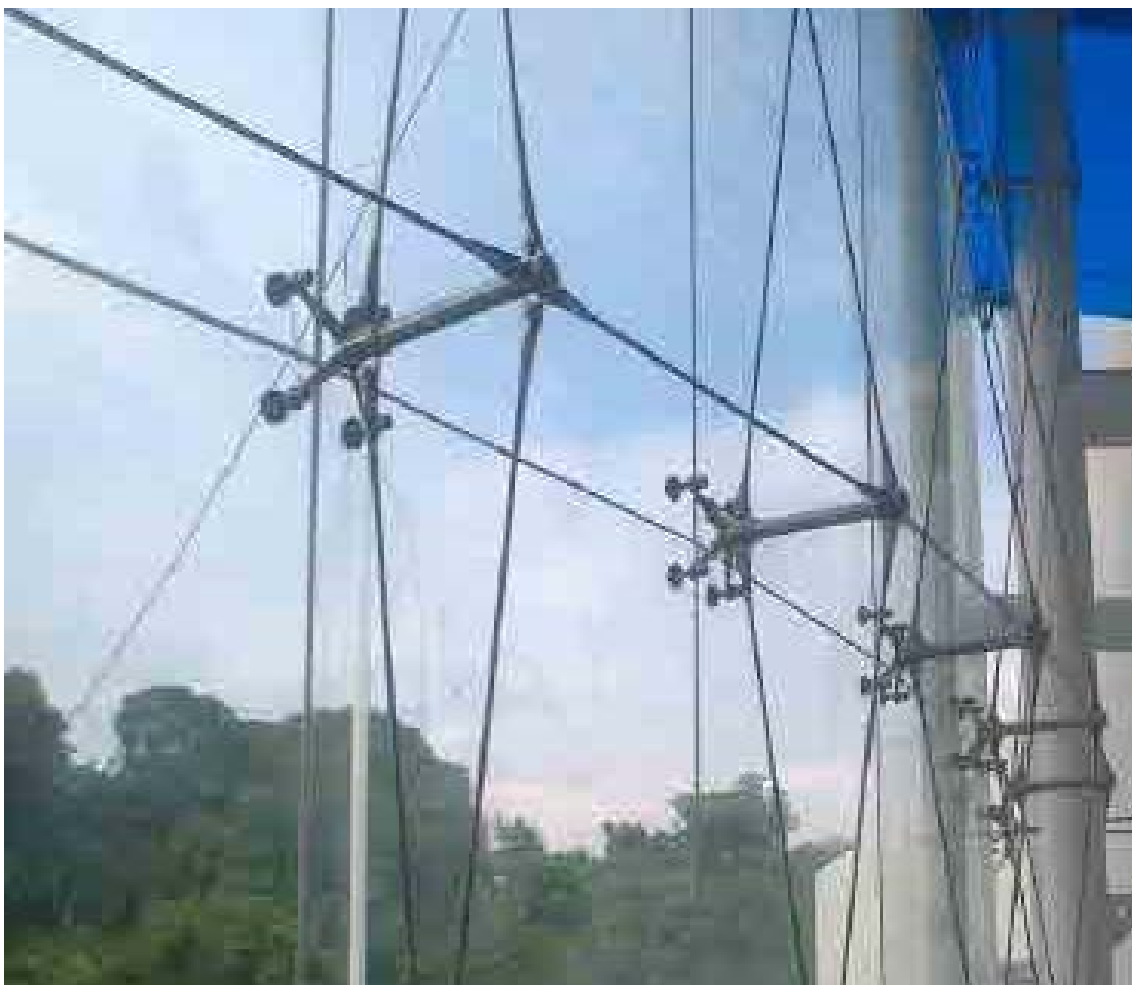
Muro cortina con sistema de arañas y tensores metálicos. Fuente: < www.docplayer.es > [Consulta: 21 de septiembre de 2020].
