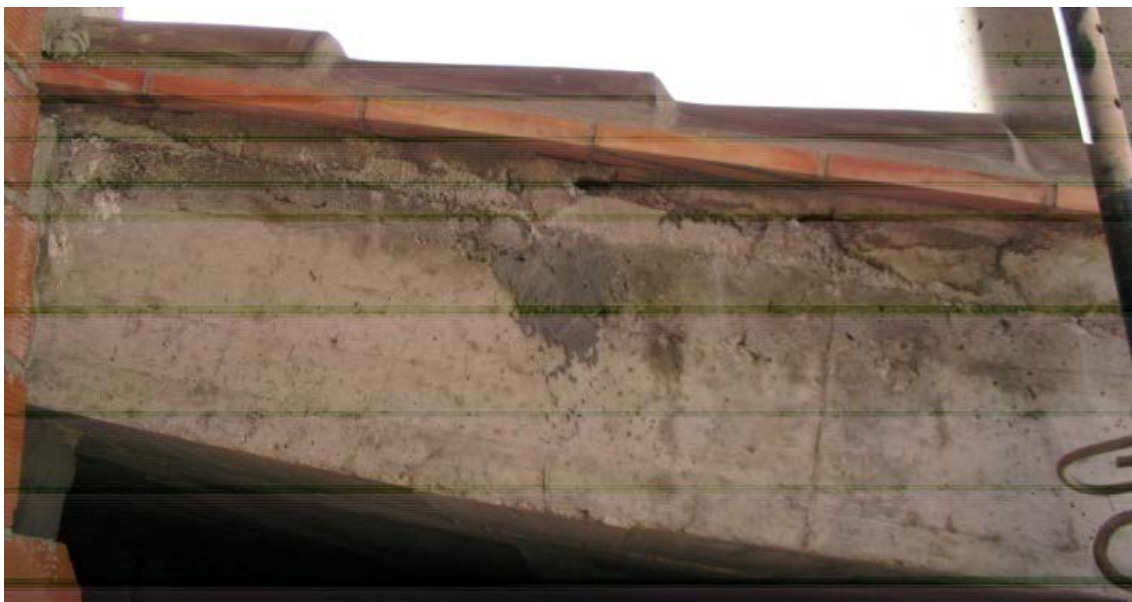
Cubierta inclinada sobre forjado inclinado.
