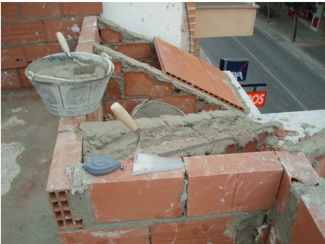
Remate de los tabiques palomeros con capa de mortero de cemento de regulación.
