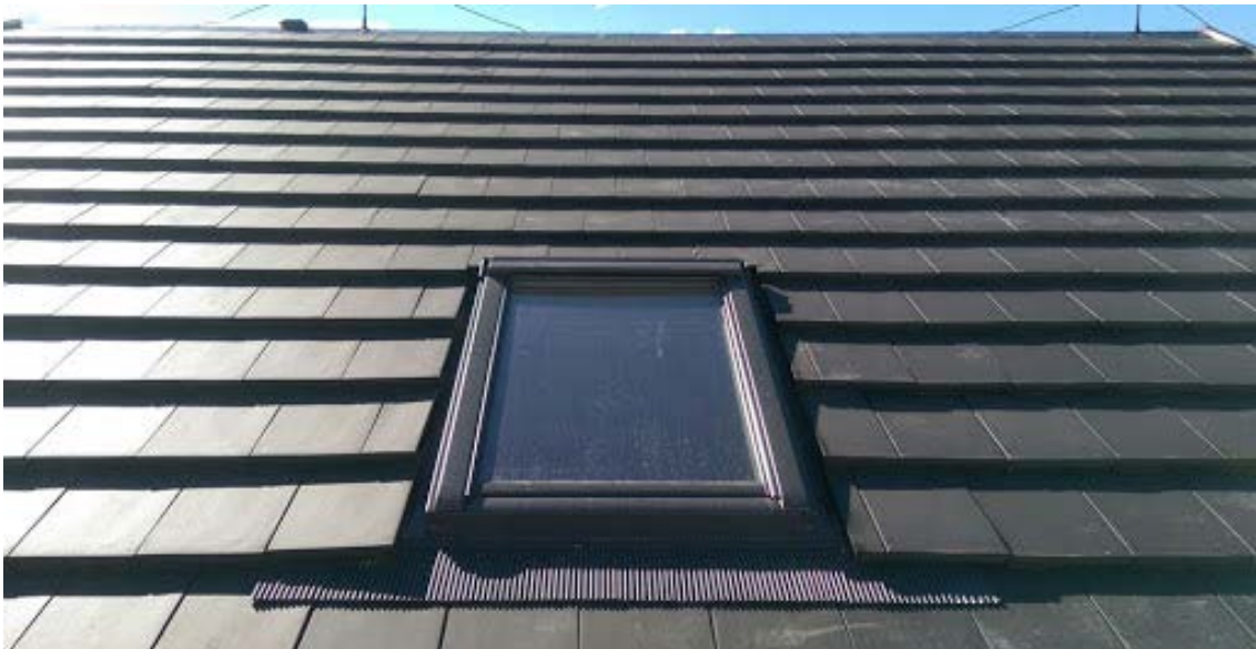
Lucernario en cubierta inclinada. Fuente: < www.ricajamisa.es > [Consulta: 9 de septiembre de 2020].
