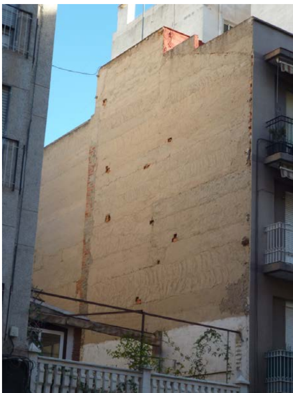
Medianeras con deficiencias y lesiones en su acabado continuo.
