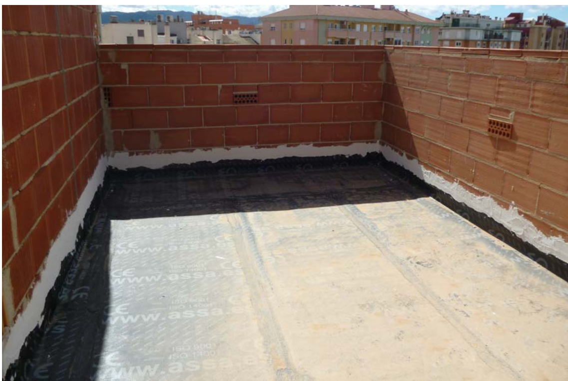
Solapen se lámina bituminosa adherida en cubierta plana.
