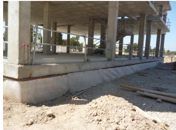
Drenaje de muro de sótano con lámina nodular con geotextil incorporado en la cara exterior en contacto con el terreno.
