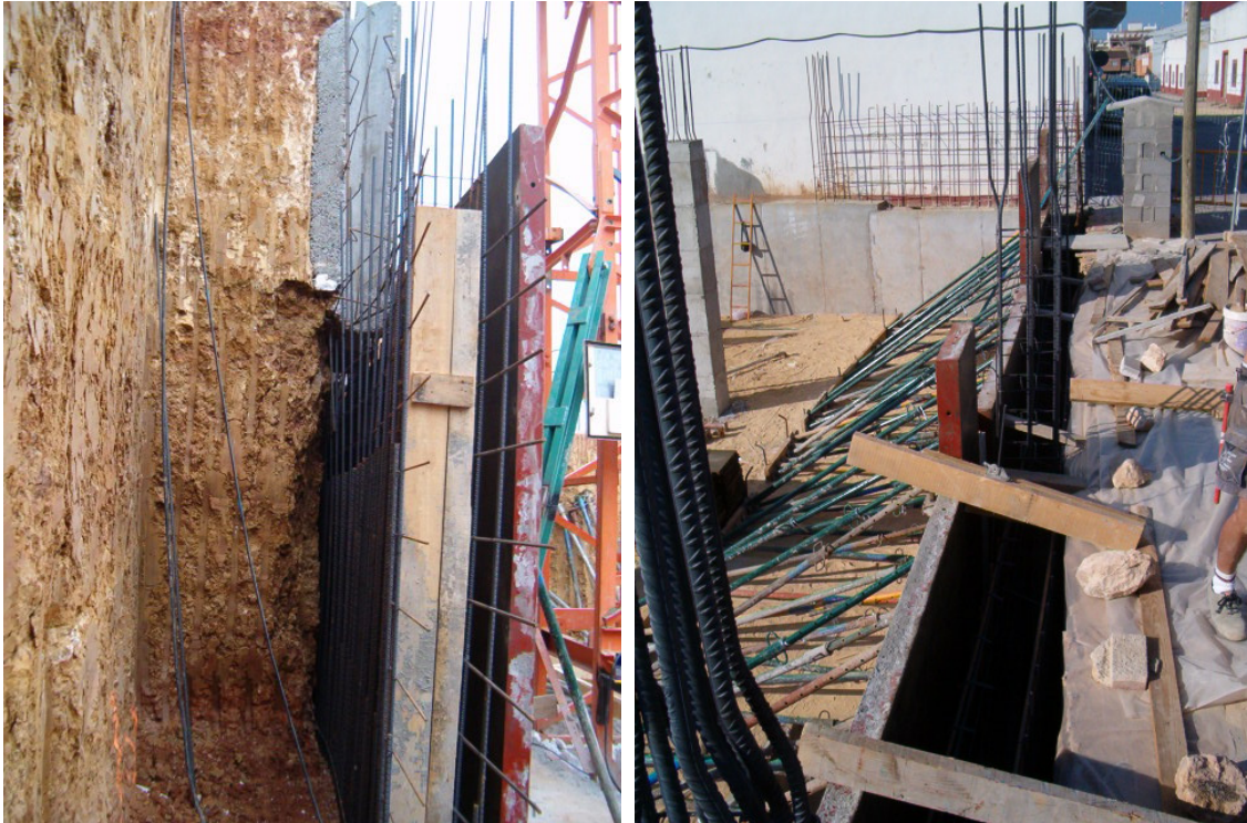
Encofrado del muro y apuntalamiento del mismo durante el proceso de vertido y de fraguado y endurecimiento del hormigón.
