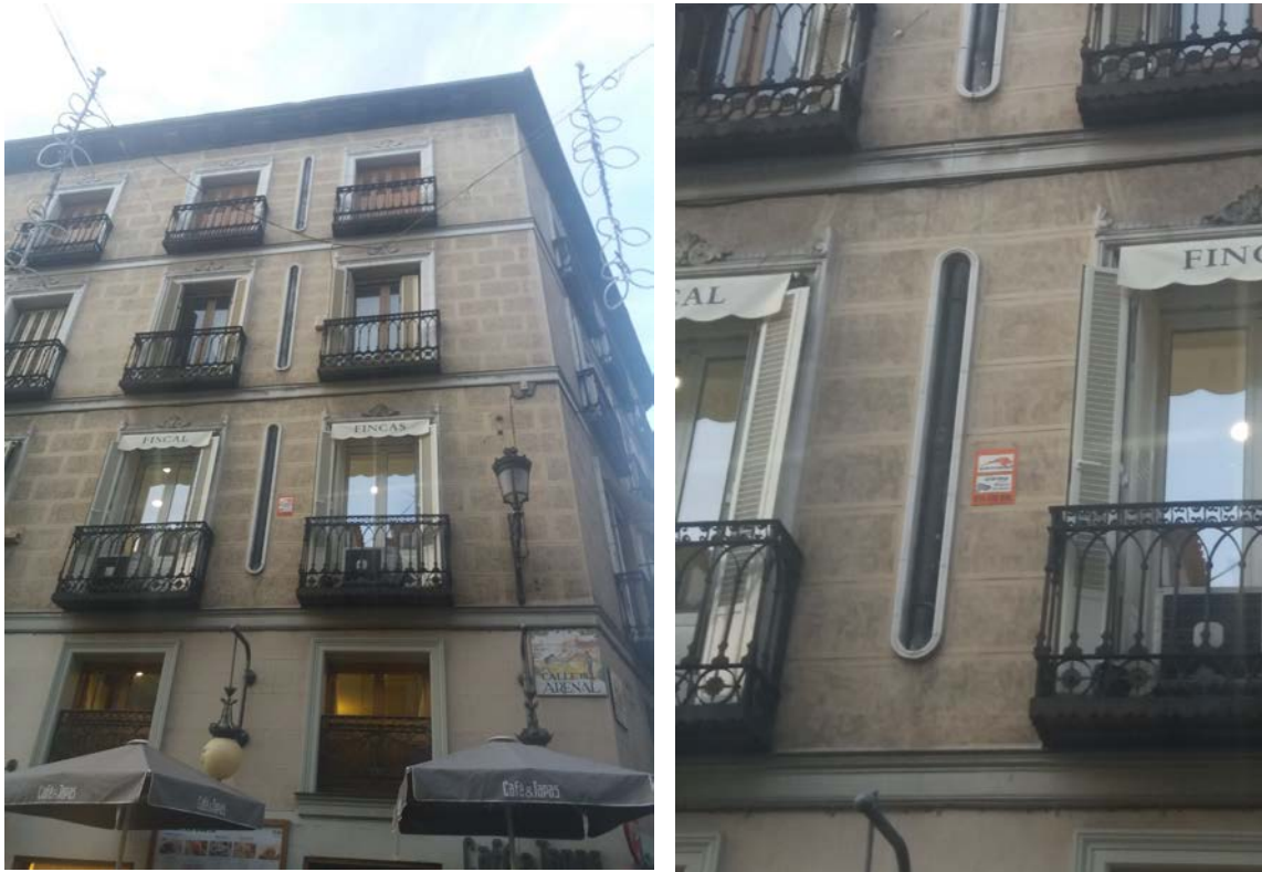
Integración de las bajantes en la fachada de un edificio decimonónico de Madrid.
