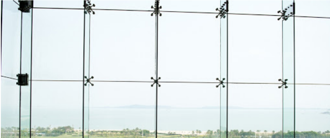
Muro cortina con sistema de arañas y costillas de vidrio. Fuente: < www.cosmoglasssolution.com > [Consulta: 21 de septiembre de 2020].
