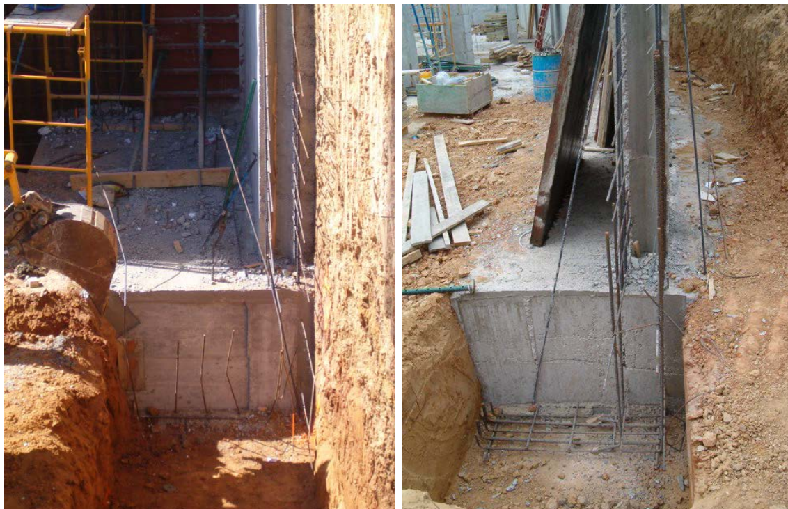
Excavación de la zanja contigua y disposición de la nueva parrilla de armaduras del cemento.
