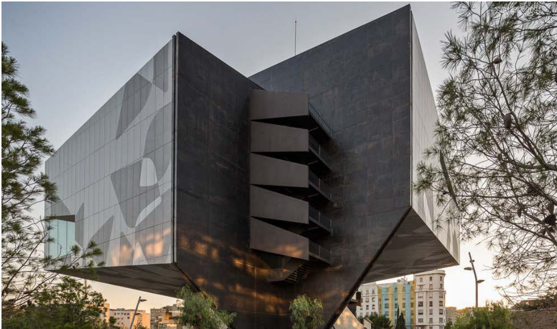
Escalera de incendios del Caixaforum de Zaragoza, Carne Pinós. Fuente: < www.arqfoto.com > [Consulta: 9 de septiembre de 2020].
