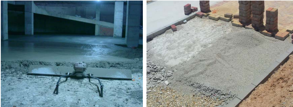
(Izda.) Solera en sótano interior con acabado visto. (Dcha.) Solera base de un pavimento exterior.
