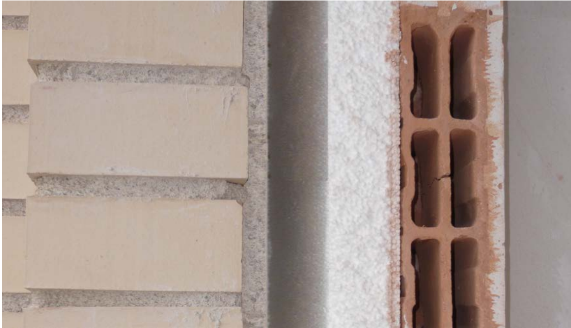
Cámara de aire en fachada capuchina.
