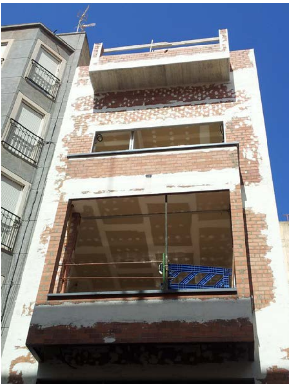
Disposición de malla de fibra de vidrio embebida en el revestimiento continuo en todos los frentes de la estructura, forjados y pilares.
