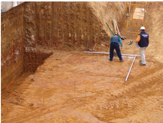
Excavación de la zanja, limpieza, refinado y vertido del hormigón de limpieza.
