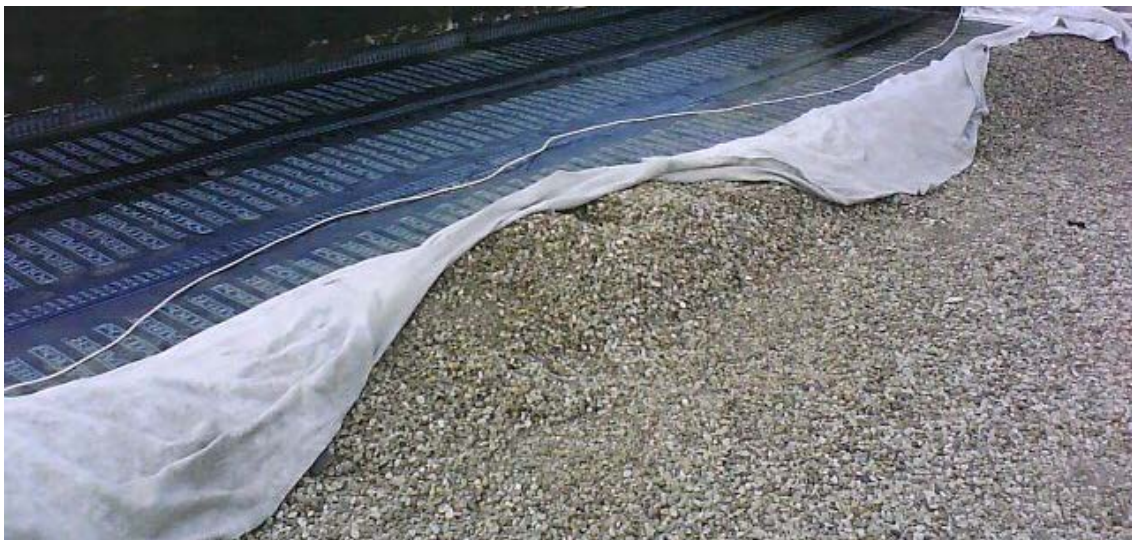
Cubierta no transitable con acabado de grava. Fuente: <www.impaparicio.com> [Consulta: 11 de mayo de 2018].
