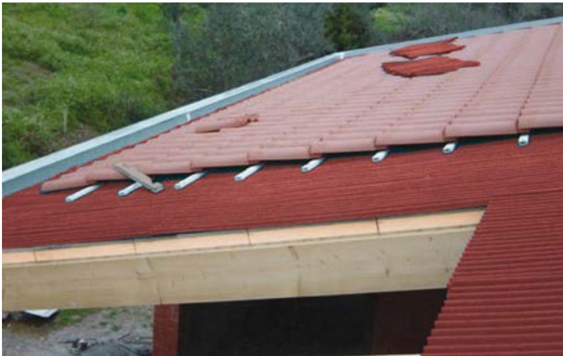
Impermeabilización de cubierta con placas impermeabilizantes bajo teja (Onduline). Fuente: < teycubermadera.com > [Consulta: 20 de mayo de 2018].
