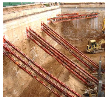
Apuntalamiento contra el fondo de la excavación. Dibujos basados en el CTE DB SE-C-75. Fuente: <www.hotfrog.es> [Consulta: 4 de febrero de 2014].
