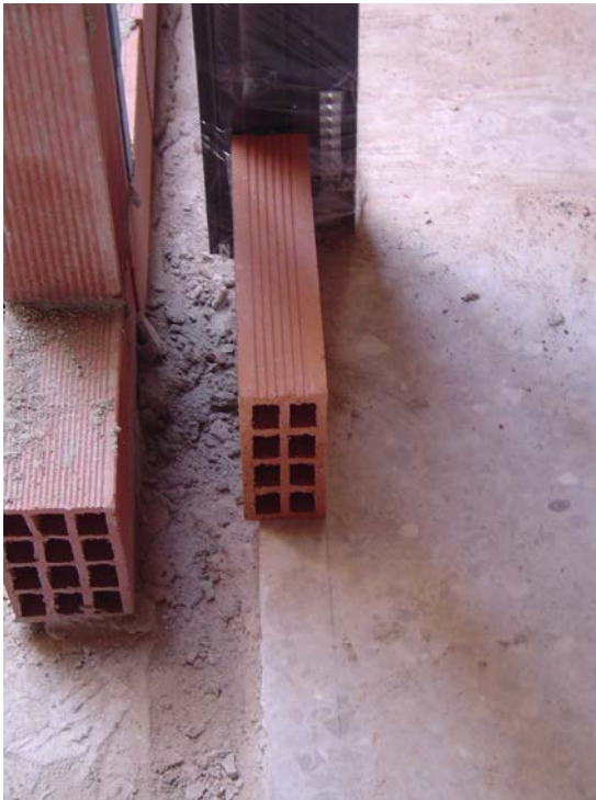
Hoja exterior de fachada interior de fábrica de ladrillo cerámico triple hueco para revestir.
