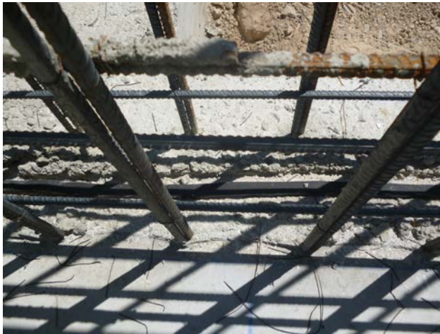
Disposición de cordón de bentonita de sodio en el encuentro del muro con la zapata.
