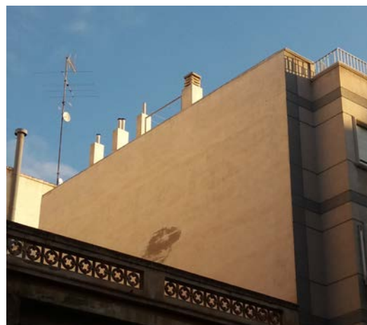
Medianeras con deficiencias y lesiones en su acabado continuo.
