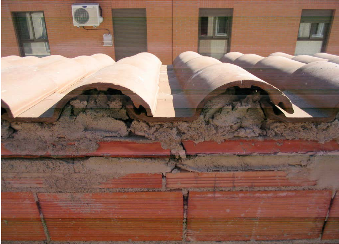
Protección de cubierta inclinada con teja cerámica mixta.
