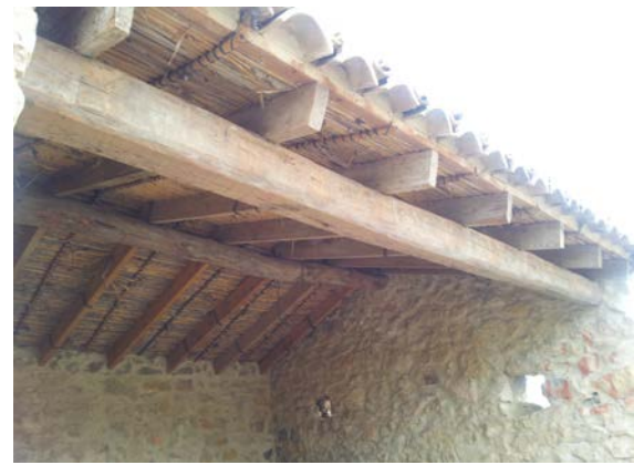
Cubierta inclinada sobre pares de madera.
