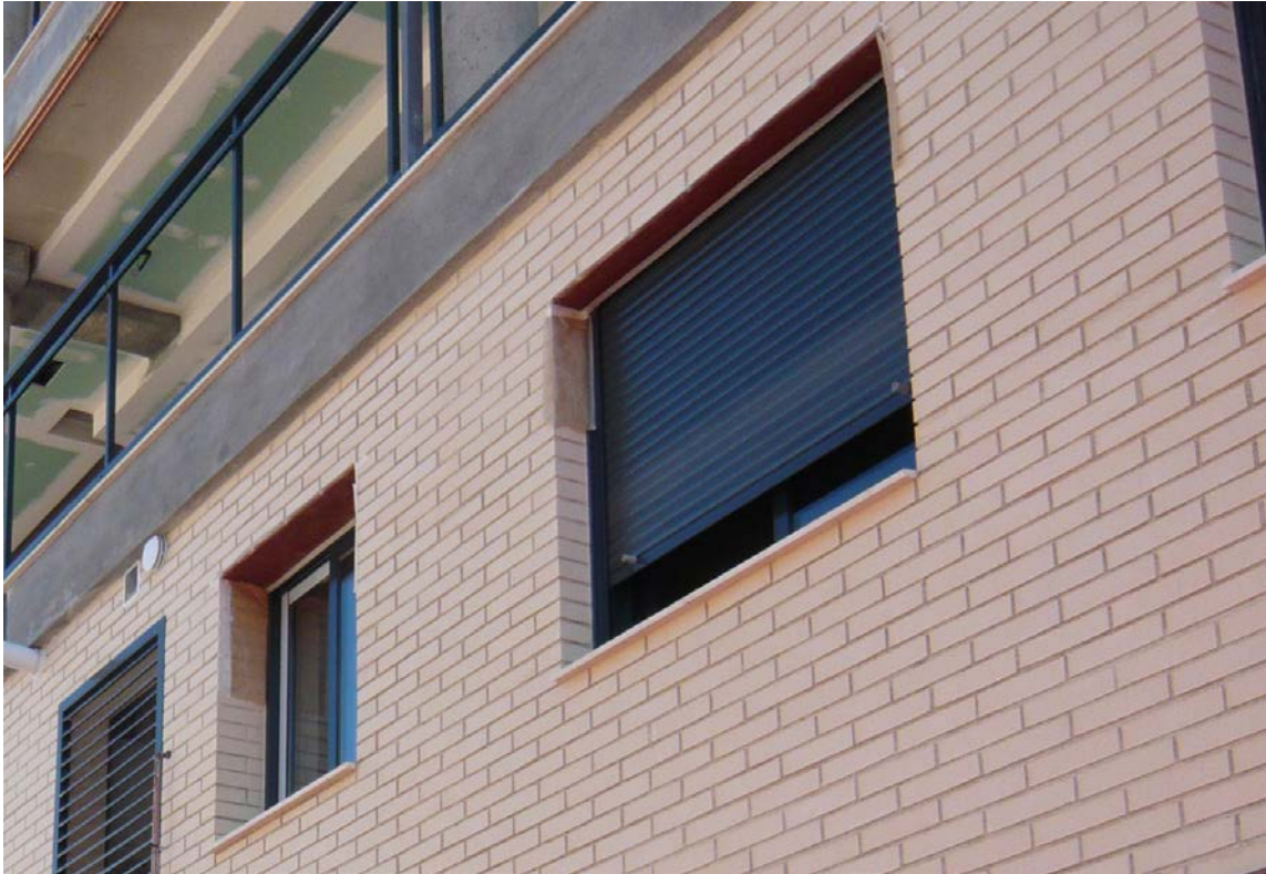
Fachada de ladrillo caravista con dinteles metálicos.
