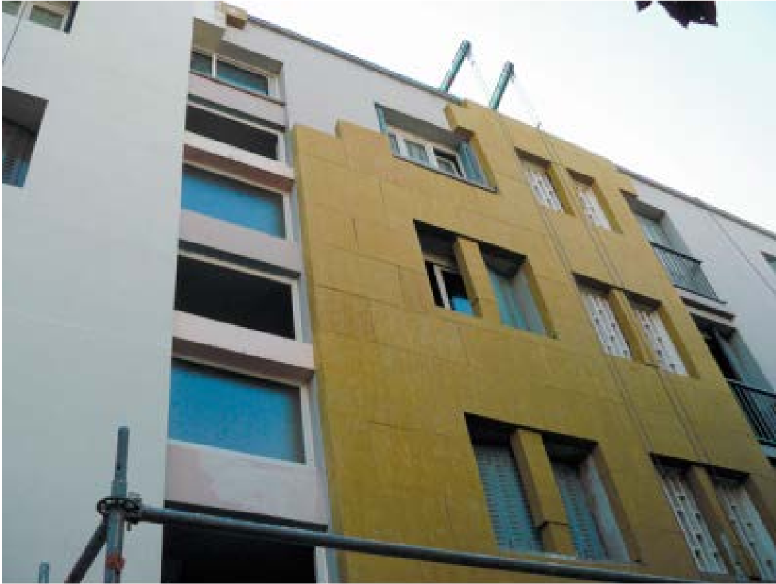
Paneles de lana de roca para fachada con sistema SATE. Fuente: <www.isover.es> [20 de junio de 2020].
