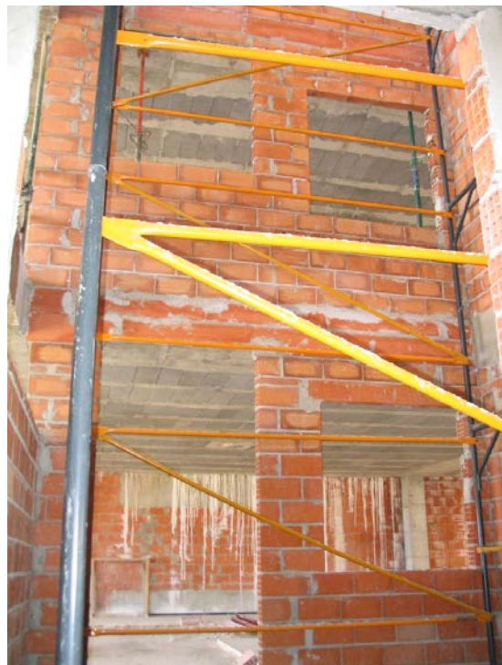
Hoja exterior de fachada interior de fábrica de ladrillo cerámico triple hueco para revestir.
