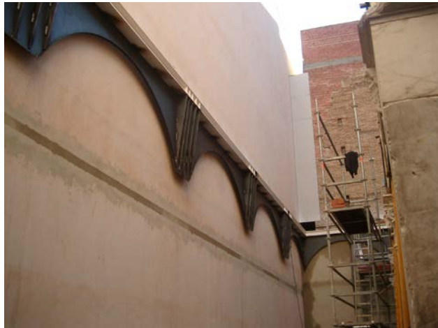
Estructura auxiliar para independizar la impostación del patio del palacio del Embajador Vich en el Museo de Bellas Artes San Pío V de Valencia del propio edificio.
