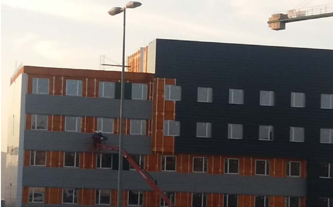
Fachada ventilada con aislamiento termoacústico proyectado, espuma de poliuretano.
