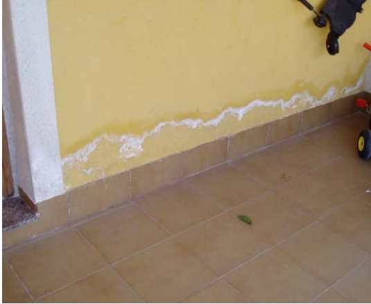
Lesiones en la edificación debidas al agua en estado líquido.
