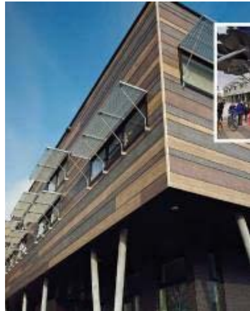
Sistema REDAir Woods de fachada ventilada con montantes de madera. Fuente: < www.rockwool.es > [Consulta: 21 de septiembre de 2020].
