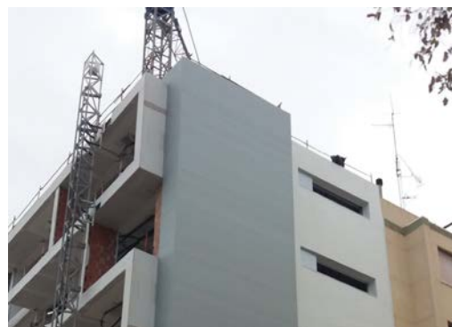
Fachada ventilada con acabado de plancha de aluminio.
