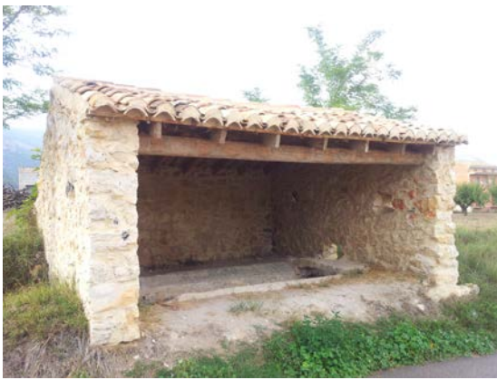
Cubierta inclinada sobre pares de madera.
