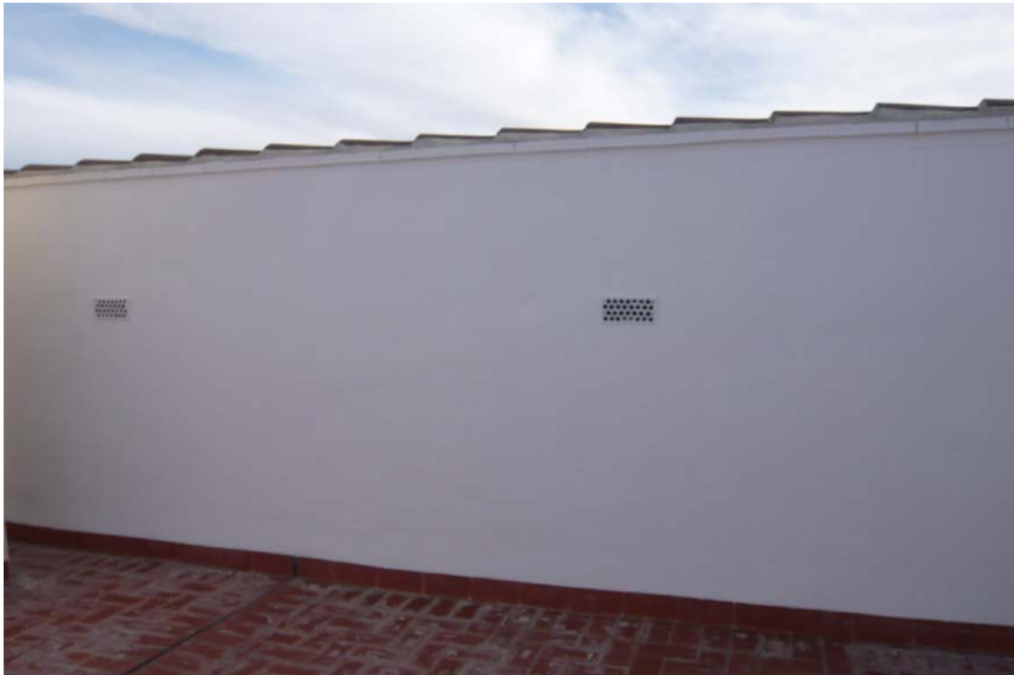
Aberturas de ventilación de la cámara de aire en muro de apoyo del tablero de cubierta.
