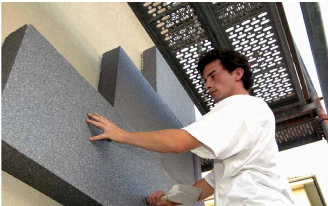
Paneles de EPS-G para fachada con sistema SATE. Fuente: < www.poraxa.com > [20 de junio de 2020].
