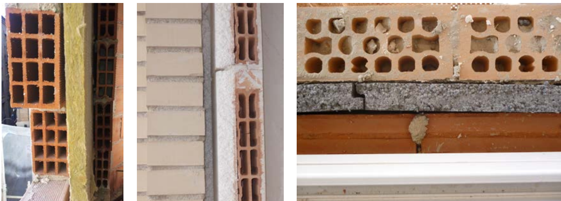
Aislamiento térmico de lana de roca, poliestireno expandido y poliestireno expandido de grafito, en fachada capuchina tradicional.
