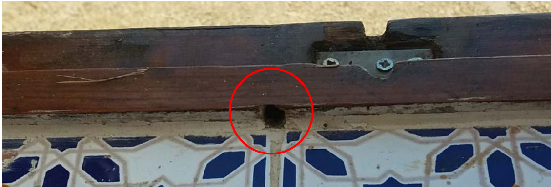
Orificios de salida del agua de lluvia infiltrada.
