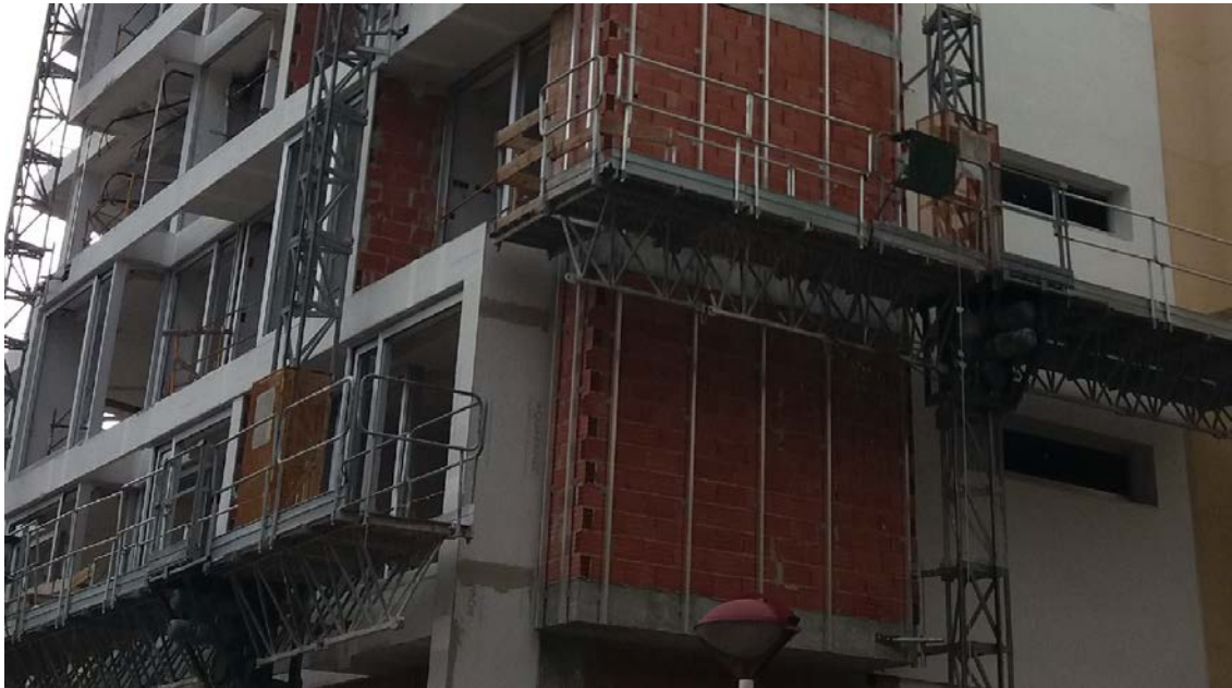
Montantes fachada ventilada.
