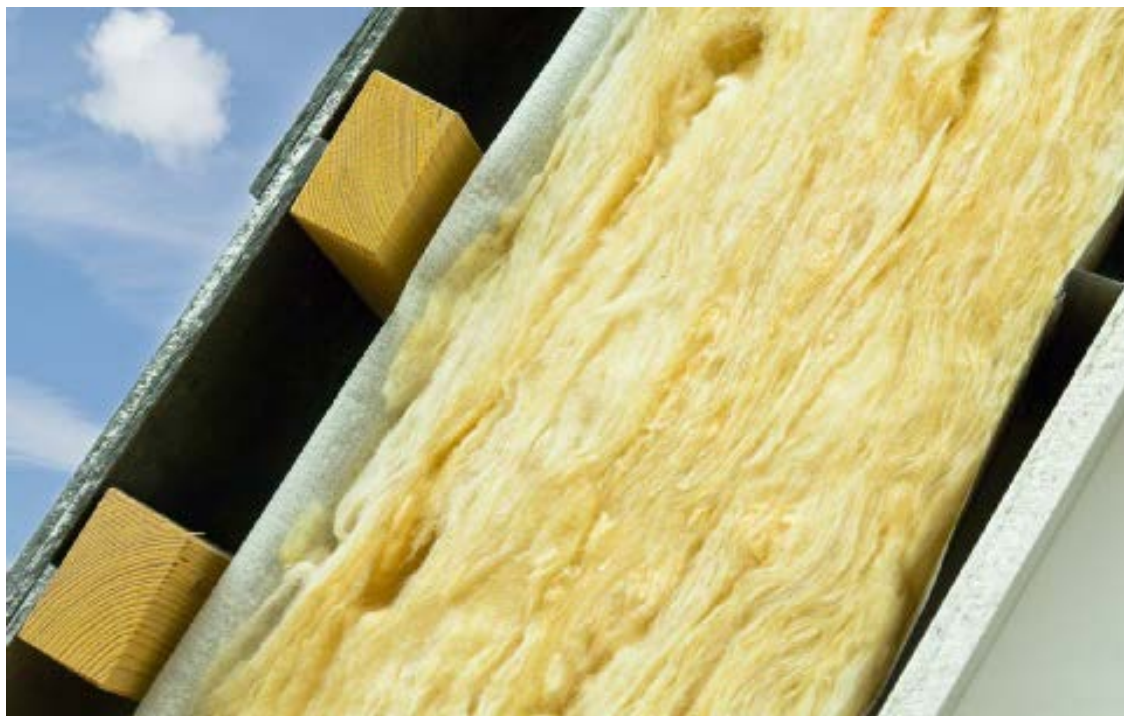
Aislamiento cubierta inclinada con mantas de fibra de vidrio. Fuente: <Ecogreenhome> [Consulta: 20 de mayo de 2018].
