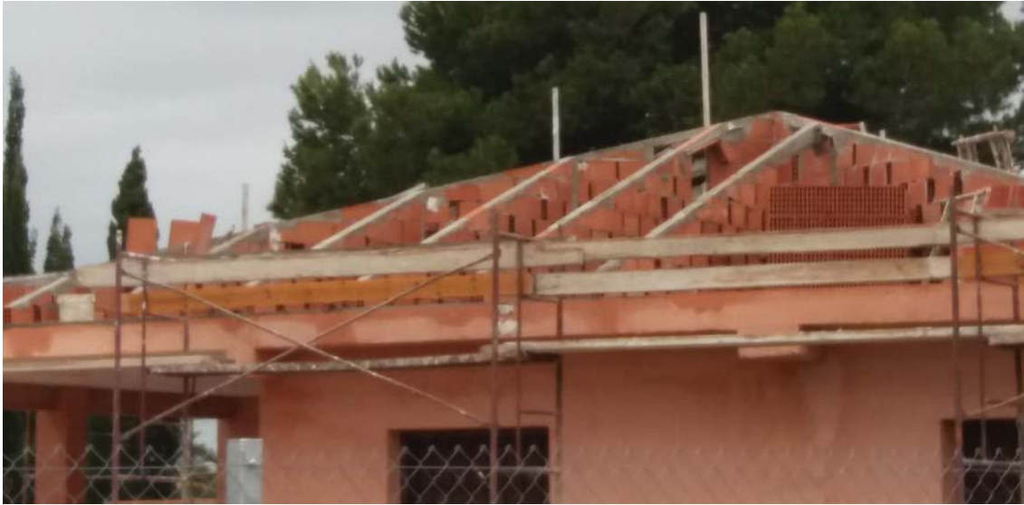
Formación de pendientes con tabiques palomeros de ladrillo cerámico hueco.
