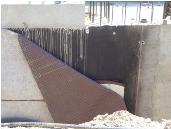
Drenaje de muro de sótano con lámina nodular con geotextil incorporado en la cara exterior en contacto con el terreno.
