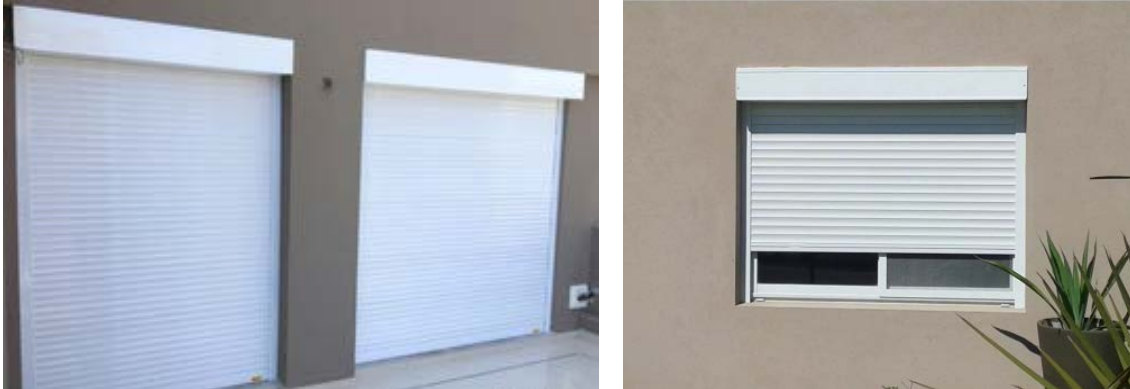
Cajón de persiana exterior. Fuente: < www.listado.mercadolibre.com.ar > < www.mosquiterasbaratas.com > [Consulta: 9 de septiembre de 2020].
