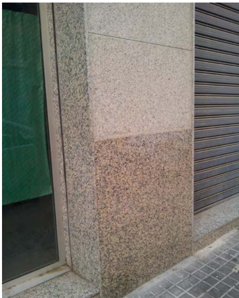
Prolongación de lámina impermeable 15 cm sobre rasante y protección con zócalo aproximadamente una altura igual o superior a 30 cm.
