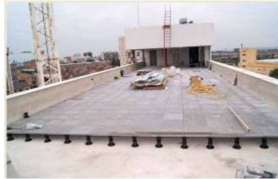
Esquema de ejecución de una cubierta con solado flotante sobre plots. Fuente: < www.texsa.es > y < www.profesionales.todoconstruccion.com > [Consulta: 3 de febrero de 2016].
