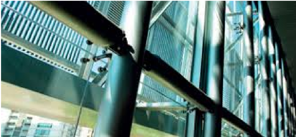
Sistema araña de perfilería metálica. Fuente: < www.glasstech.cl > [Consulta: 21 de septiembre de 2020].
