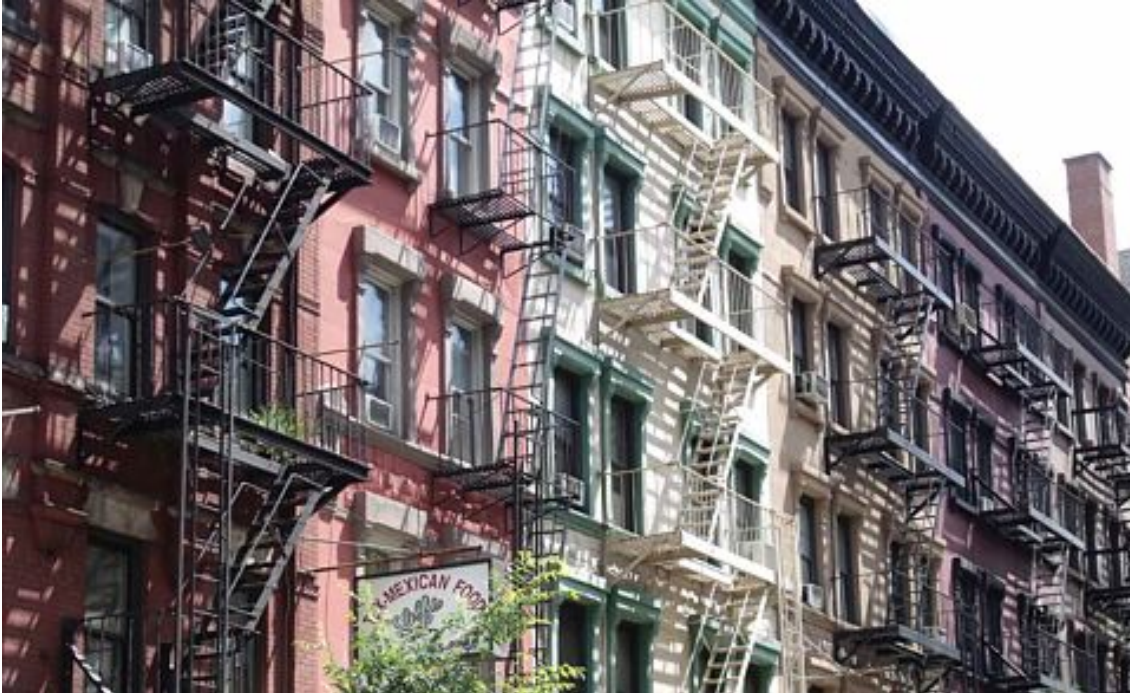
Escaleras de incendios en Nueva York. Fuente: < https://www.revistabuenviaje.com > [Consulta: 9 de septiembre de 2020].
