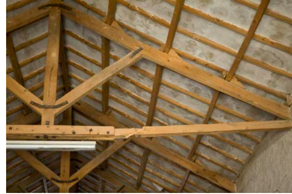
Cubierta inclinada sobre correas apoyadas sobre cerchas.
