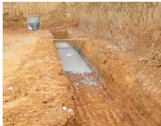
Excavación de la zanja, limpieza, refinado y vertido del hormigón de limpieza.
