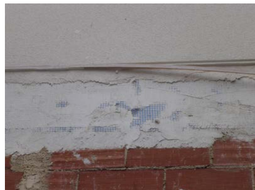
Disposición de malla de fibra de vidrio embebida en el revestimiento continuo en todos los frentes de la estructura, forjados y pilares.
