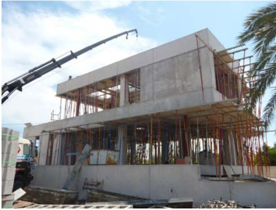
Hoja exterior del cerramiento de hormigón visto ejecutado in situ.
