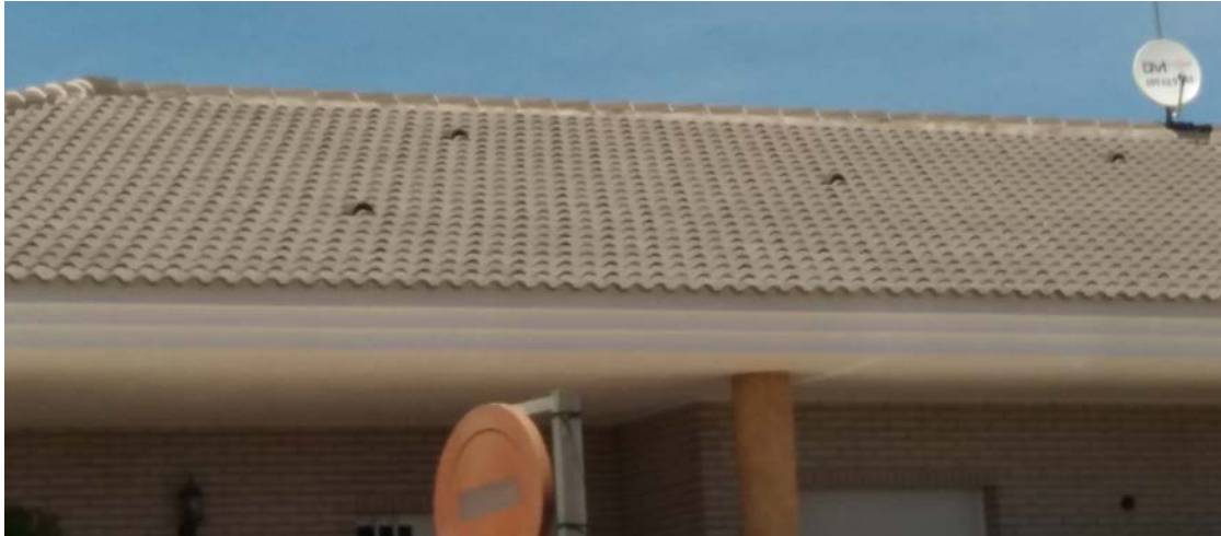
Faldón de cubierta inclinada con tejas ventiladoras repartidas en la superficie.
