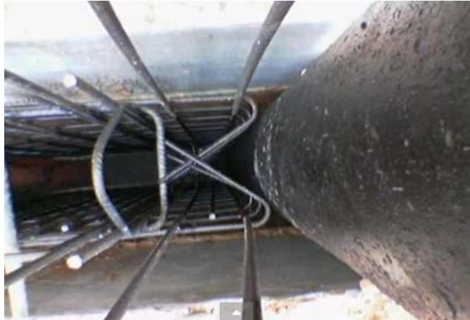
Disposición de los encofrados laterales. Fuente: < http://procedimientosconstruccion.blogs.upv.es > [Consulta: 4 de febrero de 2014].
