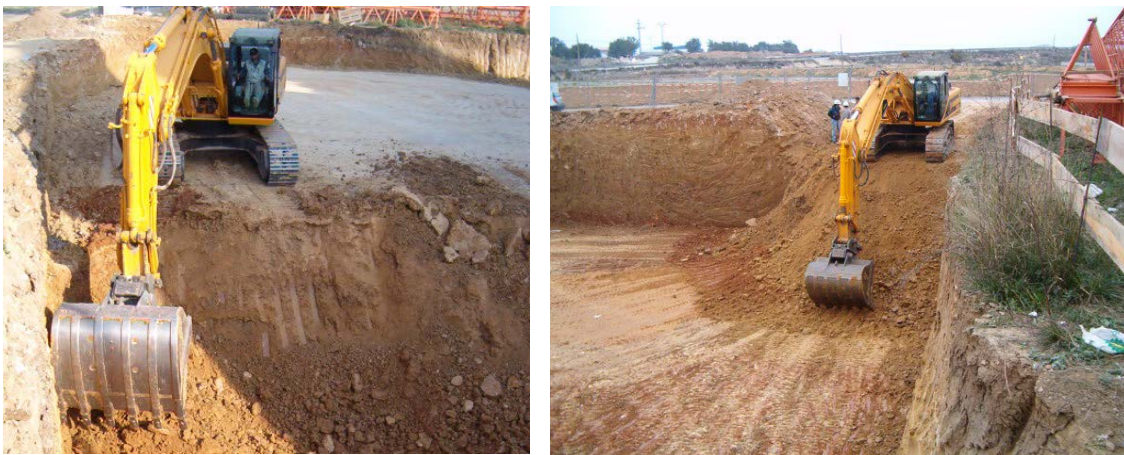
Vaciado de gran profundidad por franjas horizontales. Habilitación de rampas de acceso al tajo.
