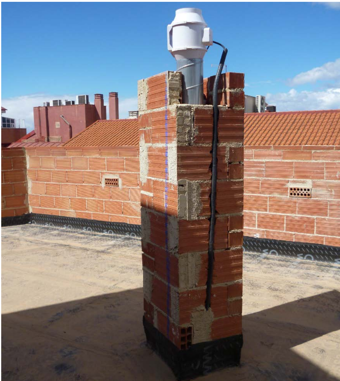
Remate de la lámina impermeable de cubierta en el encuentro con el paramento vertical. Figura 2.13 del CTE DB HS1, pág. HS1-24.
