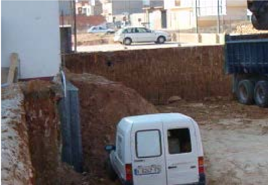
Muros en contacto con el terreno.
