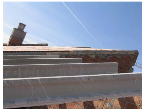
Cubierta inclinada sobre viguetas de hormigón pretensado.
