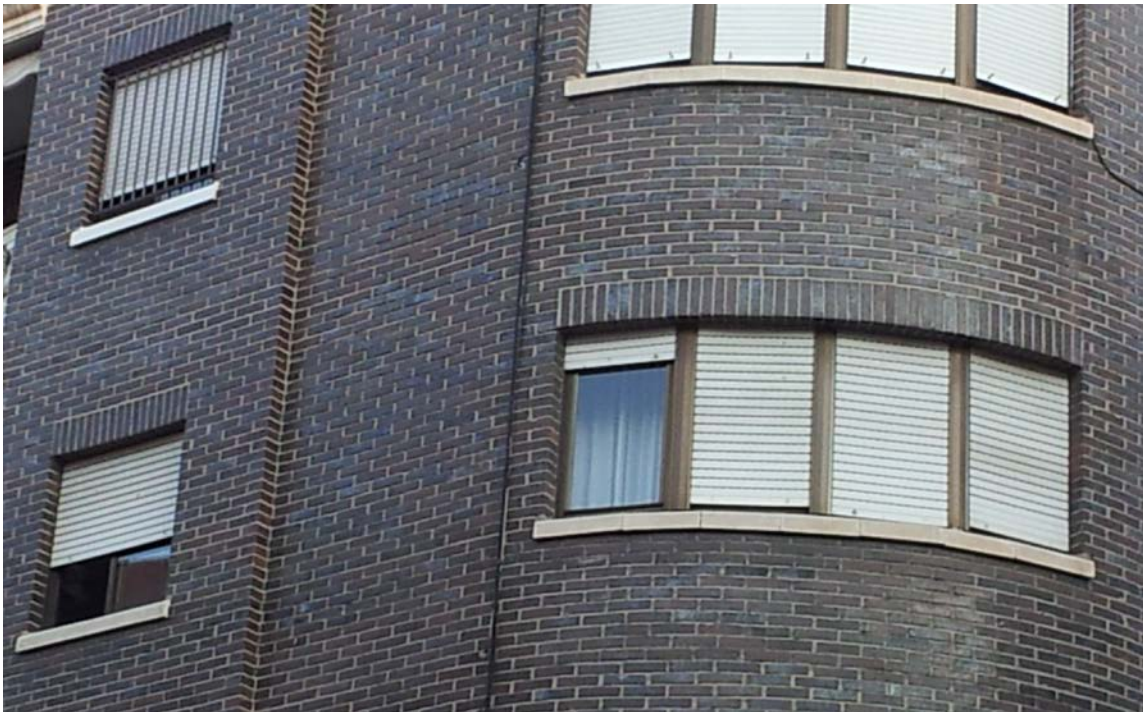
Fachada de ladrillo caravista con dinteles a sardinel vertical.
