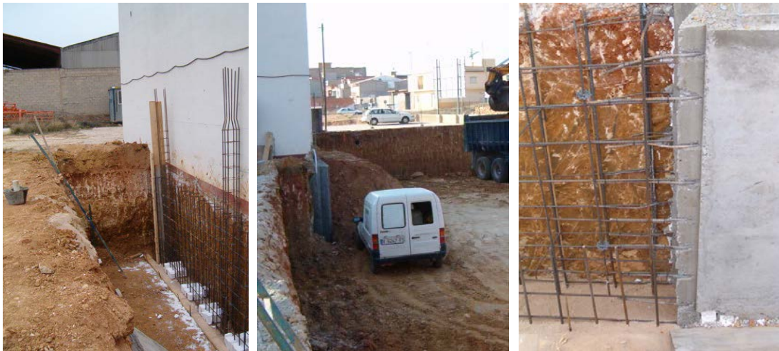
Ejecución del elemento de contención de la medianería (muro de sótano), por bataches. Unión entre las distintas partes del muro.
