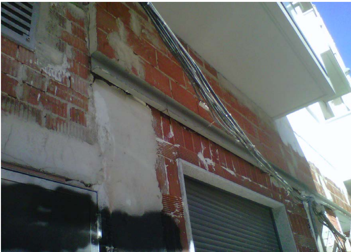
Integración de la caja de instalaciones en obra.
