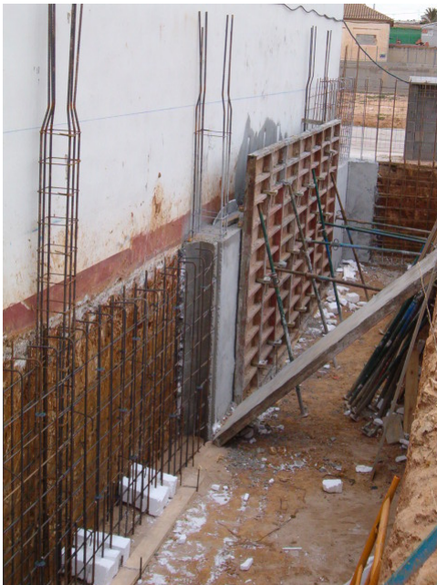
Armaduras en espera del pilar sobresaliendo de la coronación del muro de sótano: disposición enrasada.
