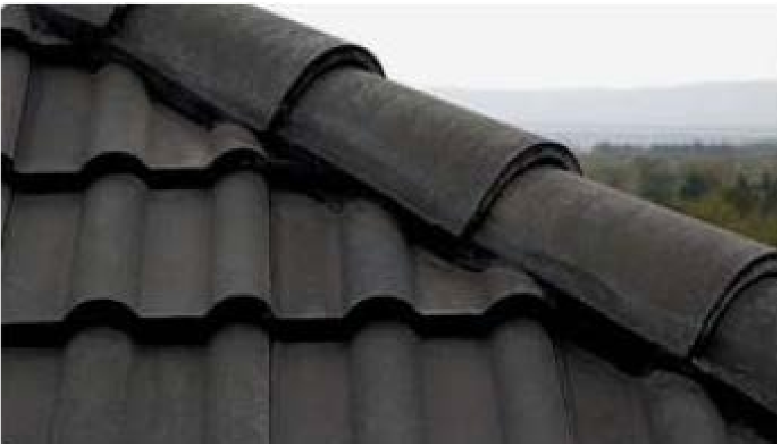
Faldón de cubierta inclinada acabado con teja mixta de hormigón. Fuente: <http://casamanriquesrl.com> [Consulta: 20 de mayo de 2018].
