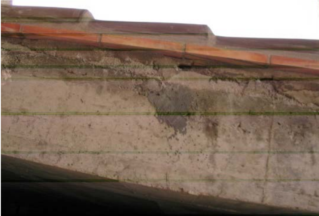
Cubierta inclinada en contacto directo con el aire exterior.
