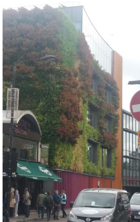
Fachada verde, sistema de hidroponía.
