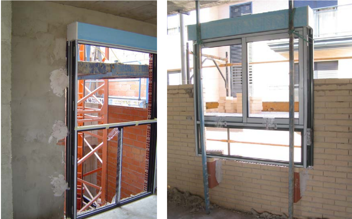
Colocación de carpintería en obra.
