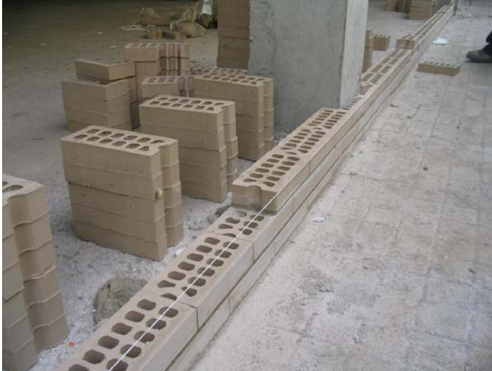
Hoja exterior de fachada de fábrica de ladrillo cerámico perforado caravista.
