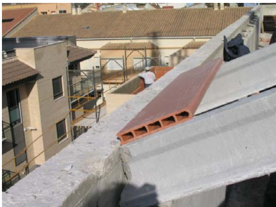
Cubierta inclinada sobre viguetas de hormigón pretensado.
