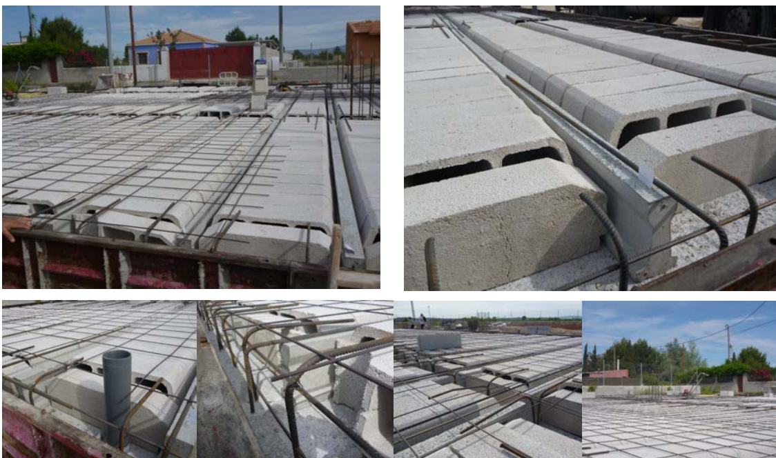
Forjado sanitario sobre muretes de hormigón armado.
