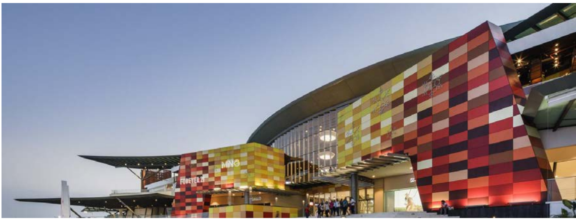
Fachadas resueltas con planchas de celulosa de alta presión. Fuente: < www.trespa.com > [Consulta: 21 de septiembre de 2020].
