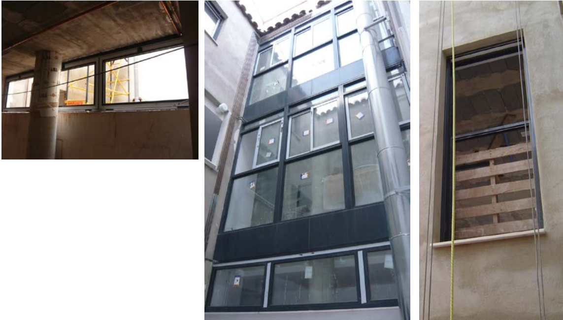
Ventanas con distintos sistemas de abertura.
