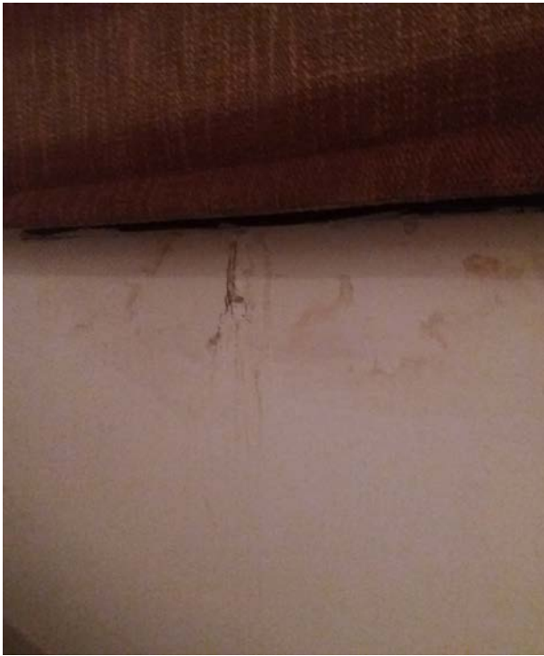
Filtraciones procedentes de ventanas.
