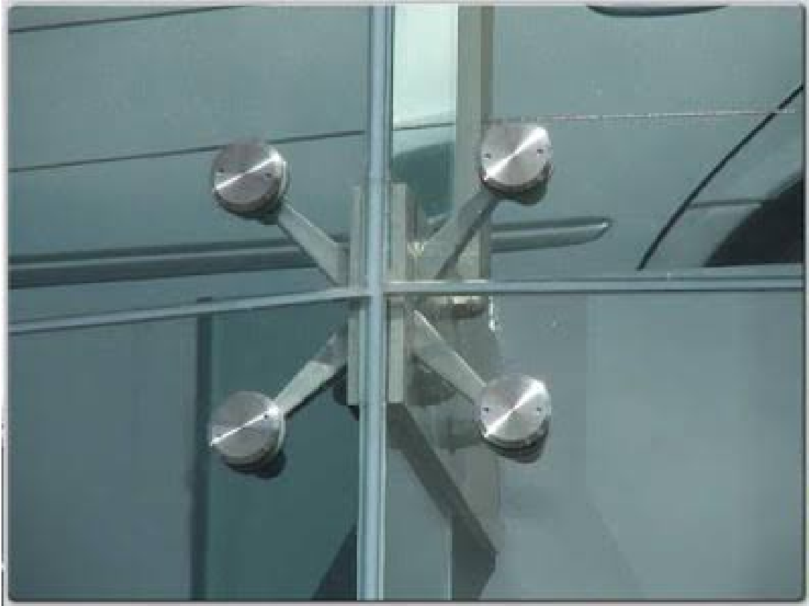
Araña para muro cortina. Fuente: < www.vidrieriamax.com > [Consulta: 21 de septiembre de 2020].
