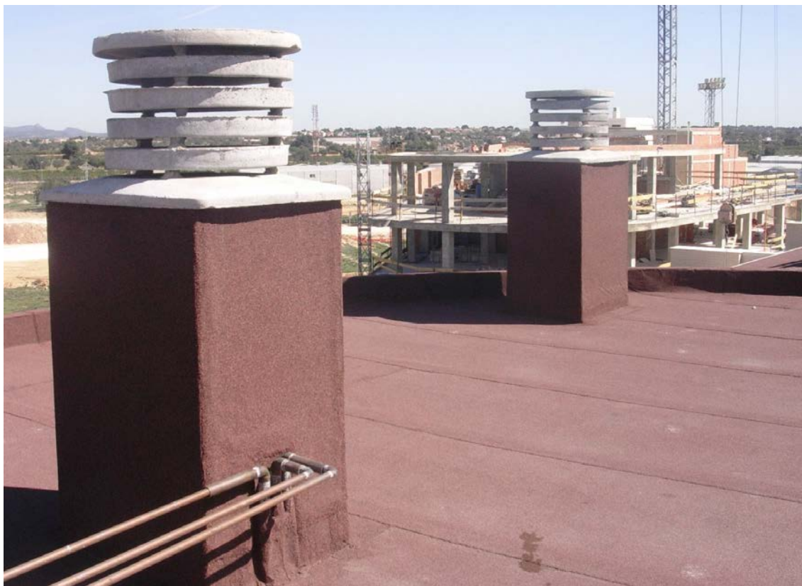
Acabado de cubierta plana con lámina impermeable autoprotégida, no transitable.
