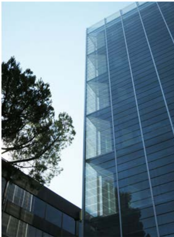
Muro cortina de doble piel y pasarelas de mantenimiento. Fuente: <www.bimobject.com> [Consulta: 21 de septiembre de 2020].
