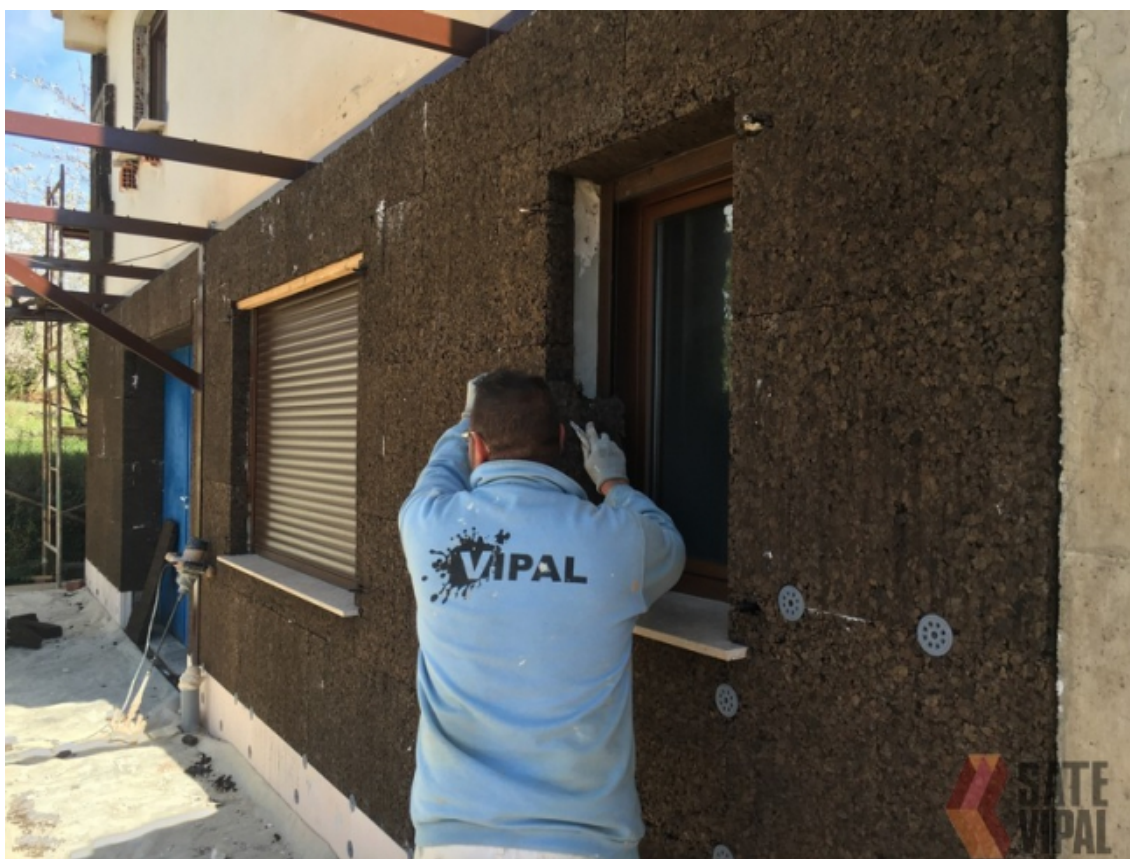
Paneles de corcho natural para fachada con sistema SATE. Fuente: < www.sate-vipal.com > [20 de junio de 2020].
