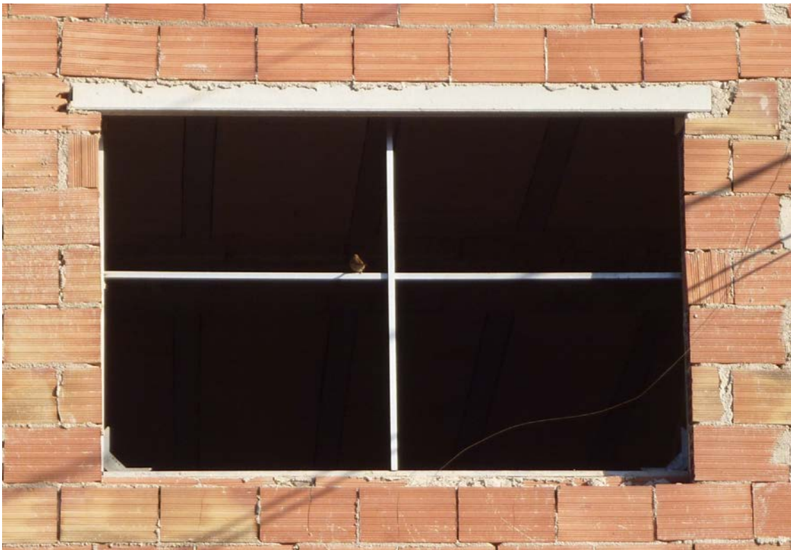
Fachada de ladrillo a revestir con de cargadero de hormigón.
