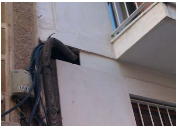
Sujeción del cableado mediante tapa de registro.
