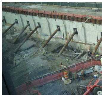
Apuntalamiento contra el fondo de la excavación. Dibujos basados en el CTE DB SE-C-75. Fuente: <www.hotfrog.es> [Consulta: 4 de febrero de 2014].
