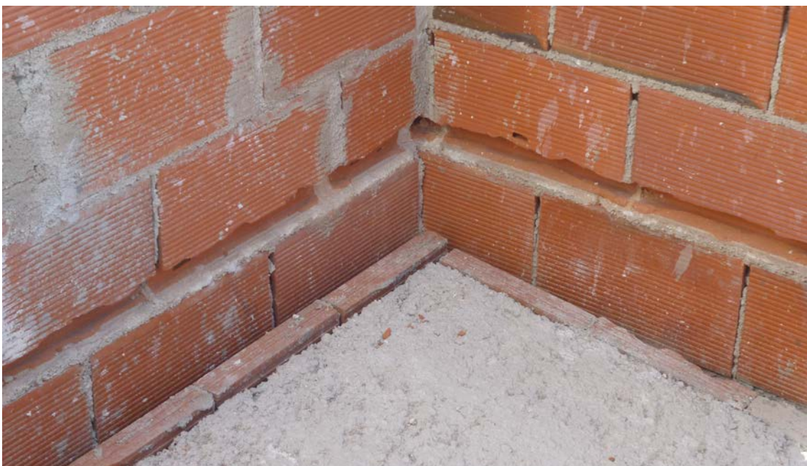
Roza en el antepecho de cubierta para remate de la lámina impermeable.
