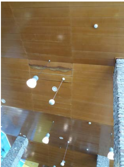
Filtraciones procedentes de la cubierta.
