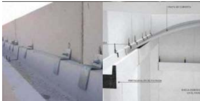
Colocación de paneles verticales. Fuente: <www.tecnyconta.es> [Consulta: 21 de septiembre de 2020].
