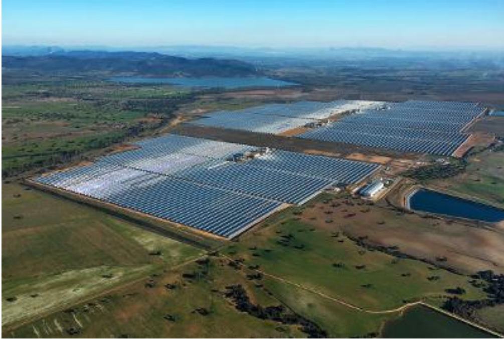
Fig. 1: Planta termosolar Solaben en Extremadura [5]
