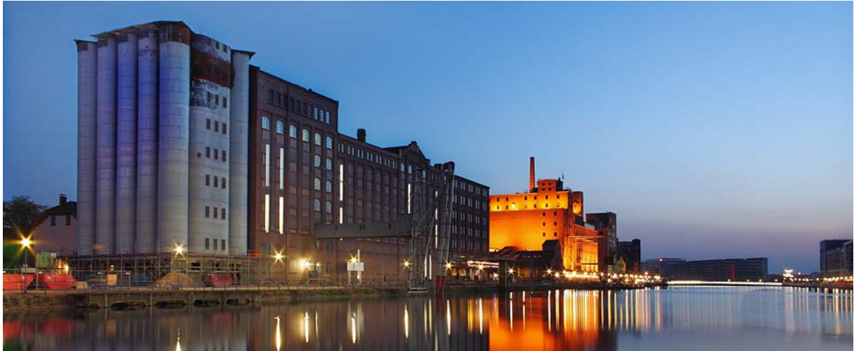
Figura 20. Silke V, Fábrica Küppersmühle en el puerto de Duisburgo (Alemania). Reconversión de Herzog & de Meuron. 25.04.2010 Fuente: http://www.mai-nrw.de/IBA-1999.56.0.html
