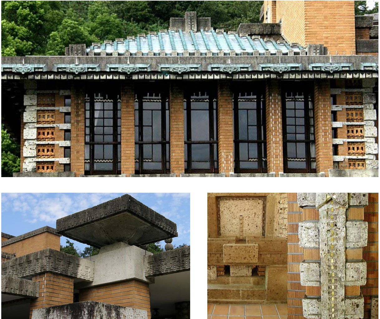
Figura 5. Cubierta, carpintería y detalles fachada.
