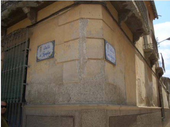
Figuras 15 y 16. Desperfectos en morteros y pinturas en fachadas.
