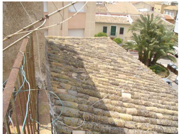
Figuras 5 y 6. Daños y desperfectos en los paños de cubiertas inclinadas.
