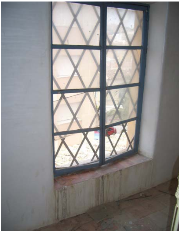
Figuras 11 y 12. Desperfectos en carpinterías y elementos de evacuación de agua.
