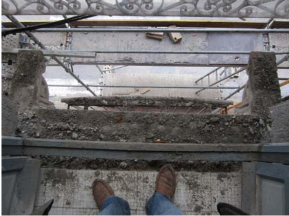
Figura 43. Eliminación tablero original.
