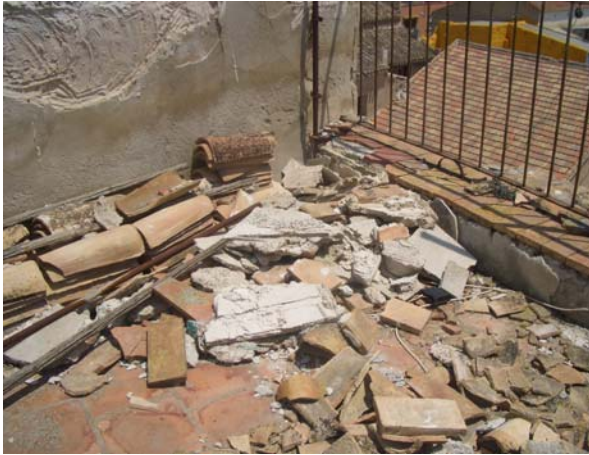
Figuras 9 y 10. Desprendimiento y acumulación de material.
