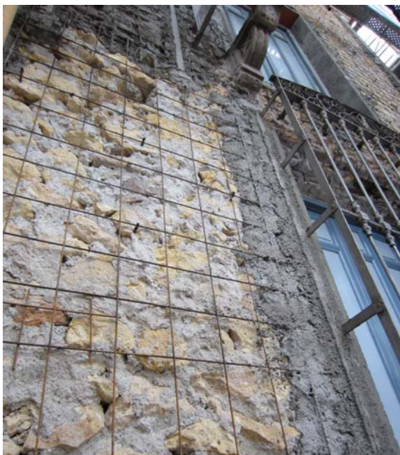
Figuras 37 y 38. Disposición de malla claveteada.
