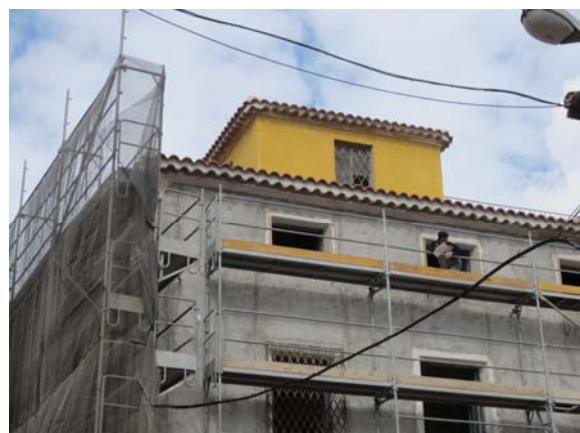
Figura 40. Aplicación mortero monocapa.
