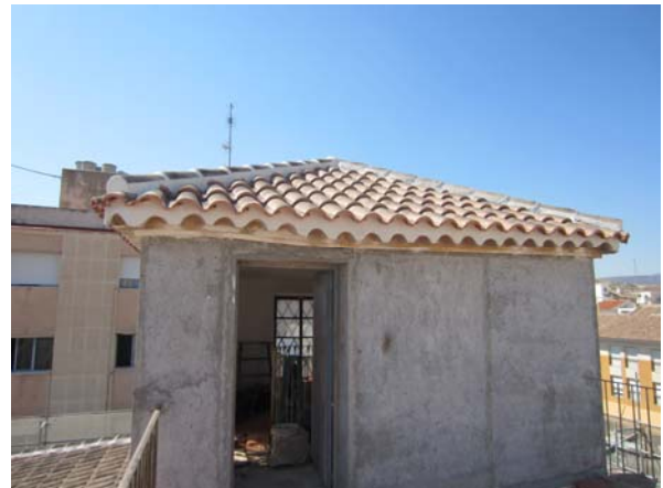
Figuras 31 y 32. Rehabilitación de la terraza y cubierta a cuatro aguas del torreón.
