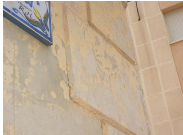
Figuras 13 y 14. Desperfectos en morteros y pinturas en fachadas.
