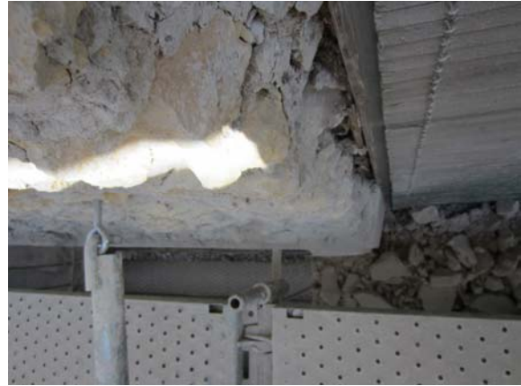
Figuras 35 y 36. Descarnado de los muros de fachada.
