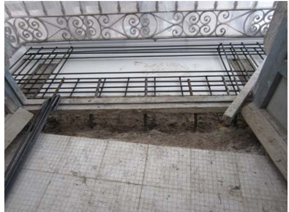
Figuras 45 y 46. Disposición de armadura y anclajes en el muro en patilla.
