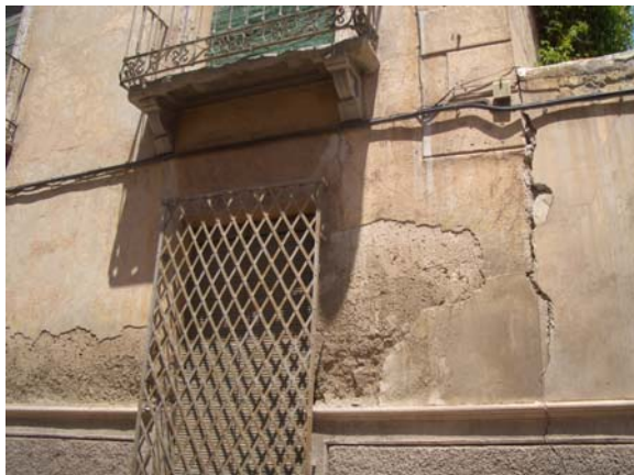
Figuras 13 y 14. Desperfectos en morteros y pinturas en fachadas.
