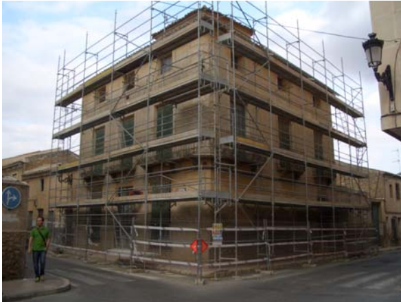
Figuras 23 y 24. Instalación andamiaje previo al comienzo de los trabajos.
