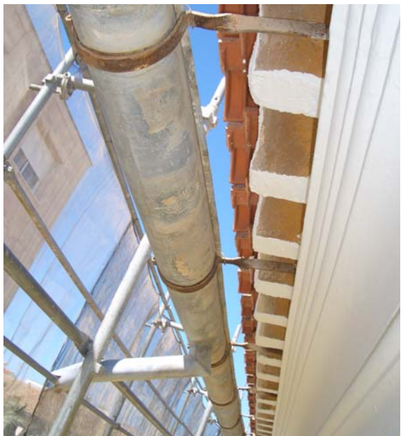
Figuras 33 y 34. Operaciones de reparación de la red de evacuación del agua de lluvia.
