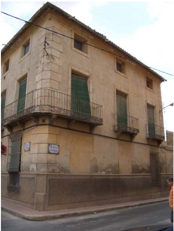
Figuras 17 y 18. Desperfectos en morteros y pinturas en fachadas.
