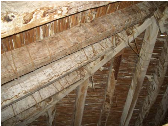
Figuras 25 y 26. Inspección y refuerzo de los elementos portantes.
