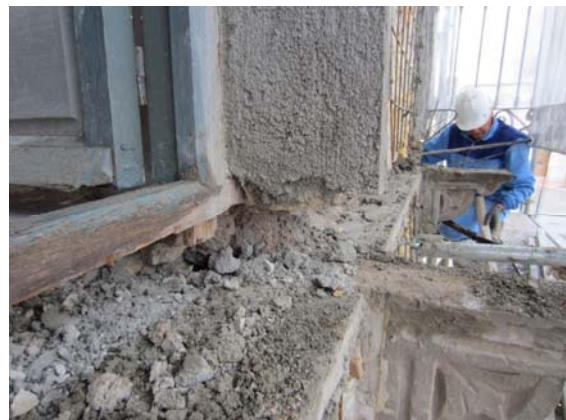
Figuras 41 y 42. Derribo y desmonte de los tableros apoyados en las ménsulas.
