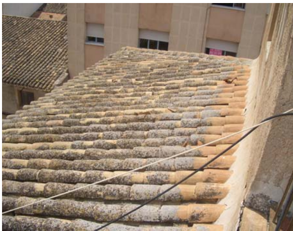
Figuras 5 y 6. Daños y desperfectos en los paños de cubiertas inclinadas.
