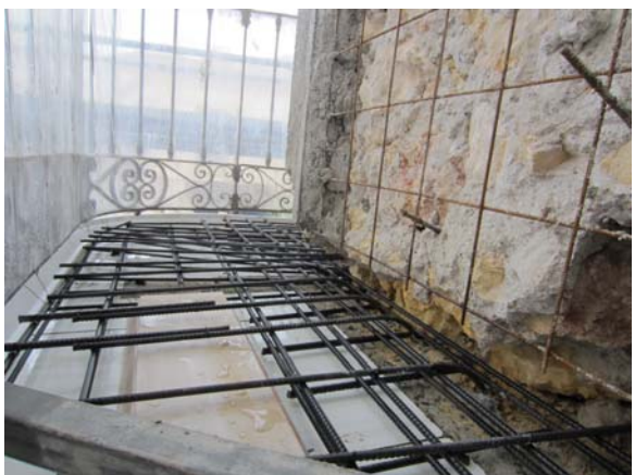
Figura 47. Anclajes de la armadura en el muro.
