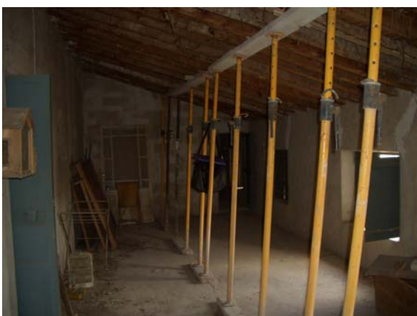
Figuras 27 y 28. Inspección y refuerzo de los elementos portantes.
