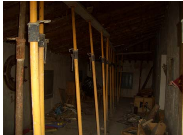
Figuras 25 y 26. Inspección y refuerzo de los elementos portantes.
