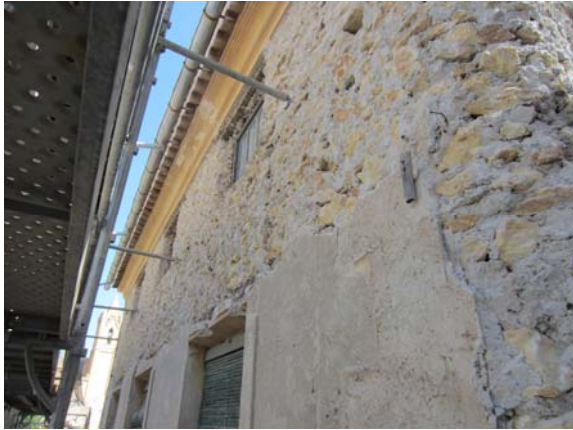
Figuras 35 y 36. Descarnado de los muros de fachada.
