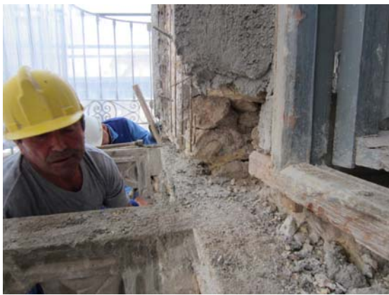
Figuras 41 y 42. Derribo y desmonte de los tableros apoyados en las ménsulas.
