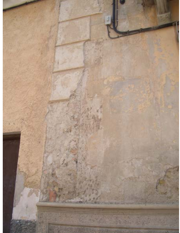
Figuras 17 y 18. Desperfectos en morteros y pinturas en fachadas.
