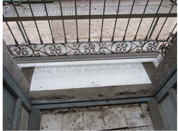
Figura 44. Preparación encofrado.
