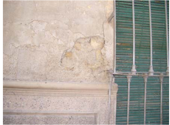
Figuras 15 y 16. Desperfectos en morteros y pinturas en fachadas.
