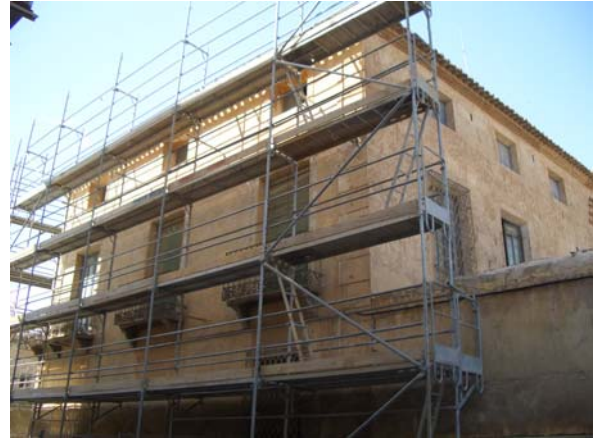
Figuras 23 y 24. Instalación andamiaje previo al comienzo de los trabajos.
