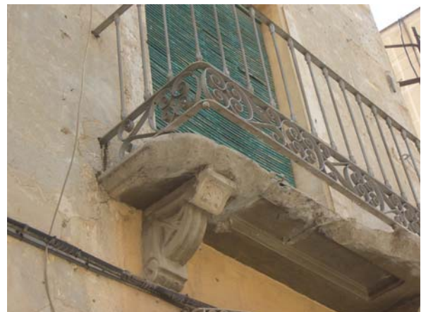
Figuras 21 y 22. Estado ruinoso de los balcones de planta primera.
