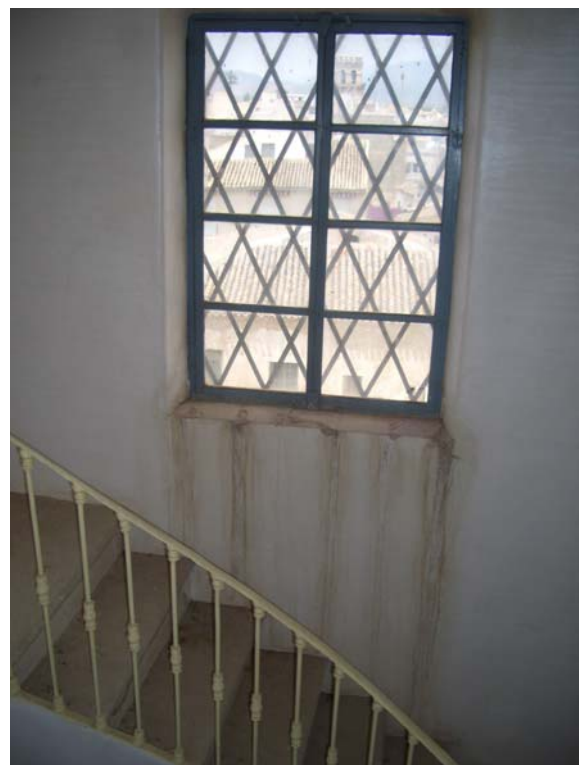
Figuras 11 y 12. Desperfectos en carpinterías y elementos de evacuación de agua.
