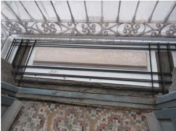
Figuras 45 y 46. Disposición de armadura y anclajes en el muro en patilla.
