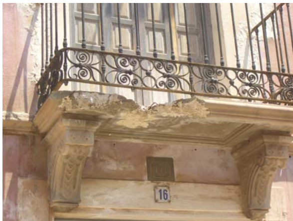
Figuras 21 y 22. Estado ruinoso de los balcones de planta primera.
