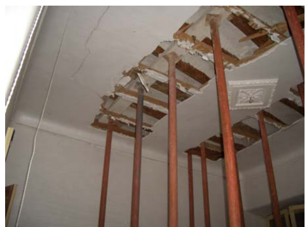
Figuras 27 y 28. Inspección y refuerzo de los elementos portantes.
