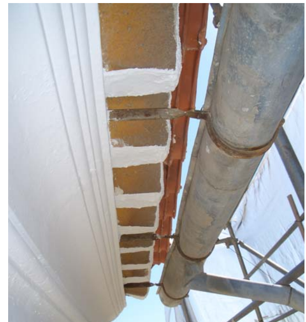
Figuras 33 y 34. Operaciones de reparación de la red de evacuación del agua de lluvia.
