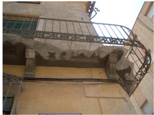
Figuras 19 y 20. Estado ruinoso de los balcones de planta primera.
