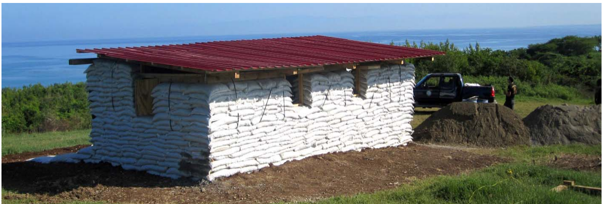
Figura 5. Proyecto Haití_ Grupo TECNOS_ Grados Arquitectura /Ingeniería de Edificación _ 2010.
