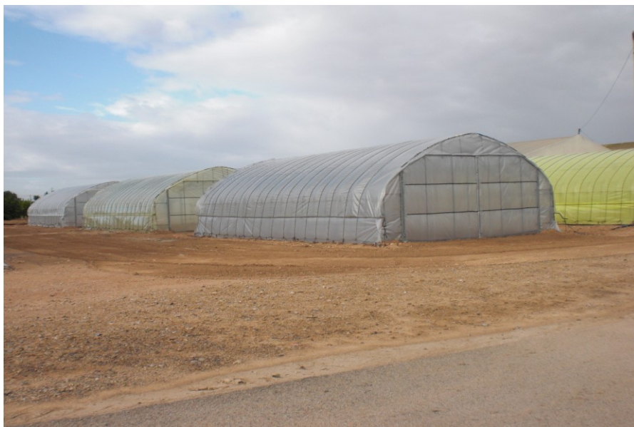
Figura III.12. Vista exterior de los invernaderos experimentales, tipo túnel visitable, modelo Kyoto.
