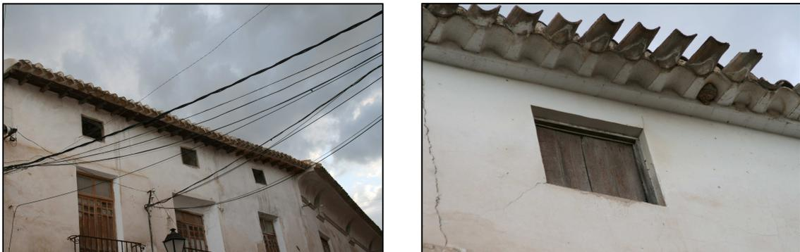
Fig. 79. Imágenes de fachadas en el casco antiguo acabadas con revestimiento de yeso. (Fuente Propia).
