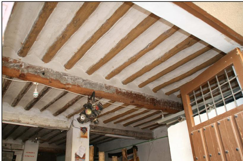
Fig. 91. Vista de elemento estructural horizontal de madera en C/ García Aguilera. (F.P.).
