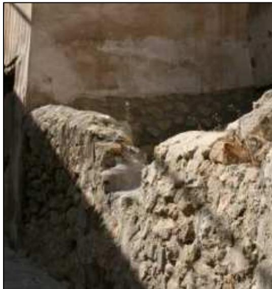
Figura 81. Muro de mampostería no concertada con mortero de cal.
