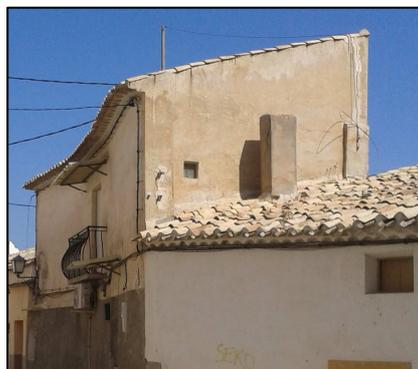
Figura 173. Cubierta inclinada a un agua. (F. P.).
