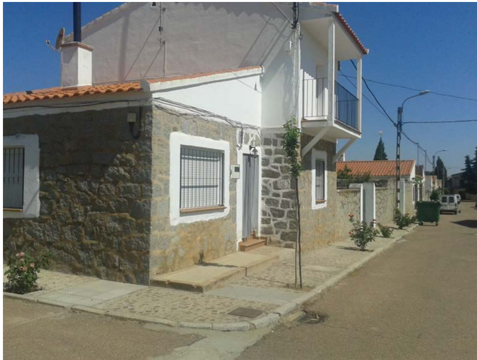
Fotografía nº 26. Edificación con Granito empleado como Material de Construcción. Población: El Docenario. Pedanía de Zalamea de La Serena. Fotografía del autor.
