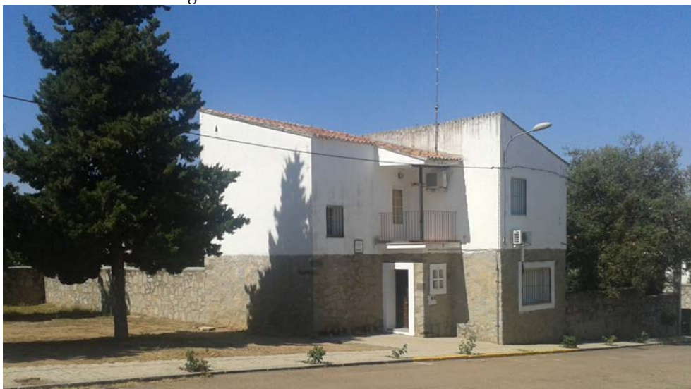
Fotografía nº 25. Edificación con Granito empleado como Material de Construcción. Población: El Docenario. Pedanía de Zalamea de La Serena. Fotografía del autor.
