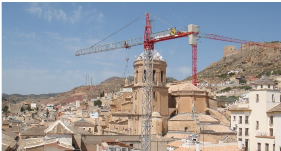
Figura 4.4. Grúas torre. Rehabilitación de San Patricio. Lorca. Fuente: el autor
