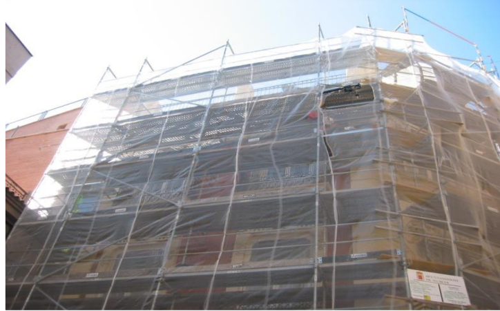
Figura 4.2. Andamio. Cámara Comercio de Murcia. Fuente: el autor
