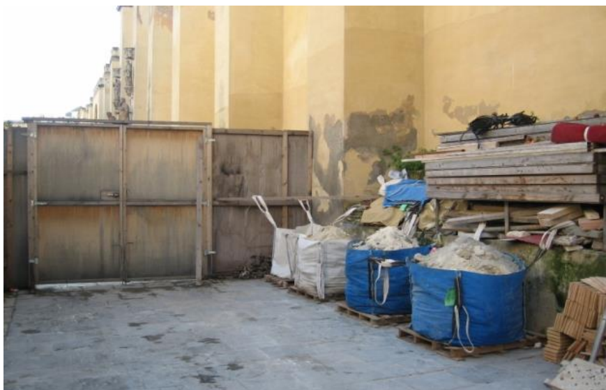
Figura 4.1. Zona de acopios. Catedral de Sevilla. Fuente: el autor
