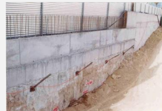
Bulonados de muro pantalla
