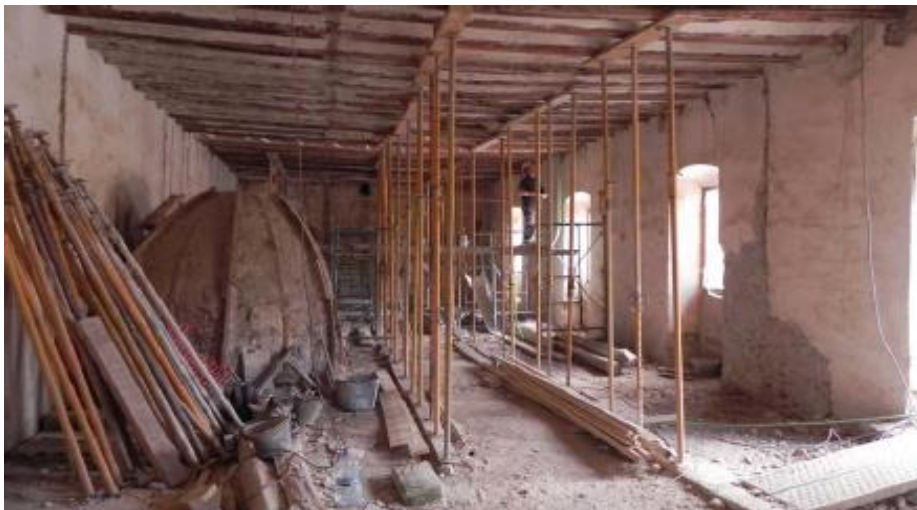
Figura 6.5. Apeo con puntales metálicos. San Francisco. Lorca. Fuente: el autor
