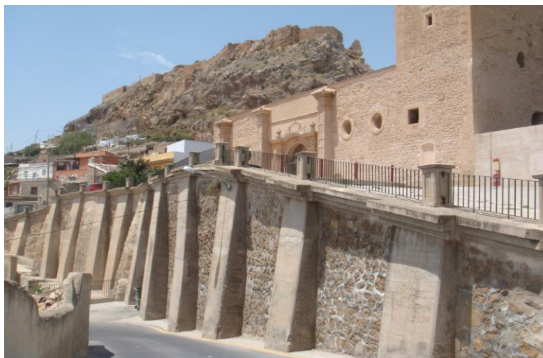
Figura 10.13 Muros de contención de piedra en la Plaza. Fuente: el autor
