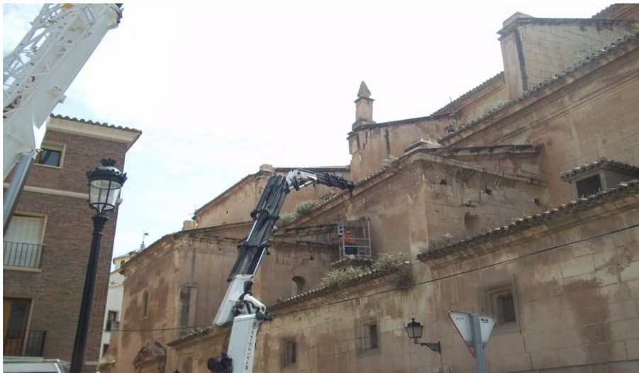
Figura 4.5. Grúa autopropulsada. Colegiata San Patricio. Lorca. Fuente: el autor
