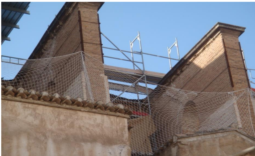
Figura 4.8. Iglesia de Santiago. Lorca. Red sistema "U". Fuente: el autor
