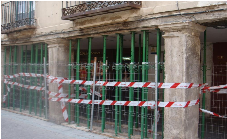
Figura 6.2. Apeo de una edificación en Alcalá de Henares. Fuente: el autor
