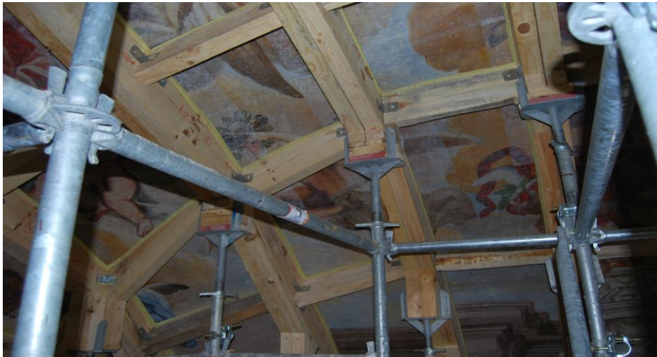
Figura 6.8. Encimbrado. Capilla del Rosario. Terremoto de Lorca. Fuente: el autor
