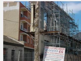
Estabilizador fachada
