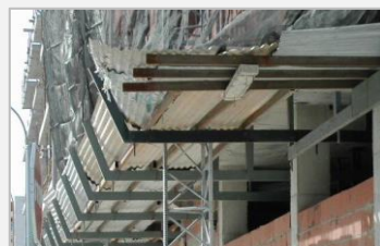
Marquesina de protección
