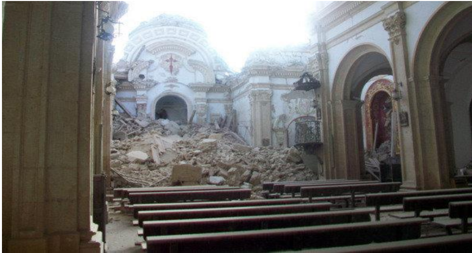
Figura 5.3. Iglesia San Patricio. Lorca, eliminación de escombros. Fuente: el autor
