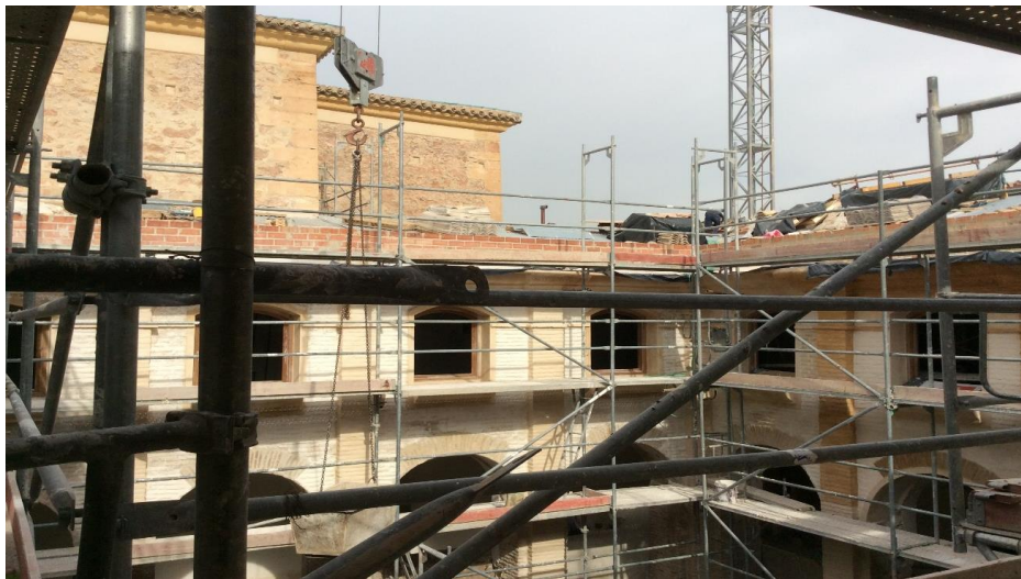
Figura 9.6. San Francisco. Lorca. Restauración de la cubierta. Fuente: el autor
