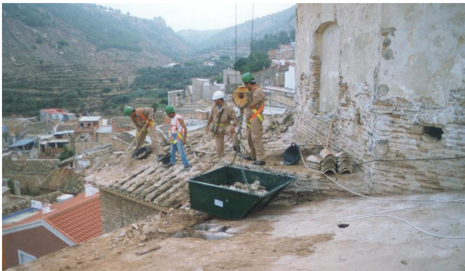
Figura 9.7. Rehabilitación de cubierta. Iglesia de Pliego. Fuente: el autor
