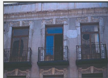
Edificio San Julián. Exterior.
