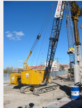
Maquina. Muro Pantalla
