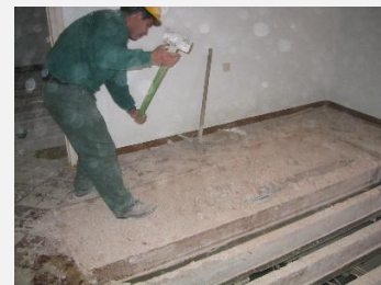
Demolición suelo vivienda
