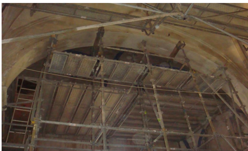
Figura 6.7. Apeo de Arco en Iglesia San Francisco de Yecla. Fuente: el autor
