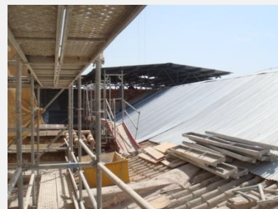
Iglesia Santiago. Trabajos en cubierta, paso peatonal para trabajadores con seguridad. Lorca. Fuente Autor
