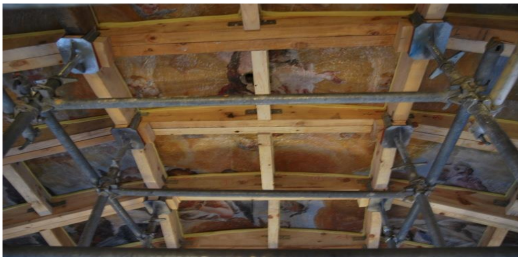
Figura 6.1. Iglesia de Santo Domingo. Lorca. Cimbrado Bóveda. Fuente: el autor
