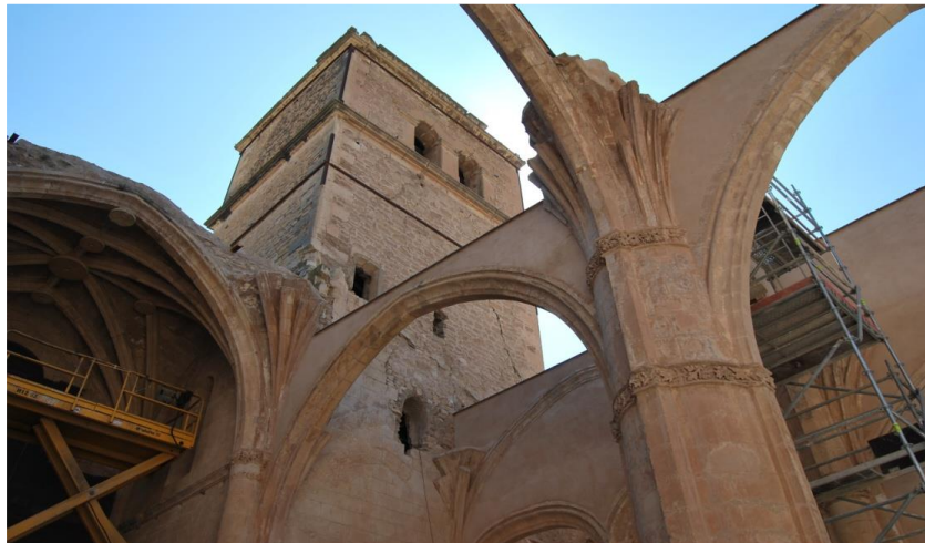
Figura 4.3. Plataforma elevadora. Iglesia Santa María. Fuente: el autor
