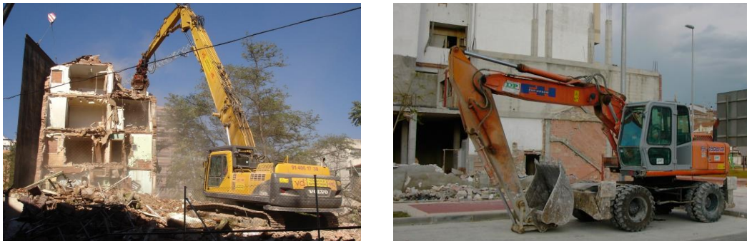
Figura 5.4. Maquinaria con cadenas izquierda y neumática derecha. Fuente: el autor
