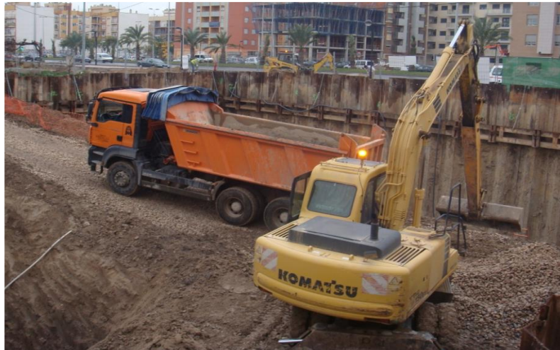
Figura 4.6. Volquete y Retroexcavadora. Fuente: el autor
