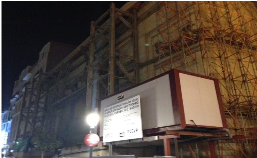
Figura 6.9 Edificio en Plaza Carmen 2016.Madrid. Vaciado total. Fuente: el autor
