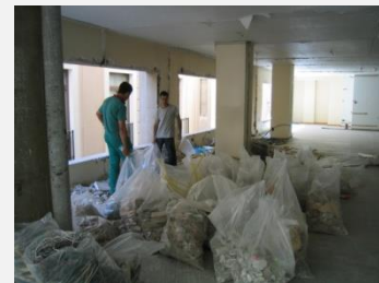
Demolición tabiquería vivienda
