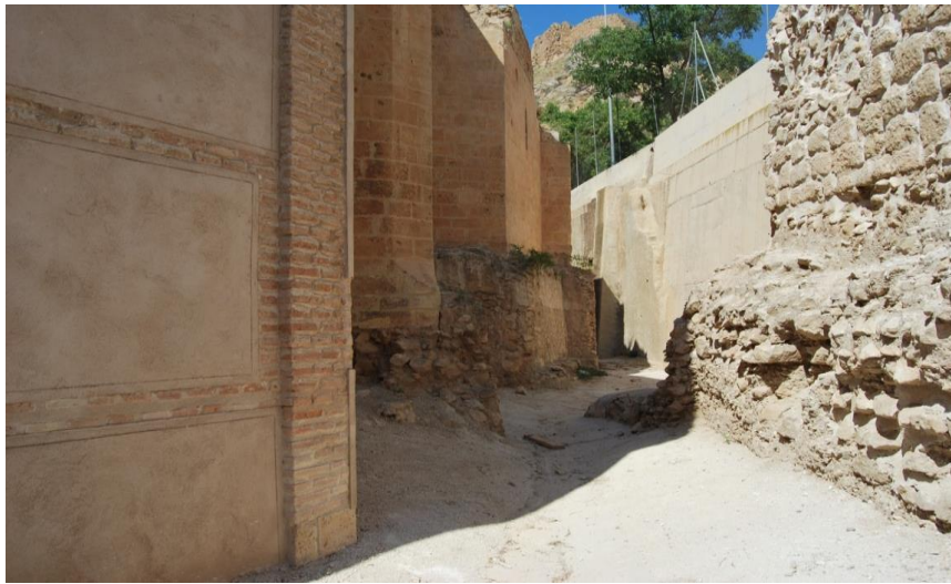
Figura 10.14. Muros de contención lateral y zona trasera. Fuente: el autor
