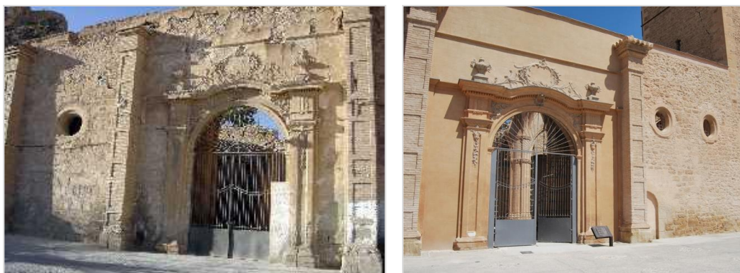
Figura 10.4. Puerta principal antes y después. Fuente: autor la segunda
