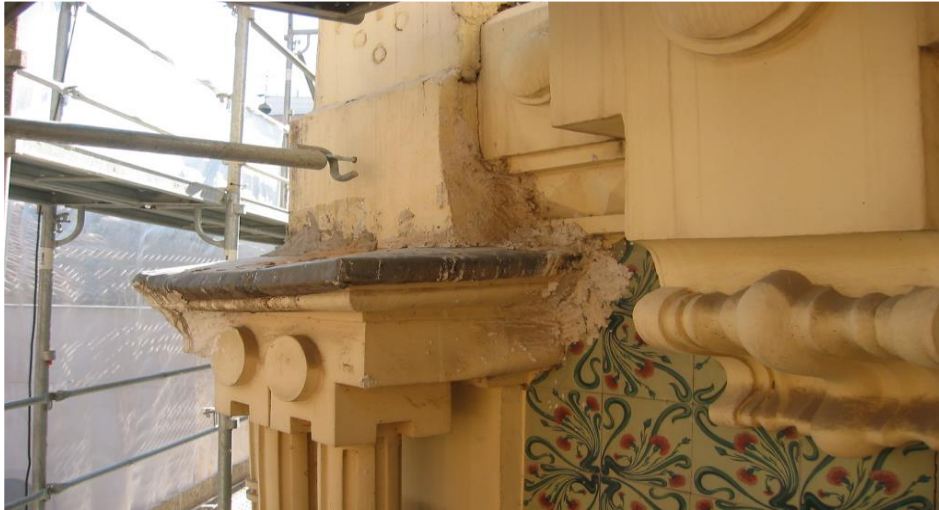
Figura 7.1. Cámara Comercio. Murcia. Rehabilitación fachada. Fuente: el autor
