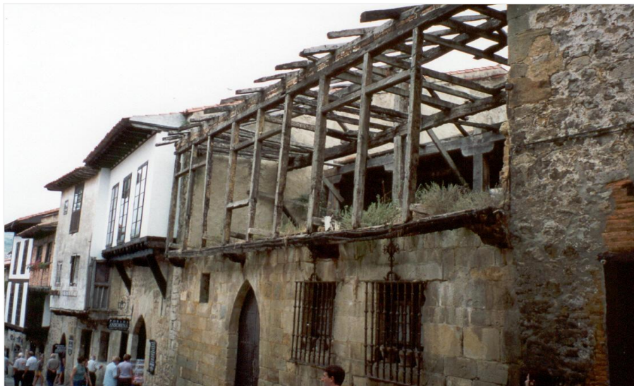
Figura 8.2. Estructura de madera. Santillana del Mar. Fuente: el Autor
