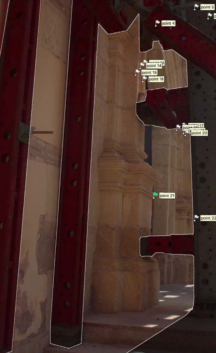
Figura 080 (izquierda) y figura 081 (superior). Máscaras de PhotoScan para ayudar al software fotogramétrico a no considerar aquello que no es objeto del levantamiento. Labores de conservación tras sismo. Portada principal antiguo Convento de la Merced, actual Centro de Visitantes de Lorca (Murcia). Fuente: Autor.
