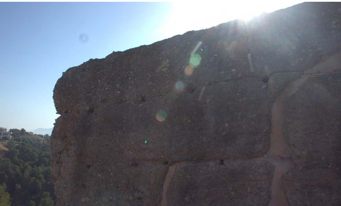
Figura 046. Condiciones lumínicas adversas (fotografía a contraluz) para un correcto levantamiento fotogramétrico en exteriores. Castillo de la Luz, Parque Regional Carrascoy y El Valle (Murcia). Fuente: Autor.
