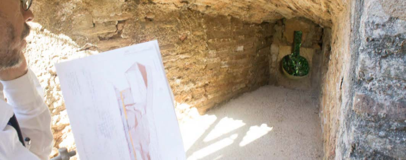
Figura 069. Proceso documental de una tronera del cubo de defensa del pilar de Carlos V, junto a la Puerta de la Justicia y toma fotogramétrica de la Alhambra, Granada. Fuente: Autor.
