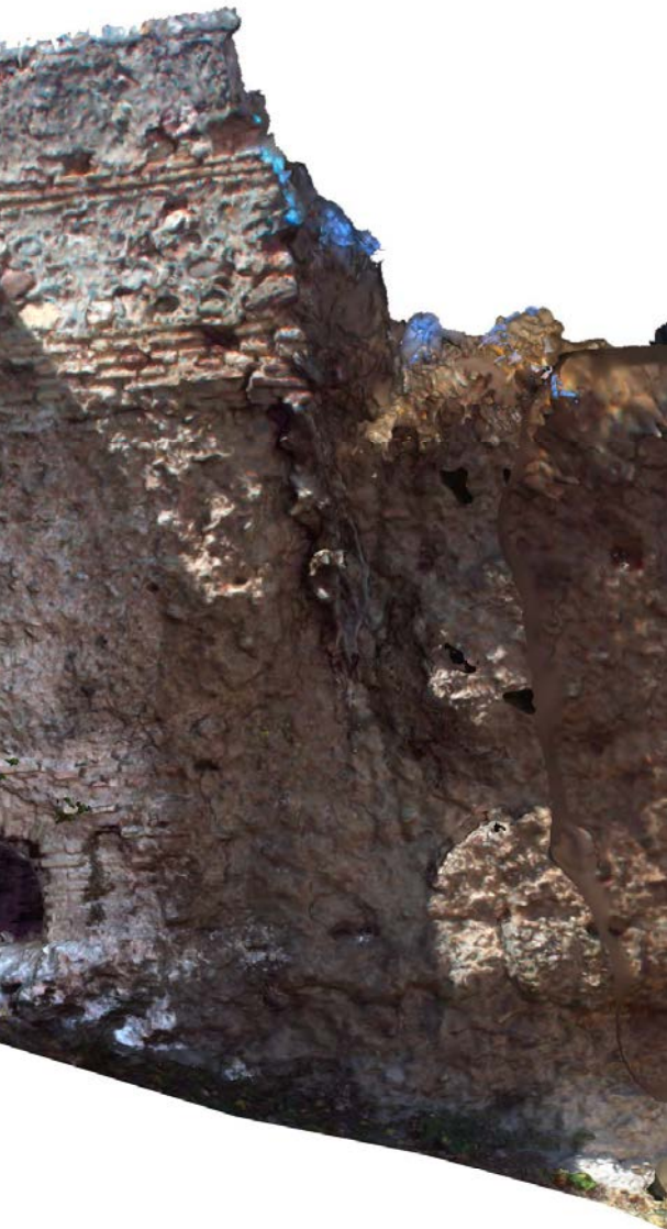
Figura 170 (inferior derecha). Ortofotografía fotogramétrica de valor métrico para cálculo de superficies. Baluarte de la Alcazaba. Alhambra (Granada). Fuente: Autor.
