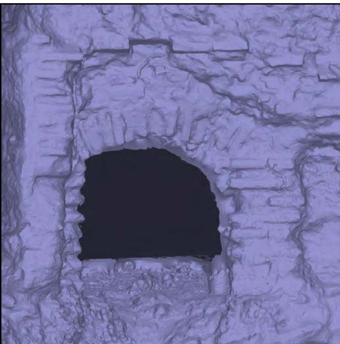
Figura 183. Tronera 5 (superior) y 6 (inferior). Correspondencia modelo tridimensional y ortofotografía del conjunto de troneras del Baluarte de la Alcazaba. Generadas con fotogrametría digital. Alta resolución fotorrealística para un estudio pormenorizado en gabinete de materiales y técnicas constructivas empleadas. Fuente: Autor.
