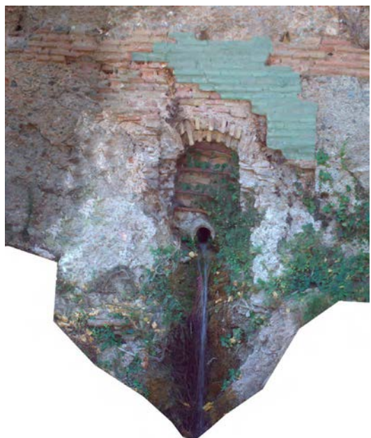
Figura 170 (inferior derecha). Ortofotografía fotogramétrica de valor métrico para cálculo de superficies. Baluarte de la Alcazaba. Alhambra (Granada). Fuente: Autor.
