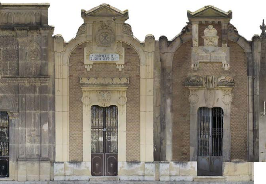
Figura 228. Planimetría de estado actual generada con fotogrametría. Acabado fotorealístico. Conjunto de panteones estudiados del Cementerio de San Clemente, Lorca (Murcia). Fuente: Autor.
