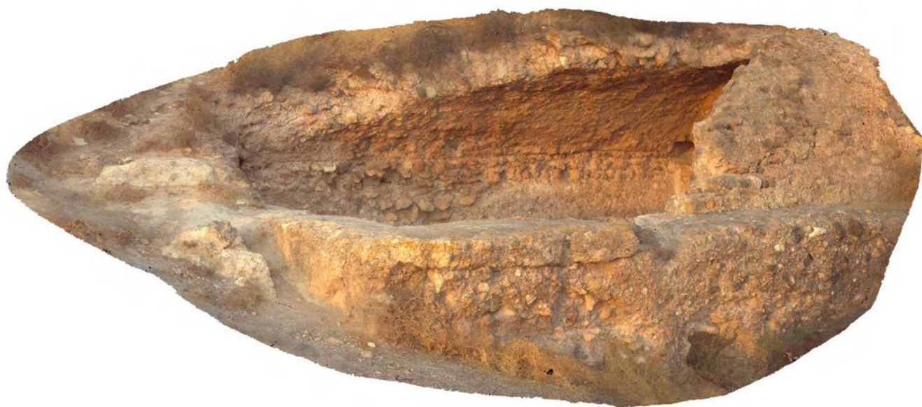
Figura 103 (superior) y figura 104 (inferior). Respectivamente: Comparativa entre imagen real y recreación tridimensional fotorrealística en alta resolución generada con fotogrametría desde la misma perspectiva. Aljibe del Castillo de la Luz, Parque Regional Carrascoy y El Valle (Murcia). Fuente: Autor.
