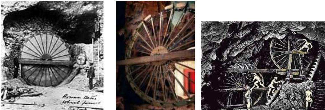
Fig. II.48. Rueda hidráulica de Río Tinto. Noria romana encontrada tras excavaciones por el derrumbe de las galerías. Archivo Histórico Minero Fundación Rio Tinto.
