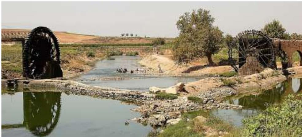
Fig. II.62. Norias de corriente sirias sobre el río Orontes (R.I).
