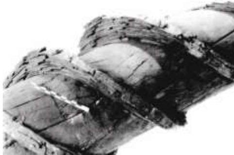
Fig. II.56. Mina romana Sotiel Coronada. Detalle de hélice de tornillo de Arquímedes. Les mines de la Péninsule Ibérique dans l'Antiquité romaine. Domergue, Claude.
