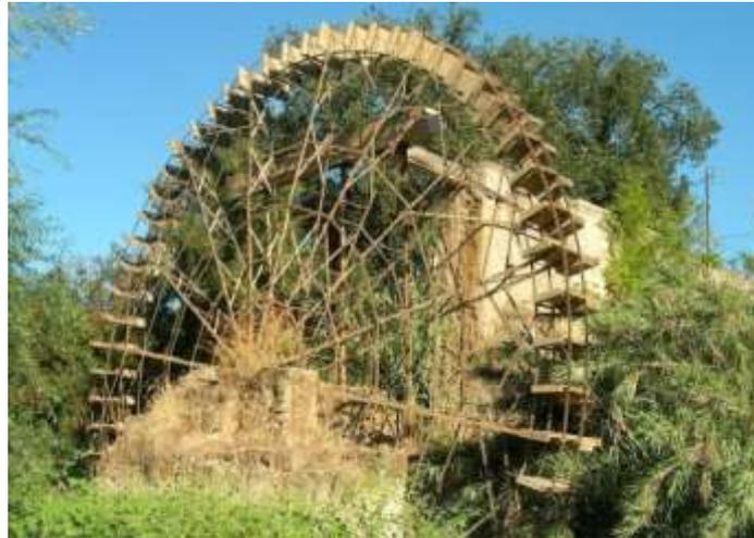
Fig.: IV.54.: Noria de Jauja, Lucena, Córdoba, de estructura metálica con palas y cangilones de madera.
