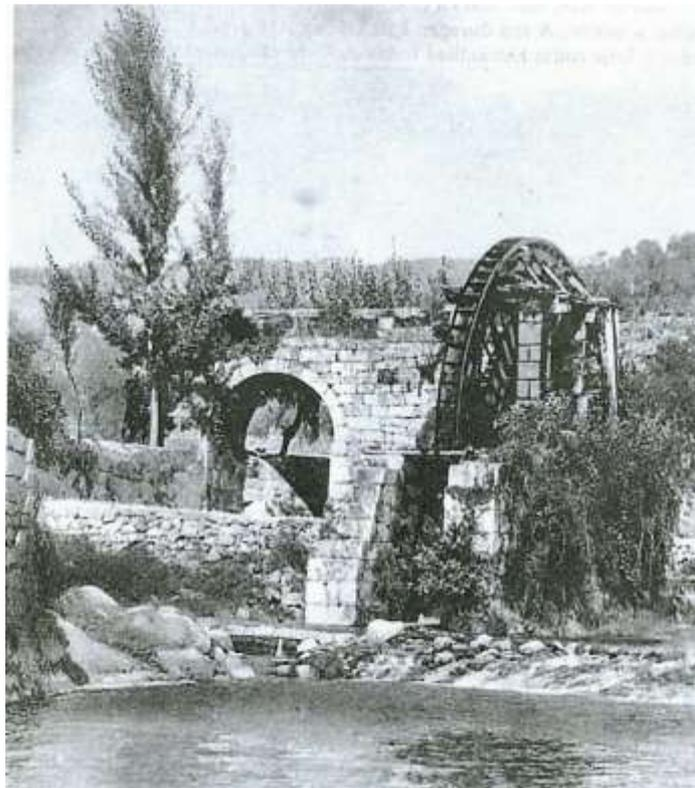
Fig.: IV.84. Rueda hidráulica de hierro en San Pedro do Sul.
