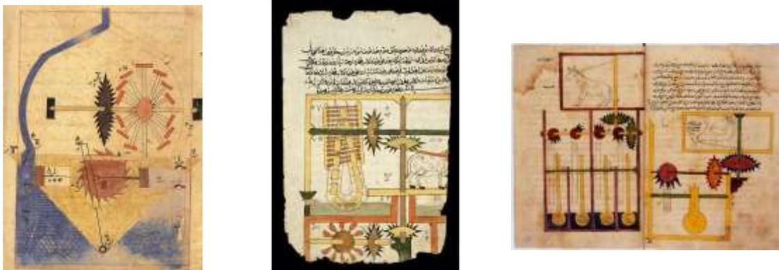
Fig. II.64, II.65 y II.66. Ruedas hidráulicas con engranajes, dentadas, de cuchara, con cangilones, de paletas planas, etc. El libro del conocimiento de los ingeniosos mecanismos. The Book of Knowledge of Ingenious Mechanical Devices . al-Jazari. Siglo XII (R.I).
