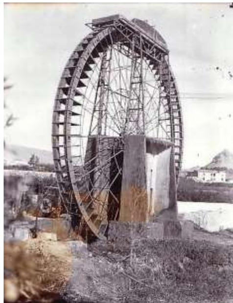
V.36. La noria de Las Arboledas en Archena, de tipología mixta, con elementos metálicos y de madera, tenía unos 14 metros de diámetro y fue desmontada a mediados del siglo XX. Archivo de la Confederación Hidrográfica del Segura.
