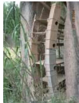
V.32. Noria de Salmerón. Moratalla. Las actuaciones de mantenimiento, incorporaron elementos metálicos, incluso de metalurgias distintas, de métricas diferentes a las originales, configurando finalmente, una estructura totalmente metálica, sin la presencia de elementos de madera.
