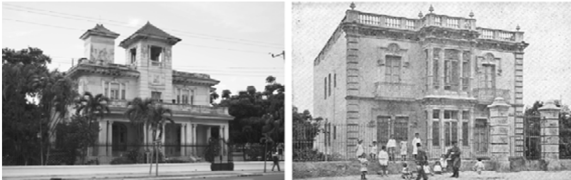
Fig. 382 Obras en el Vedado de La Habana (izq.) y el Ensanche de Cartagena (drcha.)
