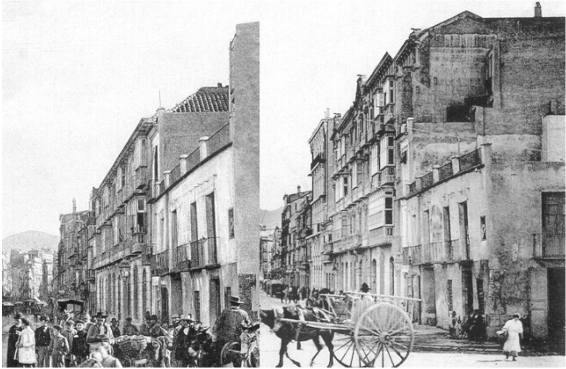
Fig. 40 La casa Dorda antes y después de ser ampliada (dos parcelas más adelante aparece el casa Nieto Asensio, en 1909, se convertiría en el edificio más alto de la calle)
