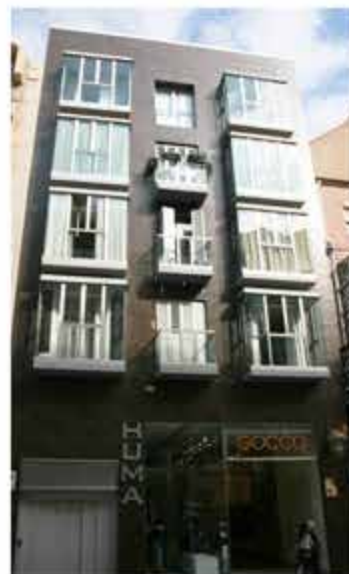
Obra siglo XXI
