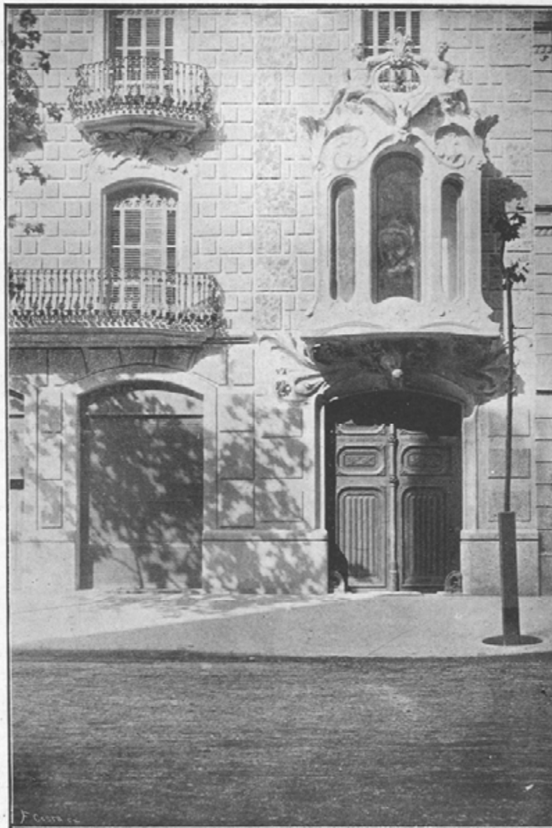
Casa de alquiler en la calle del Bruch (Barcelona)
