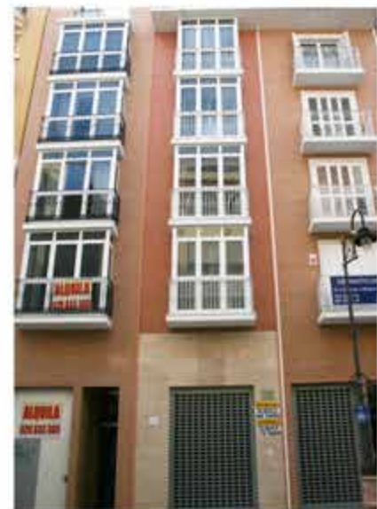
Obra siglo XXI
