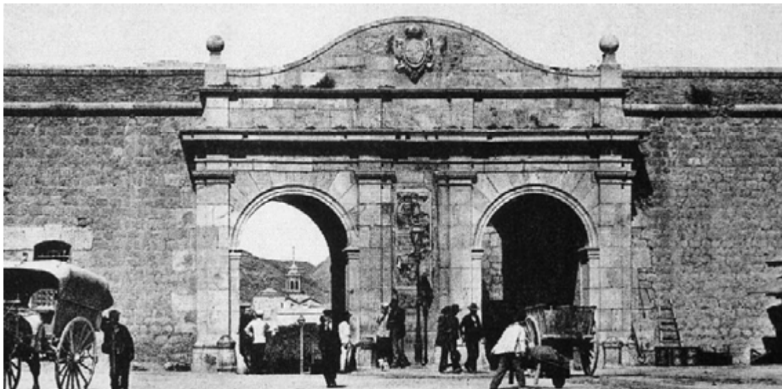
Fig. 77 Puertas de San José: a la izquierda se vislumbra la linterna de La Caridad
