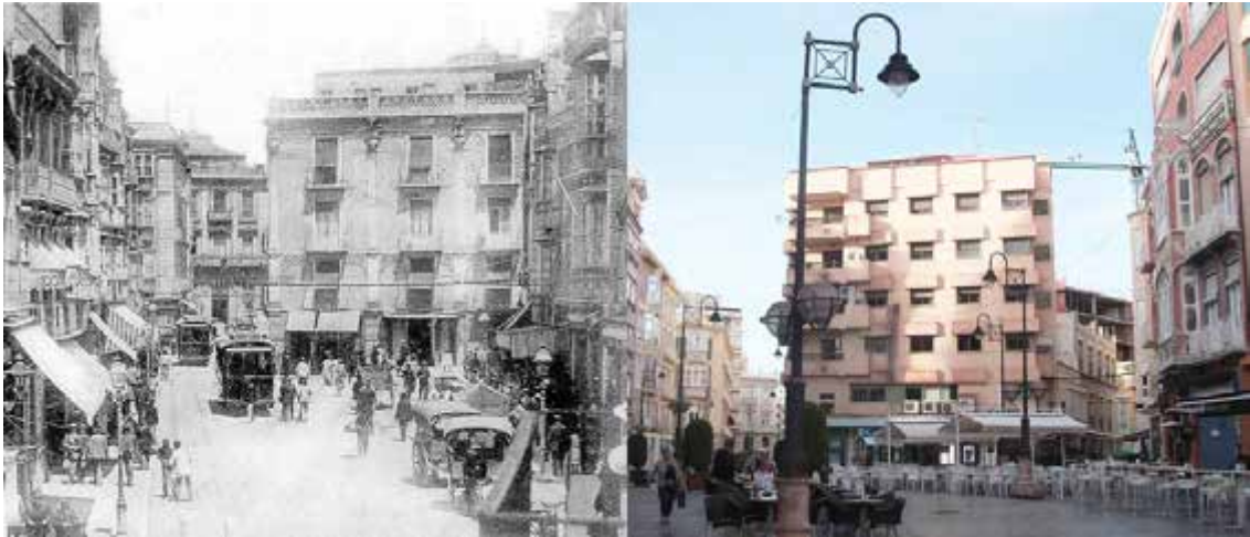
Fig. 172 Las Puertas de Murcia antes (izq.) y después (dcha.) del derribo del edificio nº24 de esta calle
