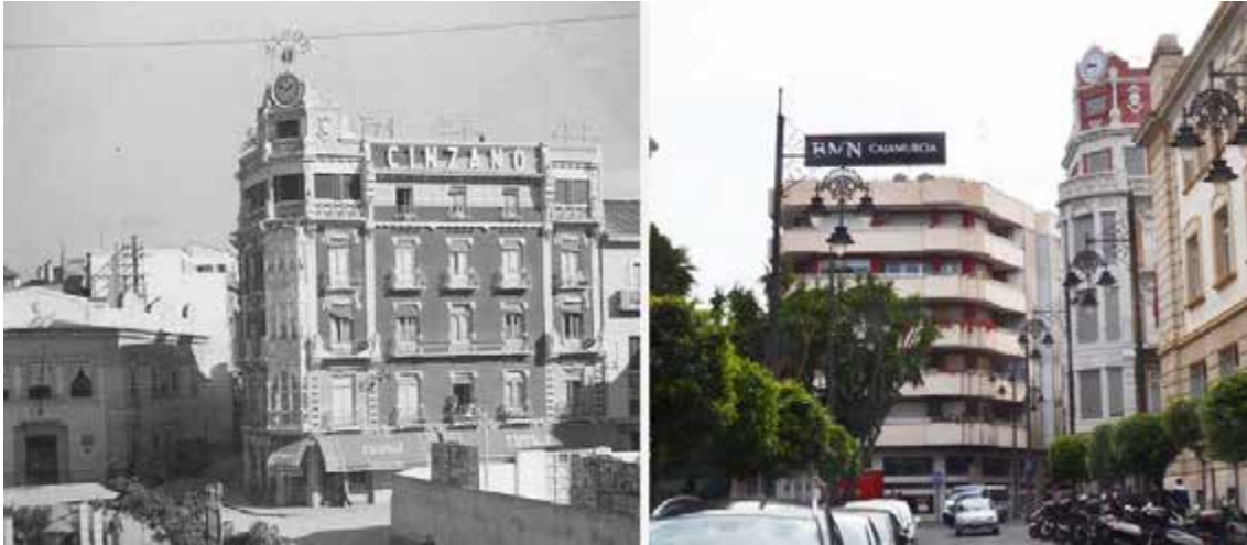
Fig. 222 Edificio Dorda Bofarull con el mirador original (izq.) y en la actualidad (dcha.) en el que ya aparece el mirador de obra, a su lado el edificio Telefónica de 1978.
