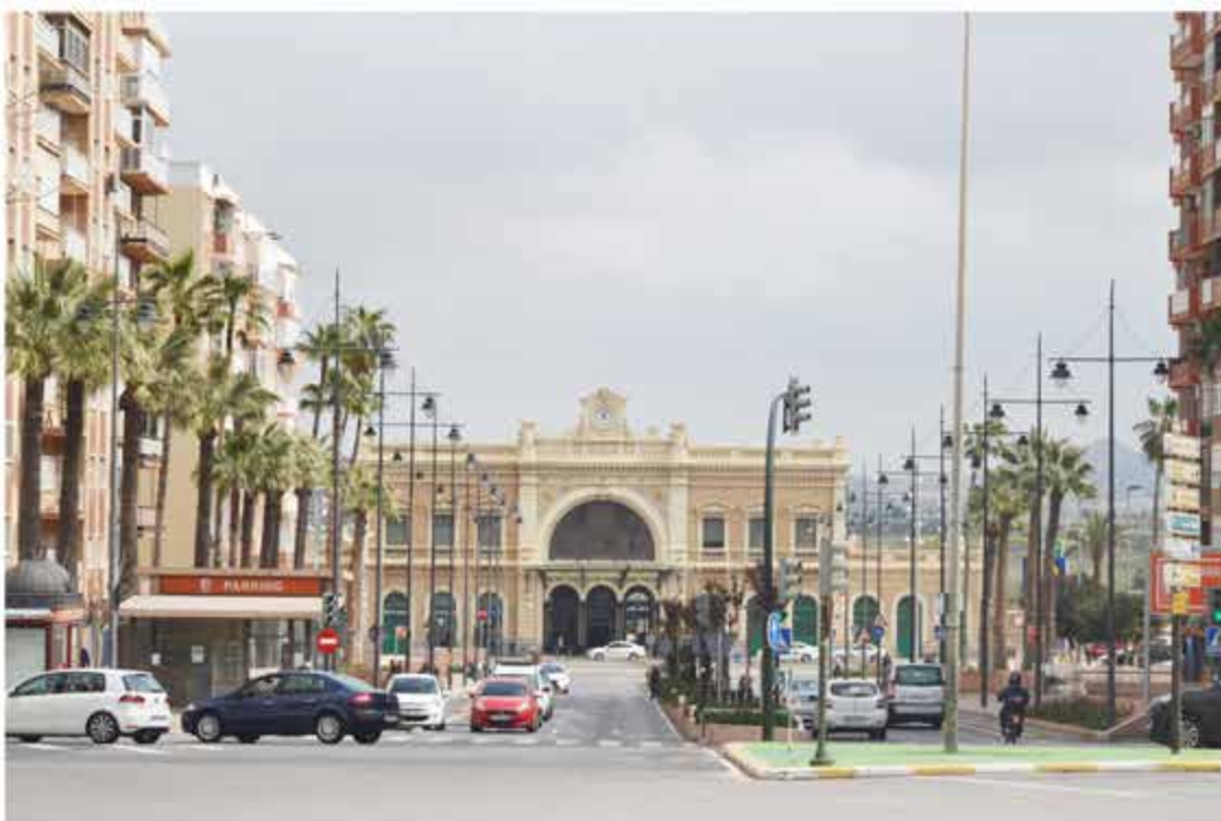
Avenida América y la Estación de Tren en la actualidad
