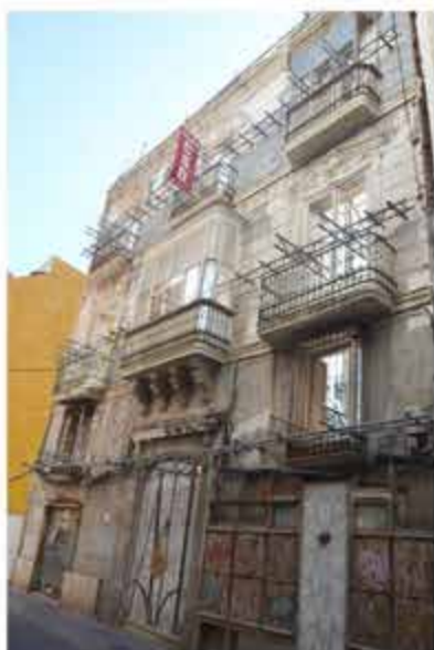
MAL ESTADO (Sólo se conserva fachada) 1 La planta baja muy deteriorada
