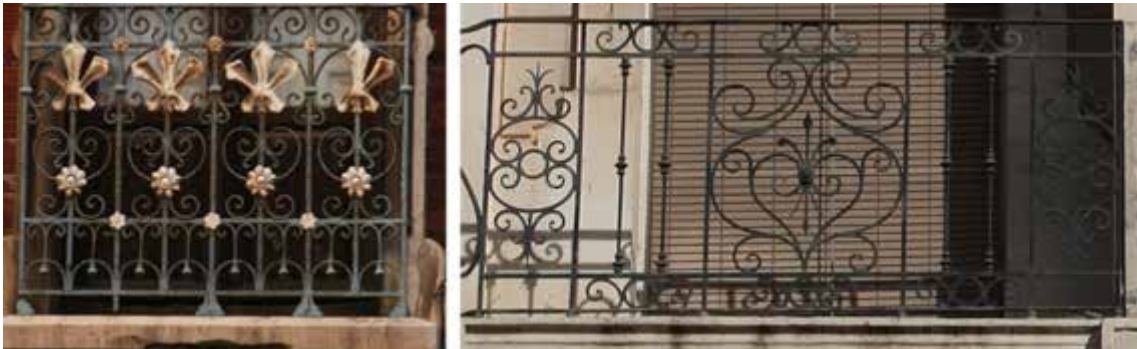
Fig. 8 Detalle de rejerías
