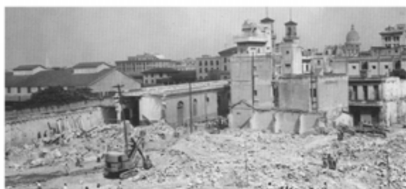
3 Derribos en la Avenida del Puerto
