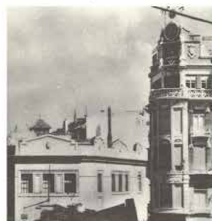
6 Edificio Telefónica 7 Edificio Dorda Bofarull
