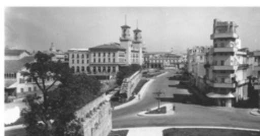
4 Estación de Tren
