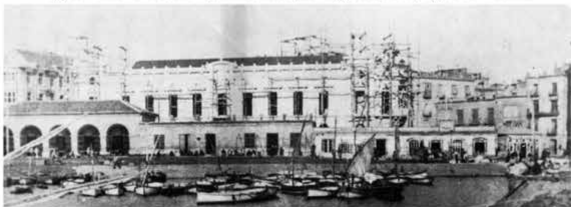
Fig. 61 Palacio Consistorial en construcción
