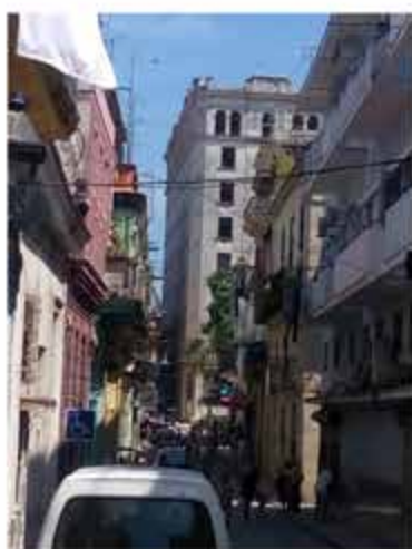
7 Obra en Aguacate-O'Reilly
