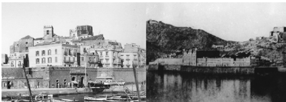
Fig. 63 La C/Príncipe de Vergara (izq.) y la C/Muralla del Mar (dcha.) antes de la caída de la muralla
