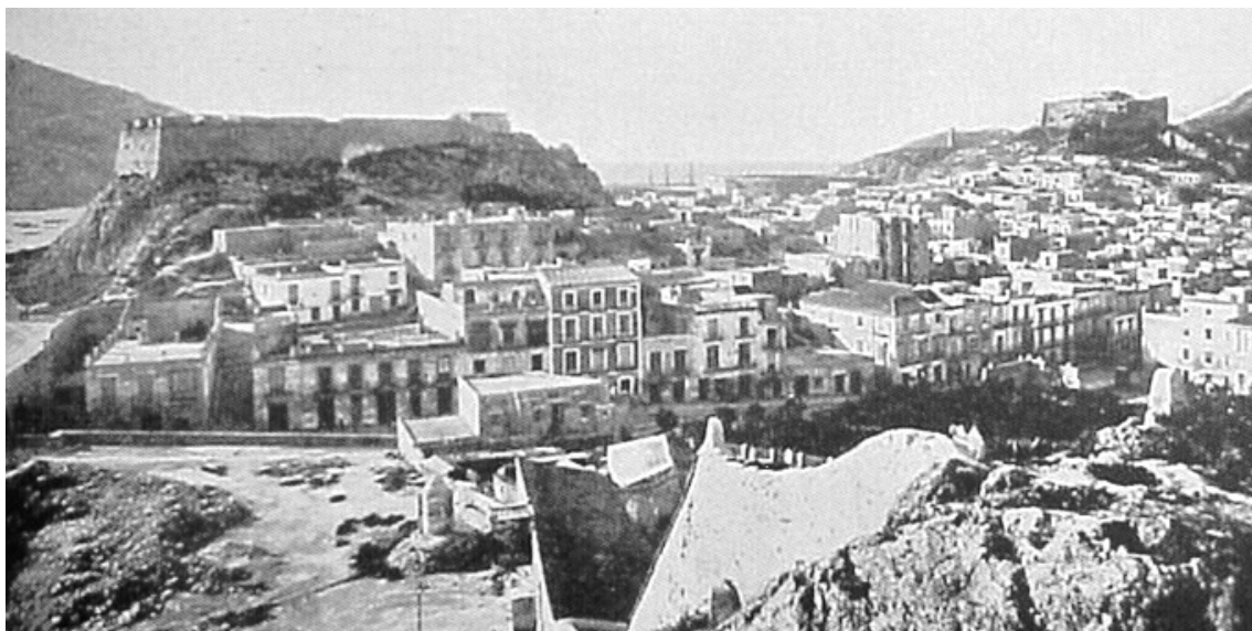
Fig. 85 Calle San Diego antes del derribo de las Puertas de San José
