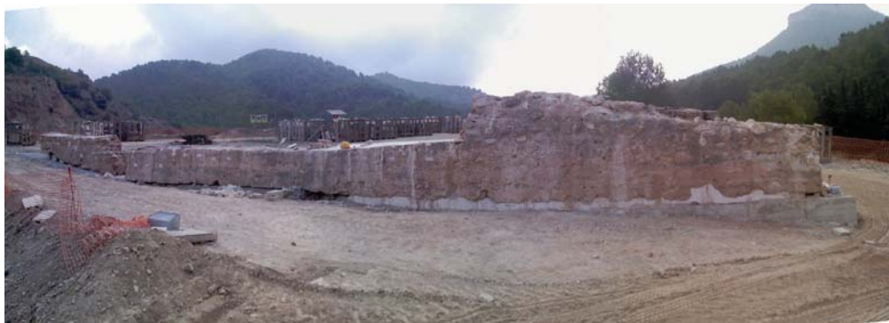
Fig. 9.- Recolocación de primeros tramos sobre las zapatas corridas de cimentación en plataforma (2008, Fuente: Sánchez Medrano, Fco. J.)
