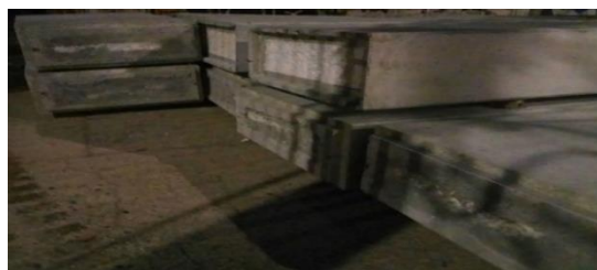
Figura 0.10 Acopio de bloques en obra. Fuente: Elaboración propia.
