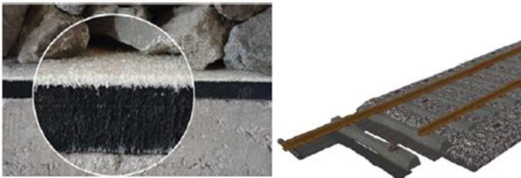
Figura 0.17. Manta elástica bajo capa de balasto. Fuente: (85)
