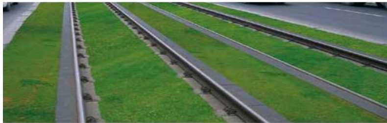
Figura 0.20. Sistema ATD de RAILONE. Fuente: (94)
