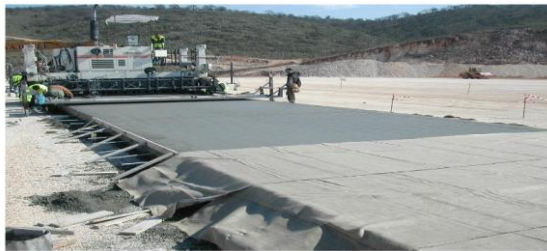
Figura 0.7. Pavimento de puerto realizado con hormigón reforzado con fibras. Fuente: (37)
