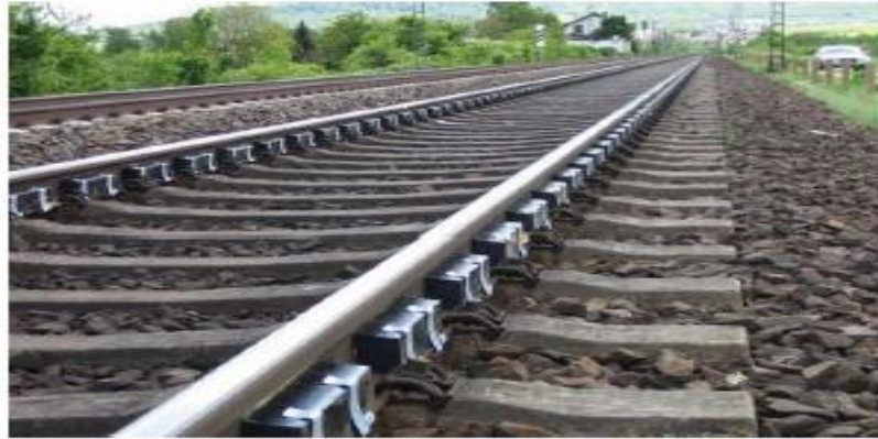
Figura 0.33. Material de amortiguamiento en el alma del carril. Fuente: (111)
