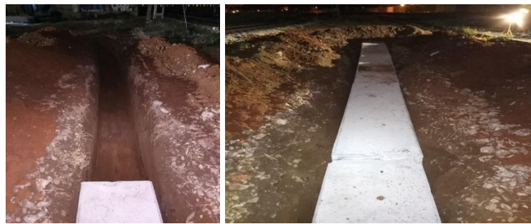
Figura 0.11 Ejecución de la barrera de bloques anti-onda. Fuente: Elaboración propia
