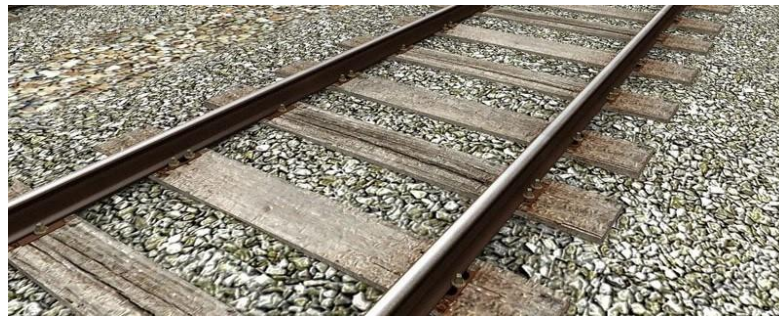
Figura 0.2. Traviesa de madera. Fuente: maderea.es .
