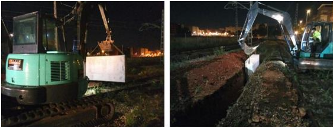
Figura 0.5 Manipulación e instalación con miniexcavadora. Fuente: Elaboración propia.
