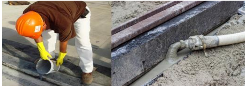
Figura 0.5 vertido de lechada de cemento en juntas de forma manual. Fuente: es.123rf.com
