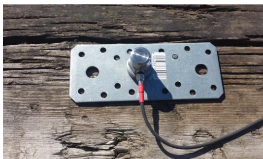
Figura 0.8 Pletina metálica adherida a la superficie de la traviesa. Fuente: Elaboración propia
