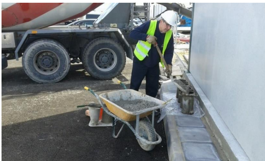
Figura 0.1. Relleno de los moldes. Fuente: Elaboración propia.
