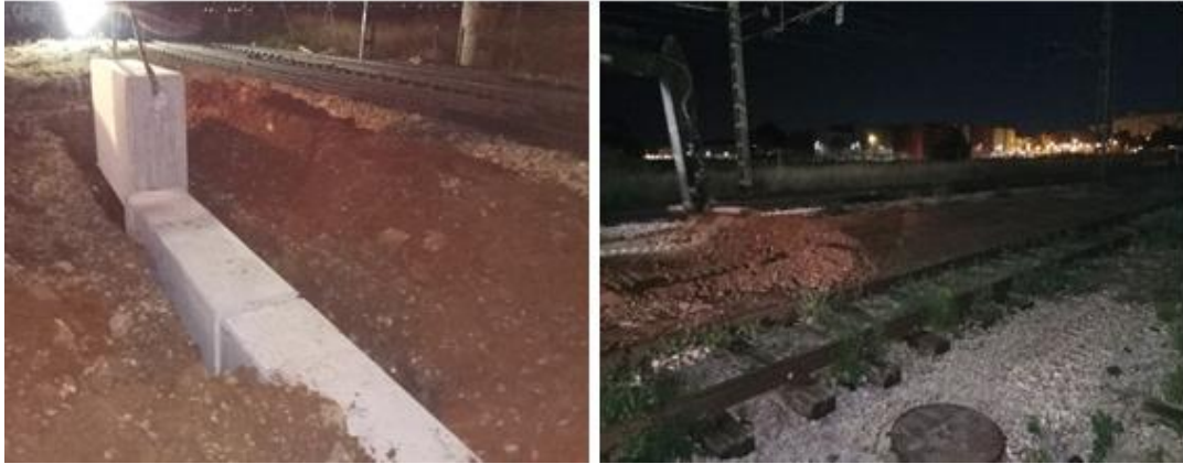
Figura 0.7 Finalización de la disposición de bloques, Cierre de zanja. Fuente: Elaboración propia.
