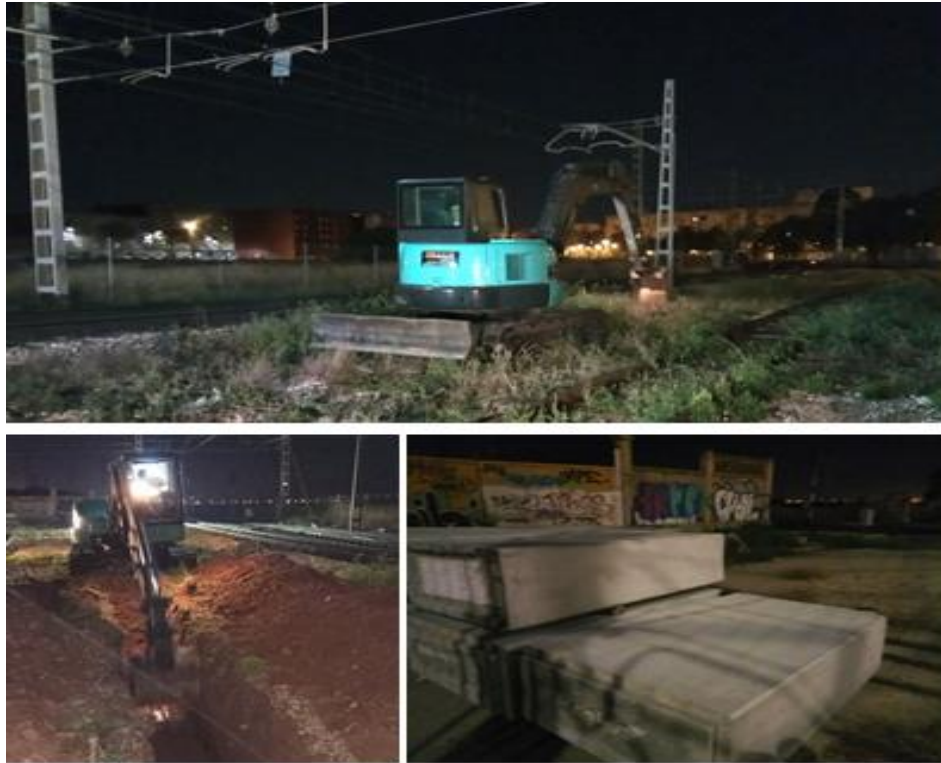
Figura 0.3 Excavación de zanja para disposición de bloques anti-onda; acopio de bloques sobre las vías del antiguo acceso a talleres. Fuente: Elaboración propia.
