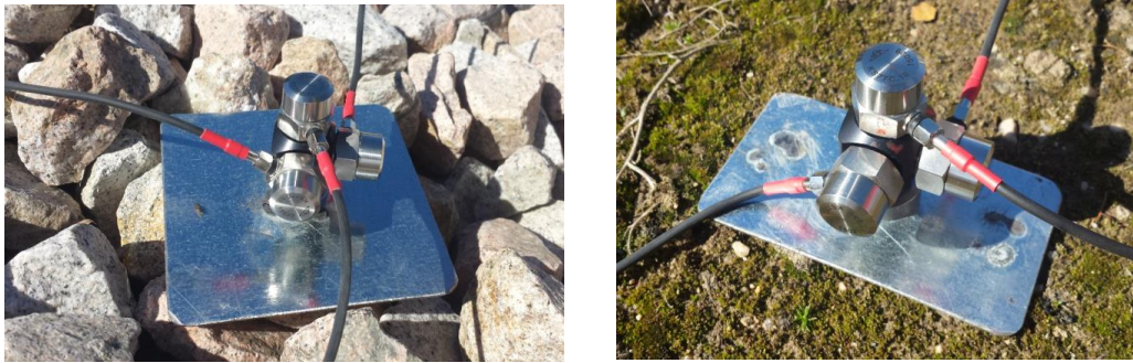
Figura 0.9 Pica metálica clavada en balasto (izquierda) y terreno natural (derecha). Fuente: Elaboración propia
