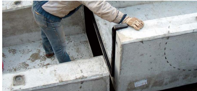
Figura 0.6 Preparación de junta aislante de PVC entre elementos prefabricados de hormigón. Fuente: www.bt-innovation.de
