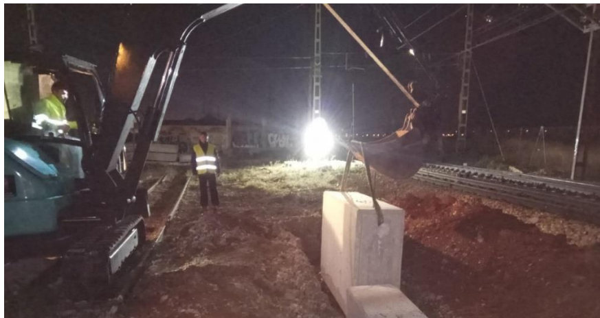
Figura 0.12 Colocación del último bloque del tramo de pruebas. Necesidad de un guiado preciso y cuidadoso. Fuente: Elaboración propia.
