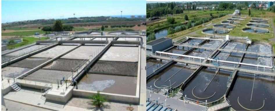
Figura 5. Vista de un reactor biológico de fangos activos de flujo pistón y un reactor biológico de fangos activos en carrusel.
