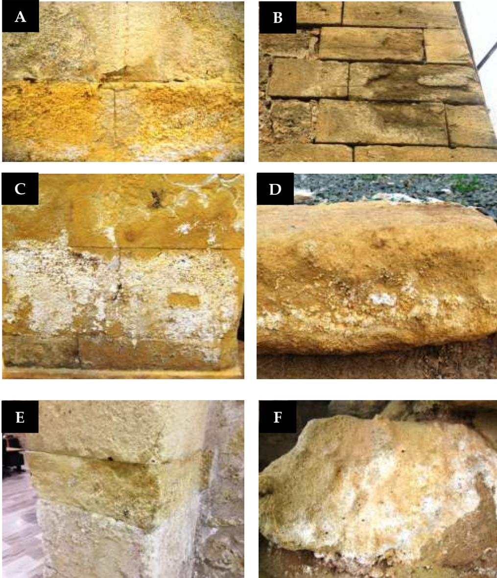
Figura 5.2. A: Detalle de pátina en D I O 0,70 160. B: Presencia de costra negra en F E N 2,20 102. C: Eflorescencias (D I S 0,10 160). D: Presencia de eflorescencias en la superficie del sillar (G E S 1,10 426). E: Distintas tonalidades en un sillar en A I O 0,10 663. F: Presencia de sales en D I O 0,60 160. Fuente: elaboración propia
