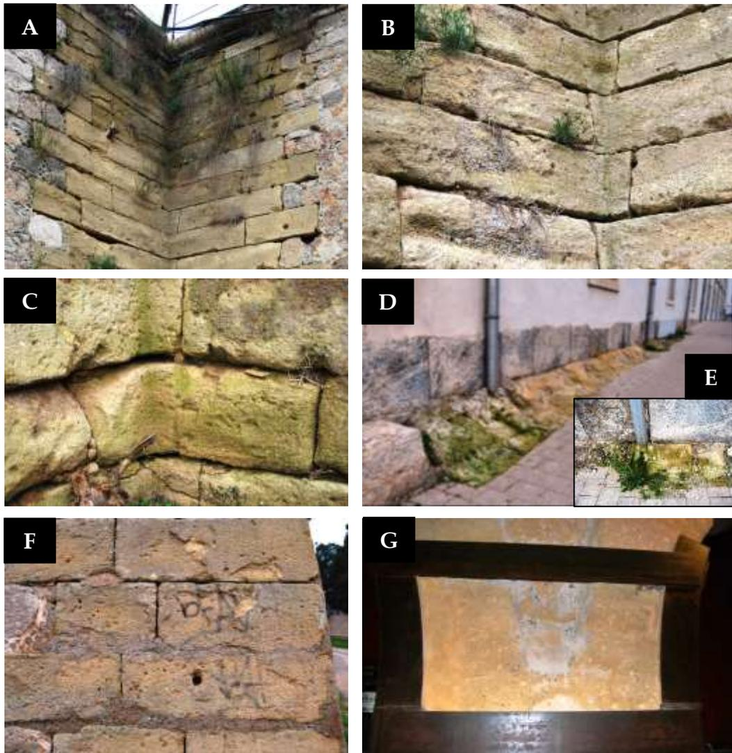
Figura 5.5. A: Colonización por plantas superiores en F E N/O 5,20 102. B: Presencia de organismos en F E O 3,20 102. C: Presencia de biodeterioro en F E N/O 0,30 102. D: Vista general presencia de biodeterioro en G E N 0 426. E: Detalle G E N 0 426. F: F E N 1,50 102. F: Perforación y grafiti en F E N 150 102. G: Inserción de elementos de arriostramiento en C I S 2,10 183. Fuente: elaboración propia
