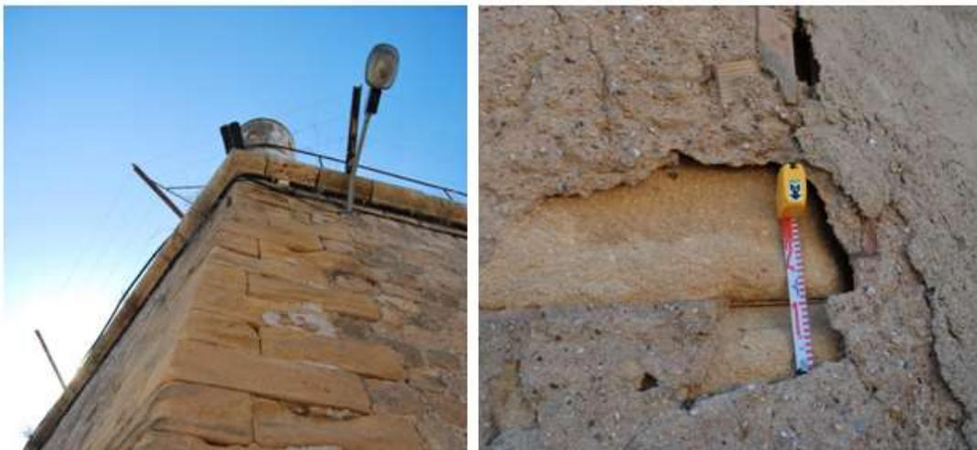
Figura 2.21. Sillería de Tabaire en la Muralla De Carlos III, rambla de Benipila. Fuente: elaboración propia
