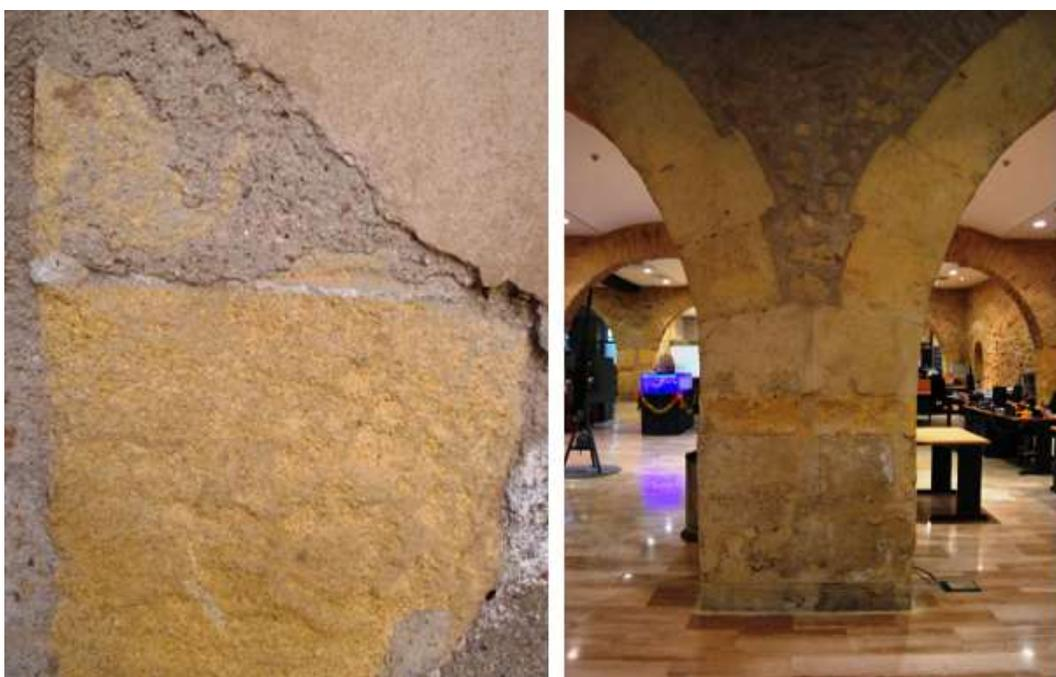
Figura 2.14. Detalle bloques de Tabaire en el Real Hospital de Marina (izquierda) y en el Real Arsenal de Marina (derecha). Fuente: elaboración propia
