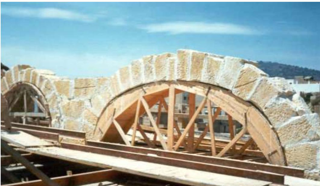
Figura 2.13. Arcos compuestos por sillería de Tabaire en el Real Hospital de Marina. Fuente: Lasheras, 2011
