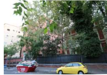
Figura 286: Relación y convivencia del palacete decimonónico con el edificio de la Sede de Bankinter.
