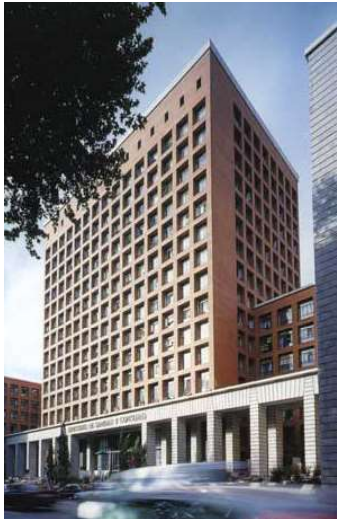
Figura 245: Casa Sindical de Madrid Paseo del Prado, 1949-1951. Francisco de Asís Cabrero y Rafael Aburto.
