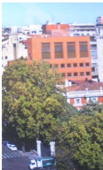
Figura 285: Fotografía desde la Avenida de la Castellana del palacete decimonónico con el edificio de la Sede de Bankinter al fondo.
