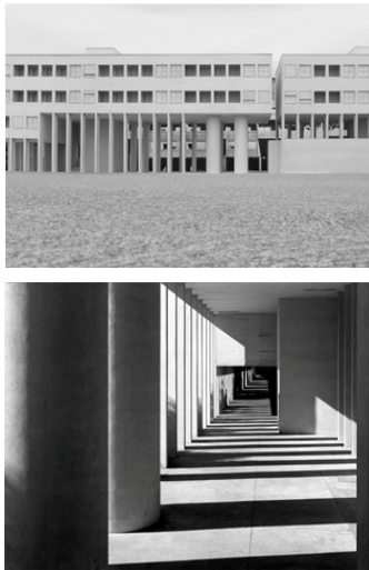
Figura 31: Unidad Residencial Gallaratese Detalle de Fachada, detalle de corredor de acceso a las viviendas. Milán 1969-1973, Aldo Rossi.
