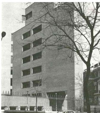
Figura 254: Detalle de los huecos de ventana que se enfrentan al edificio de viviendas del Edificio Bankinter. Madrid, 1972-1976. Rafael Moneo.
