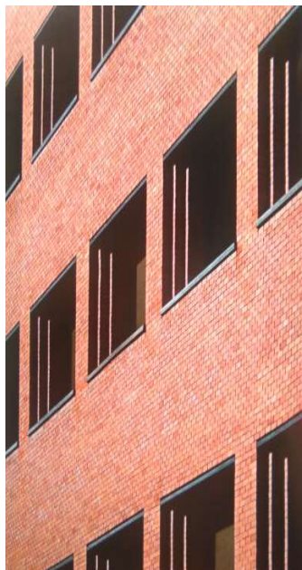
Figura 284: Fotografía de detalle de los huecos en fachada de la Sede de Bankinter. Rafael Moneo.
