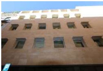
Figura 275: Alzado de la calle San Patricio con la reja de hierro forjado al nivel de peatón.
