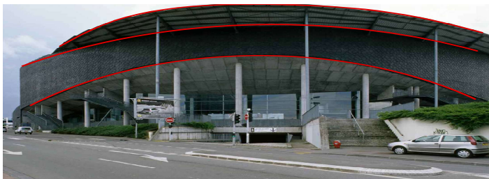
Figura 197: Pájaro en el aire. Brancusi Rotundidad del exterior del Palacio de Congresos y Exposiciones, Lille (1988-1991). Rem Koolhaas.
