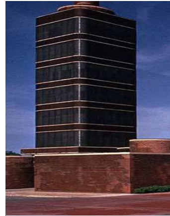
Figura 166: Exterior de las oficinas Johnson.
