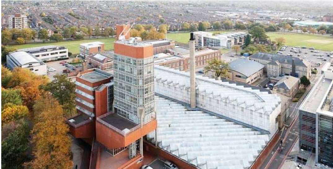
Figura 97: Vista Aérea de la Escuela de Ingeniería de Leicester, Inglaterra (1959-1963). James Stirling.
