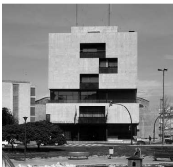
Figura 246: Edificio para el Gobierno Civil de Tarragona, Tarragona, 1959-1963. Alejandro de la Sota.
