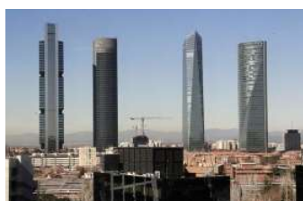
Figura 153: Fotografía Cuatro torres de Madrid.
