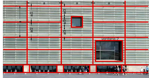
Figura 206: Fachada noroeste del Kursaal.
