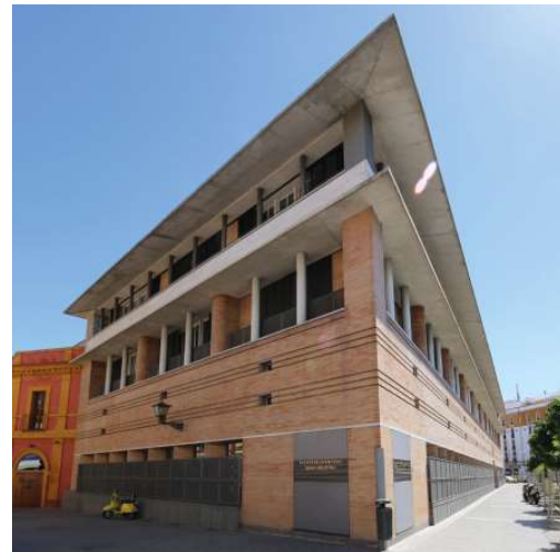
Figura 134: Puerta principal de acceso en esquina.
