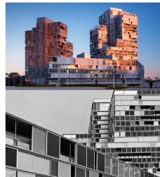
Figura 162: Edificio Illa de Llum.
