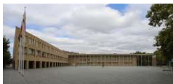
Figura 117: Fachada del Ayuntamiento.
