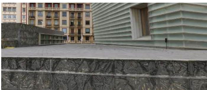
Figura 198: Detalle del zócalo de pizarra del Kursaal.
