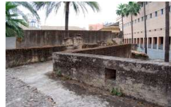
Figura 125: Fachada posterior de Previsión desde la Muralla.
