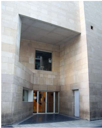
Figura 269: Acceso al Ayuntamiento de Murcia por la calle Frenería.
