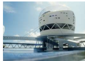
Figura 67: Estación Marítima en Zeebrugge (proyecto) Secciones, plantas y maqueta, Bélgica, 1989, Rem Koolhaas.
