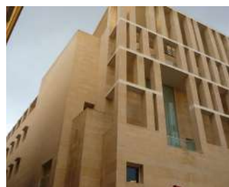
Figura 263: Materialización de la separación de los planos de fachada en el Ayuntamiento.
