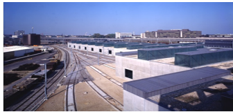
Figura 72: Depósito de la Estación de Ferrocarriles de Basilea Vista Aérea de las Cerchas - Tragaluz Basilea, 1989 - 1995, Herzog & De Meuron.
