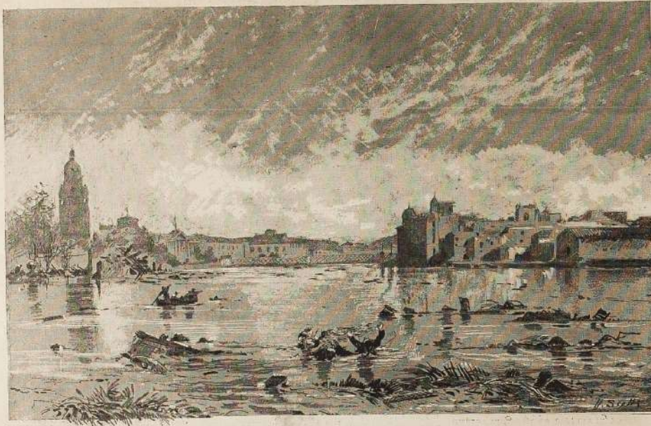
MURCIE. -- Le pont de la Segura pendant l'inondation.
